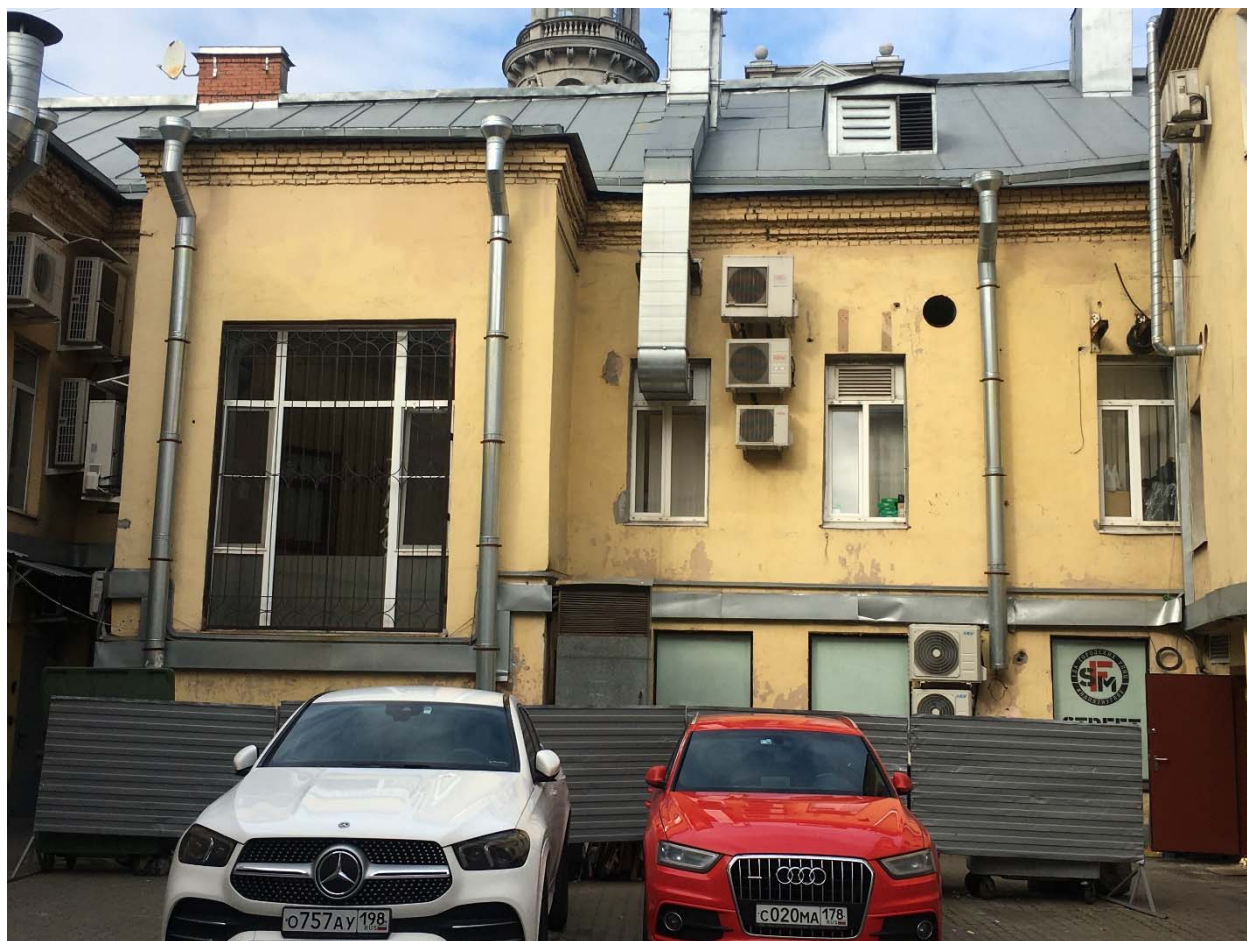
Фото №13. Юго-восточный дворовый фасад.
