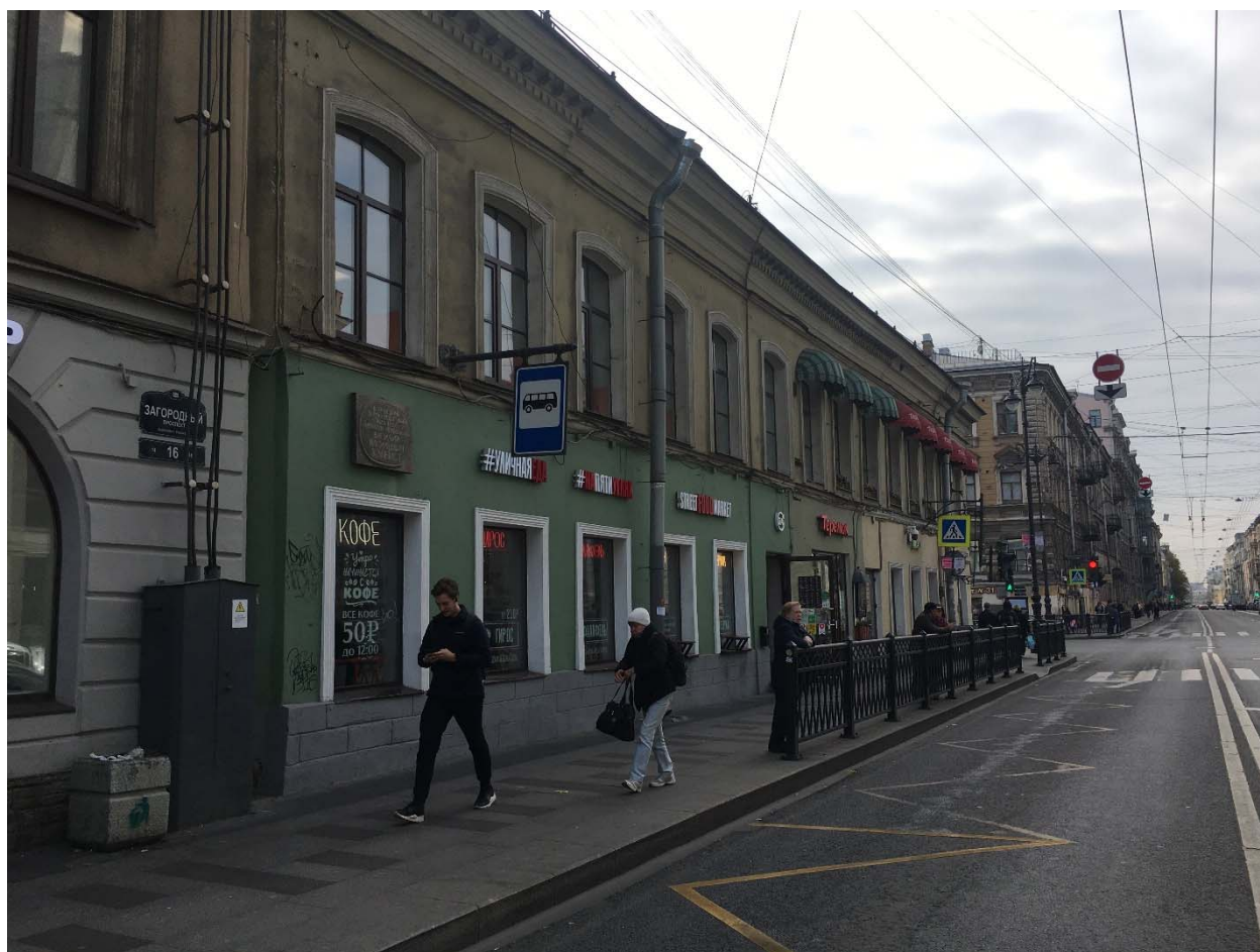
Фото №10. Северо-западный фасад по Разъездной улице.
