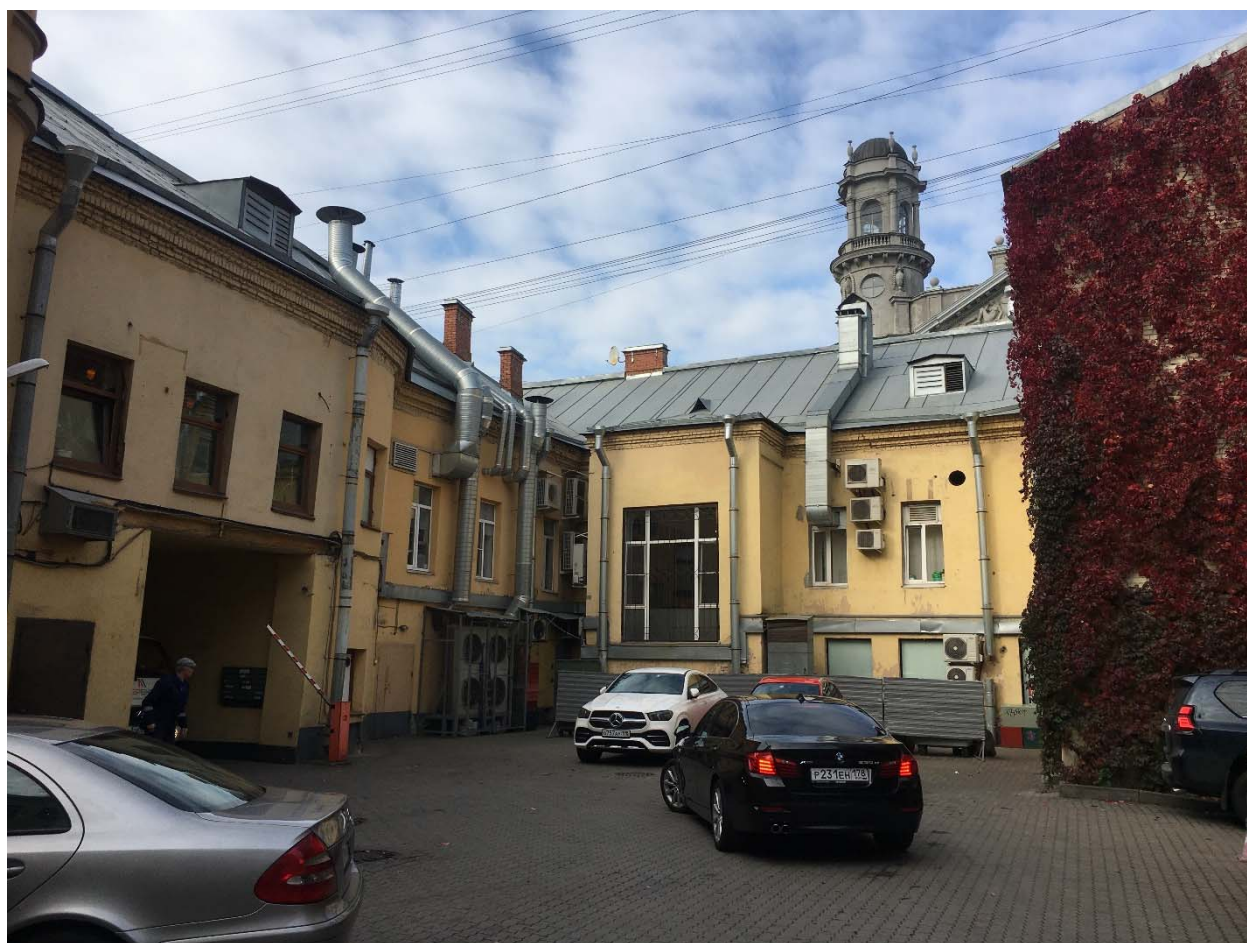
Фото №18. Юго-восточный и северо-восточный дворовые фасады.
