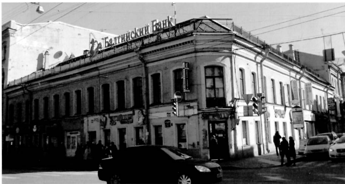
Лицевые фасады. Общий вид. Съёмка 21.03.2012. Л.С. Гуменюк.
