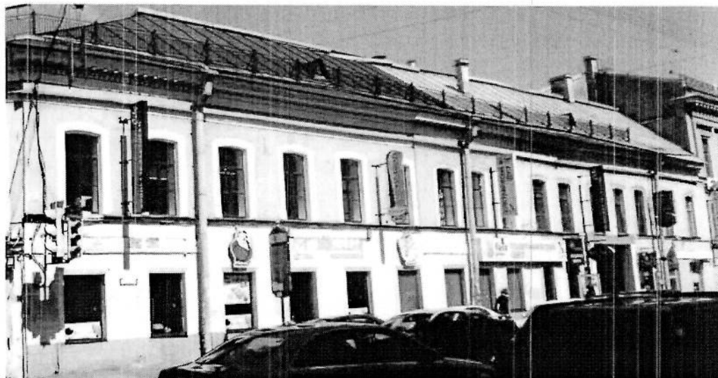
Лицевой фасад со стороны Разъезжей улице. Съёмка 20.06.2012. Т.И. Соколова.
