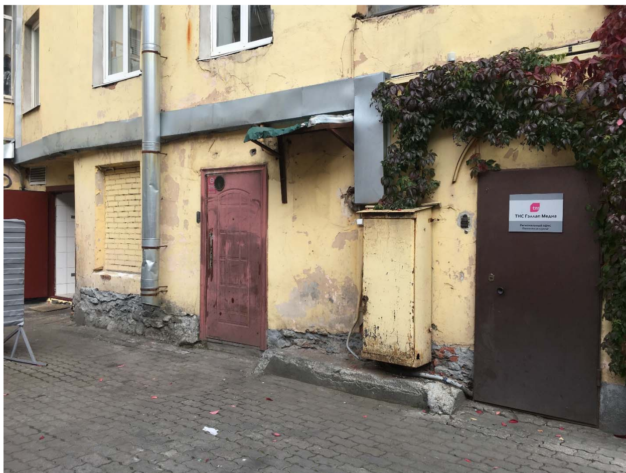
Фото №17. Юго-западный дворовый фасад.
