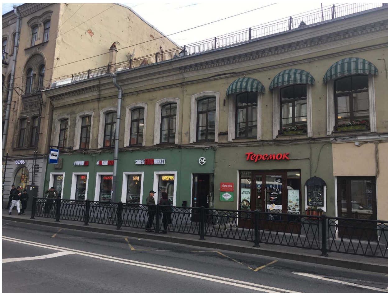
Фото №7. Северо-западный фасад по Разъездной улице.
