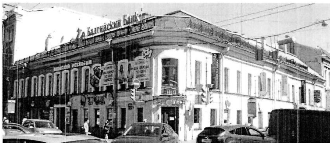
Общий вид лицевых фасадов. Съёмка 20.06.2012. Т.И. Соколова.
