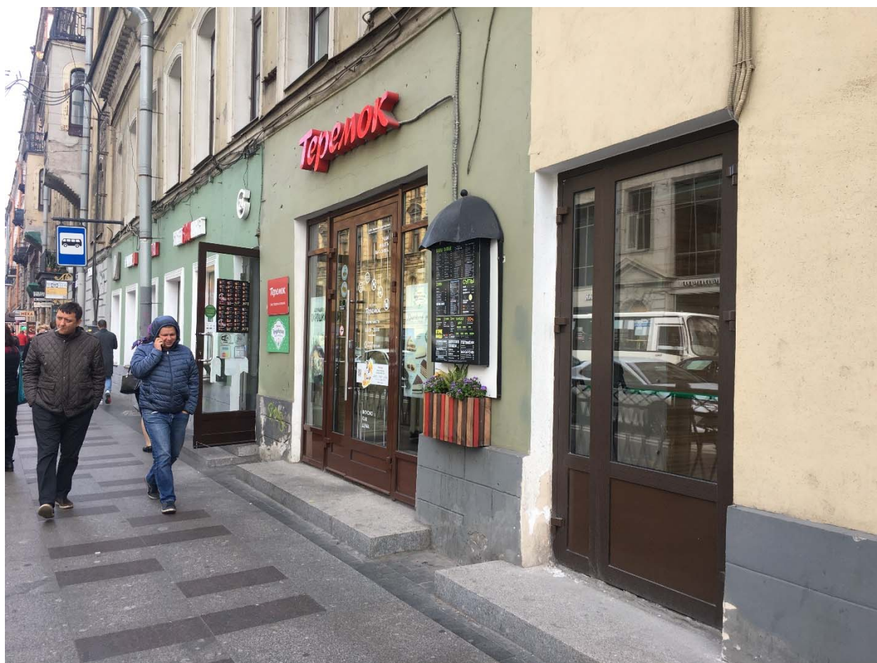
Фото №8. Северо-западный фасад по Разъездной улице.
