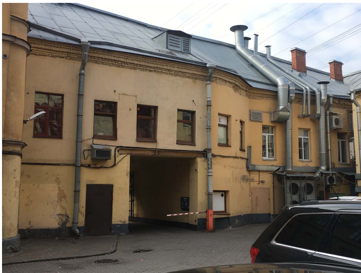
Фото №12. Северо-восточный дворовый фасад.
