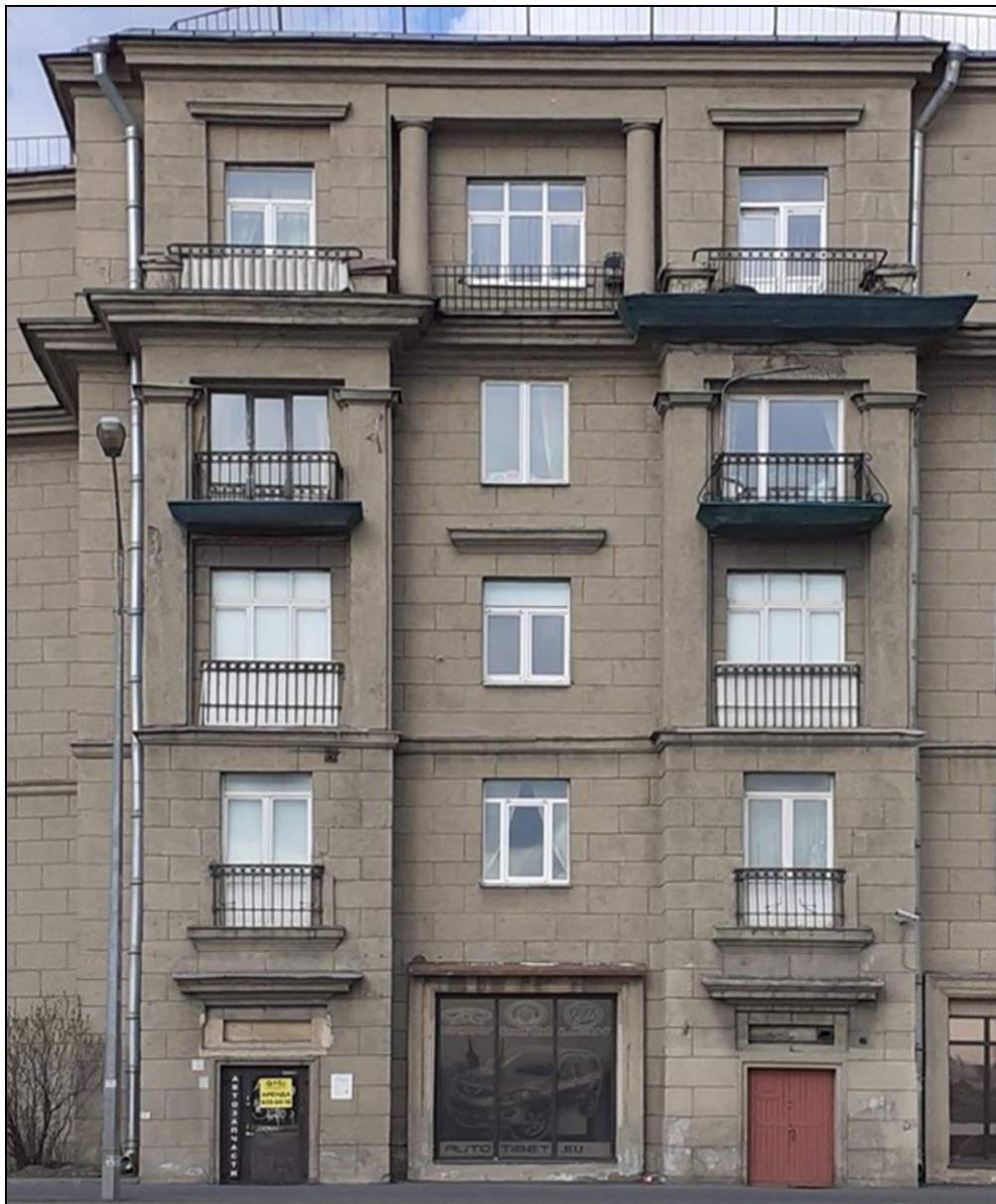
4. Северный ризалит западного фасада. Дата съемки: 10 мая 2021 г. Фотограф: Г. В. Михайловская.
