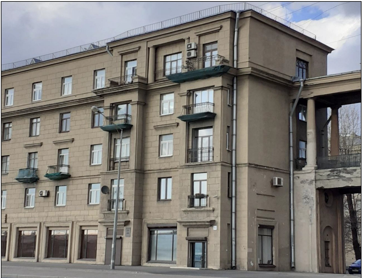
6. Западный фасад. Южная часть. Вид с юго-востока. Дата съемки: 10 мая 2021 г. Фотограф: Г. В. Михайловская.
