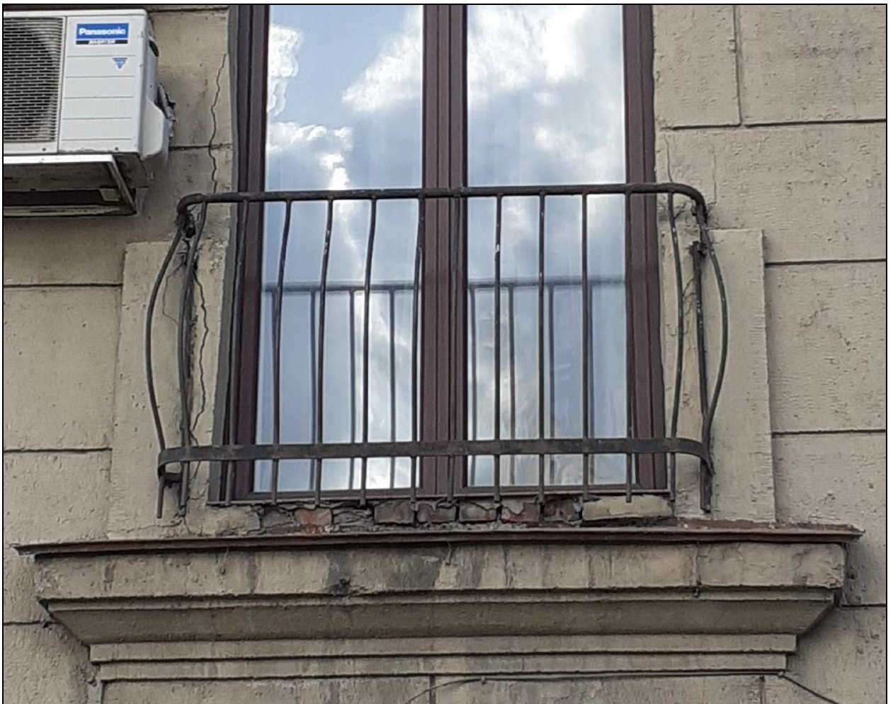
11. Западный фасад. Кованое металлическое ограждение балкона. Дата съемки: 10 мая 2021 г. Фотограф: Г. В. Михайловская.
