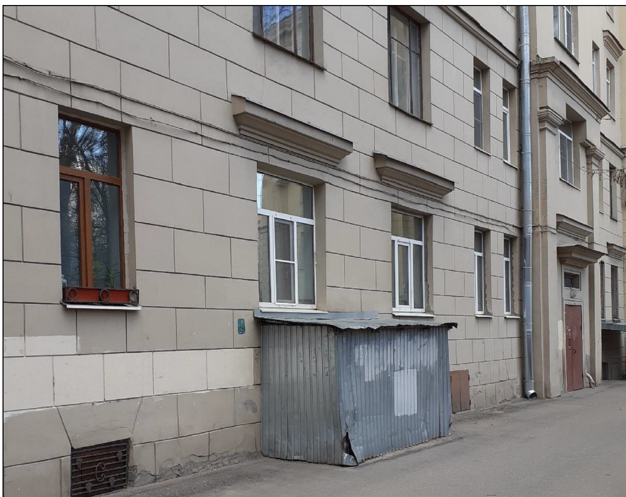
27. Южный (дворовый) фасад. Восточная часть. Фрагмент. Дата съемки: 10 мая 2021 г. Фотограф: Г. В. Михайловская.
