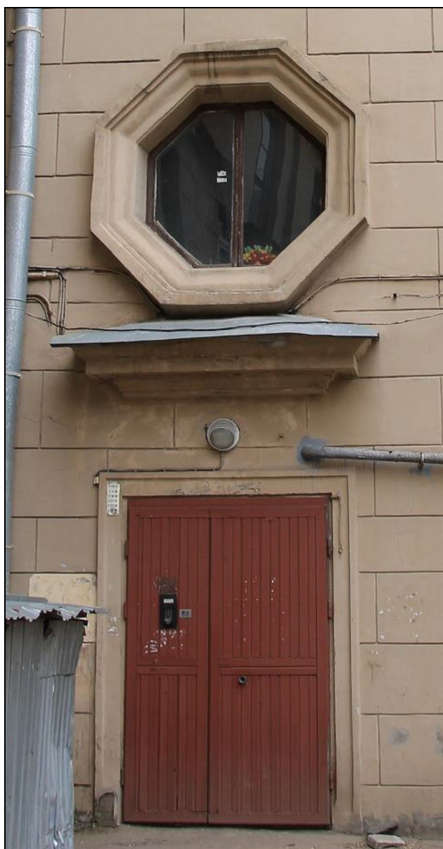
24. Южный (дворовый) фасад. Фрагмент. Дата съемки: 10 мая 2021 г. Фотограф: Г. В. Михайловская.
