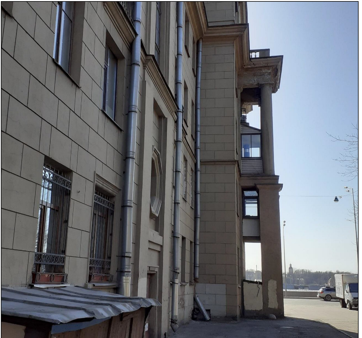
14. Северный фасад. Вид на западный ризалит. Дата съемки: 10 мая 2021 г. Фотограф: Г. В. Михайловская.
