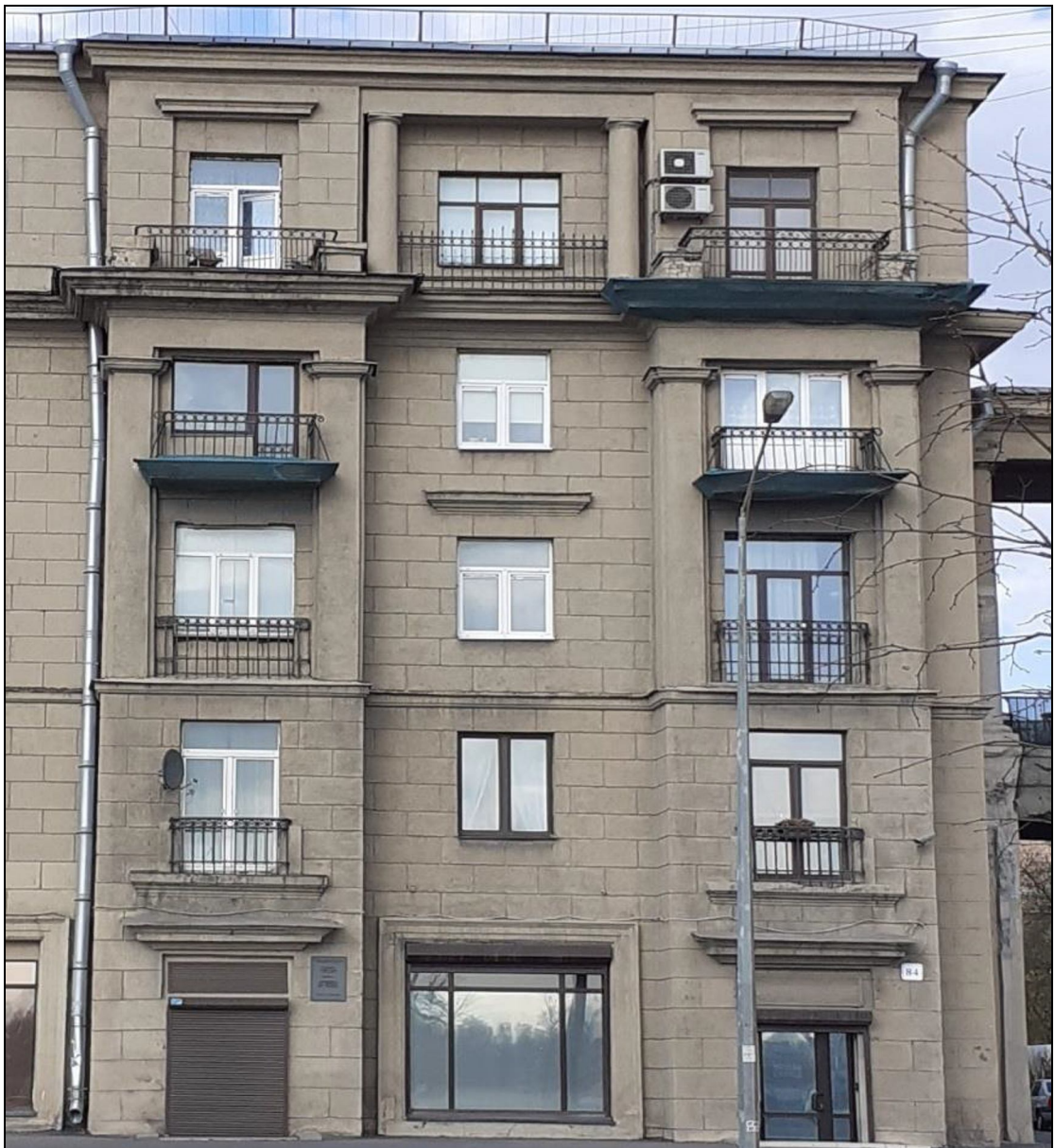
7. Южный ризалит западного фасада. Дата съемки: 10 мая 2021 г. Фотограф: Г. В. Михайловская.
