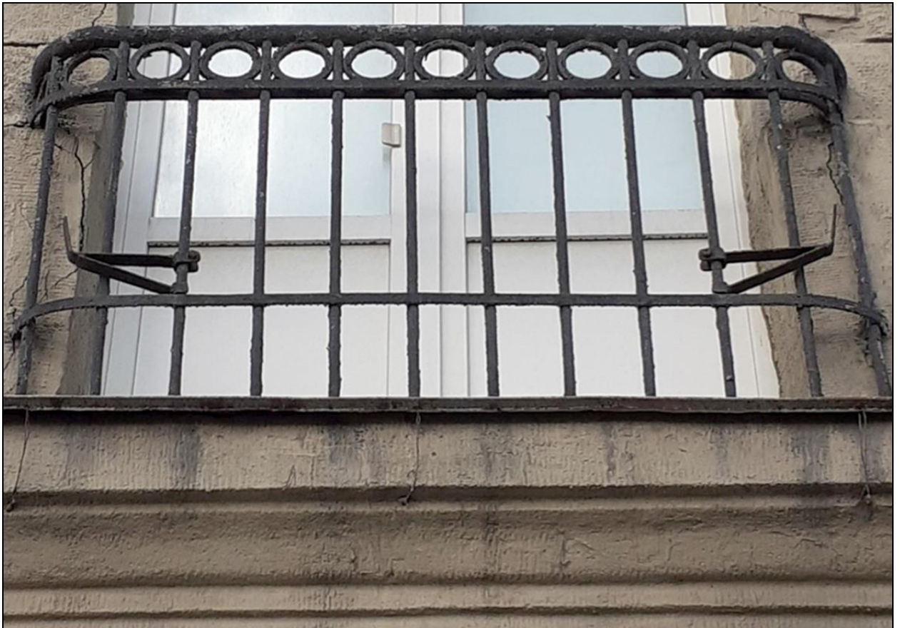
9. Западный фасад. Кованое металлическое ограждение балкона. Дата съемки: 10 мая 2021 г. Фотограф: Г. В. Михайловская.
