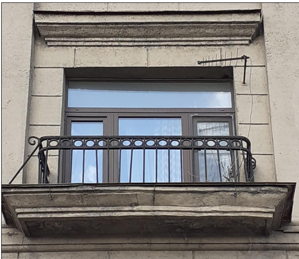
10. Западный фасад. Кованое металлическое ограждение балкона. Дата съемки: 10 мая 2021 г. Фотограф: Г. В. Михайловская.
