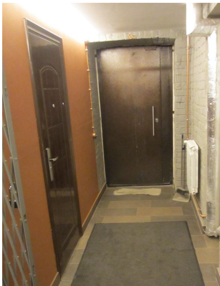
22. Вид на вход в тамбур 2-го этажа, из которого выполняется вход в квартиры №8 и 7.
