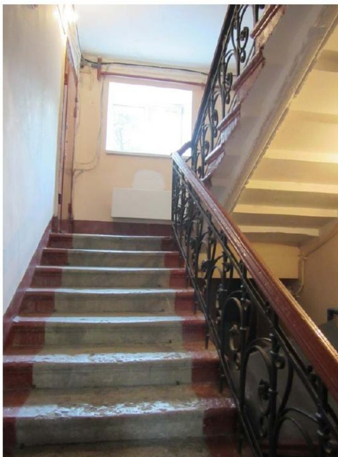
14. Вид на лестничной клетке 2ЛК, где расположен вход в квартиру №9.
