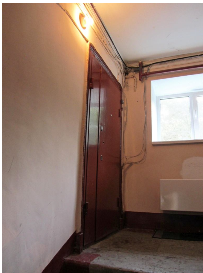
15. Вид на вход в квартиру №9 с лестничной клетки 2ЛК.
