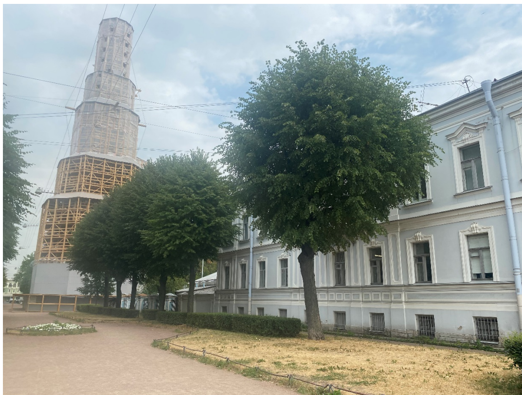
5. Вид на главный фасад;
