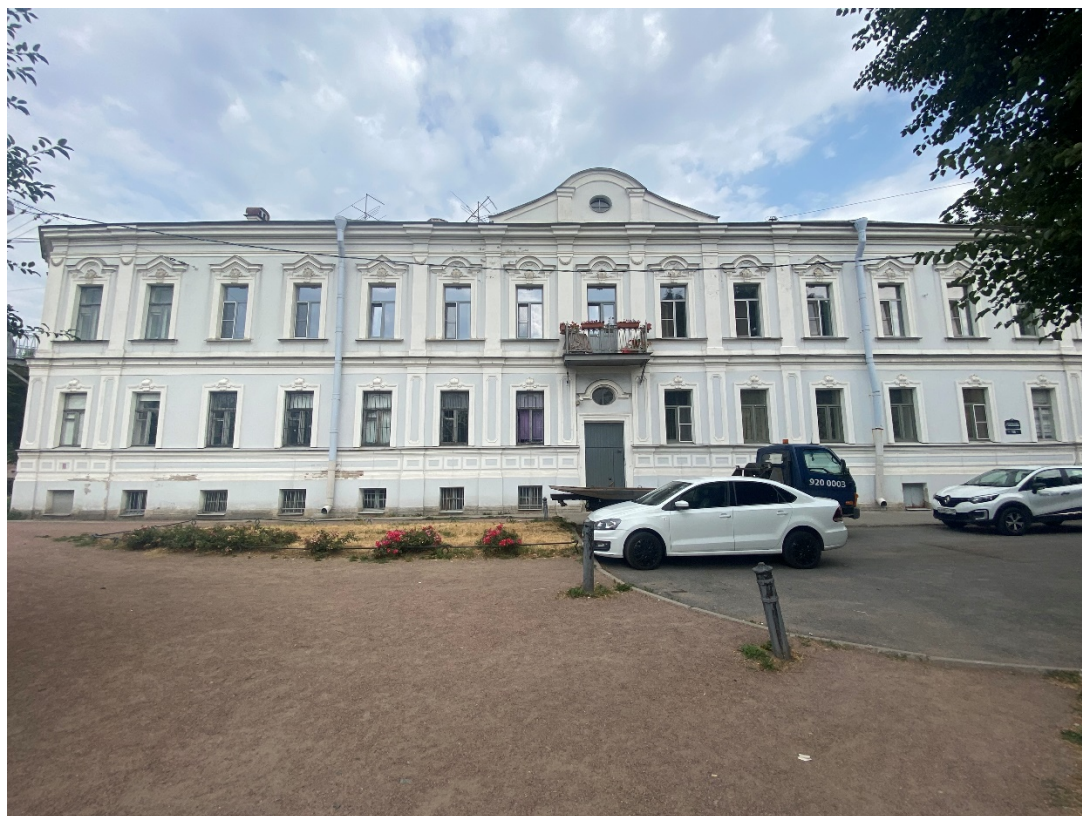
1. Вид на главный фасад;
