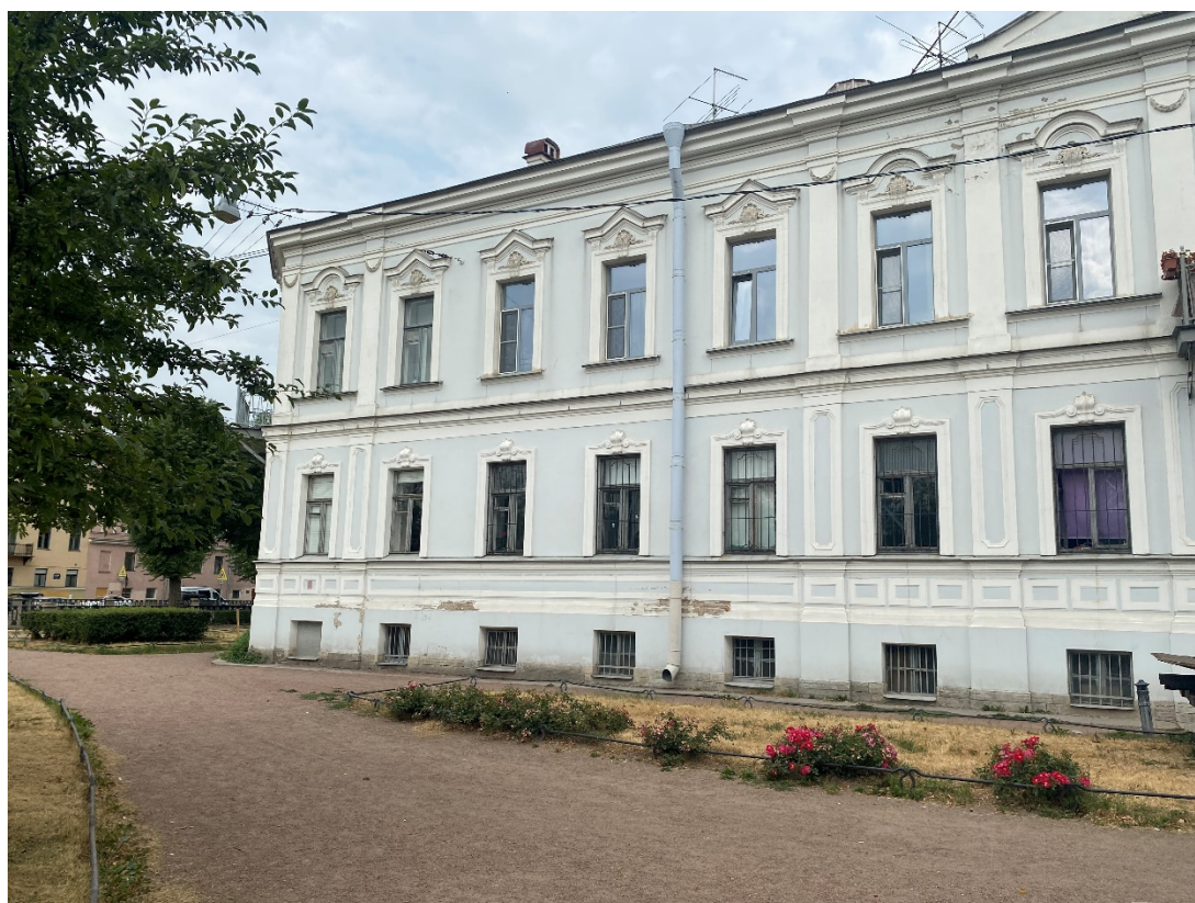
2. Вид на главный фасад;
