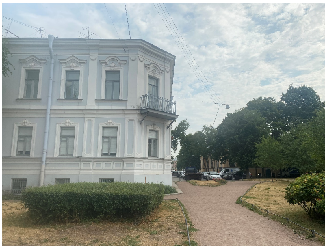
4. Вид на главный фасад;
