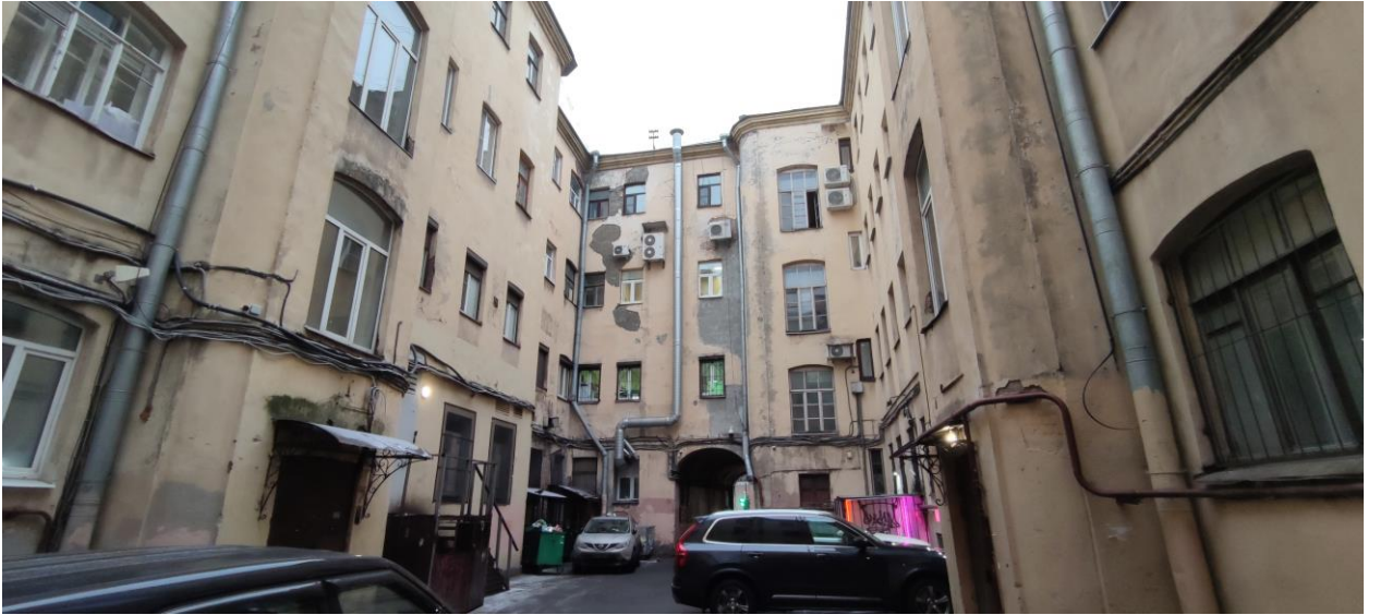
Фото 3. Общий вид двора.
