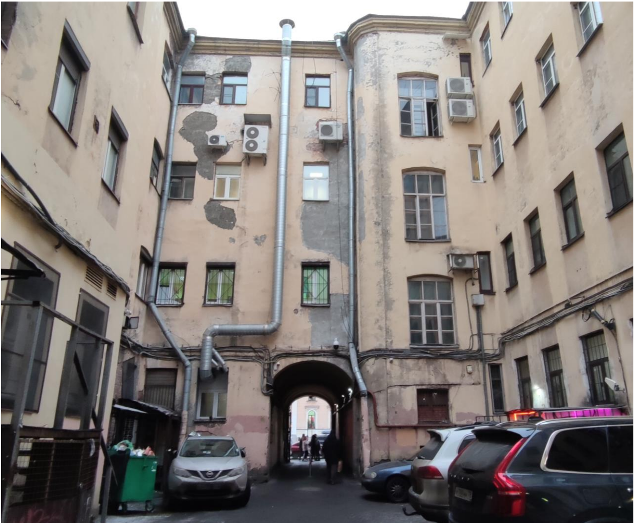
Фото 4. Дворовой фасад здания.
