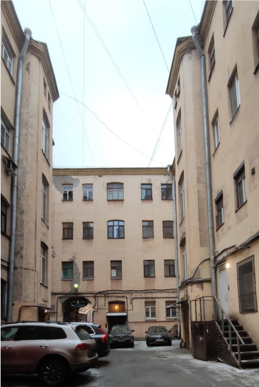
Фото 5. Общий вид двора.
