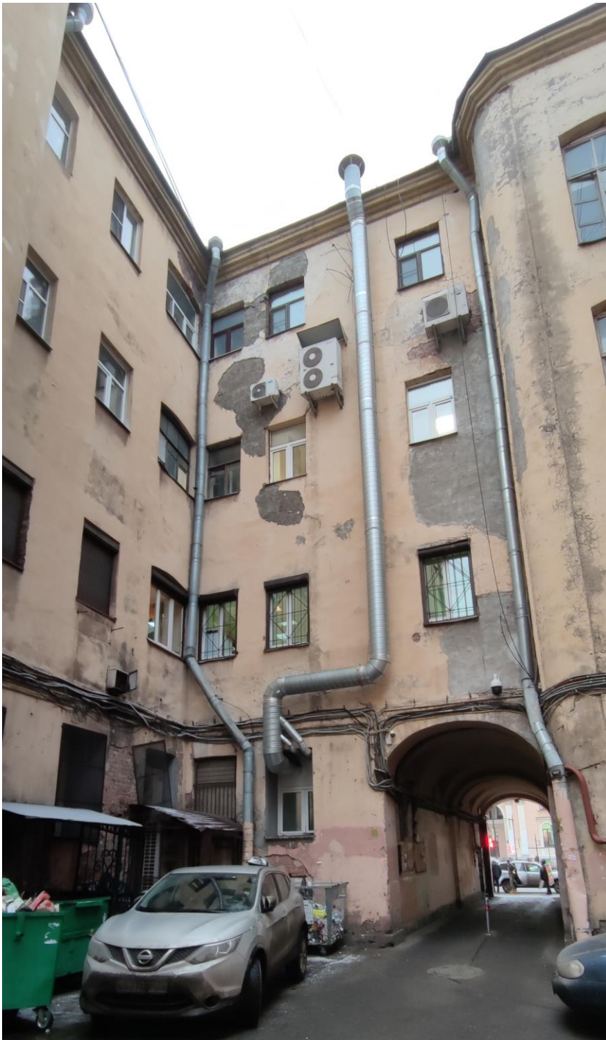
Фото 6. Фрагмент дворового фасада с проектируемой трубой воздуховода.
