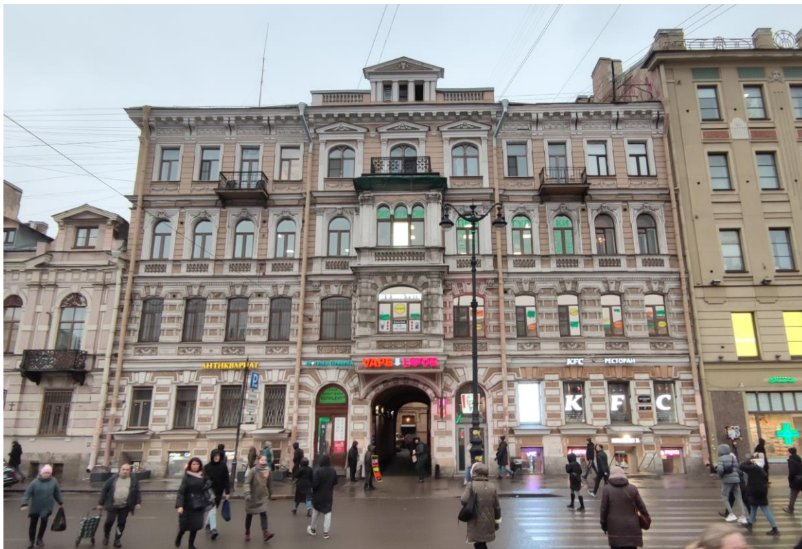
Фото 1. Лицевой фасад здания.
