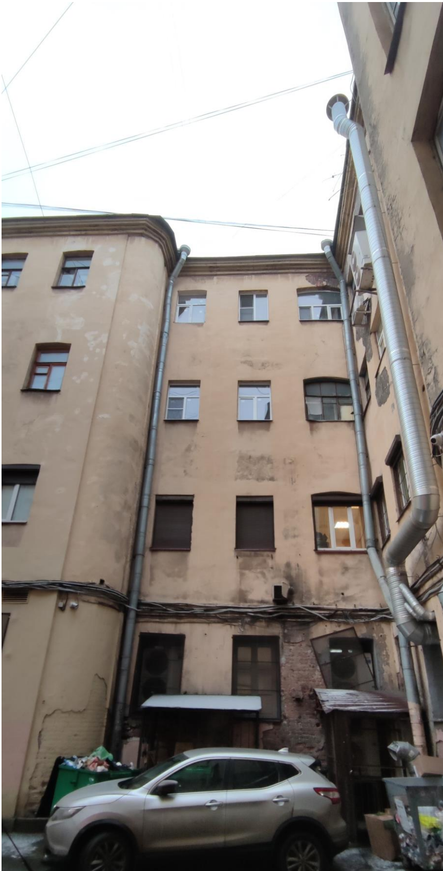
Фото 7. Фрагмент дворового фасада.
