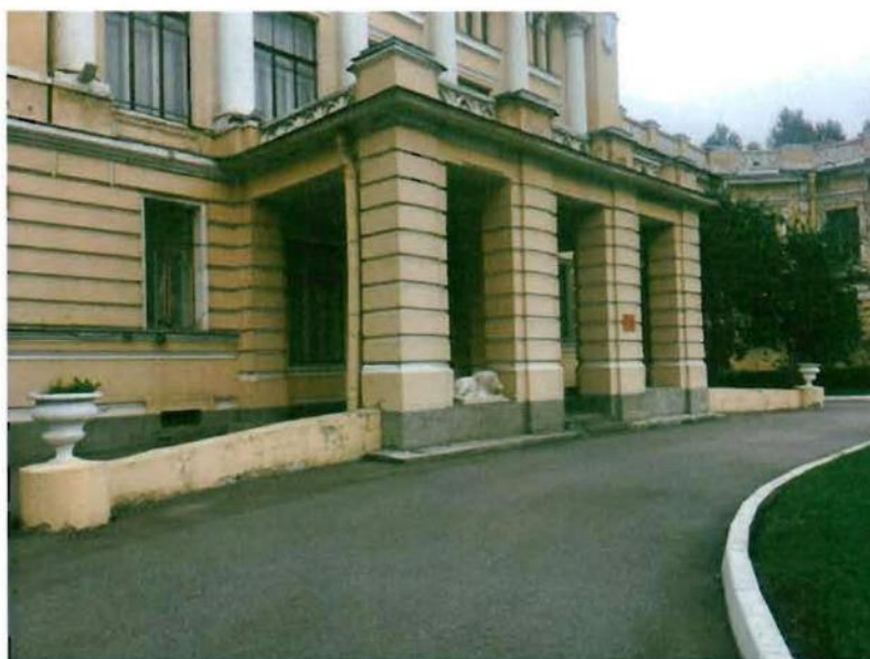
4. Фрагмент фасада. Центральный вход со стороны Суворовского пр.
