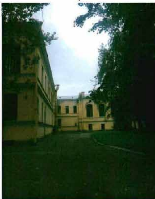
6. Фрагмент дворового фасада (северо-западная сторона)
