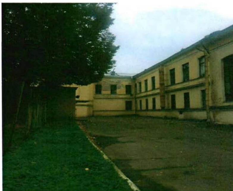
5. Фрагмент дворового фасада (юго-западная сторона).
