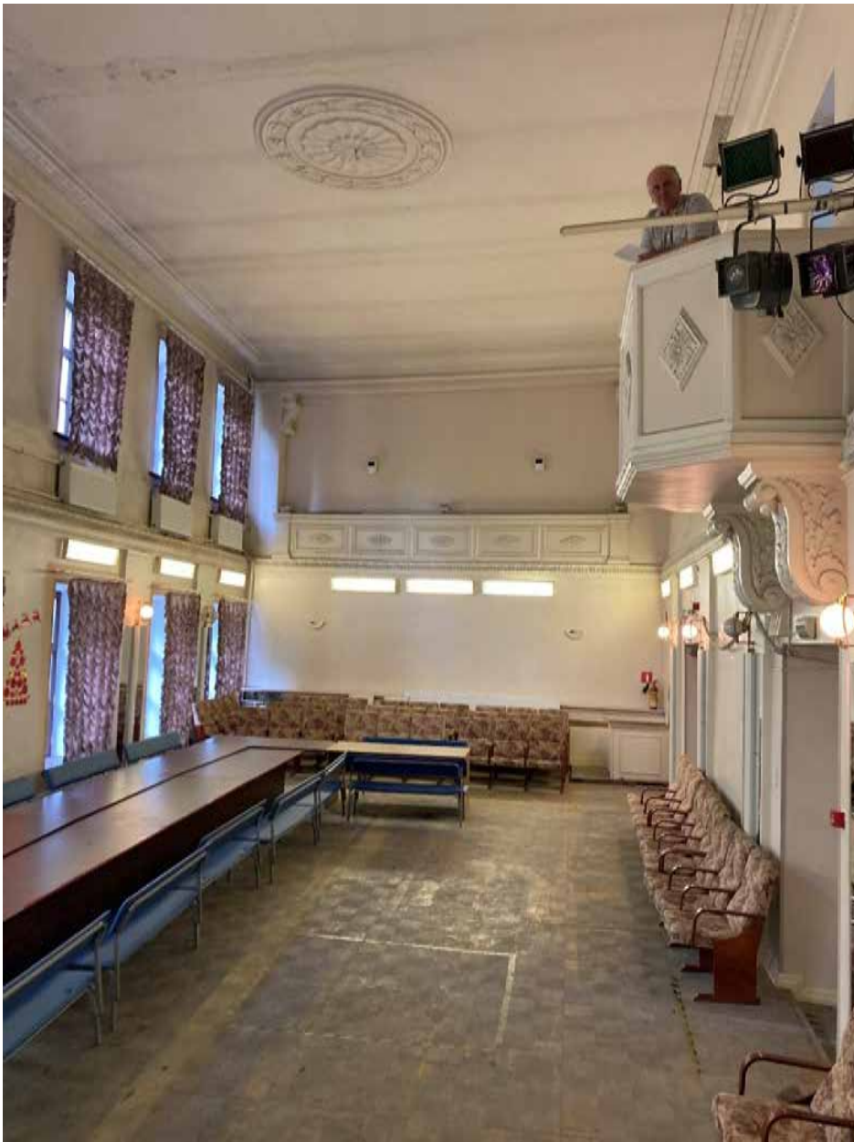
Фото 3. Актальный зал. Общий вид
