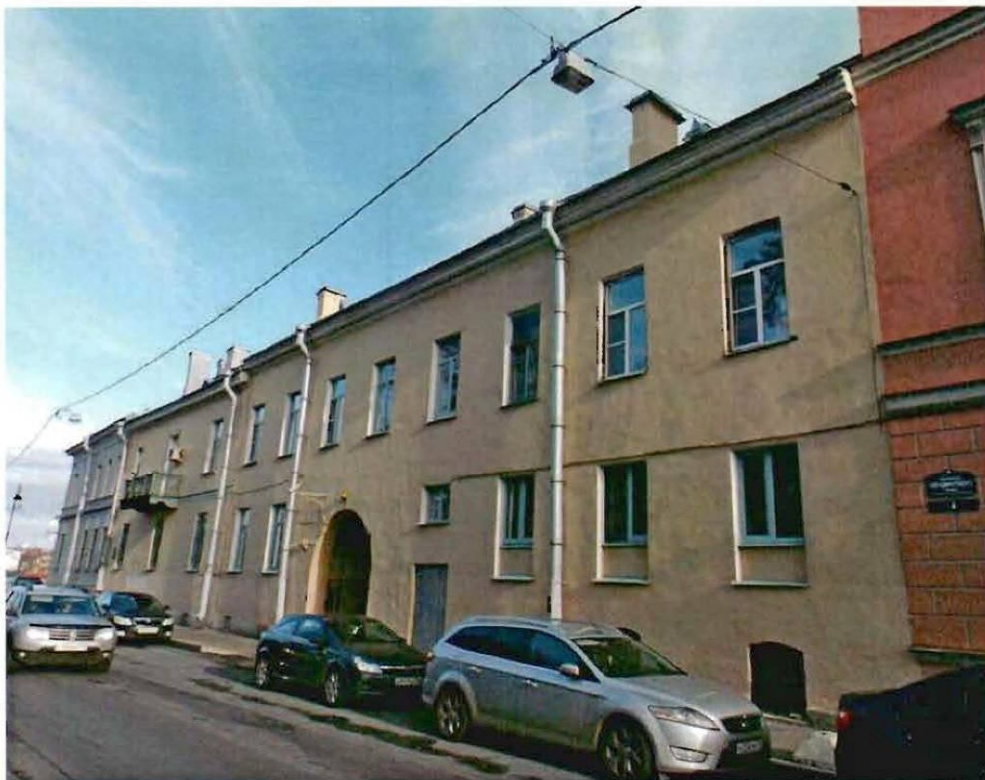
3. Фасад по набережной Ново-Адмиралтейского канала
