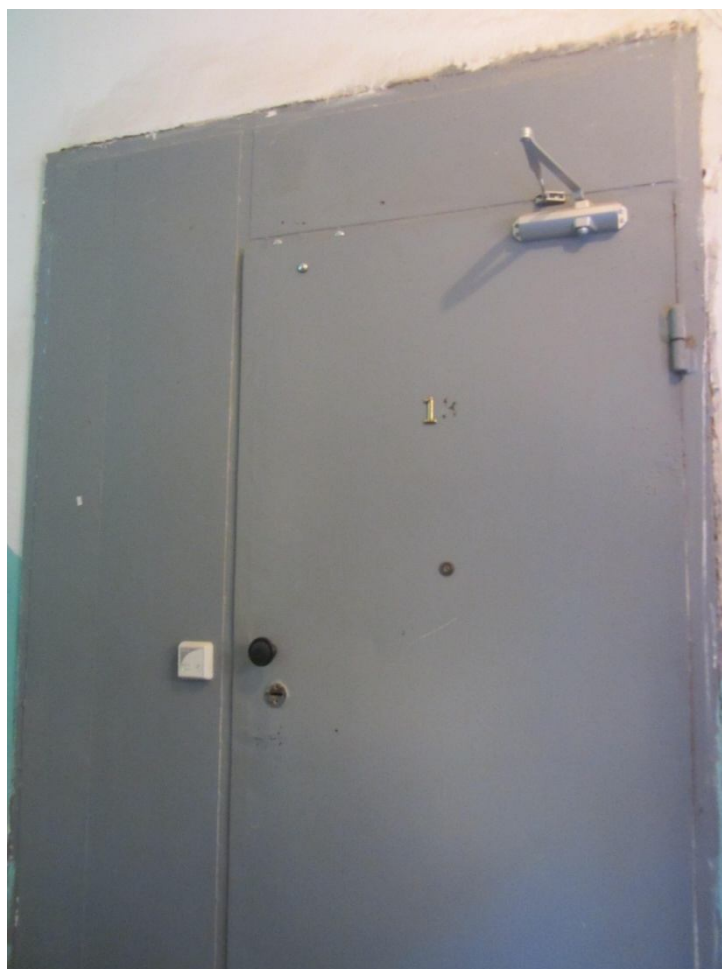
12. Вид на вход в квартиру №13 с лестничной клетки жилой части восточного флигеля.
