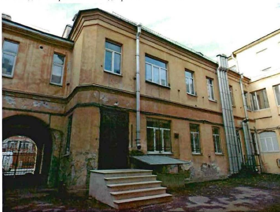
4. Западный дворовый фасад
