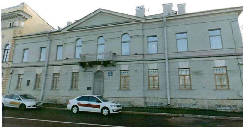
2. Фасад по Английской набережной
