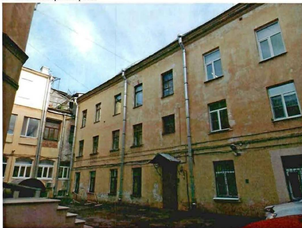
6. Восточный дворовый фасад
