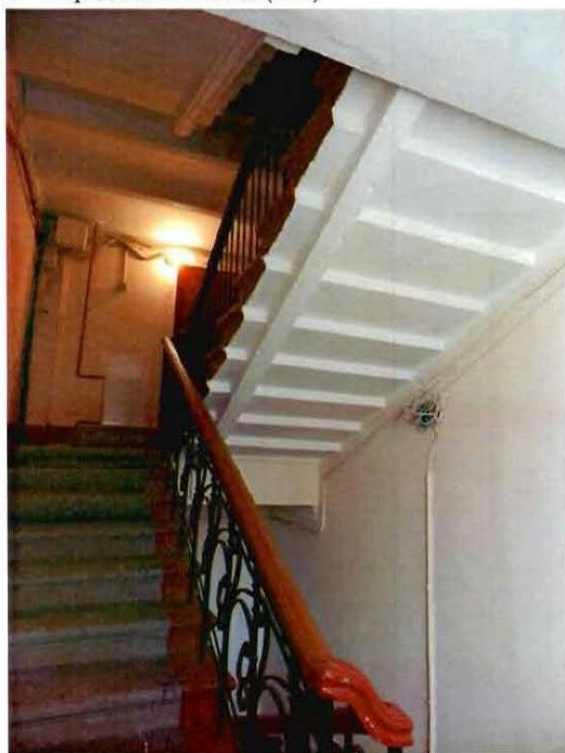
10. Лестница Л-2 (западный корпус)
