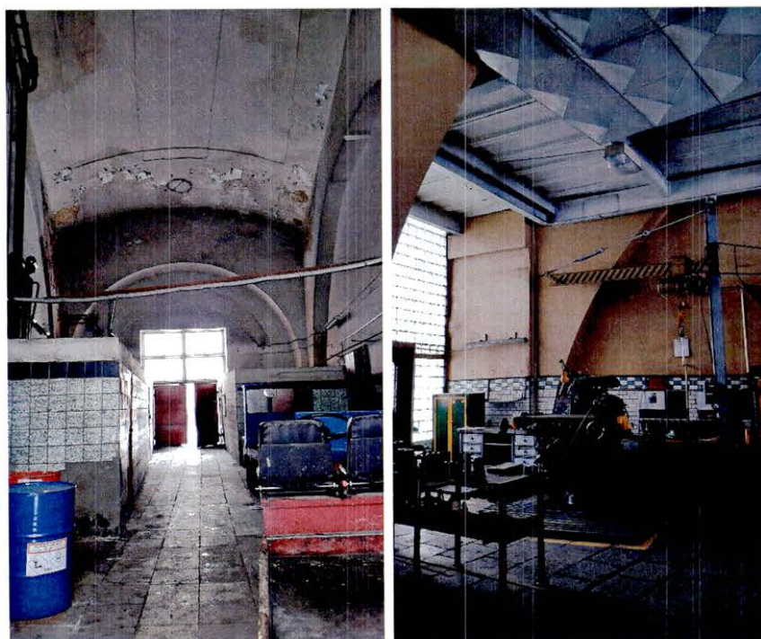
13, 14. Помещения объекта культурного наследия
