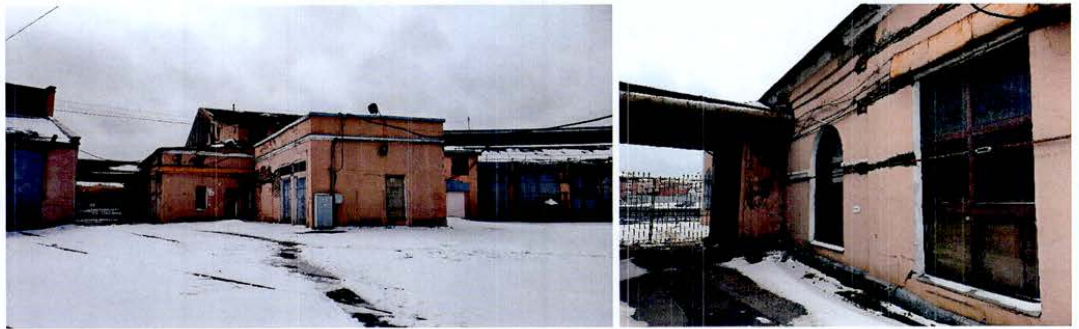
5. Правая часть объекта культурного наследия со стороны северного фасада
