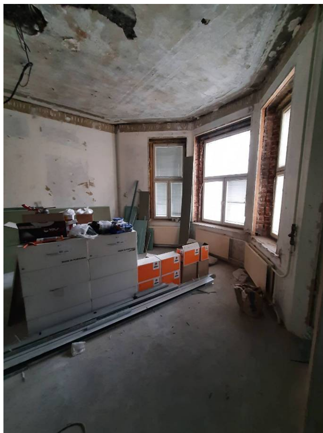
Фото 18. Интерьер квартиры № 6 выявленного объекта культурного наследия «Дом С.А.Визлер (А.Ф.Бубыря)»
