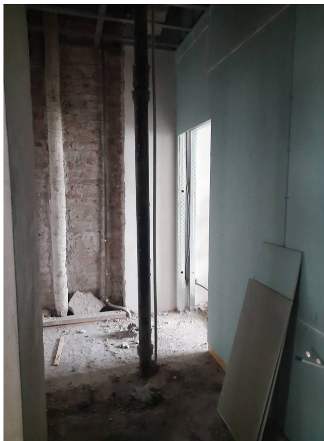
Фото 16. Интерьер квартиры № 6 выявленного объекта культурного наследия «Дом С.А.Визлер (А.Ф.Бубыря)»
