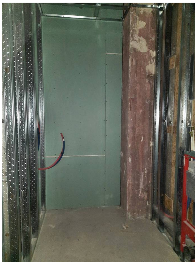
Фото 20. Интерьер квартиры № 6 выявленного объекта культурного наследия «Дом С.А.Визлер (А.Ф.Бубыря)»
