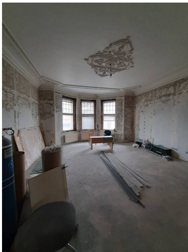
Фото 10. Интерьер квартиры № 6 выявленного объекта культурного наследия «Дом С.А.Визлер (А.Ф.Бубыря)»
