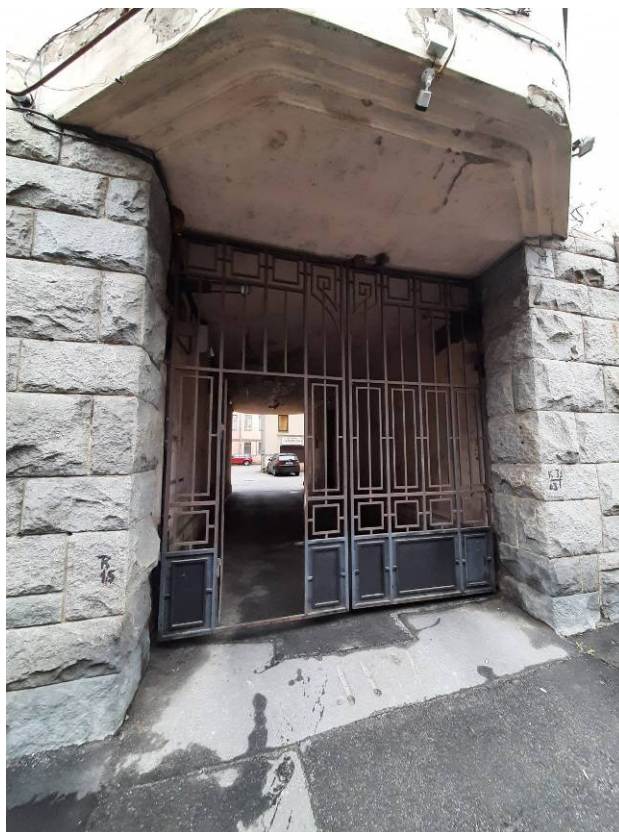
Фото 4. Фрагмент лицевого фасада выявленного объекта культурного наследия «Дом С.А.Визлер (А.Ф.Бубыря)», воротные проезд на Ковенский пер.
