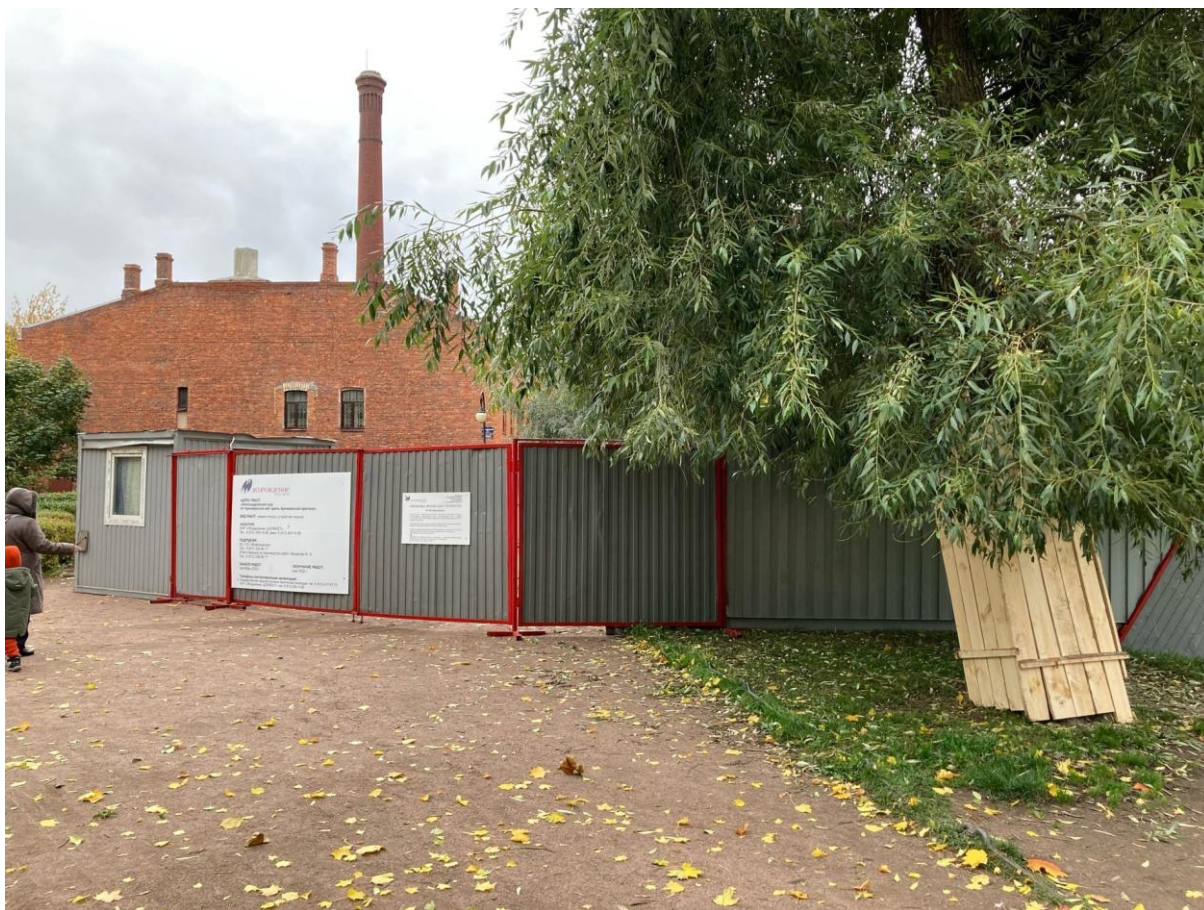
Фото 15. Вход со стороны парка на территорию откоса Кронверского протока объекта культурного наследия регионального значения «Александровский парк (парк им. В.И.Ленина)»
