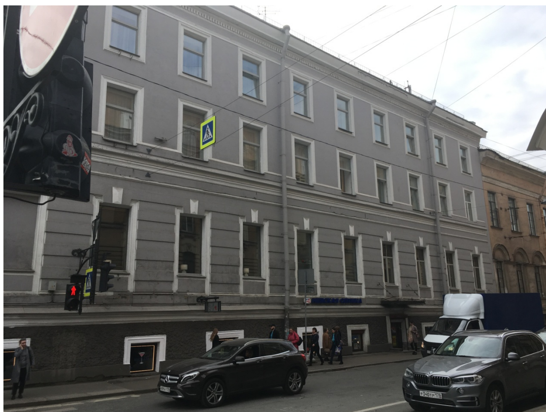
2. Вид с ул. Ломоносова на фасад выявленного объекта культурного наследия «Здание Мариинской женской гимназии», расположенного по адресу: Санкт-Петербург, Загородный пр., 13, лит. А. (15.03.2019).
