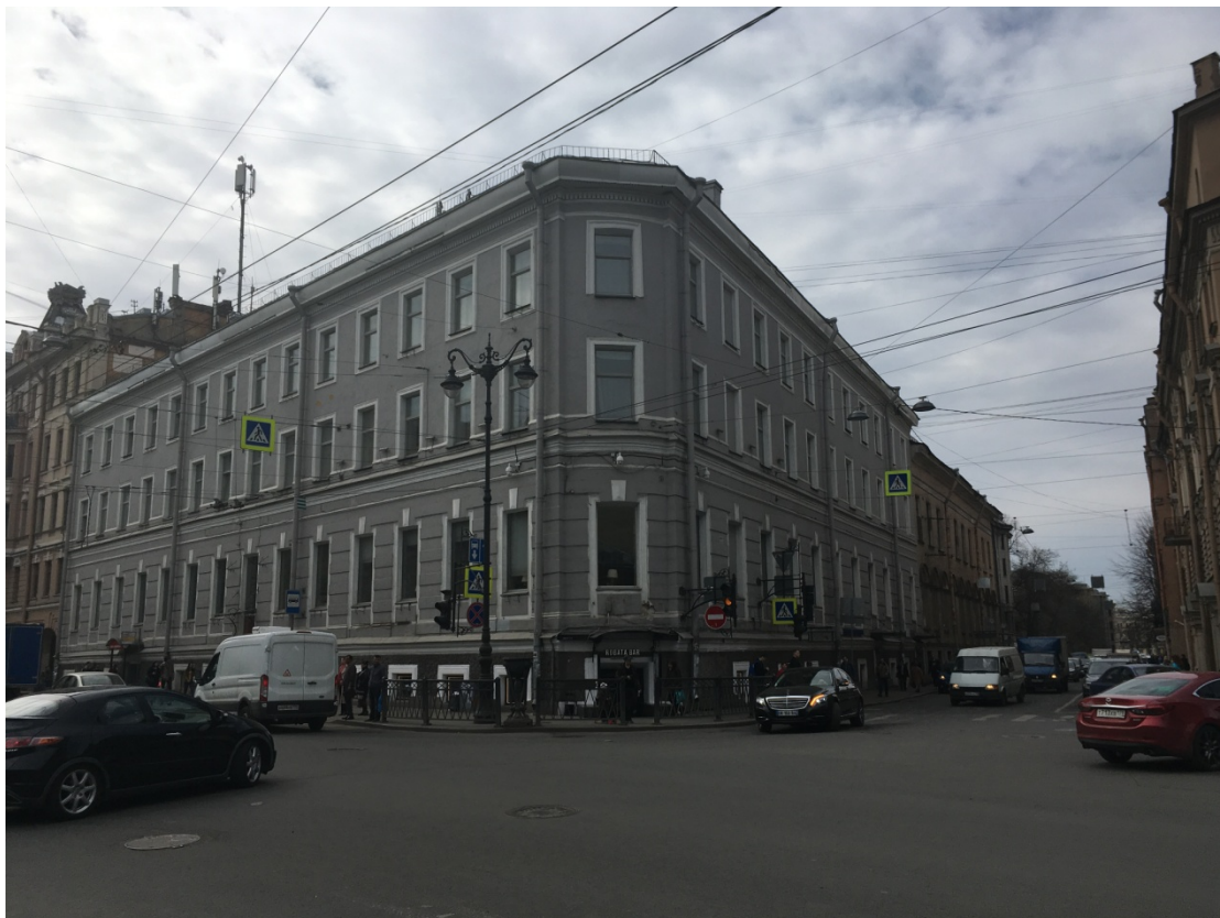
3. Вид с Разъезжей ул. на выявленный объект культурного наследия «Здание Мариинской женской гимназии», расположенного по адресу: Санкт-Петербург, Загородный пр., 13, лит. А. (15.03.2019).
