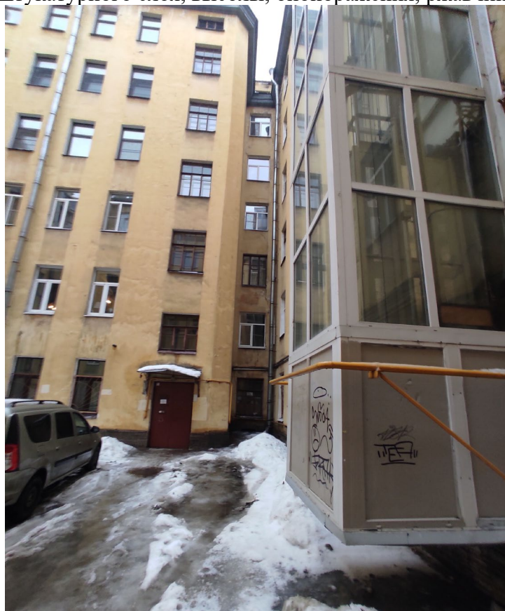
Фото 20. Фасад К-Е. Лифтовая шахта фасада 10-2
