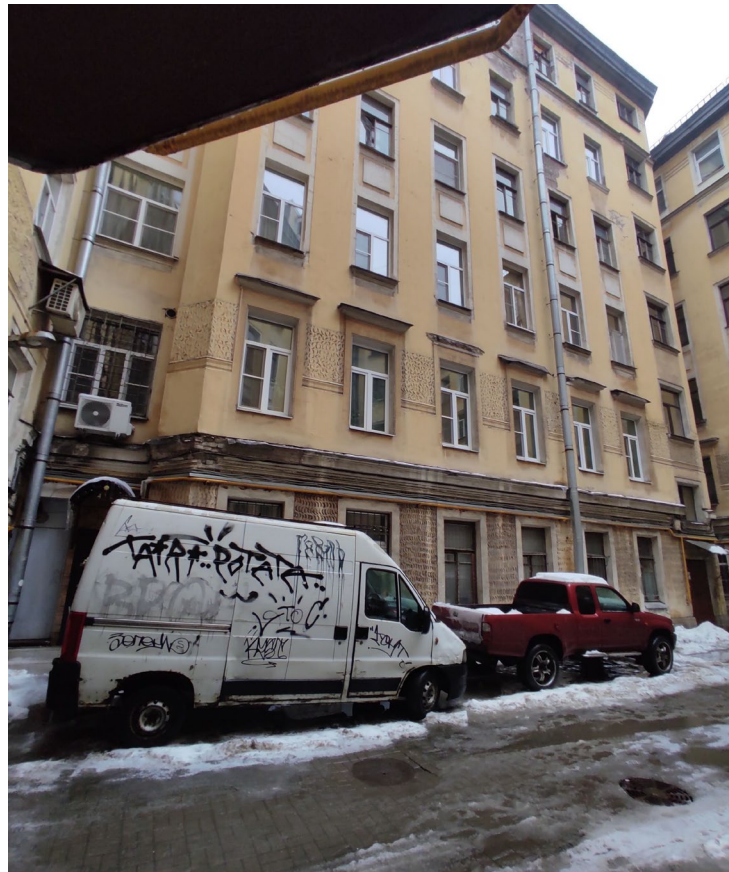
Фото 9. Общий вид на фасад Б-Д
