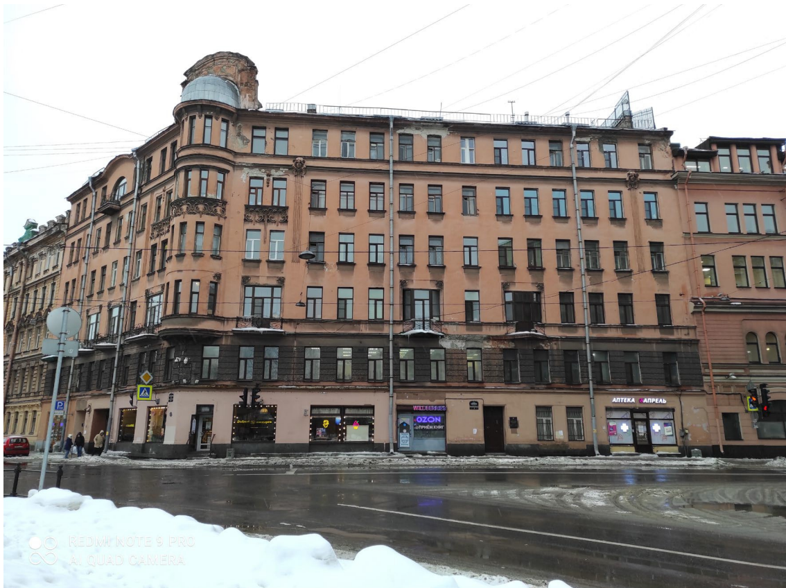
Фото 1. Фасад 1'-5'. Общий вид
