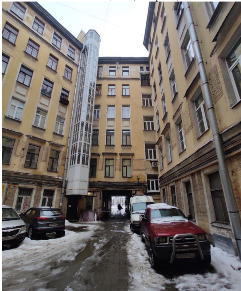
Фото 8. Общий вид на фасад 6-3
