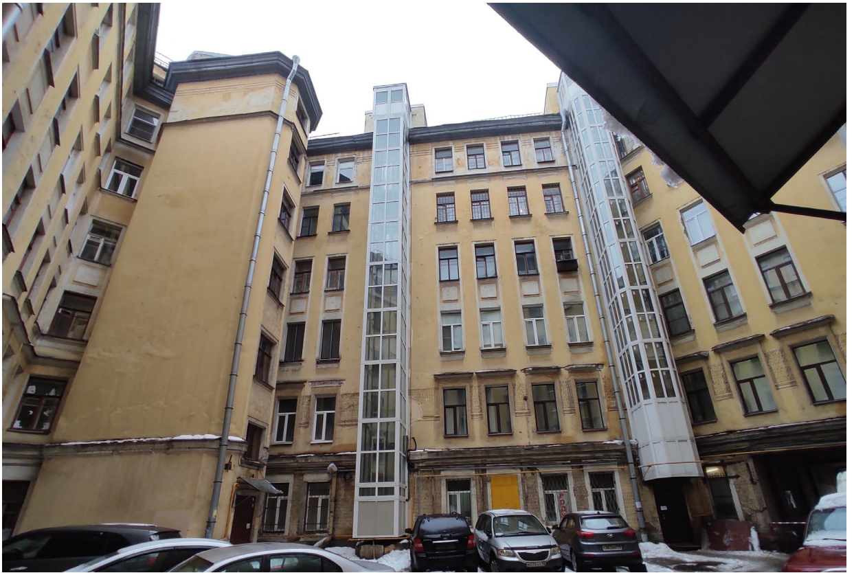
Фото № 7. Общий вид на фасад 2'-4'
