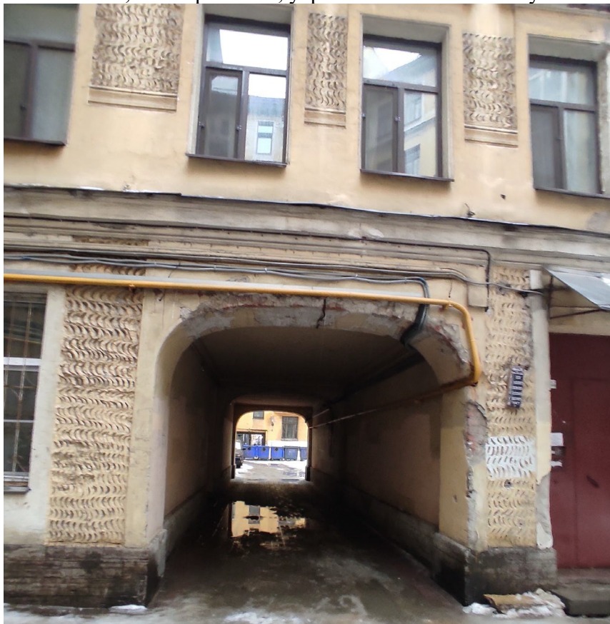
Фото 13. Проездная арка на фасаде 2-9
