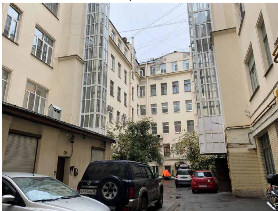
Фото 4. Вид на дворовые фасады объекта культурного наследия.
