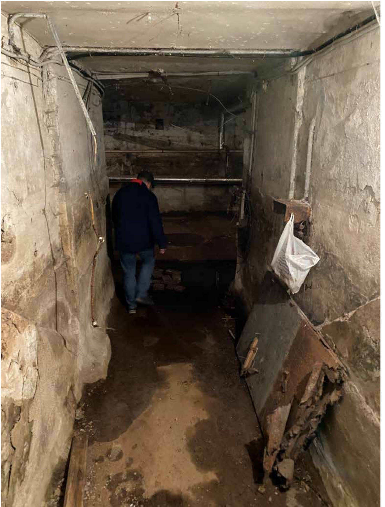
Фото 13. Вид части помещения 2-Н объекта культурного наследия.
