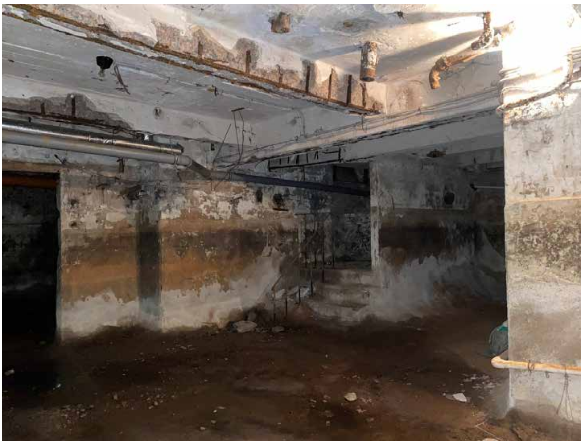
Фото 14. Вид части помещения 2-Н объекта культурного наследия.
