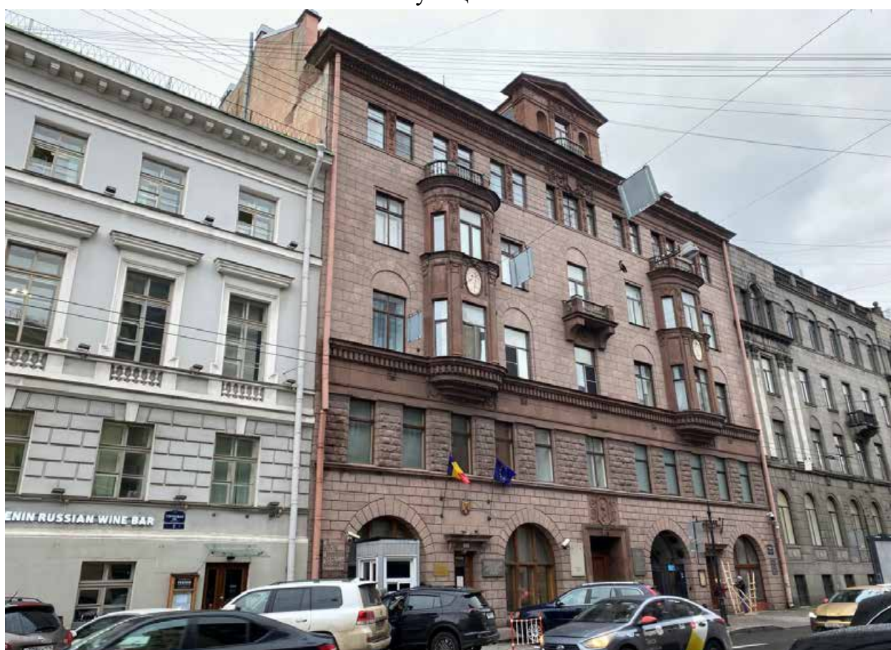
Фото 2. Вид на лицевой фасад объекта культурного наследия по Гороховой улице.
