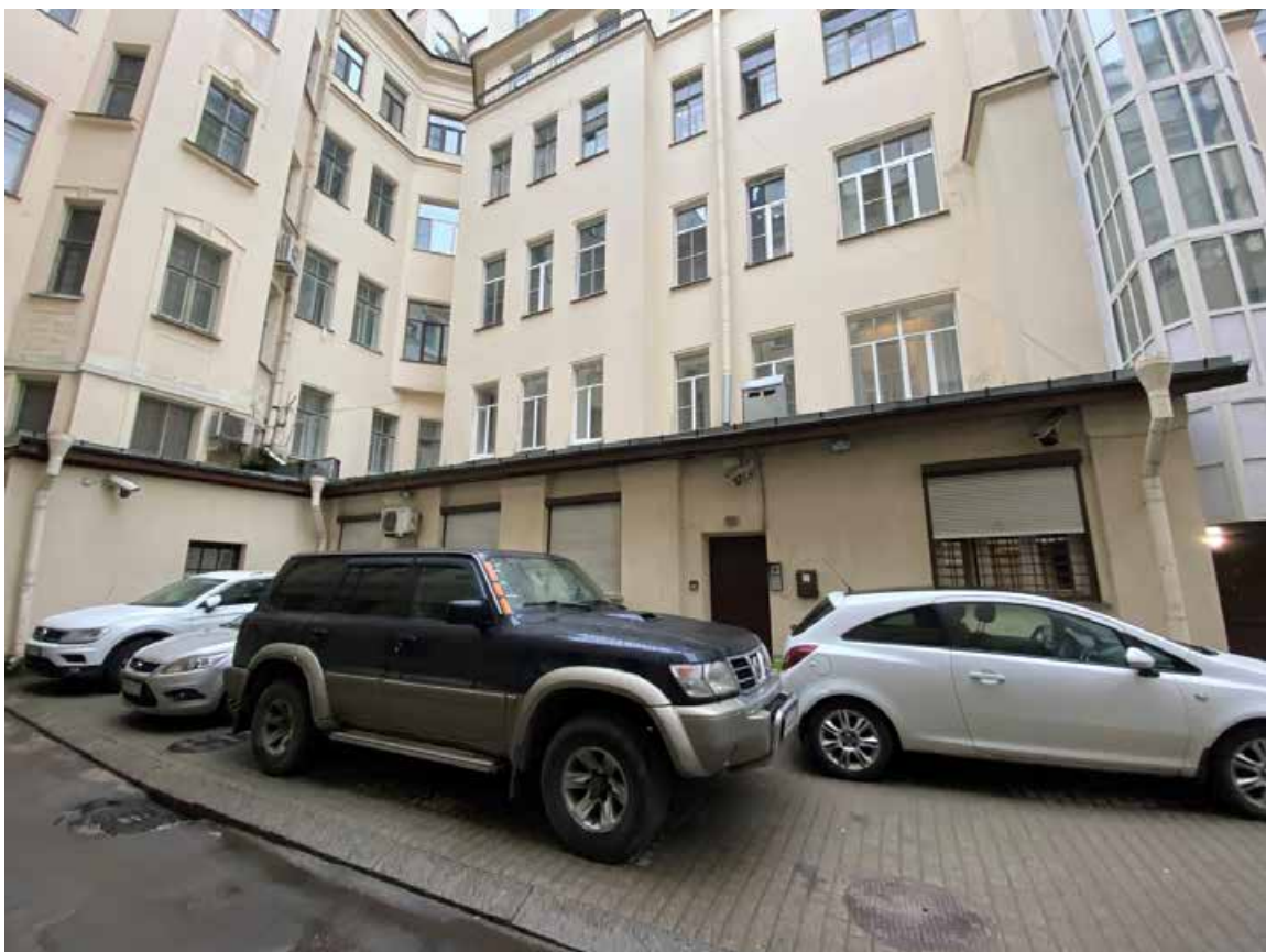
Фото 7. Вид на дворовые фасады объекта культурного наследия.
