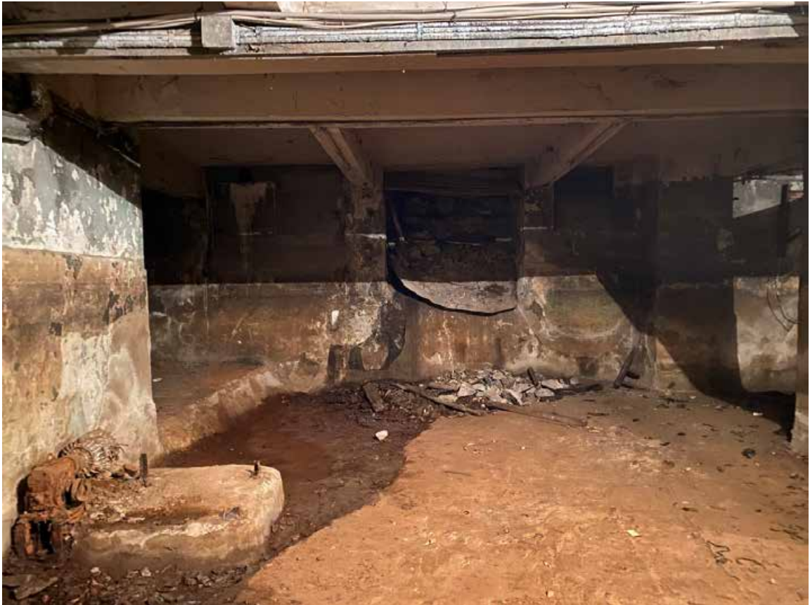
Фото 18. Вид части помещения 2-Н объекта культурного наследия.
