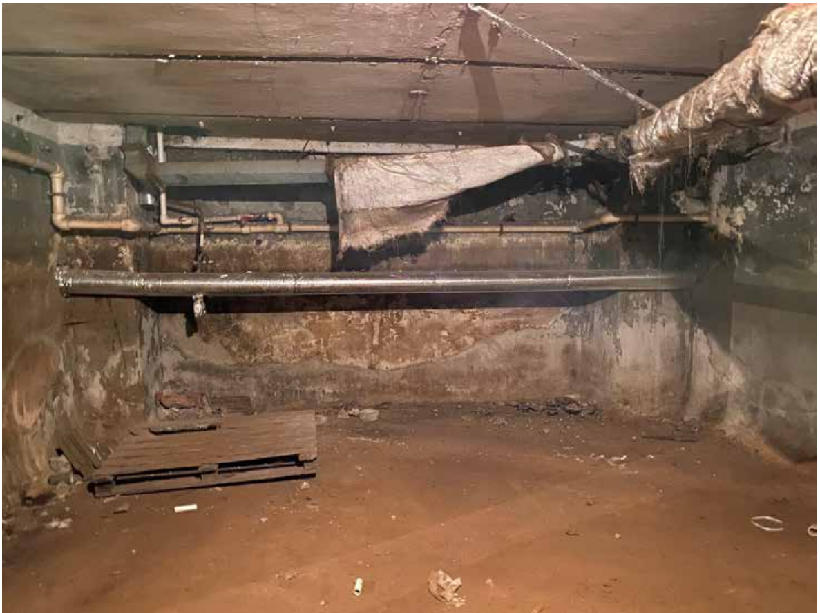
Фото 24. Вид части помещения 2-Н объекта культурного наследия.
