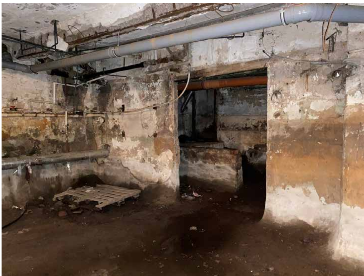
Фото 15. Вид части помещения 2-Н объекта культурного наследия.
