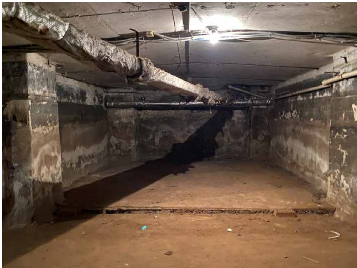
Фото 23. Вид части помещения 2-Н объекта культурного наследия.
