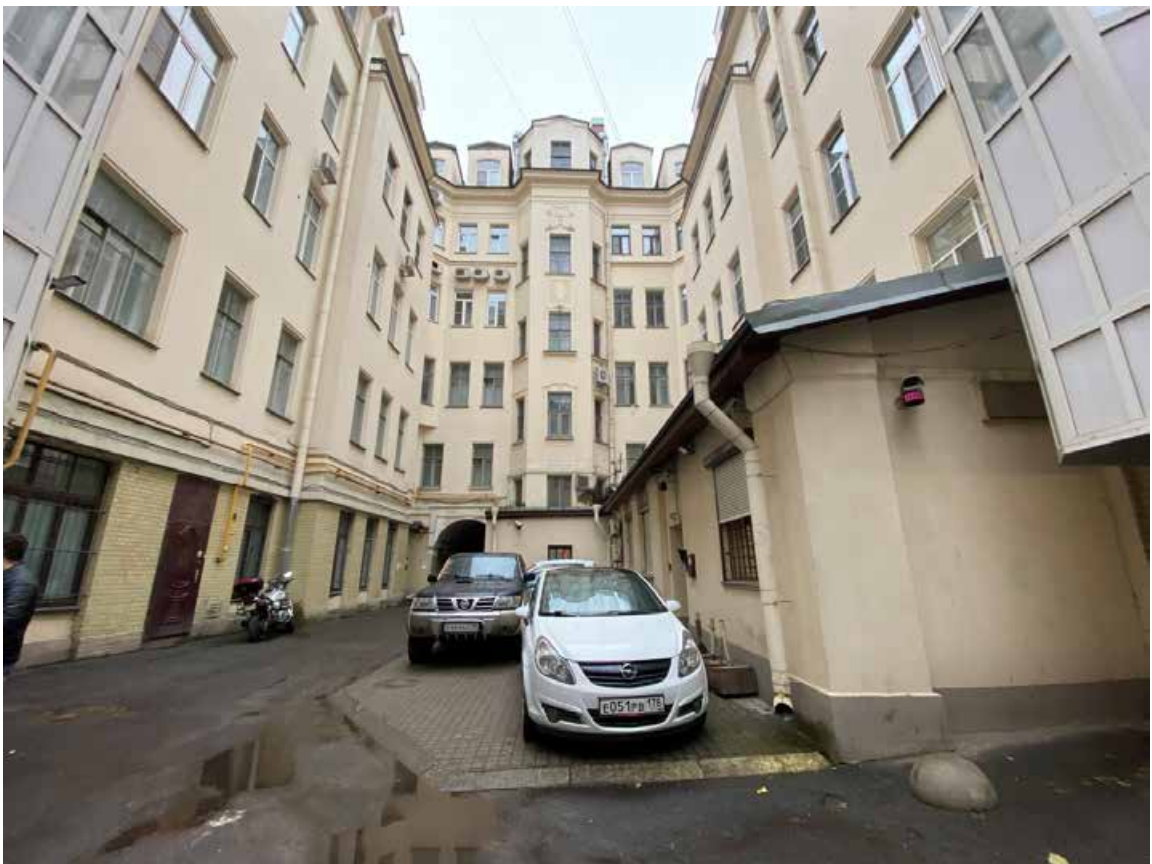
Фото 6. Вид на дворовые фасады объекта культурного наследия.
