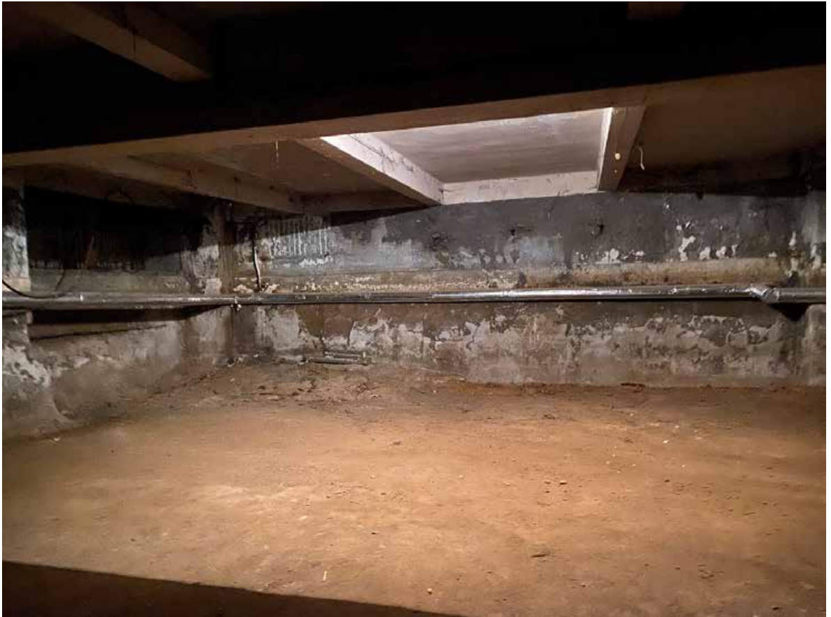
Фото 28. Вид части помещения 2-Н объекта культурного наследия.
