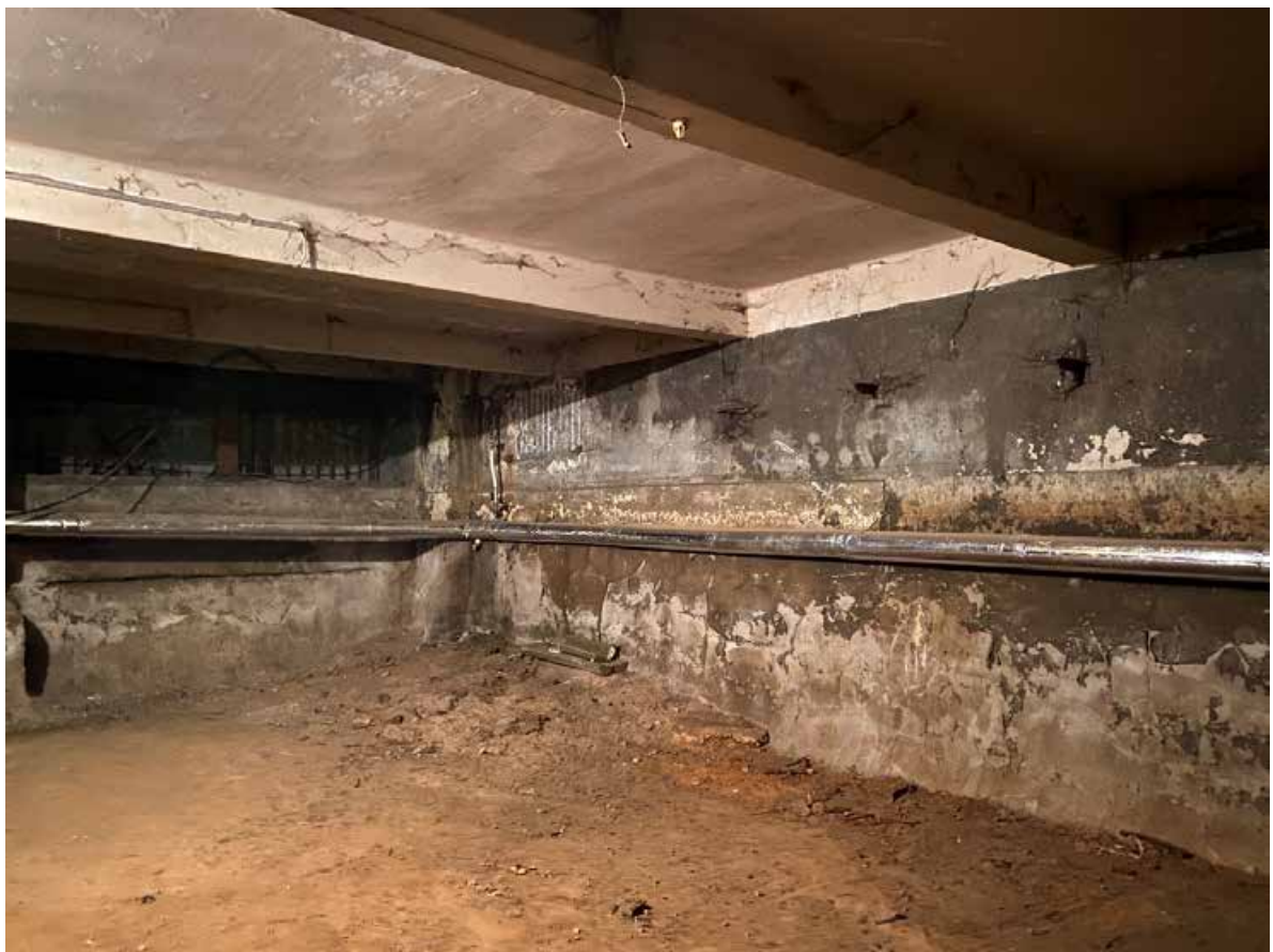
Фото 25. Вид части помещения 2-Н объекта культурного наследия.
