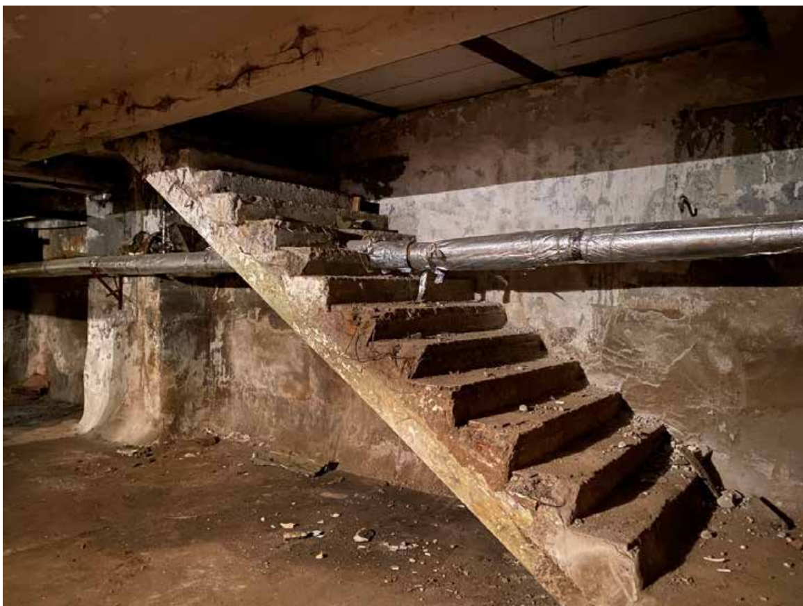
Фото 22. Вид на лестницу в части помещения 2-Н объекта культурного наследия.
