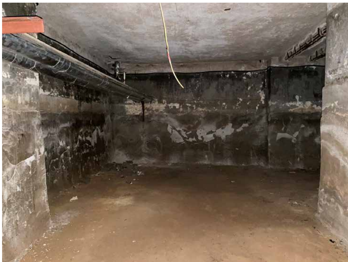
Фото 27. Вид части помещения 2-Н объекта культурного наследия.
