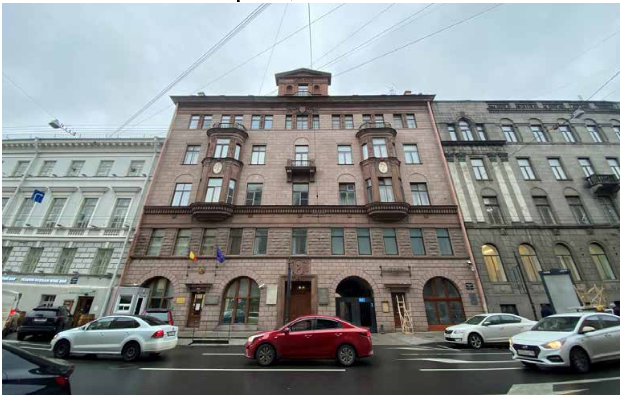
Фото 1. Вид на лицевой фасад объекта культурного наследия по Гороховой улице.
