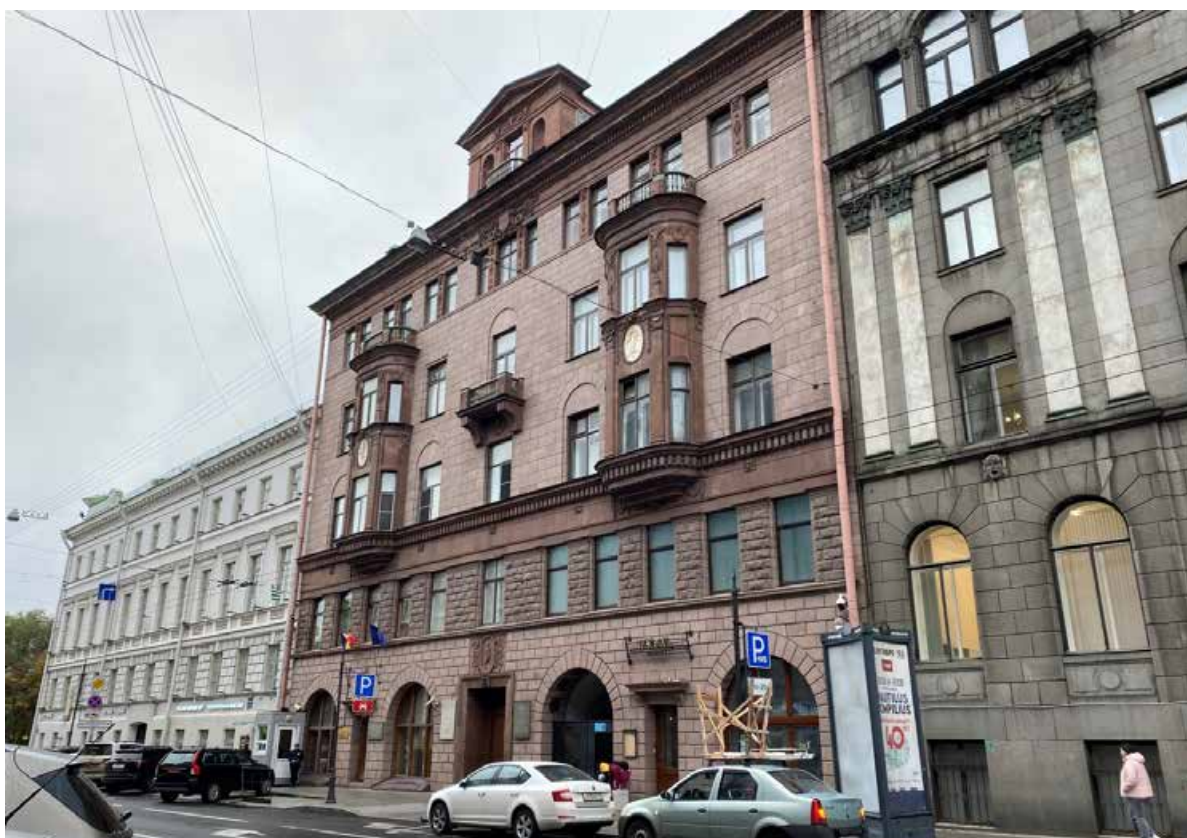
Фото 3. Вид на лицевой фасад объекта культурного наследия по Гороховой улице.
