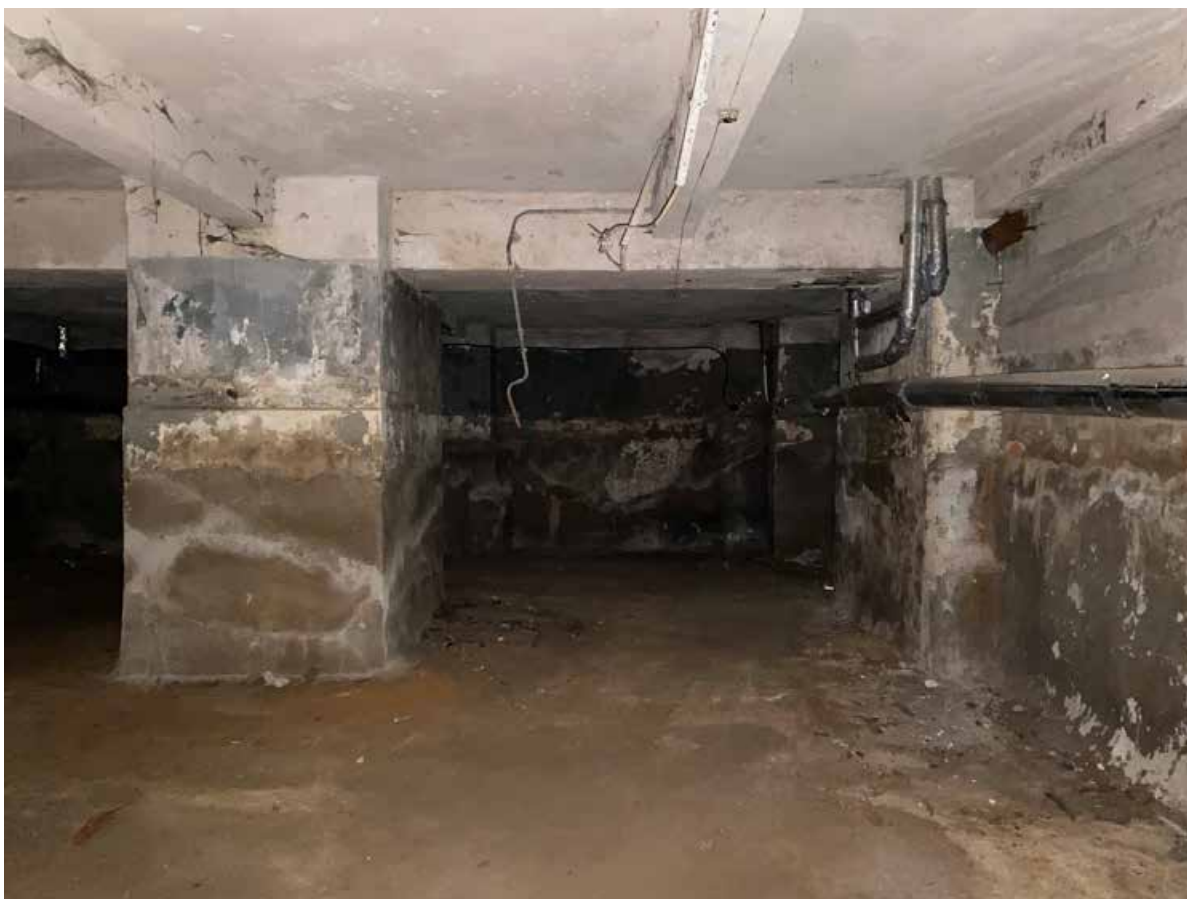
Фото 26. Вид части помещения 2-Н объекта культурного наследия.
