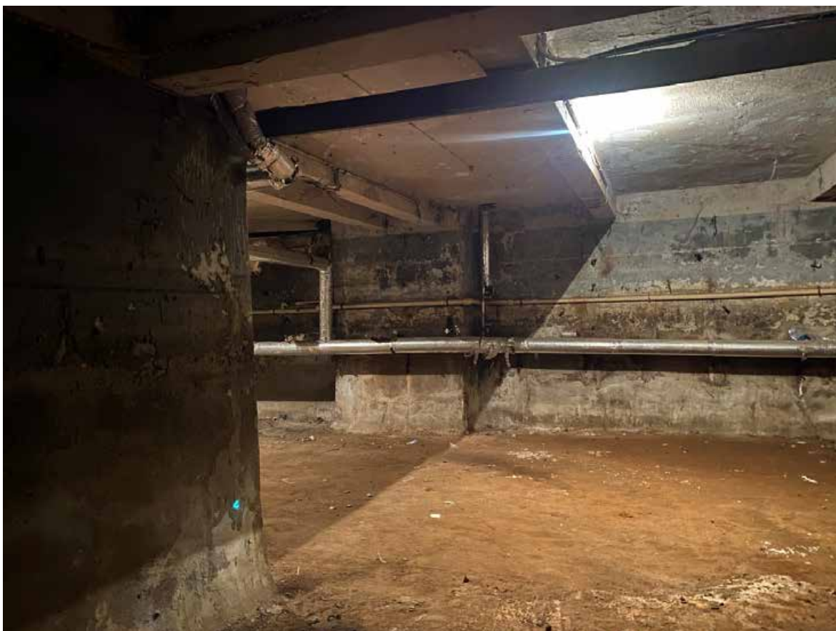
Фото 20. Вид части помещения 2-Н объекта культурного наследия.
