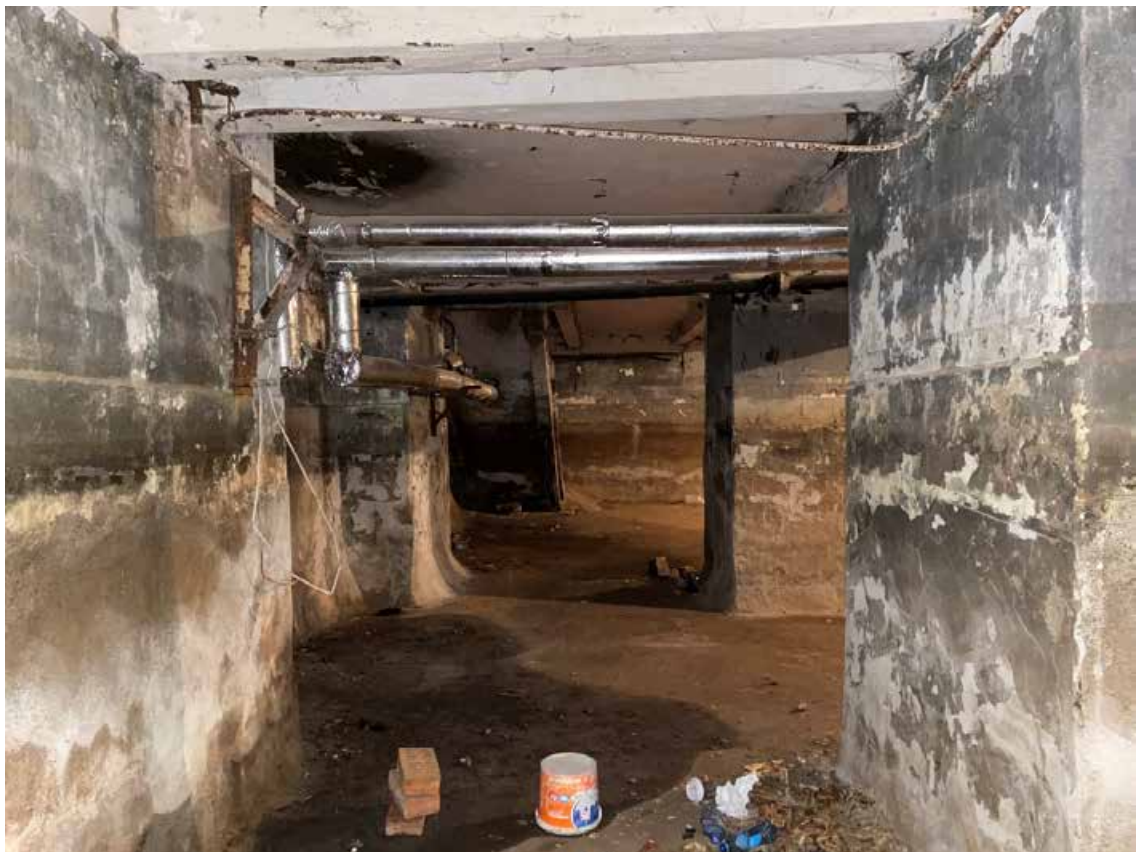
Фото 19. Вид части помещения 2-Н объекта культурного наследия.
