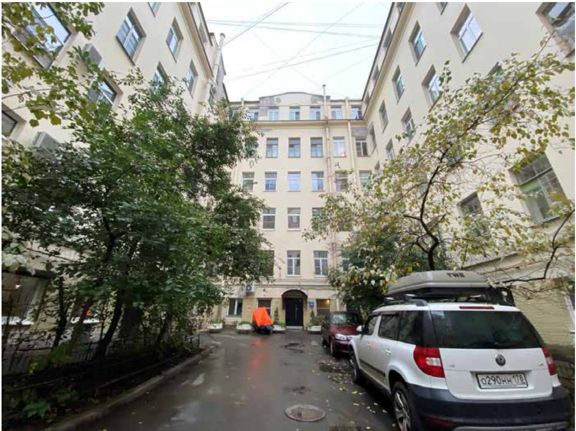
Фото 5. Вид на дворовые фасады объекта культурного наследия.
