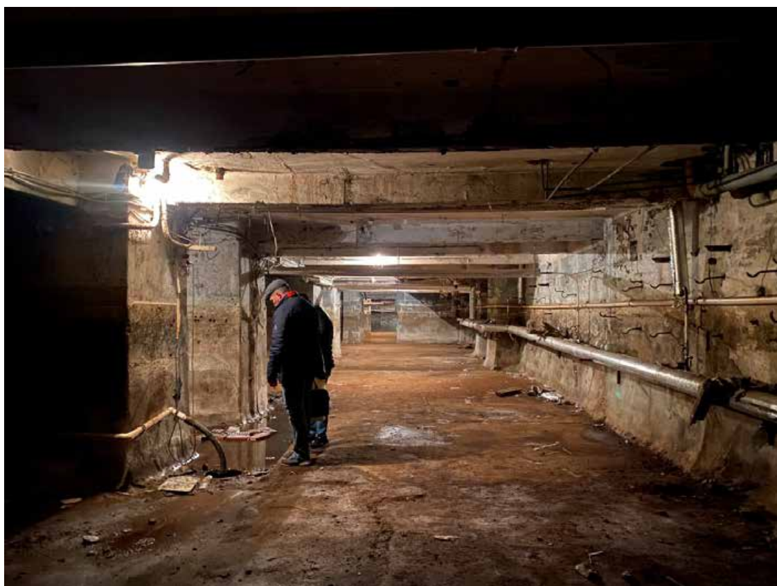
Фото 17. Вид части помещения 2-Н объекта культурного наследия.
