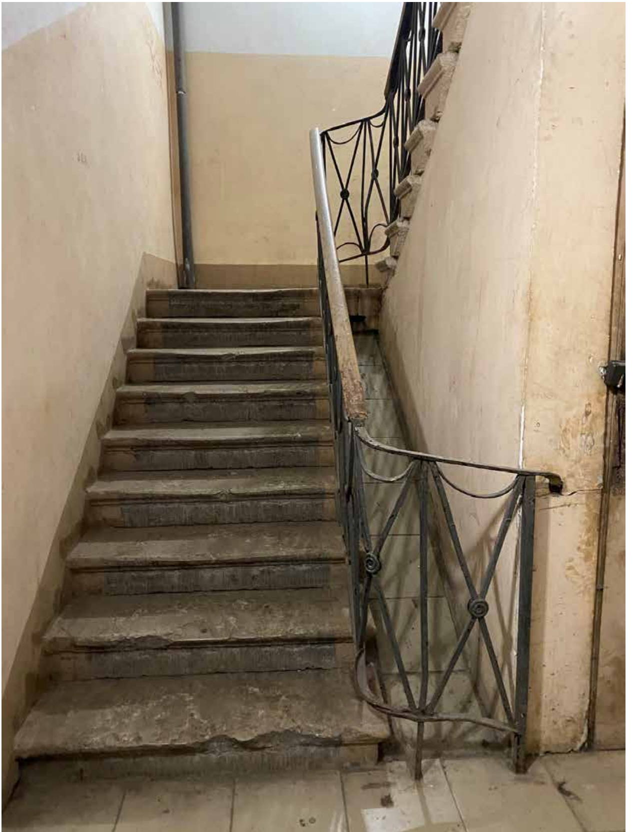
Фото 29. Вид на лестницу объекта культурного наследия при помещении с ГРЦ.
