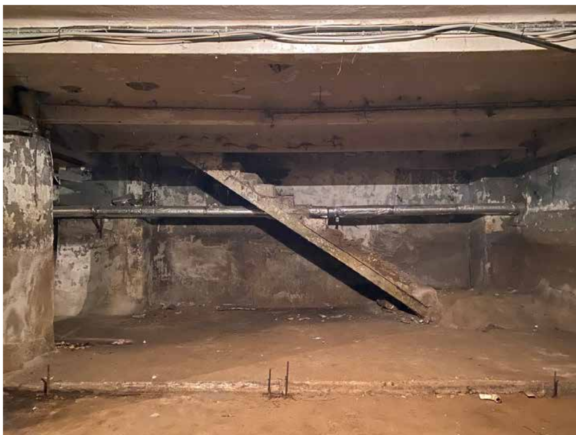
Фото 21. Вид части помещения 2-Н объекта культурного наследия.
