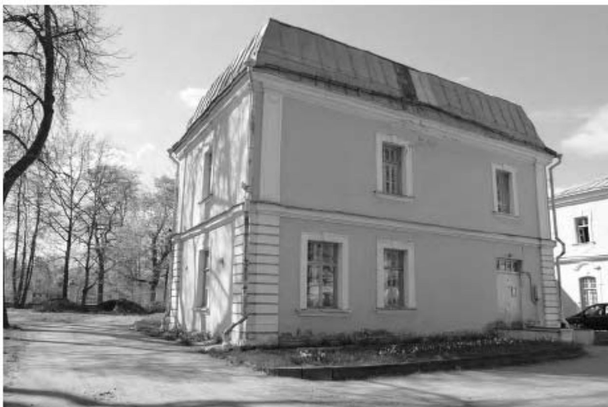
Фото 05. ОКН федерального значения «Дворцово-парковый ансамбль Верхнего парка и Нижнего сада». Службы дома садовника. Съёмка 10.06.2022 г.
