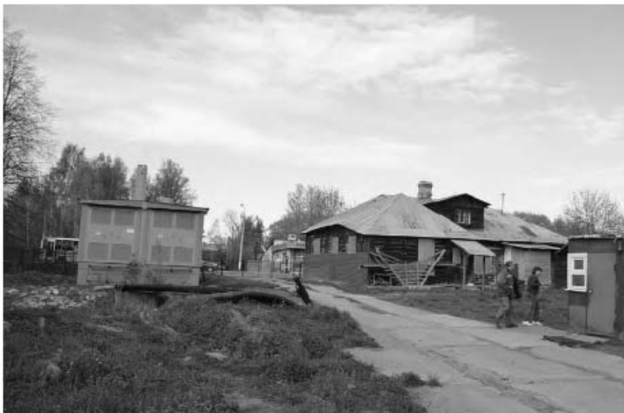
Фото 27. ОКН федерального значения «Дворцово-парковый ансамбль Верхнего парка и Нижнего сада». Фрагмент парка. Дом казначея. Съёмка 10.06.2022 г.
