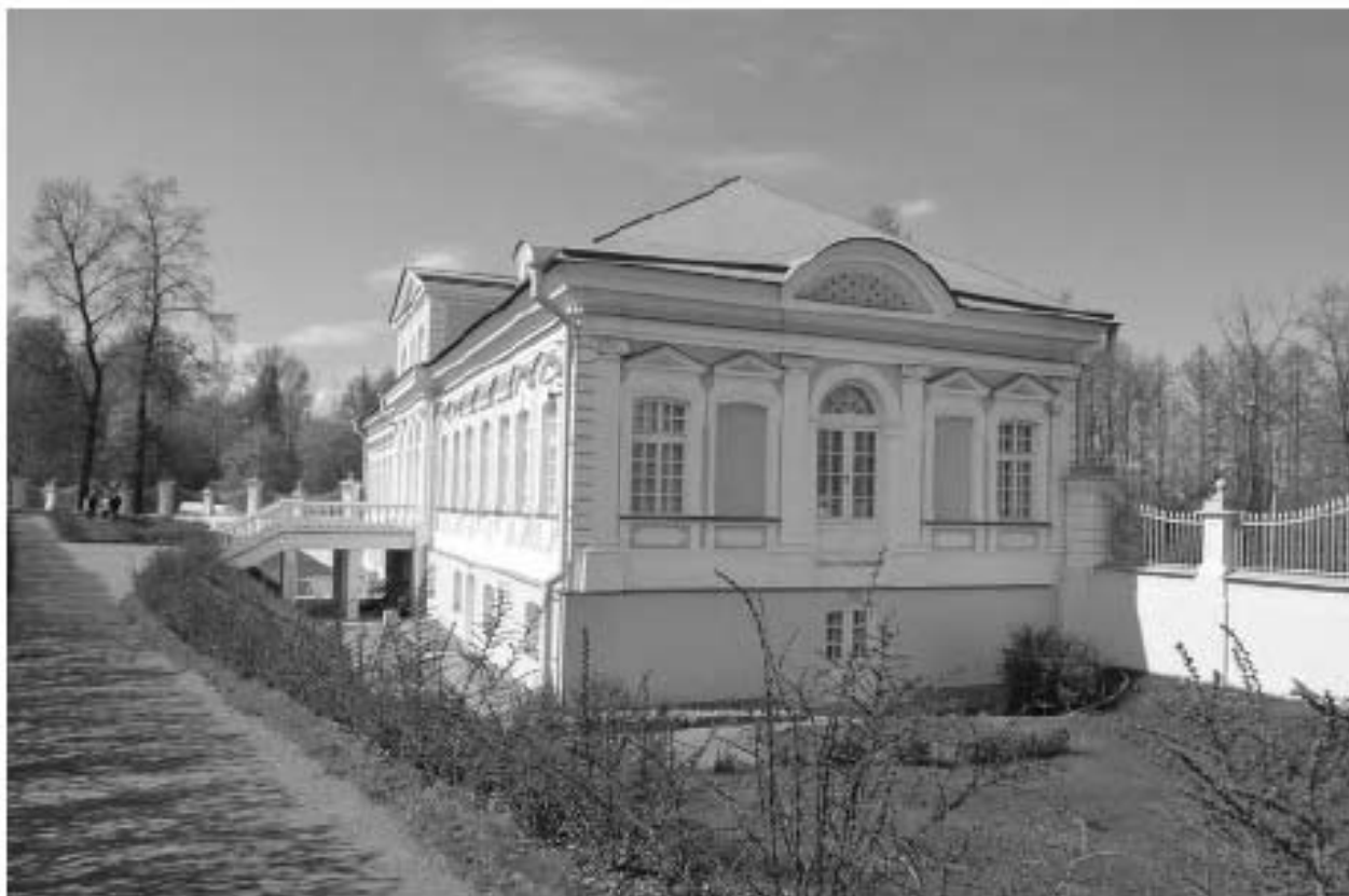
Фото 16. ОКН федерального значения «Дворцово-парковый ансамбль Верхнего парка и Нижнего сада». Картинный дом. Съёмка 10.06.2022 г.
