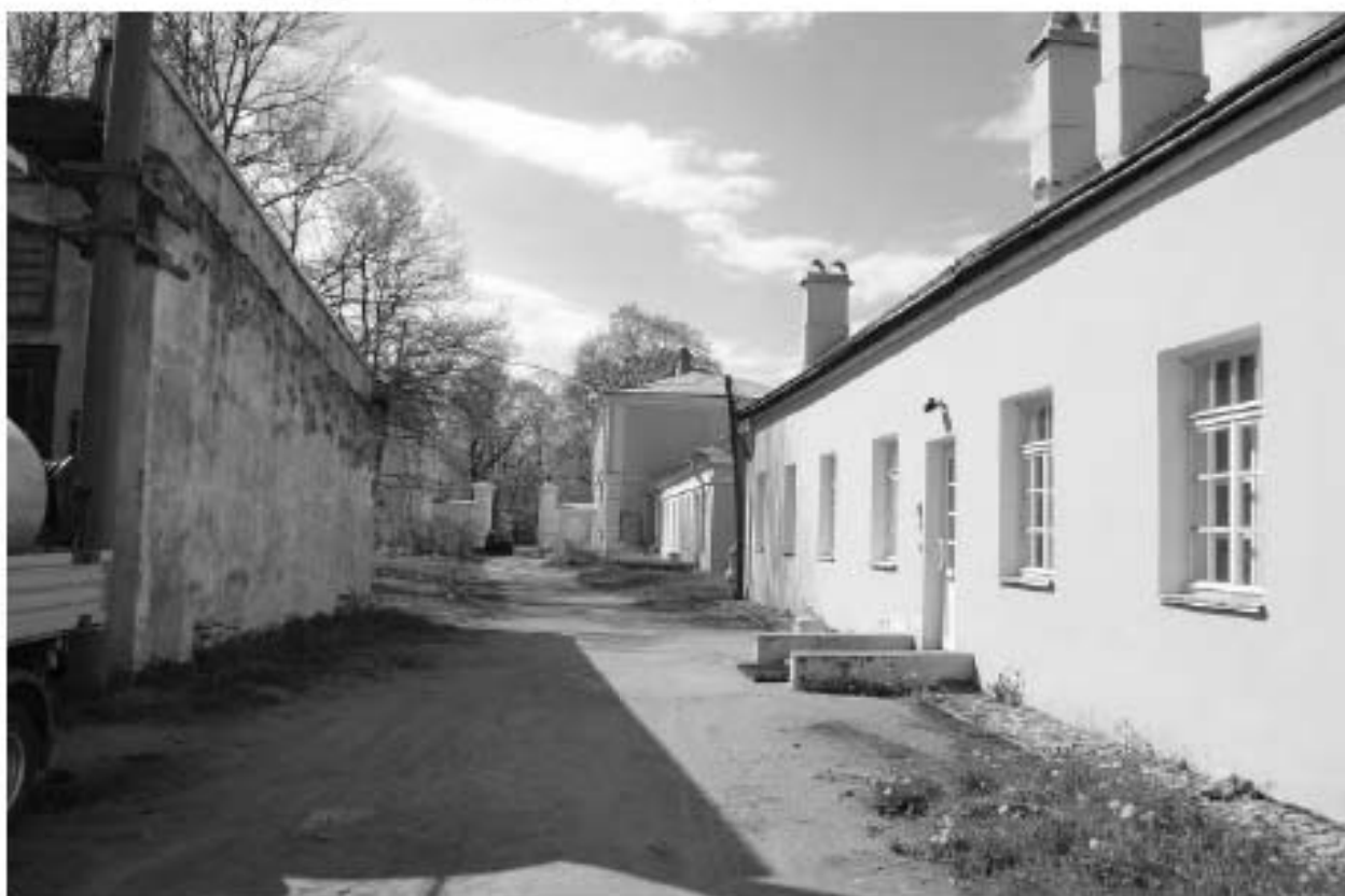
Фото 07. ОКН федерального значения «Дворцово-парковый ансамбль Верхнего парка и Нижнего сада». Центральный корпус (парники). Съёмка 10.06.2022 г.
