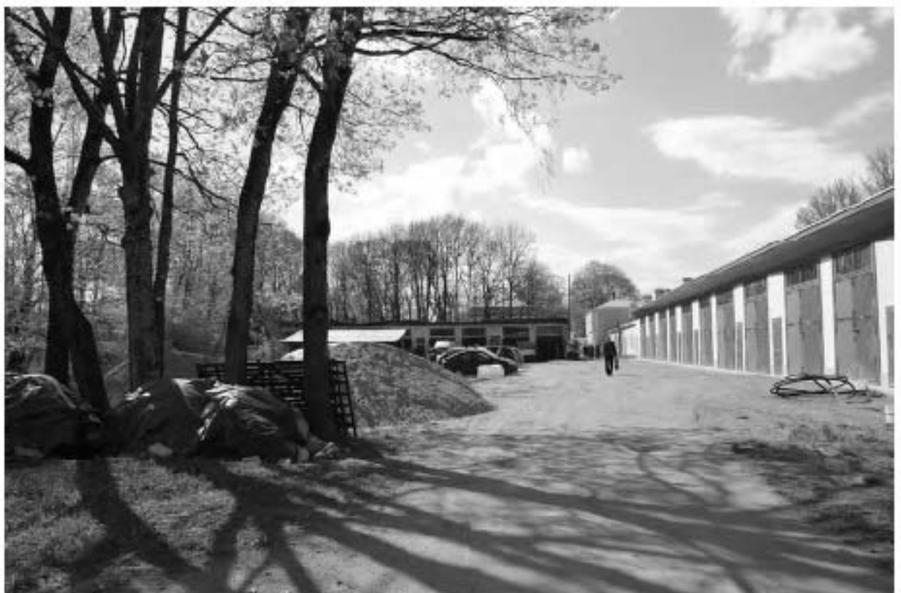
Фото 09. ОКН федерального значения «Дворцово-парковый ансамбль Верхнего парка и Нижнего сада». Центральный корпус (парники). Съёмка 10.06.2022 г.
