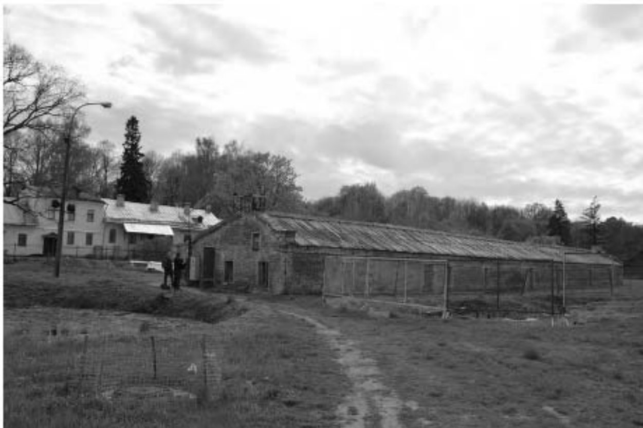
Фото 21. ОКН федерального значения «Дворцово-парковый ансамбль Верхнего парка и Нижнего сада». Фрагмент парка. Ананасная оранжерея. Съёмка 10.06.2022 г.
