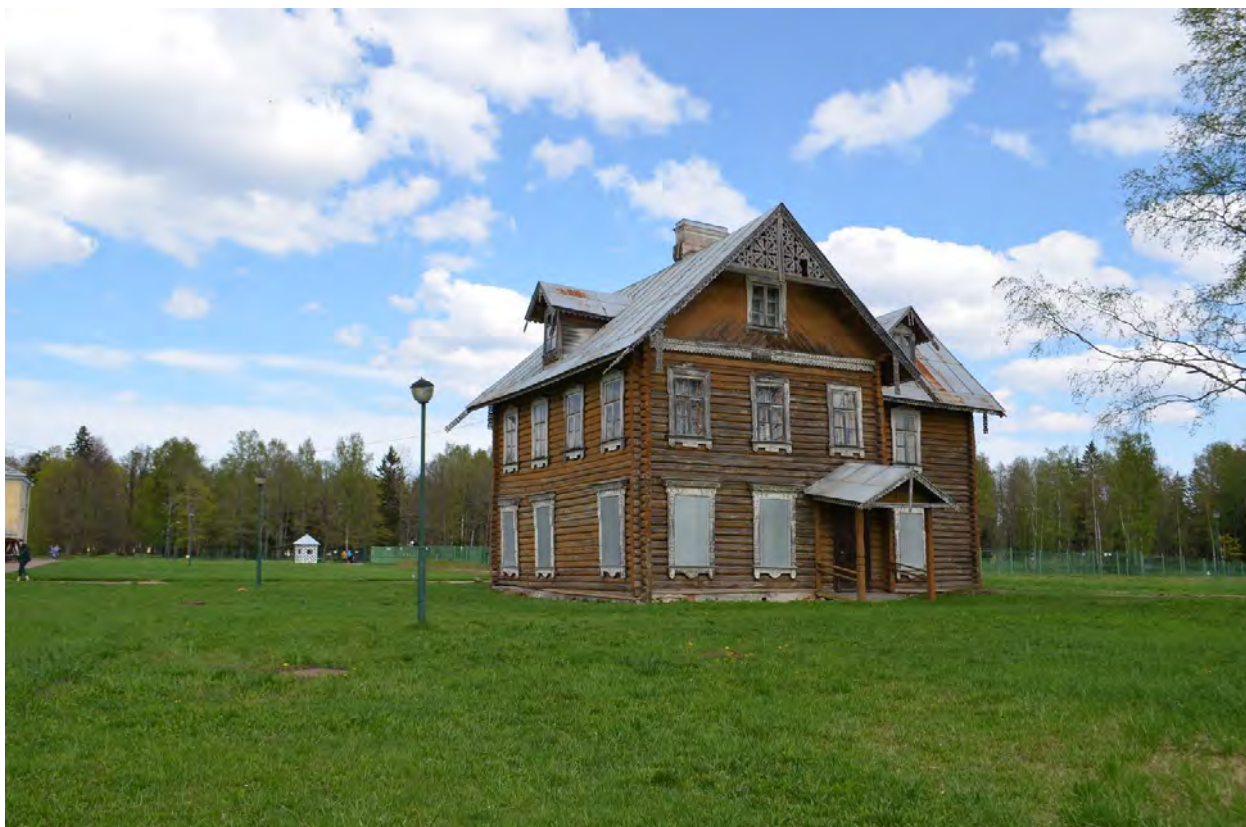
Фото 02. ОКН «Верхний парк». Вид на парк и на ОКН «Дворцовые конюшни и жилой дом». Общий вид. Съёмка 10.06.2022 г.
