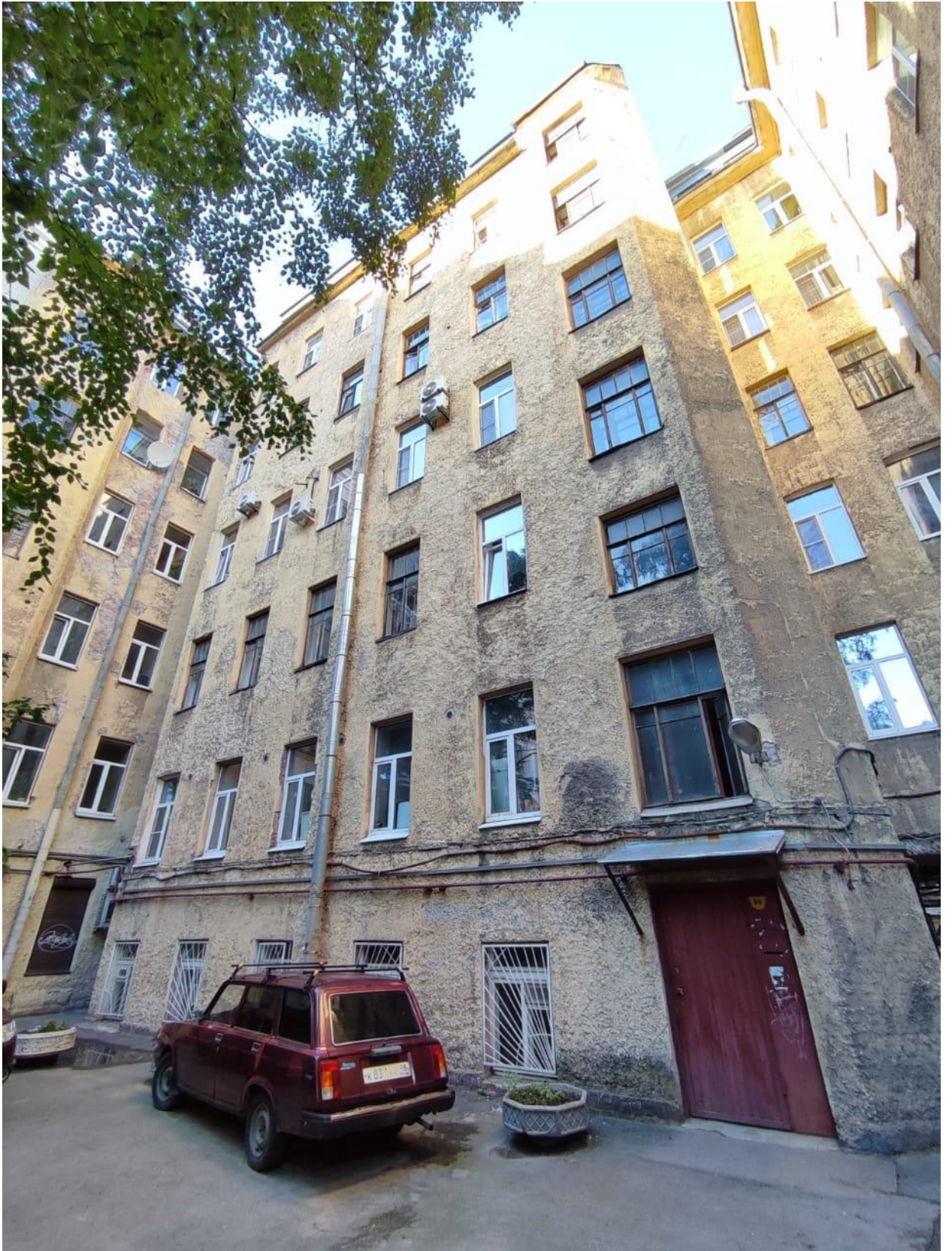
Фото №2. Вид на фасад здания со стороны двора.
