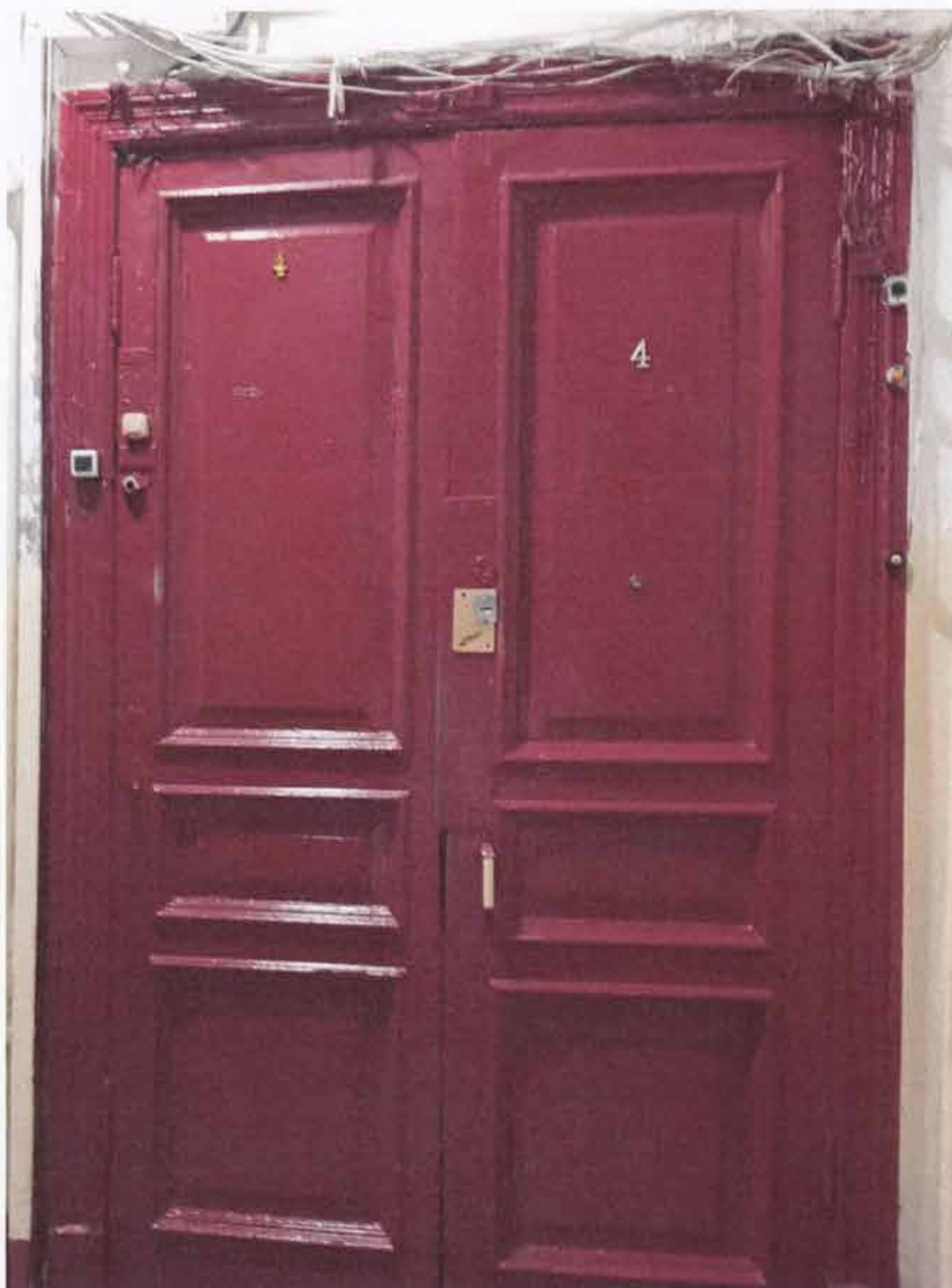
18. Объект культурного наследия федерального значения «Дом, где в 1912- 1941 гг. жил изобретатель парашюта Г.Е.Котельников». Санкт-Петербург, 14 линия В.О., 31-33. Входная дверь в кв.4, расположенную на 3-м этаже, под кв. 6. Видны металлические накладки, многочисленные покраски создали искажение профилей, оформляющих фигарей.
