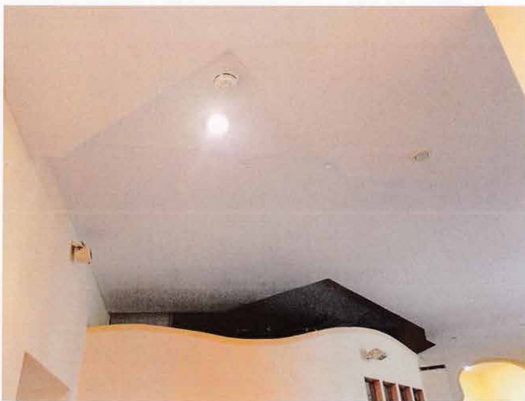
36. Объект культурного наследия федерального значения «Дом, где в 1912- 1941 гг. жил изобретатель парашюта Г.Е.Котельников». Санкт-Петербург, 14 линия В.О., 31-33, кв.6. Помещения санузла № 6, 7, 9, 10. На потолке видны следы протечки. Часть подшивки потолка демонтирована
