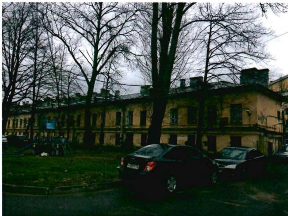
Фото 3. Западный дворовый фасад.
