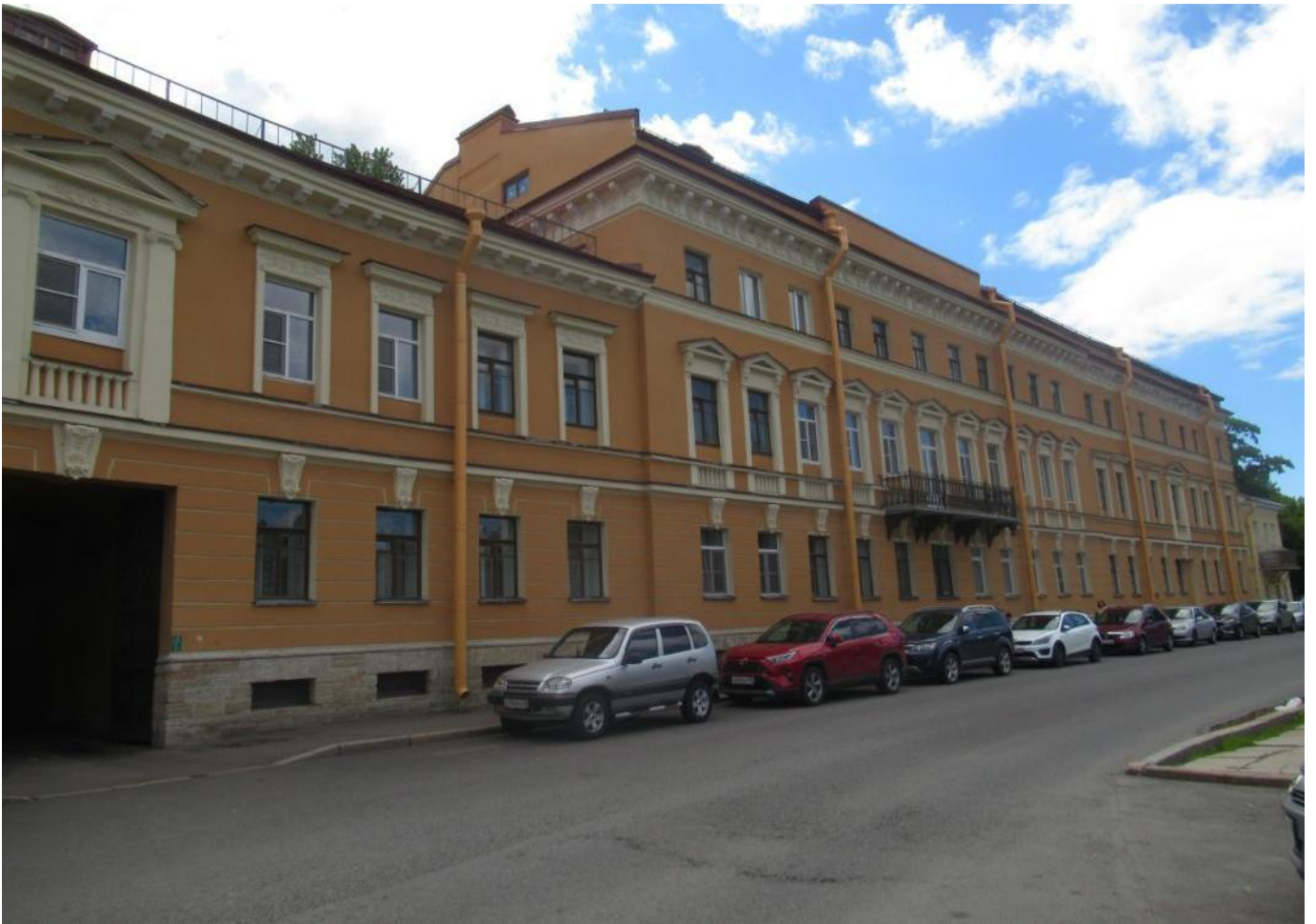
1. Лицевой (северный) фасад здания. Вид со стороны набережной реки Фонтанки.
