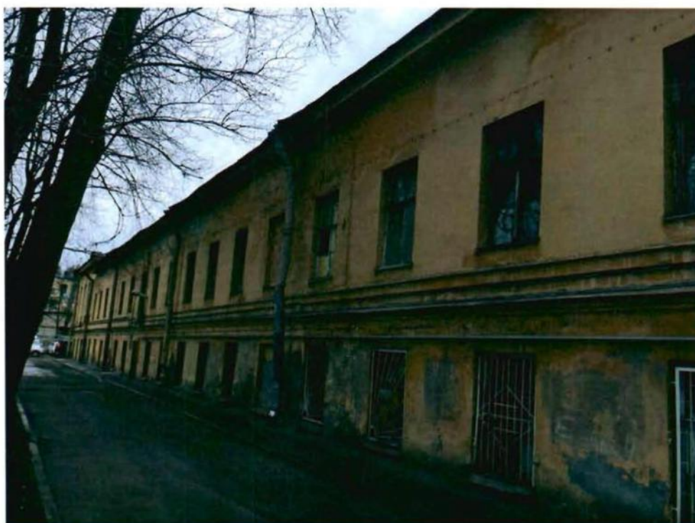
Фото 4. Восточный дворовый фасад.
