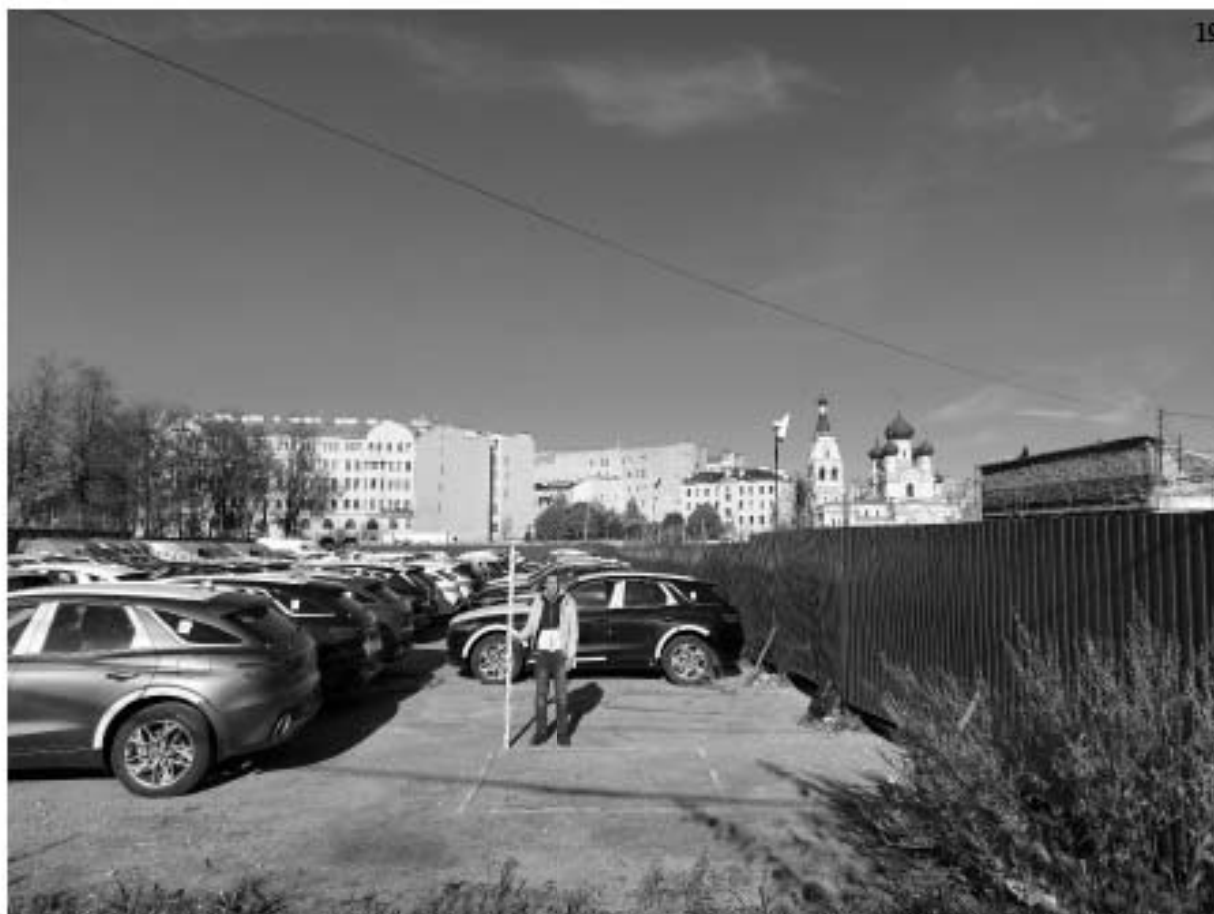
Илл. 51. Санкт-Петербург, Евгеньевская ул., д. 2, лит. Б. Шурф 2. Общий вид с Ю до начала работ. Для масштаба использована рейка 2 м.
