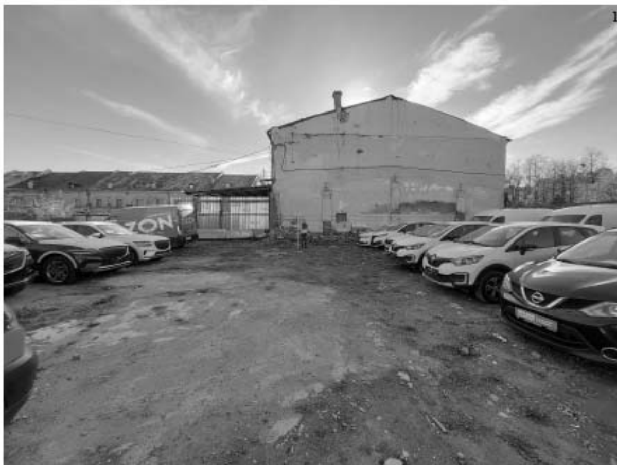
Илл. 25. Санкт-Петербург, Евгеньевская ул., д. 2, лит. Б. Точка фотофиксации 5. Общий вид на обследуемый участок с С. Для масштаба использована рейка длиной 2 м.
