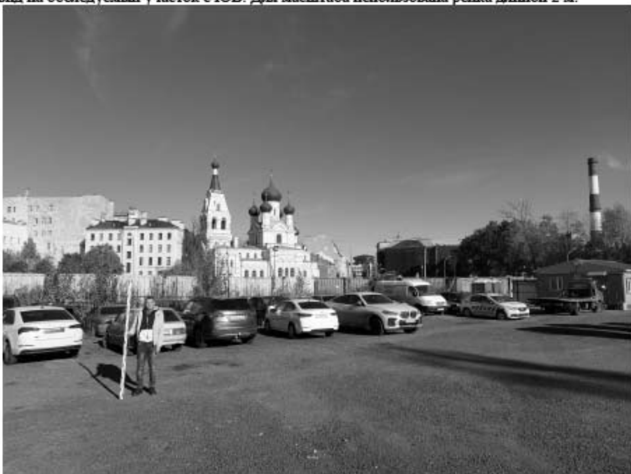
Илл. 31. Санкт-Петербург, Евгеньевская ул., д. 2, лит. Б. Точка фотофиксации 11. Общий вид на обследуемый участок с ЮЗ. Для масштаба использована рейка длиной 2 м.
