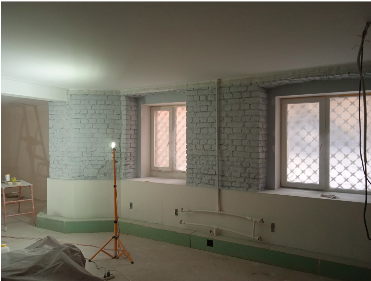
6. “Дом В.В. Фофановой”. Санкт-Петербург, 6-я Красноармейская ул., дом 3, лит.А. Фрагмент интерьера помещения 1-Н. Фото: 29.10.2022.
