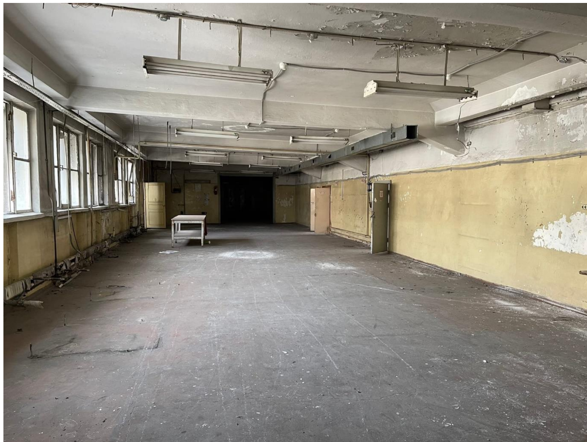
Фото 33. Помещение 15. Лит. А.
