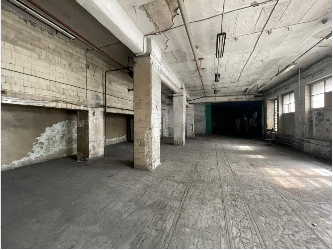
Фото 20. Помещение 6. Лит. Б.
