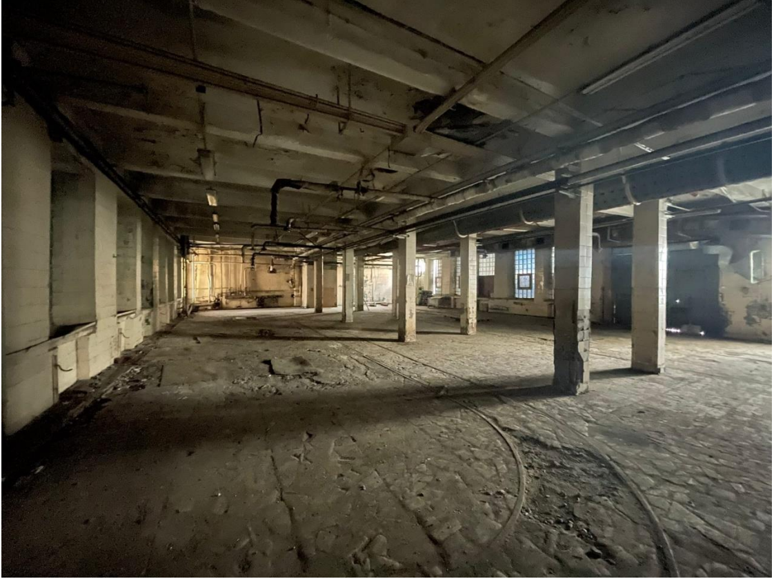
Фото 22. Помещение 7. Лит. Б.
