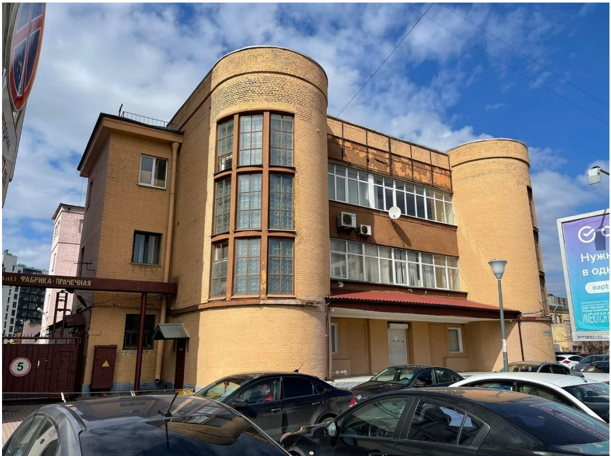
Фото 2. Фасад по Лиговскому пр. Юго-запад.
