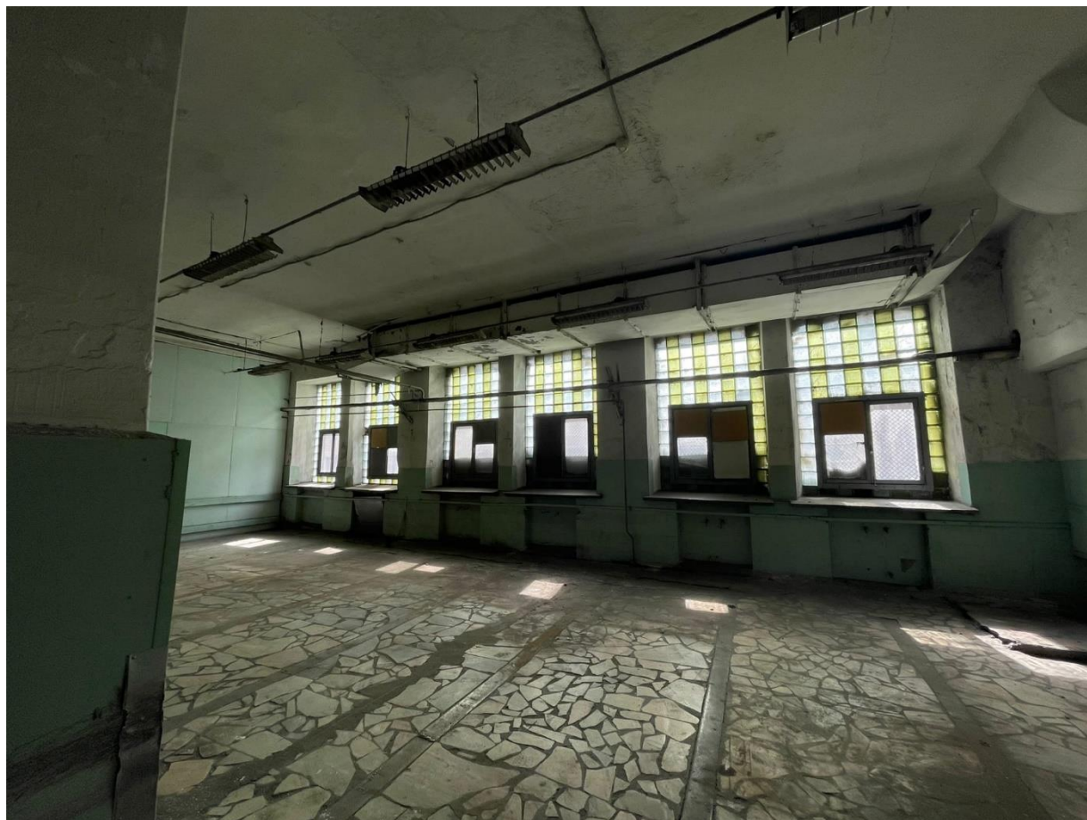
Фото 27. Помещение 9. Лит. Б.
