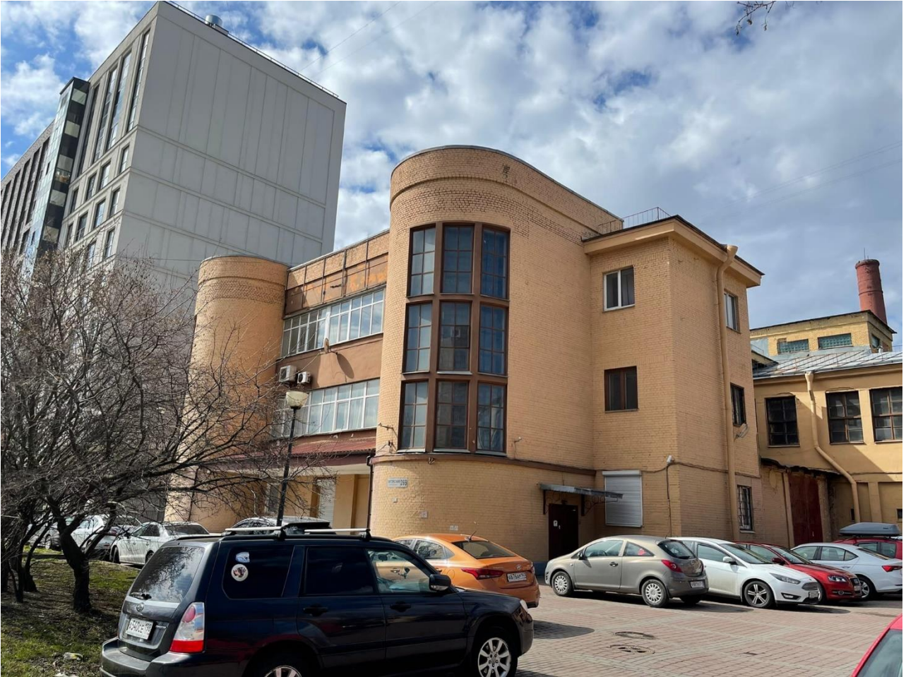
Фото 1. Фасад по Лиговскому пр. Юго-восток.
