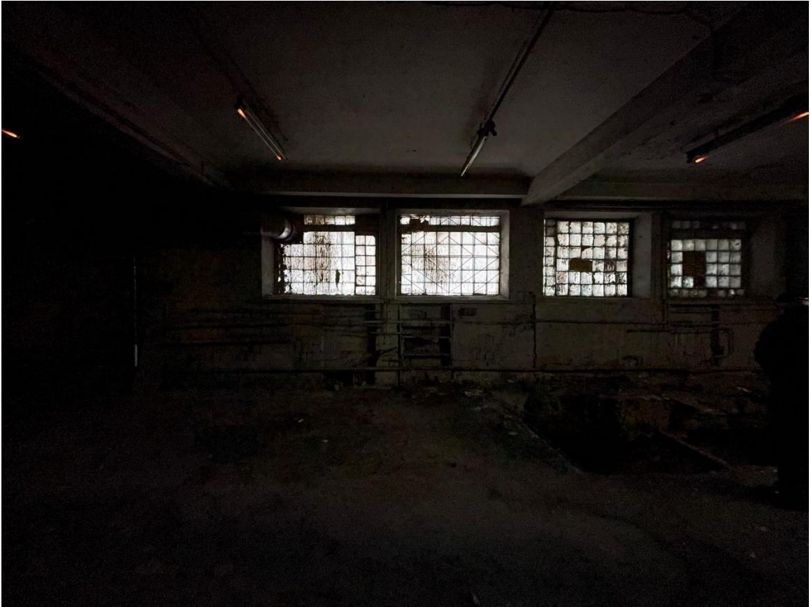
Фото 12. Помещение 2. Лит. А.
