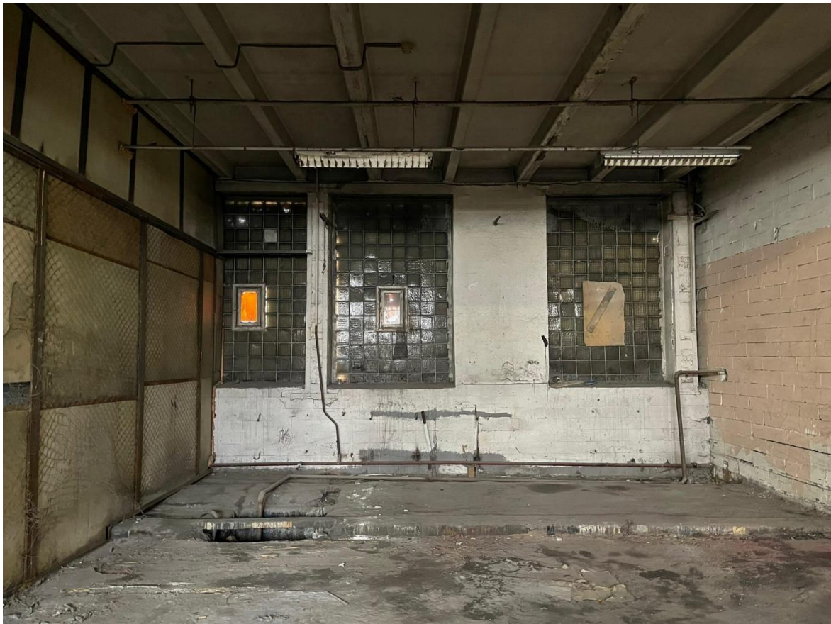
Фото 15. Помещение 4. Лит. Б.
