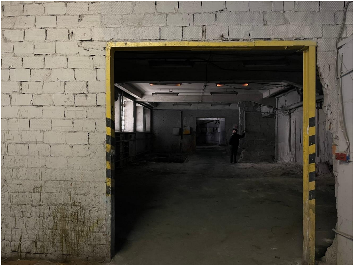
Фото 11. Помещение 1. Лит. А.
