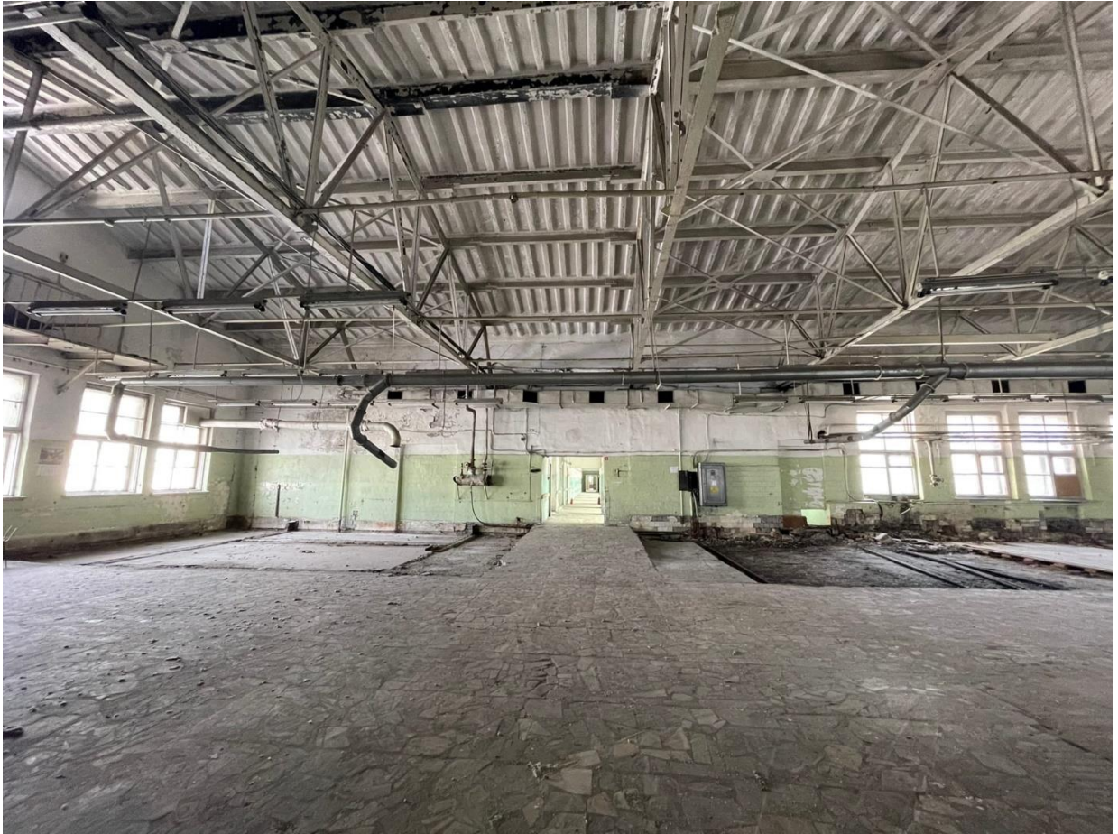
Фото 25. Помещение 8. Лит. Б.
