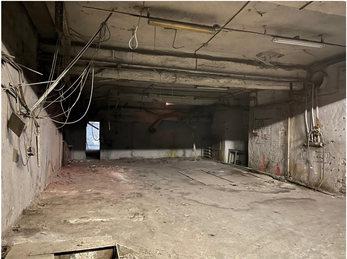
Фото 13. Помещение 3. Лит. А.
