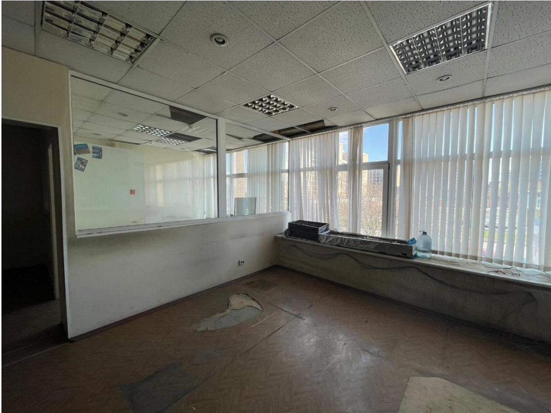
Фото 35. Помещение 23. Лит. А.
