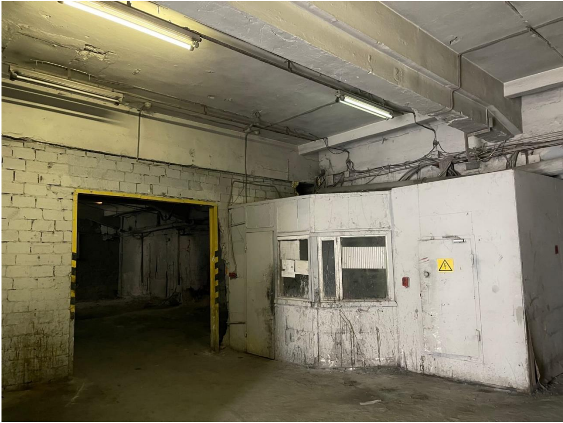
Фото 10. Помещение 1. Лит. А.
