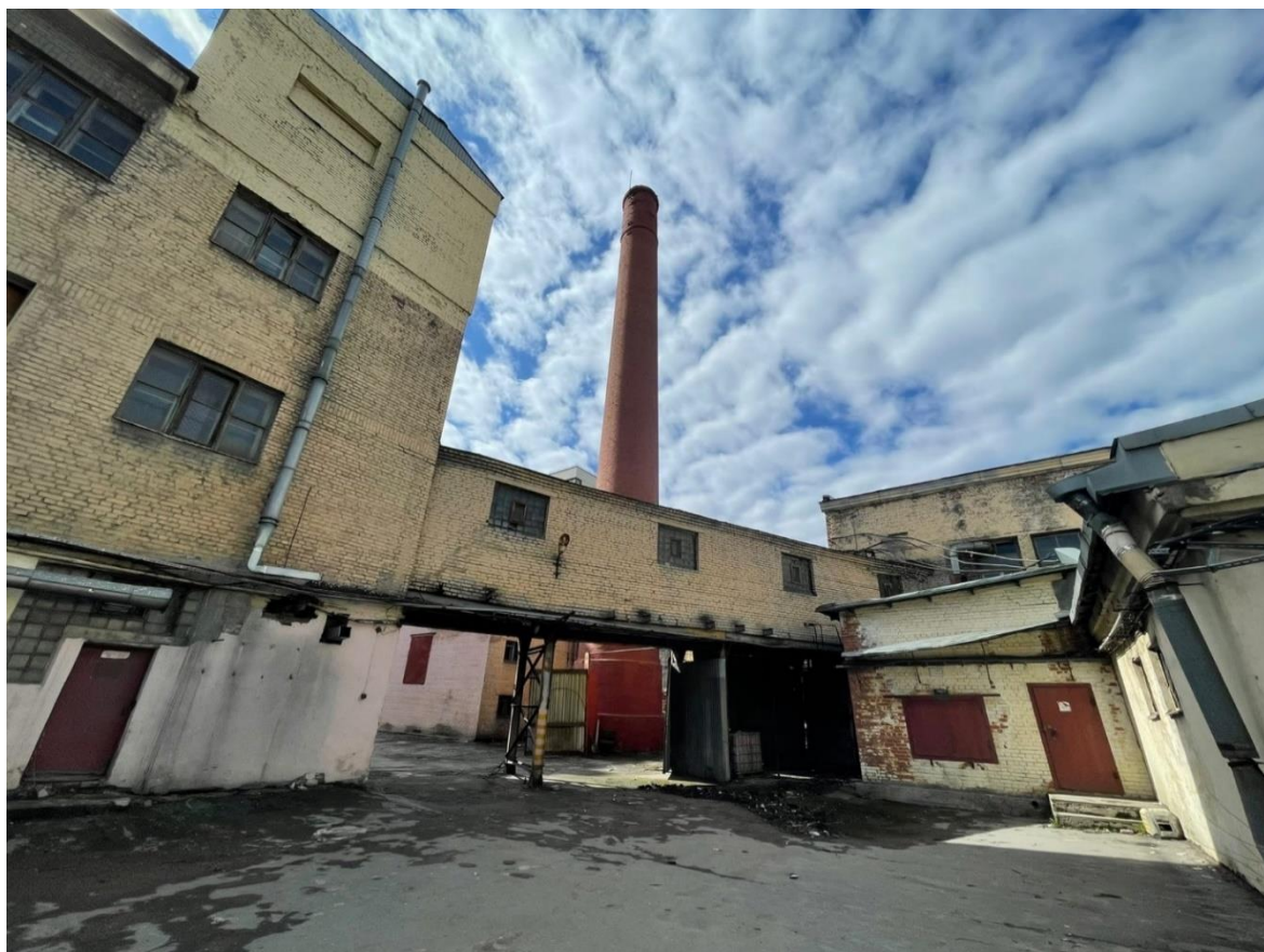
Фото 4. Одноэтажный надземный переход в уровне второго этажа из лит. А в лит. Б. (реконструкция зданий 1961–1962 гг.)
