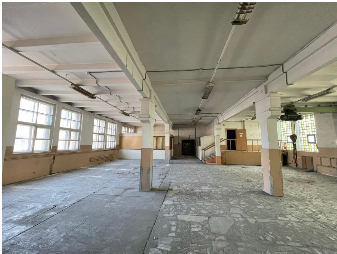
Фото 29. Помещение 11. Лит. Б.
