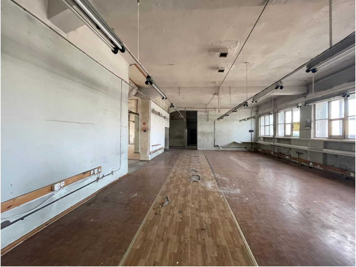
Фото 37. Помещение 16. Лит. А.
