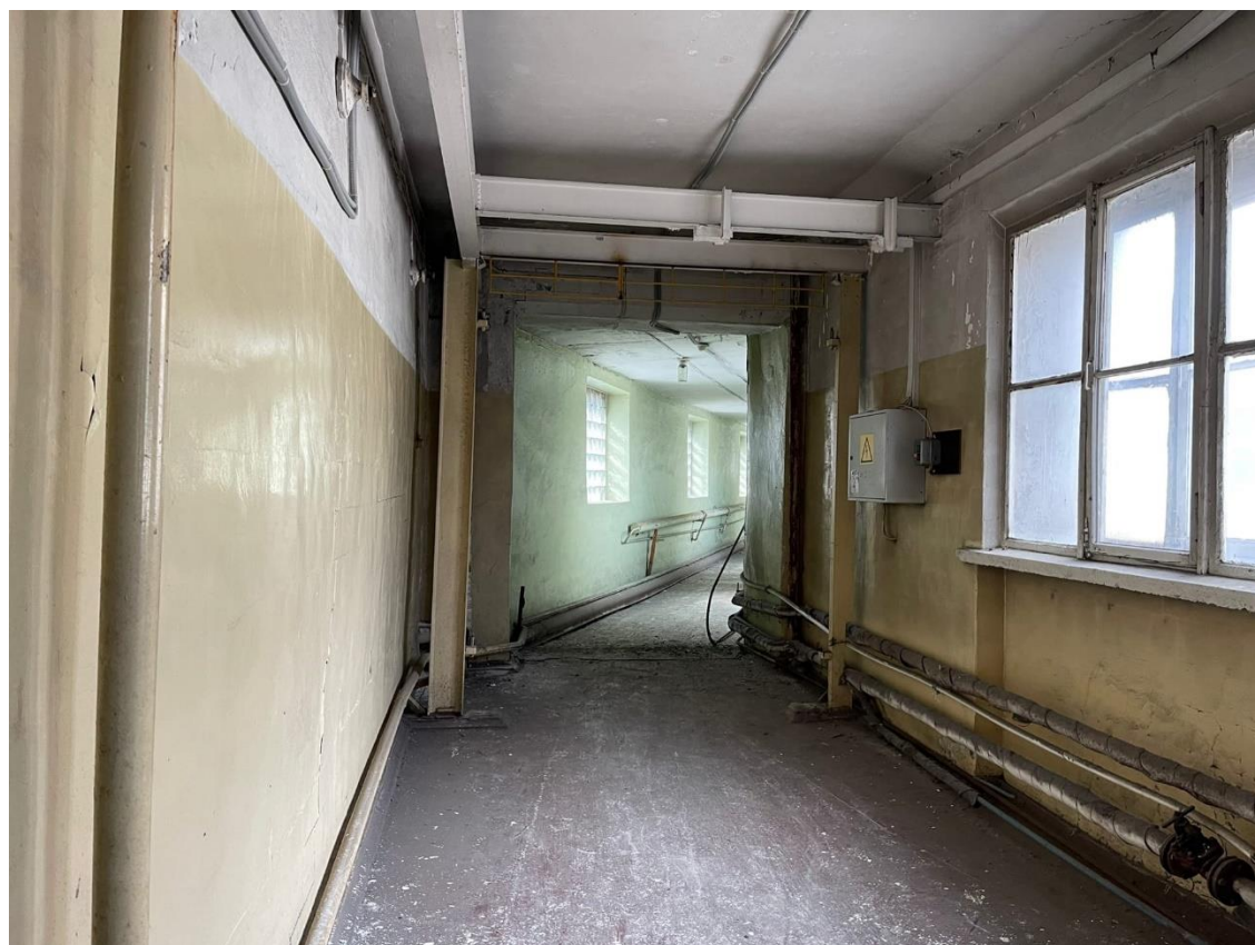
Фото 34. Помещение 15, переход в Лит. Б. по одноэтажному надземному переходу. Лит. А.
