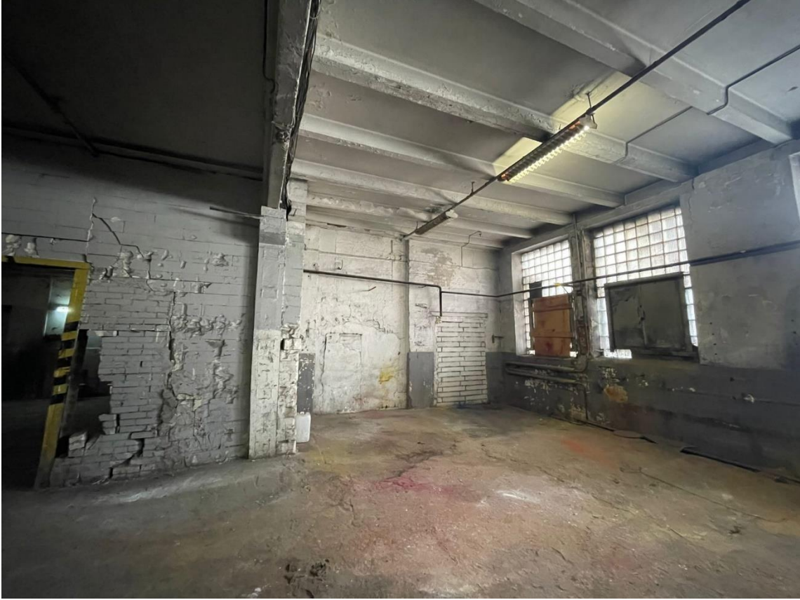
Фото 14. Помещение 4. Лит. Б.
