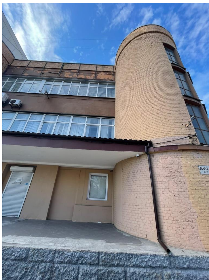
Фото 8. Фрагмент лицевого фасада по Лиговскому пр.
