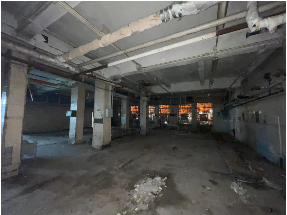
Фото 21. Помещение 7. Лит. Б.
