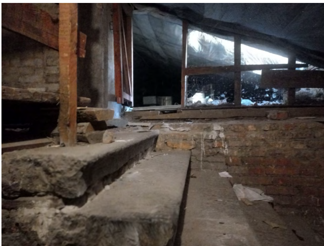
Фото 36 и 37. Помещения чердака.
