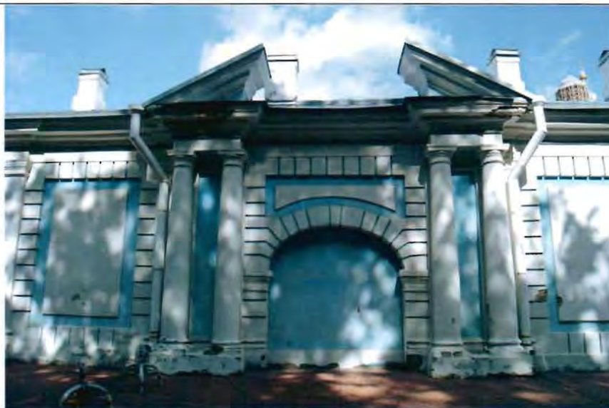
1. (Фрагмент южного фасада ограды)
