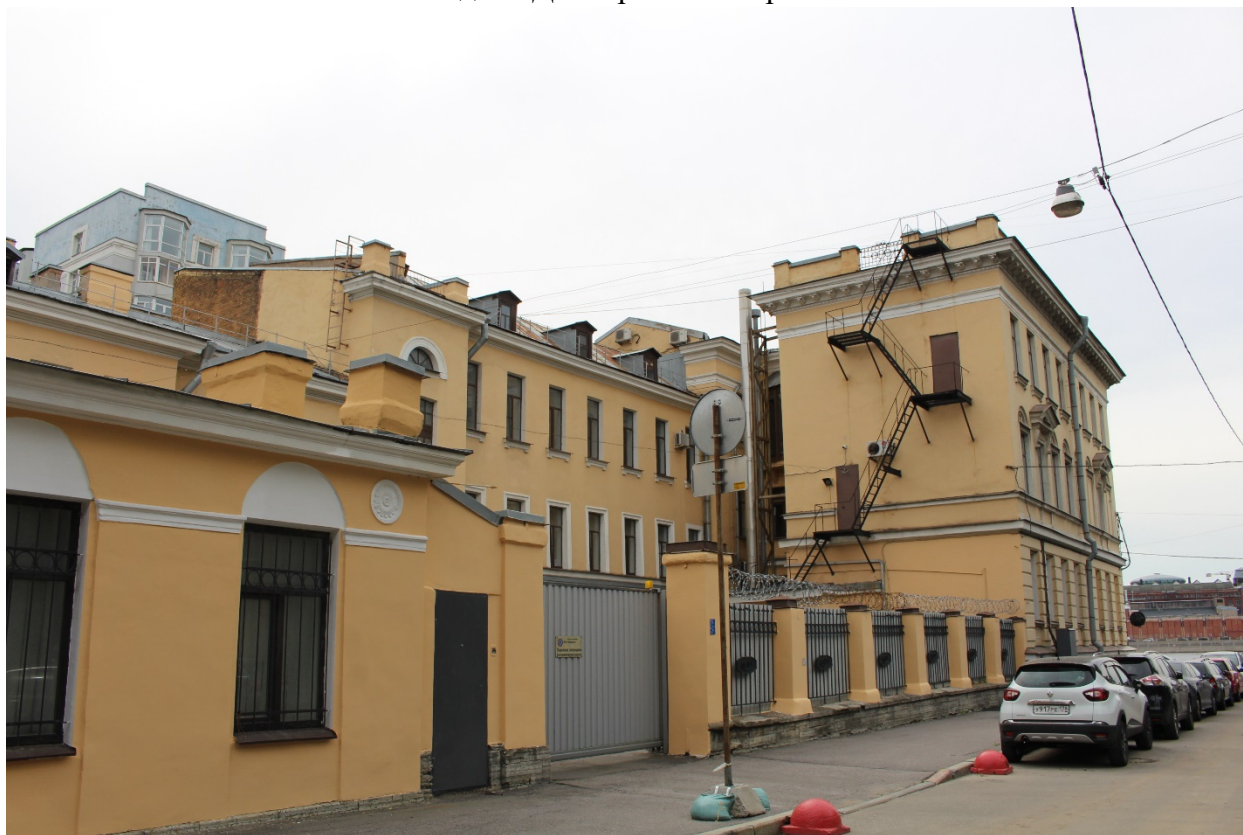
Фото 8. Вид на северный фасад дворовых корпусов выявленного объекта культурного наследия «Дом-приют Кокоревых».
