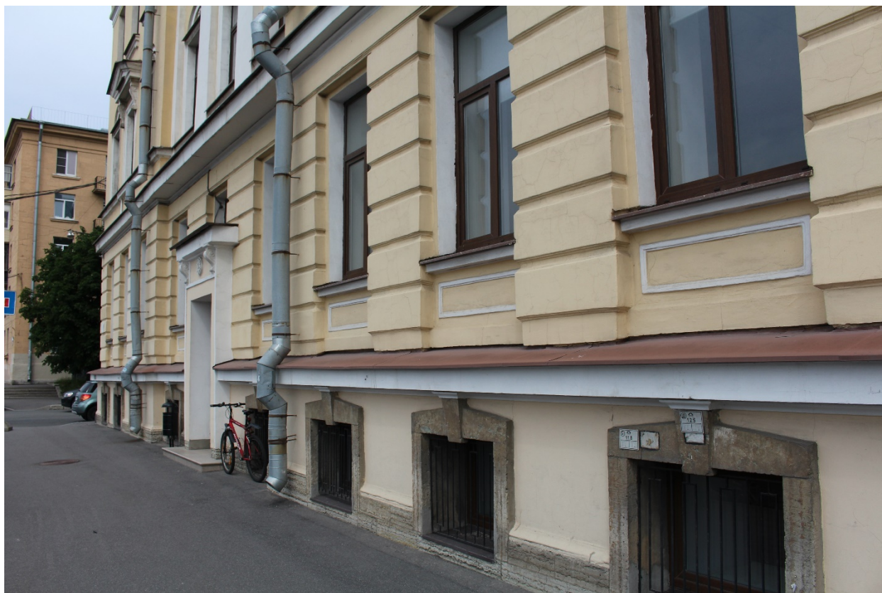
Фото 3. Вид на западный (лицевой) фасад лицевого корпуса выявленного объекта культурного наследия «Дом-приют Кокоревых» в уровне цокольного и 1-го этажей.
