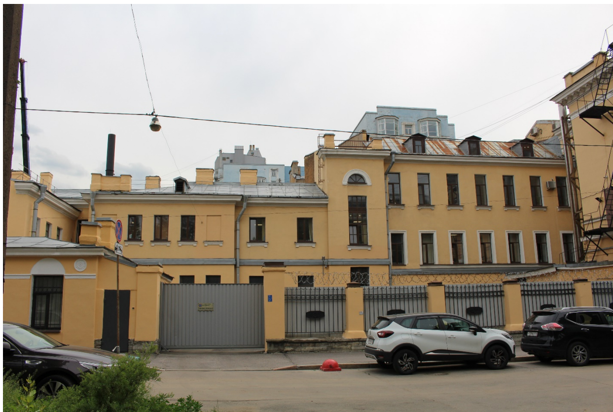
Фото 7. Вид на северный фасад дворовых корпусов выявленного объекта культурного наследия «Дом-приют Кокоревых».
