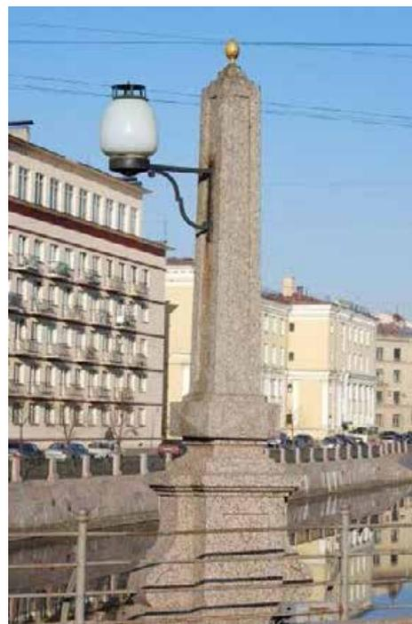
фонари – овальной формы с двумя металлическими чашами со стеклянным матовым плафоном, основание нижних чаш декорировано литыми розетками;
