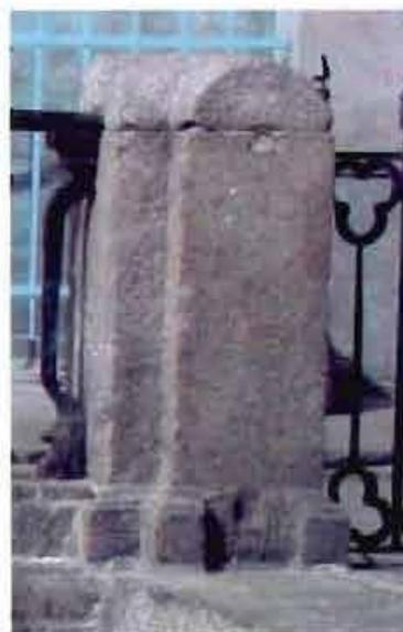
на участке от пересечения с Крюковым каналом и до р. Фонтанки – вертикальные тумбы простой формы с профилированным плинтом и завершением в виде усеченной трапеции;
