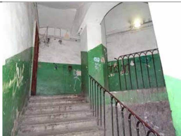
4-ЛК – трехмаршевую, с известняковыми ступенями и площадками, с металлическим ограждением из вертикальных прутьев, с фризом с мотивом «бегущая волна» по верхнему поясу; с поворотными стойками, круглыми в сечении, завершенными шарами; по внешнему краю фланкировано волнитообразными кронштейнами.
