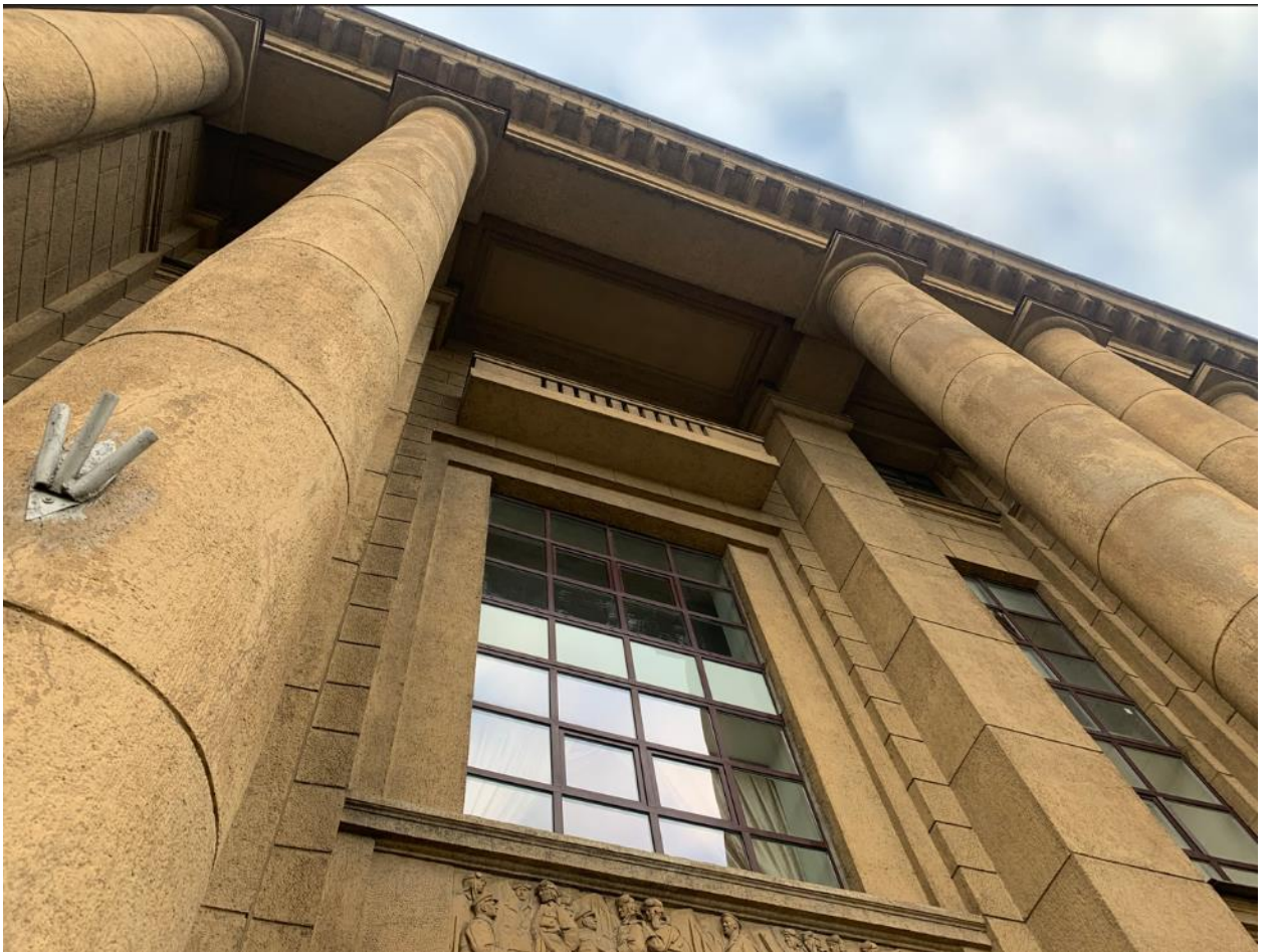
16. Западный фасад. Лоджия. 03.06.2022
