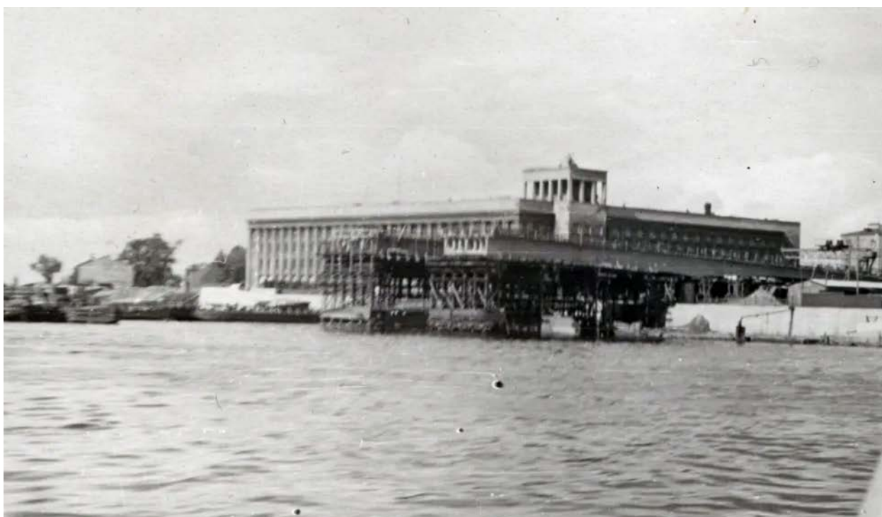
36. Ю. Туйск. Строительство моста Фотография 1963 г. ( https://pastvu.com/p/809672 )
