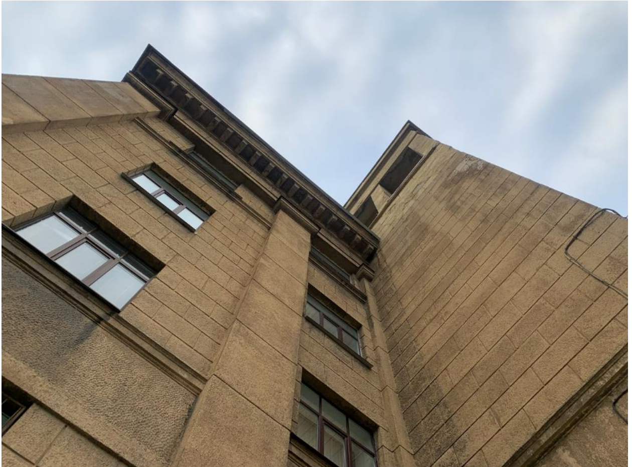
9. Южный фасад. Фрагмент угловой части с башней. 03.06.2022
