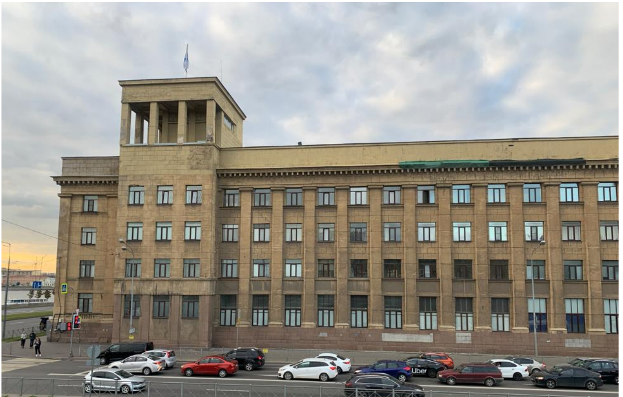
2. Южный фасад. Вид с моста Александра Невского. 03.06.2022
