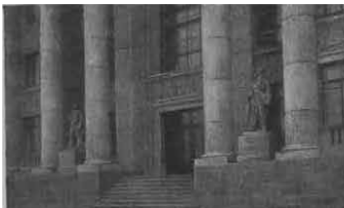
28. Здание СККС. Входная группа. Фотография 1938 г. (Ежегодник Ленинградского отделения Союза советских архитекторов 1934-1939. Л., 1940. С. 51)
