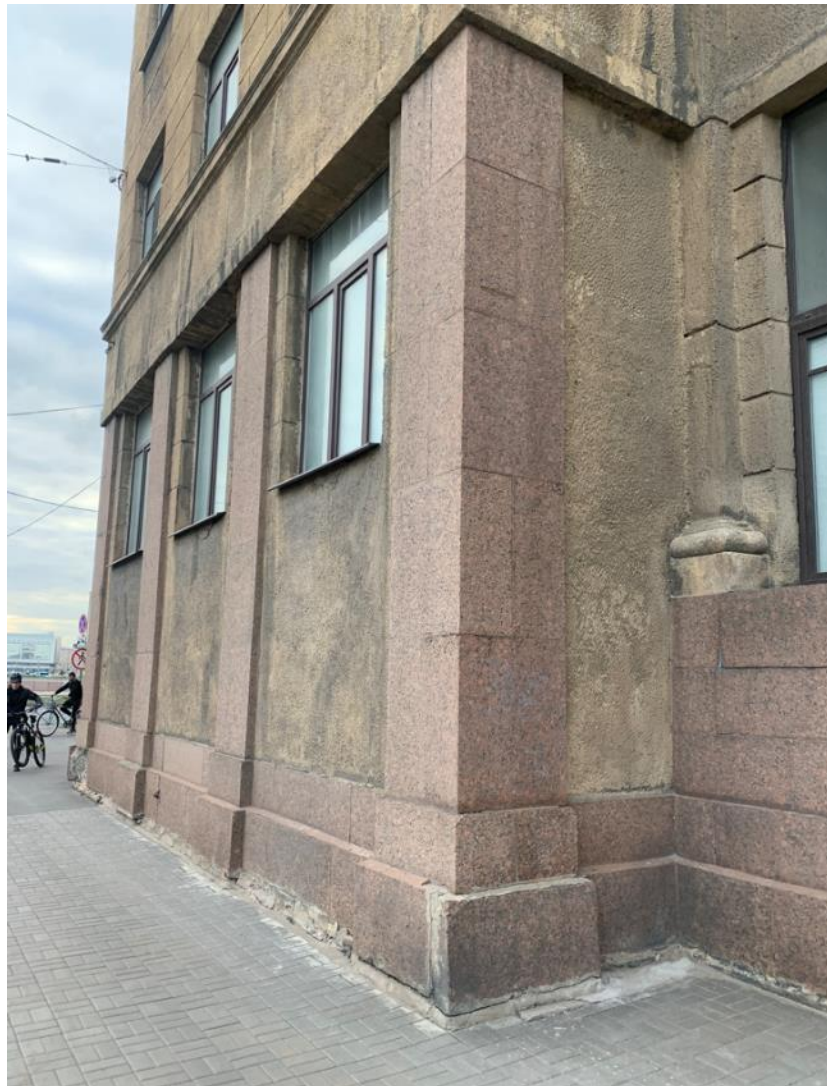
7. Южный фасад. Фрагмент покольной части башенного объема. 03.06.2022
