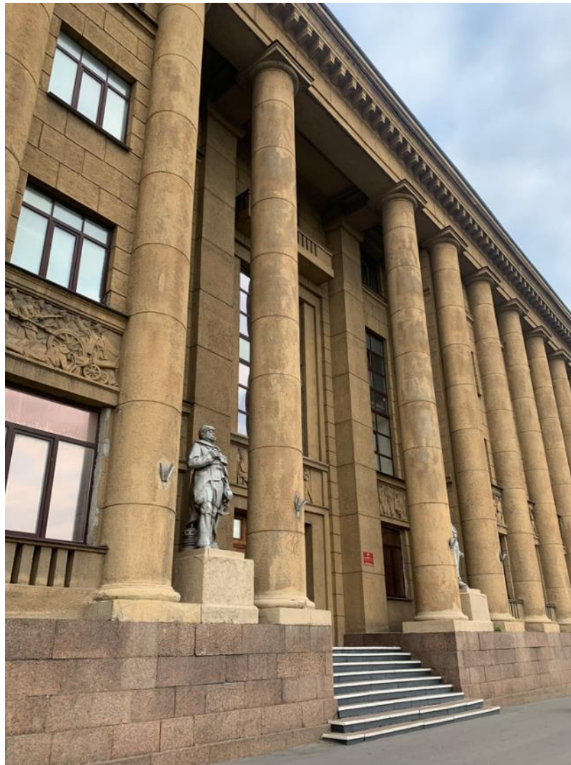
14. Западный фасад. Входная группа, оформленная лоджией с крыльцом. 03.06.2022
