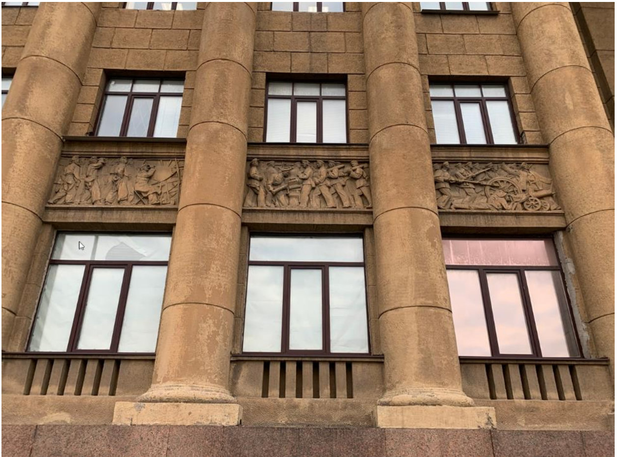
20. Западный фасад. Фрагмент. 03.06.2022
