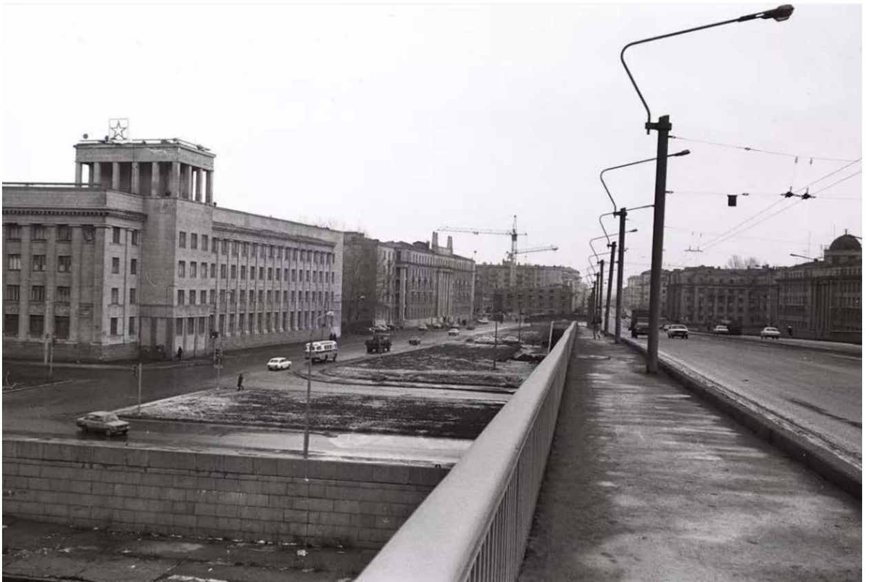
37. В. Валдин. Вид на здание Спецкурсов с моста. Фотография 1987 г. ( https://pastvu.com/p/129796 )
