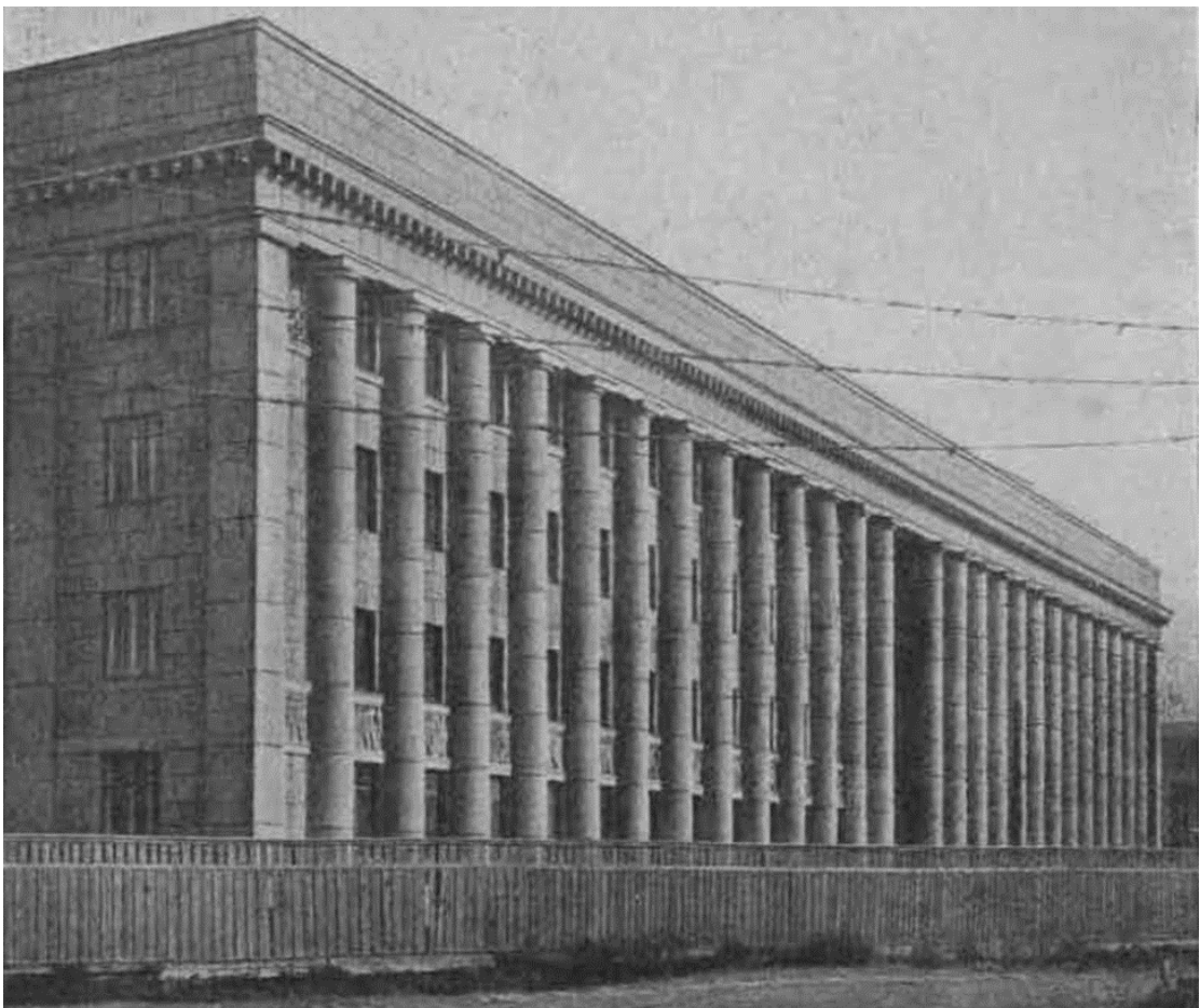
22. Здание СККС. Фотография 1938 г. (Ежегодник Ленинградского отделения Союза советских архитекторов 1934-1939. Л., 1940. С. 50)
