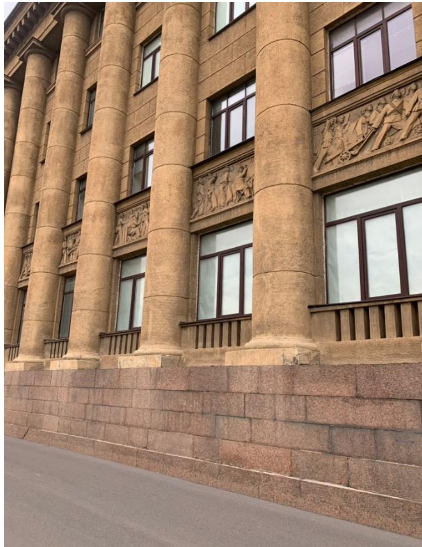
13. Западный фасад. Фрагмент. 03.06.2022
