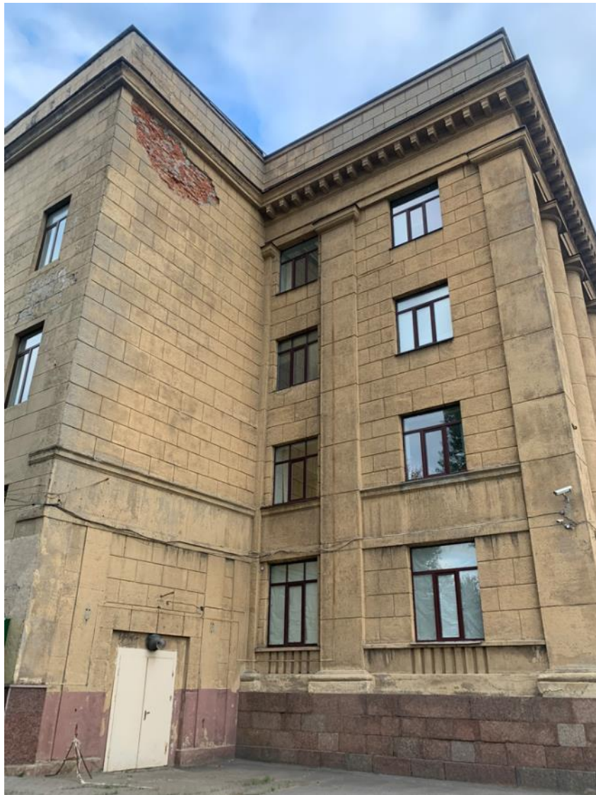
23. Северная угловая часть. 03.06.2022
