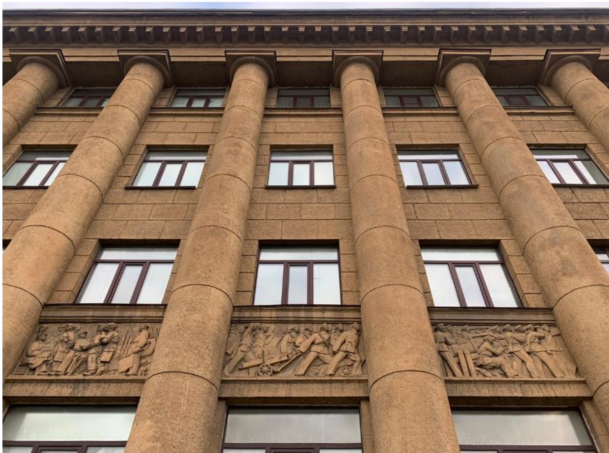
12. Западный фасад. Фрагмент. 03.06.2022
