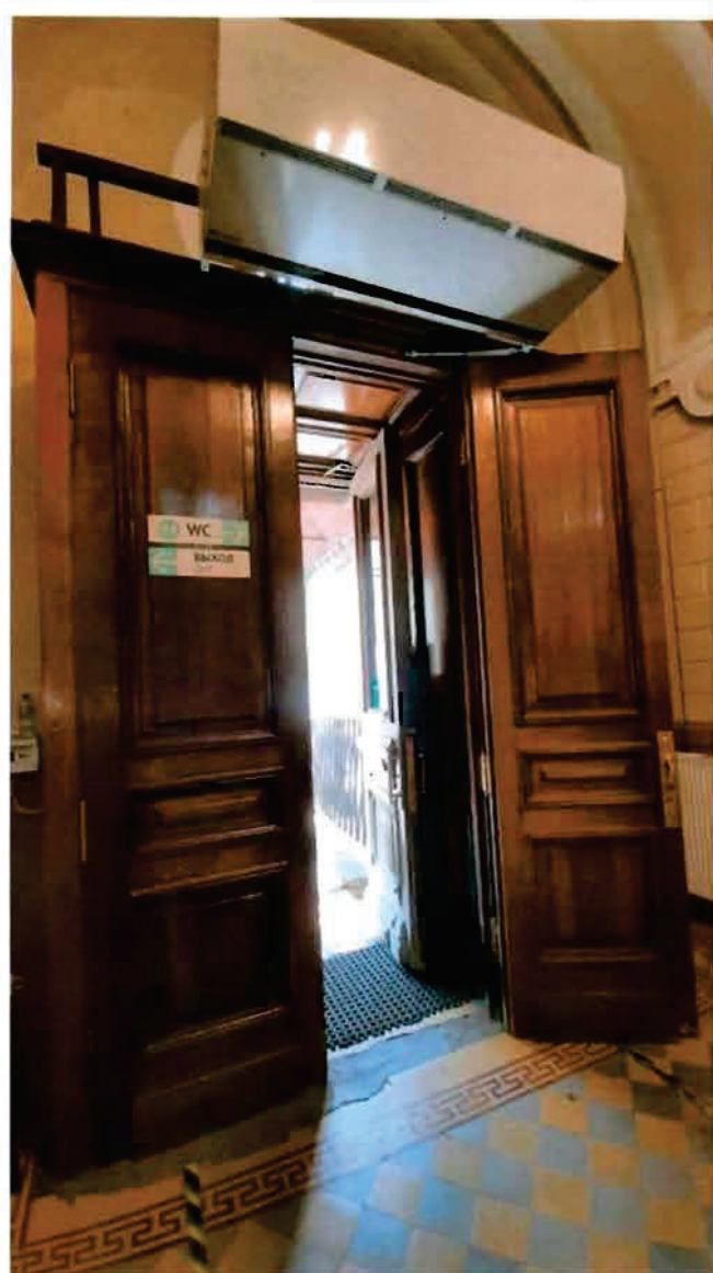
13. Тамбур парадного входа
