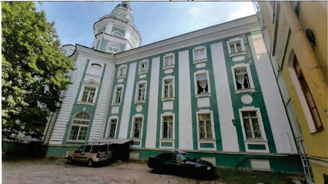
2. Фрагмент дворового фасада корпуса по Университетской набережной
