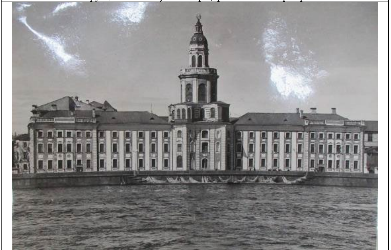
15. Главный фасад здания Кунсткамеры, 1949 г. Архив КГИОП, Паспорт объект культурного наследия «Здание Кунсткамеры».
