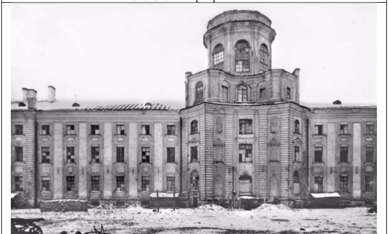
13. Вид на здание Библиотеки и Кунсткамеры со стороны двора, фото 1942-1945 гг. https://pastvu.com/
