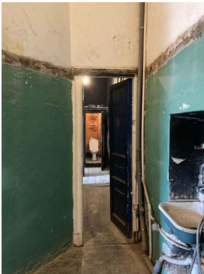
Фото 22. Интерьер квартиры №39 объекта культурного наследия регионального значения «Дом Единоверческой церкви Св. Николая».
