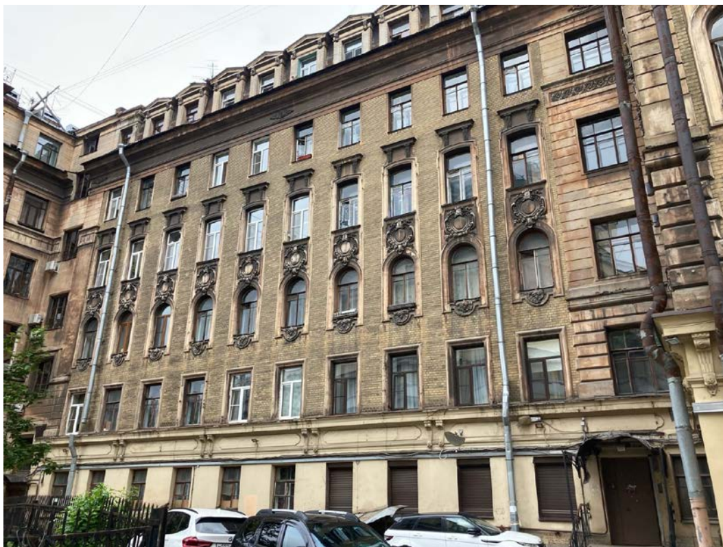
Фото 5. Лицевой фасад объекта культурного наследия регионального значения «Дом Единоверческой церкви Св. Николая».
