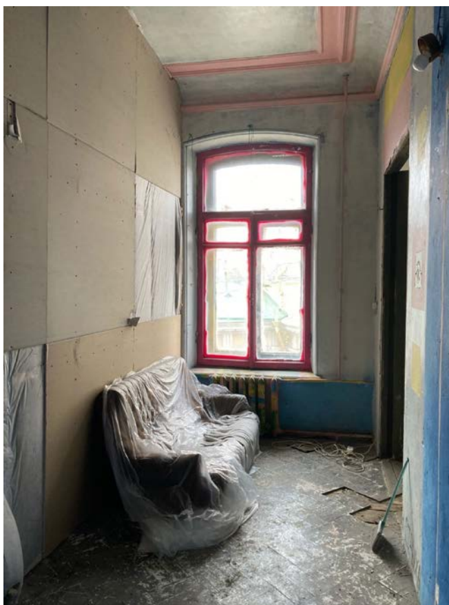
Фото 26. Интерьер квартиры №39 объекта культурного наследия регионального значения «Дом Единоверческой церкви Св. Николая».
