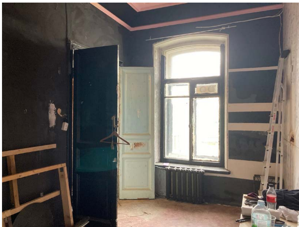
Фото 18. Интерьер квартиры №39 объекта культурного наследия регионального значения «Дом Единоверческой церкви Св. Николая».
