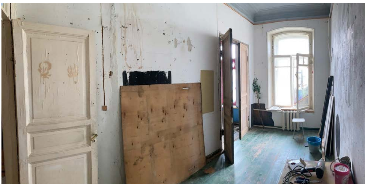
Фото 28. Интерьер квартиры №39 объекта культурного наследия регионального значения «Дом Единоверческой церкви Св. Николая».
