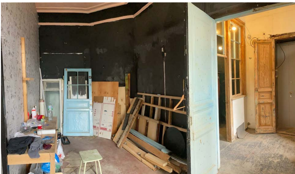
Фото 20. Интерьер квартиры №39 объекта культурного наследия регионального значения «Дом Единоверческой церкви Св. Николая».
