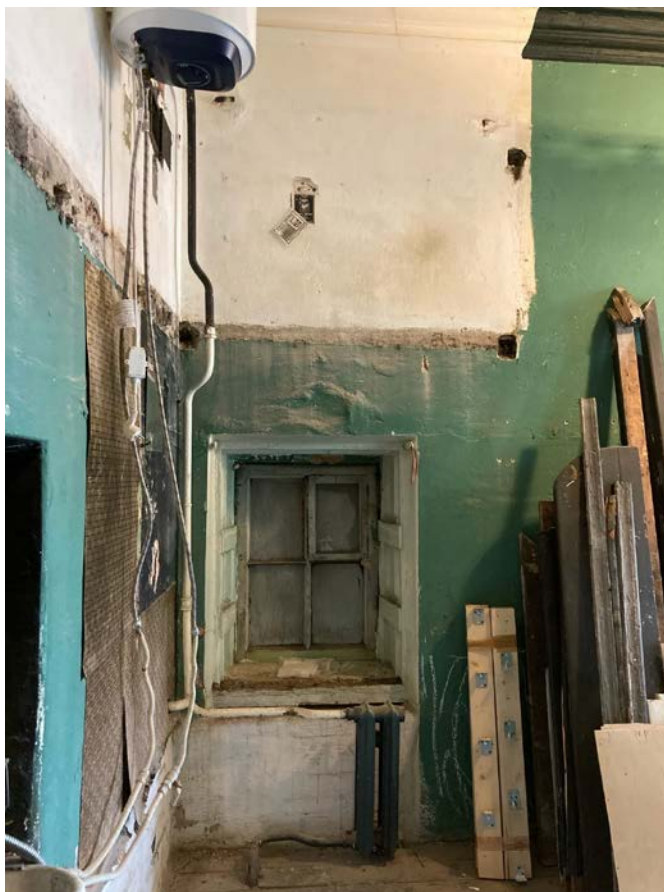
Фото 23. Интерьер квартиры №39 объекта культурного наследия регионального значения «Дом Единоверческой церкви Св. Николая».
