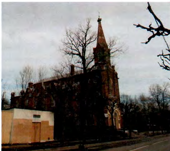
Фото 2. Церковь. Вид с юга.
