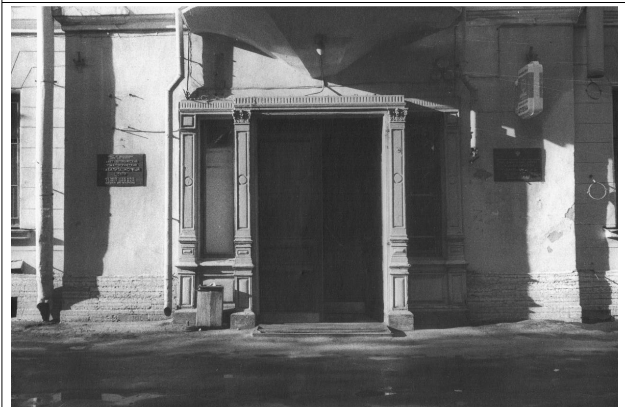
8. Лицевой фасад. Парадный вход. Фото - С.В. Доспехов. 1998 г. https://pastvu.com/
