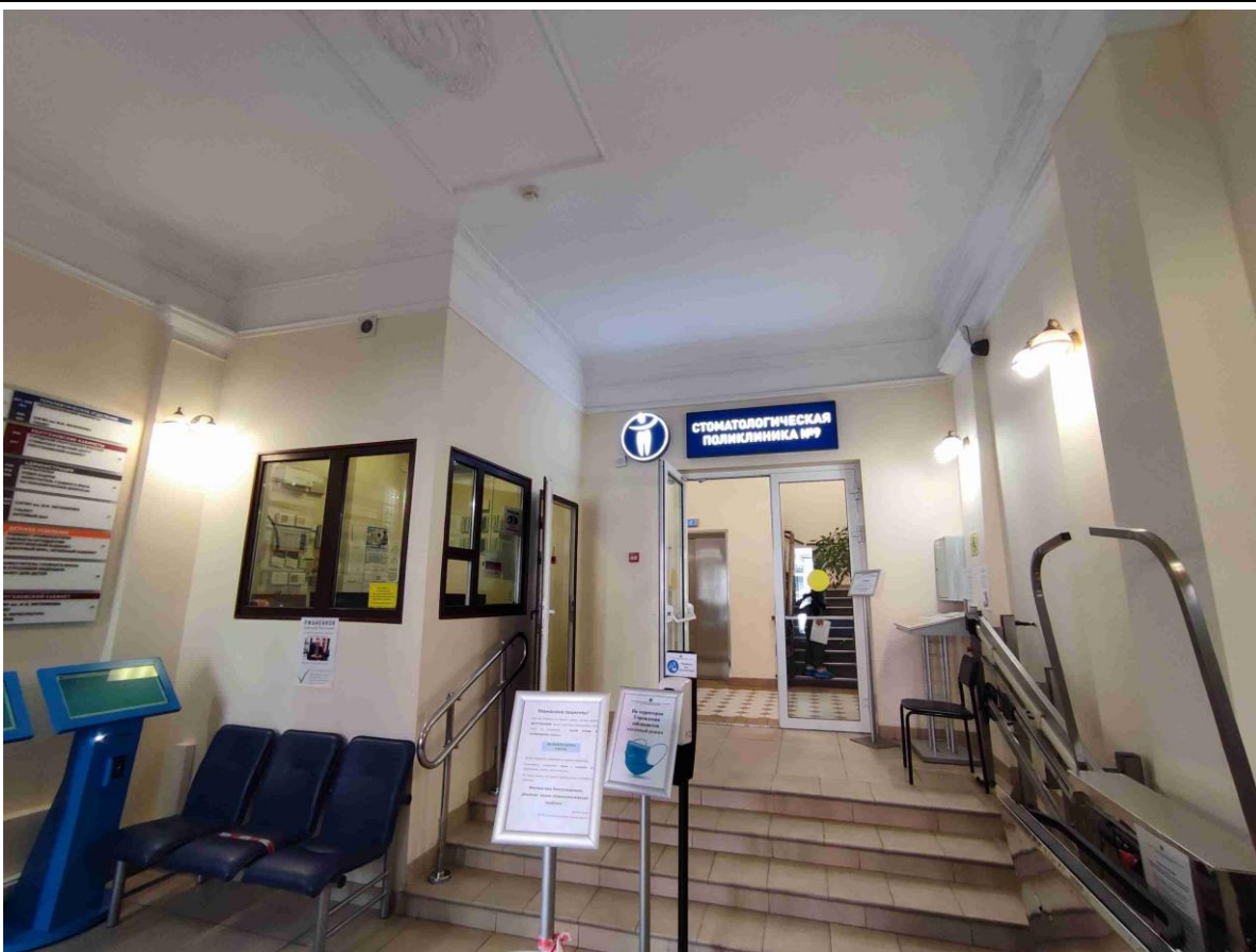
17. Общий вид вестибюля (лестница Л-6) в уровне 1-го этажа.
