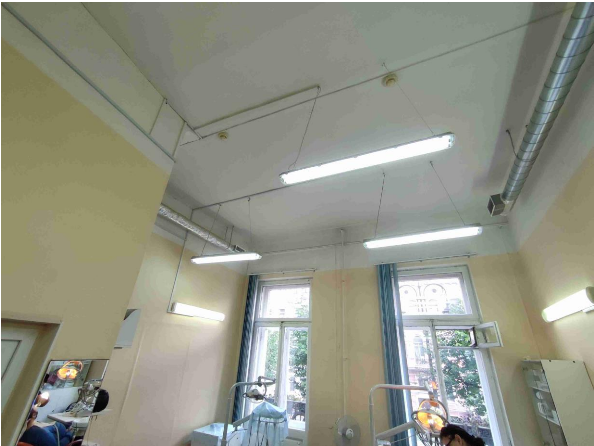
25. Общий вид пом. 9-Н (13) в уровне 2-го этажа.
