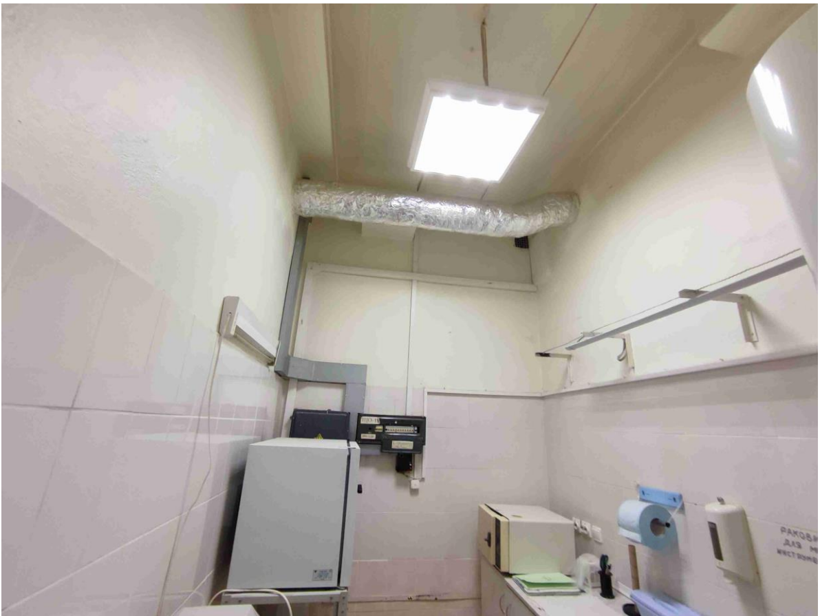
37. Общий вид пом. 14-Н (6, 9) в уровне 4-го этажа.
