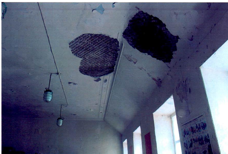
Фото №9. Помещение 1-го этажа.
