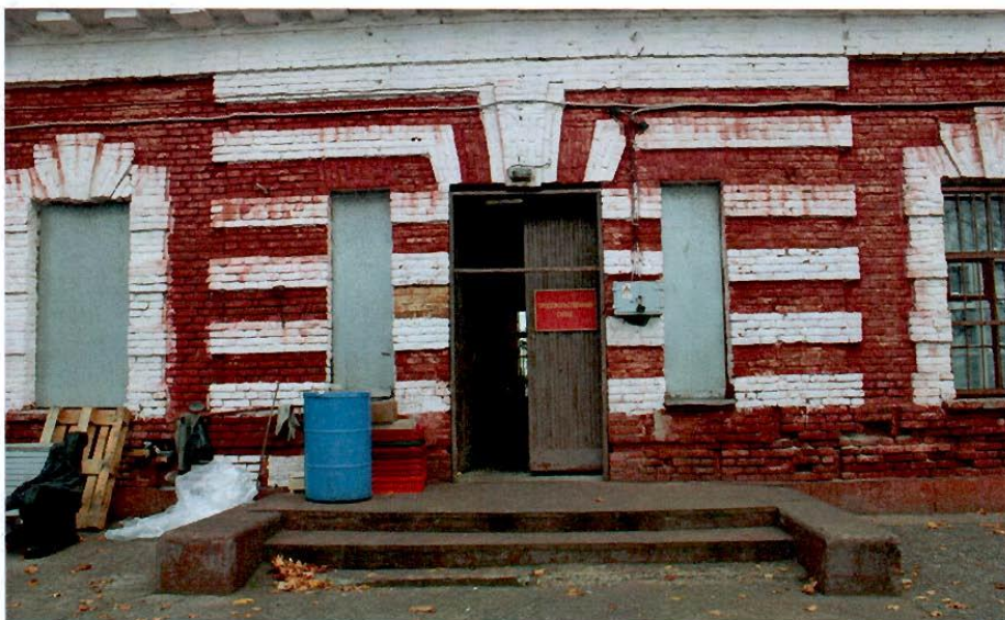
Фото №8. Входная группа парадного (южного) фасада.
