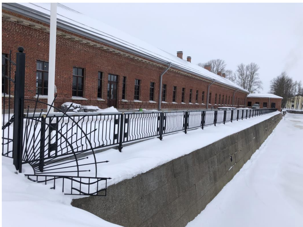
2. Объект культурного наследия регионального значения «б. Голландская кухня», расположенного по адресу: г. Санкт-Петербург, Кронштадтский район, г. Кронштадт, ул. Макаровская, д. 2а, литера А. Вид вдоль северного фасада.
