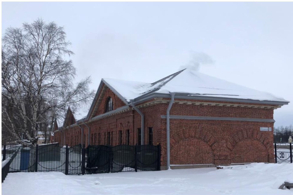
16. Объект культурного наследия регионального значения «б. Голландская кухня», расположенного по адресу: г. Санкт-Петербург, Кронштадтский район, г. Кронштадт, ул. Макаровская, д. 2а, литера А. Общий вид на главный (южный) и торцевой (восточный) фасады.
