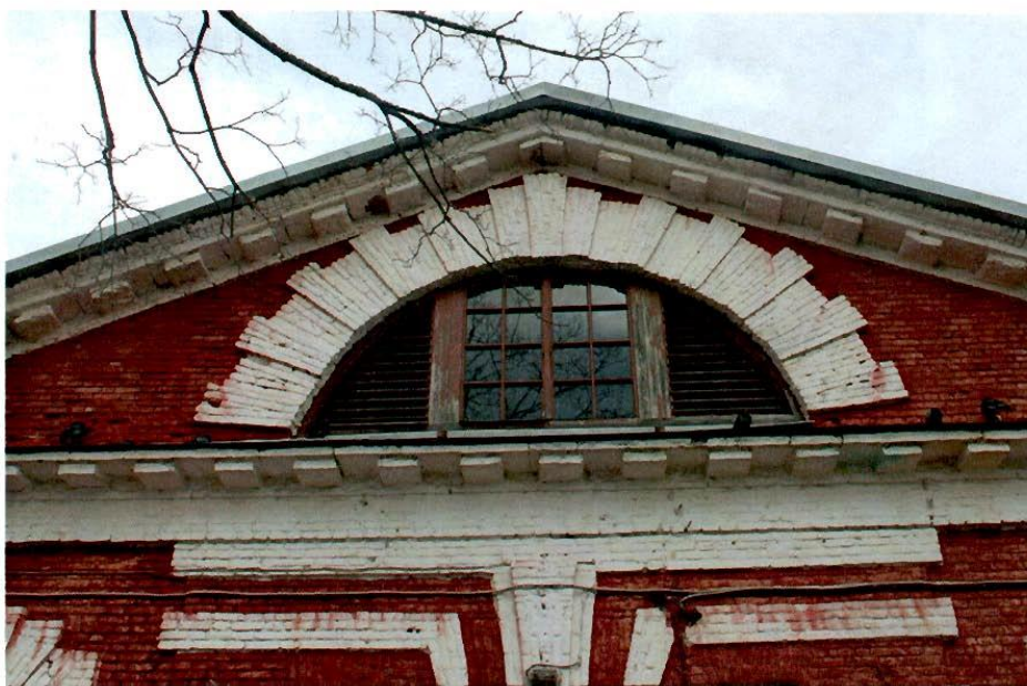
Фото №5. Фронтон парадного (южного) фасада.
