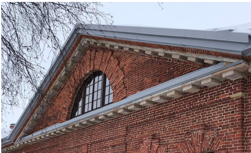
8. Объект культурного наследия регионального значения «б. Голландская кухня», расположенного по адресу: г. Санкт-Петербург, Кронштадтский район, г. Кронштадт, ул. Макаровская, д. 2а, литера А. Фрагмент главного (южного) фасада. Оформление оконного проема в тимпане фронтона ризалита.
