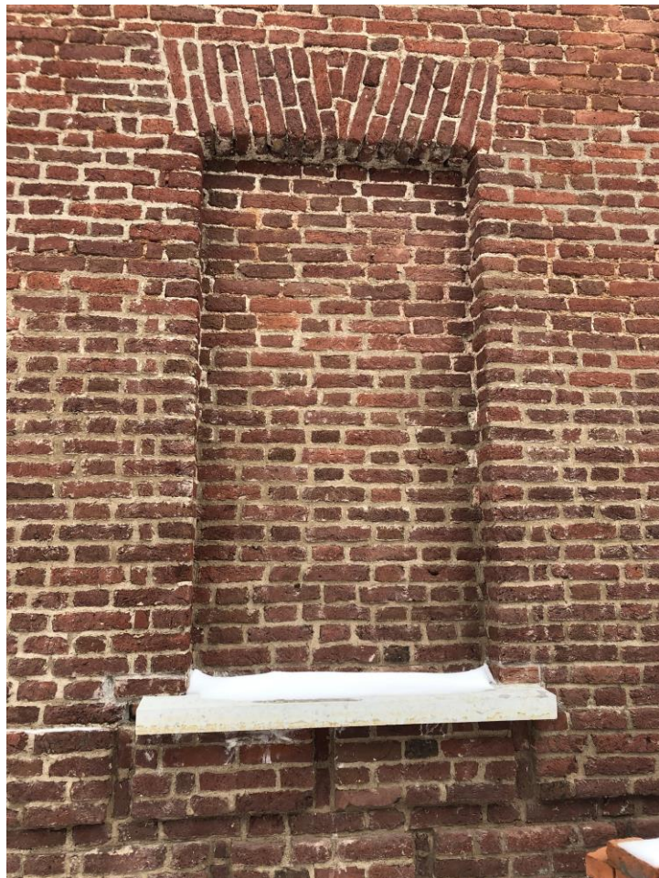
14. Объект культурного наследия регионального значения «б. Голландская кухня», расположенного по адресу: г. Санкт-Петербург, Кронштадтский район, г. Кронштадт, ул. Макаровская, д. 2а, литера А. Фрагмент торцевого западного фасада. Ниша, имитирующая заложенный оконный проем (центральная ось).
