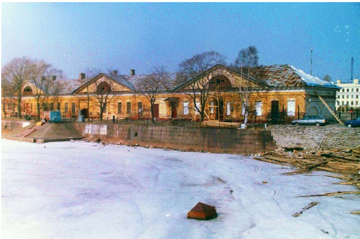
28. Здание «б. Голландской кухни». Г. Кронштадт, Итальянского пруда наб. Вид на главный (южный) фасад. 1990-е гг. Фотография.
