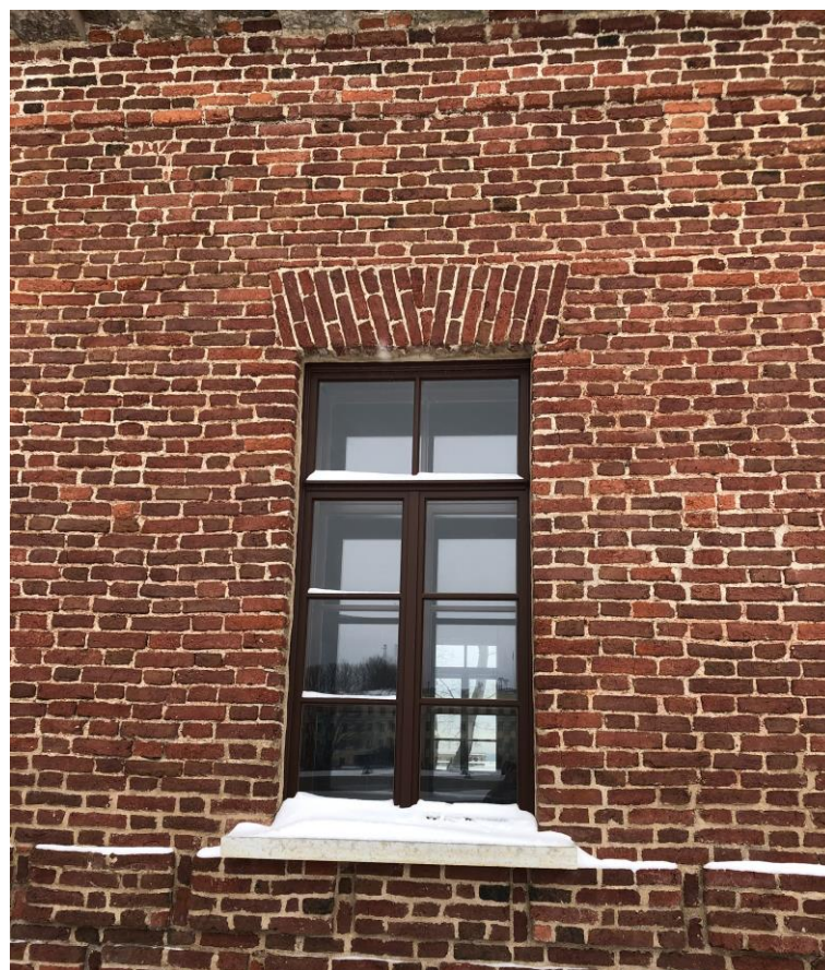
4. Объект культурного наследия регионального значения «б. Голландская кухня», расположенного по адресу: г. Санкт-Петербург, Кронштадтский район, г. Кронштадт, ул. Макаровская, д. 2а, литера А. Фрагмент северного фасада. Оконный проем.
