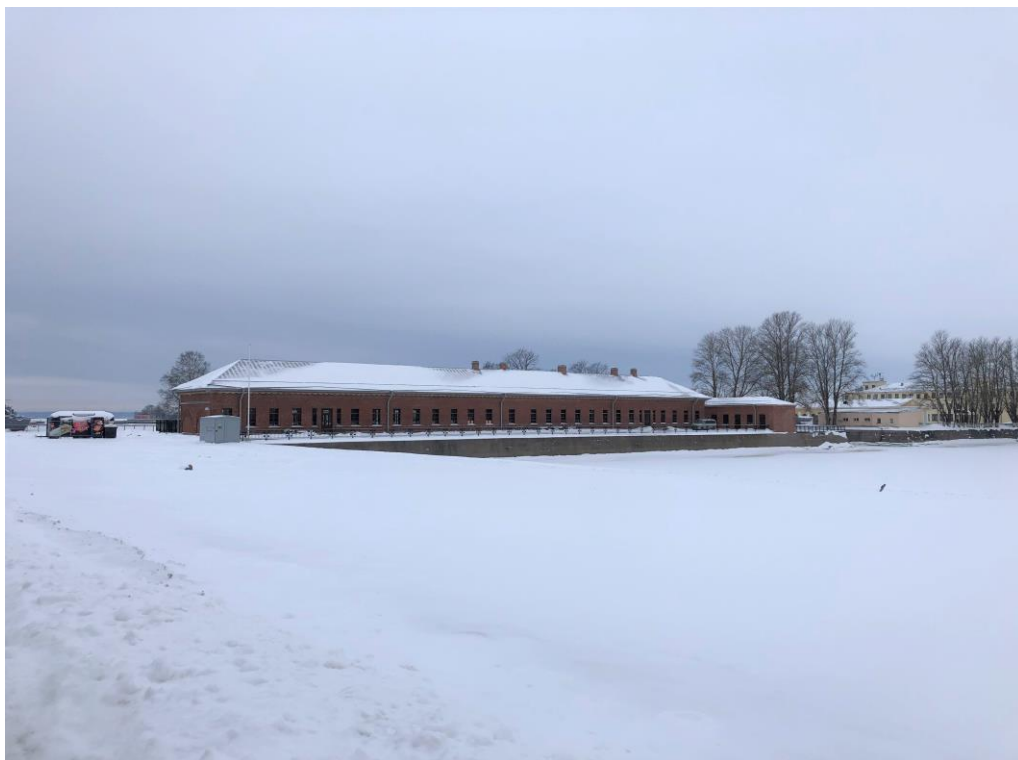
1. Объект культурного наследия регионального значения «б. Голландская кухня», расположенного по адресу: г. Санкт-Петербург, Кронштадтский район, г. Кронштадт, ул. Макаровская, д. 2а, литера А. Северный фасад. Общий вид.
