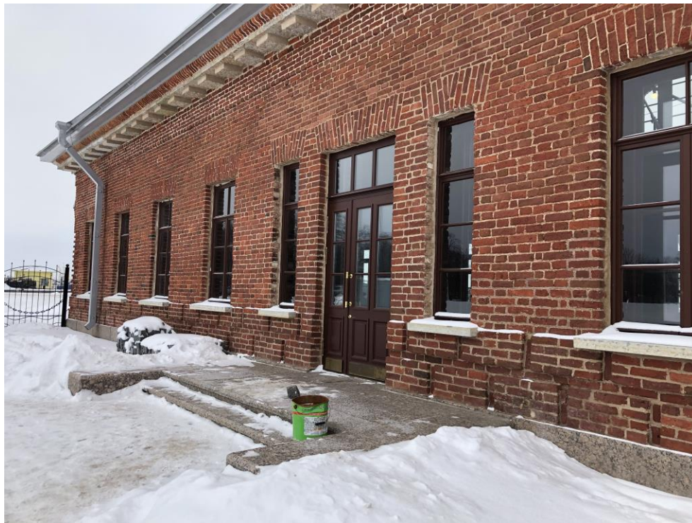
3. Объект культурного наследия регионального значения «б. Голландская кухня», расположенного по адресу: г. Санкт-Петербург, Кронштадтский район, г. Кронштадт, ул. Макаровская, д. 2а, литера А. Фрагмент северного фасада. Вид вдоль северного фасада в восточном направлении.
