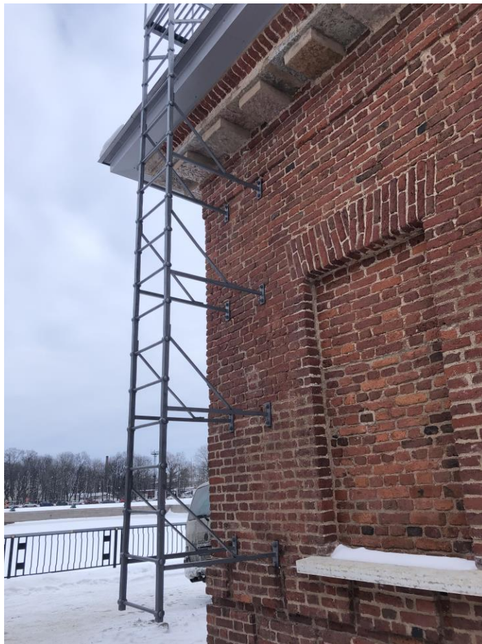
13. Объект культурного наследия регионального значения «б. Голландская кухня», расположенного по адресу: г. Санкт-Петербург, Кронштадтский район, г. Кронштадт, ул. Макаровская, д. 2а, литера А. Фрагмент торцевого западного фасада.
