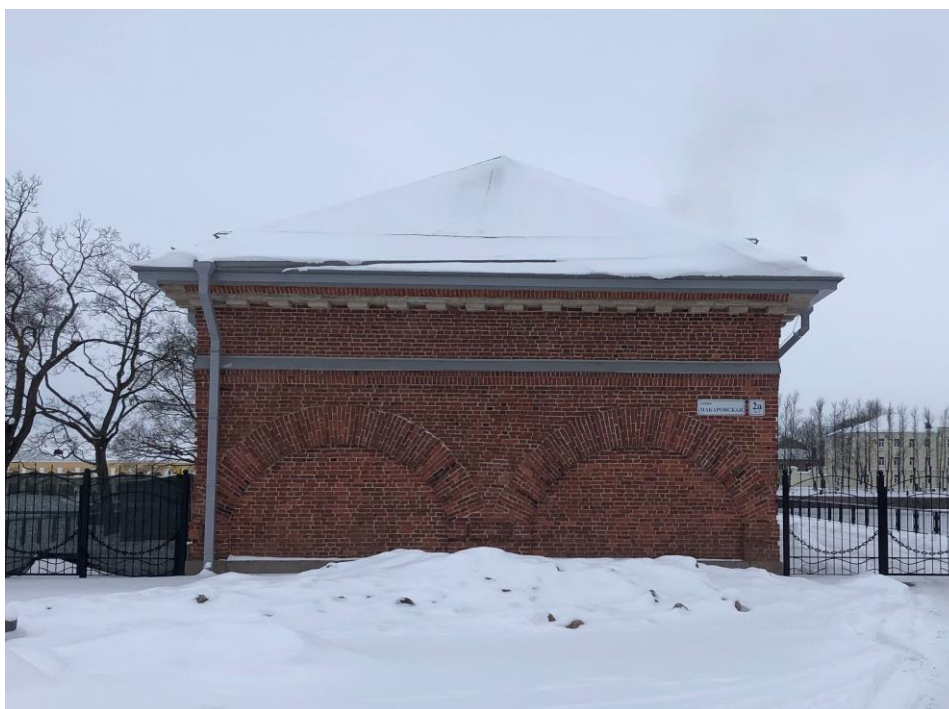
17. Объект культурного наследия регионального значения «б. Голландская кухня», расположенного по адресу: г. Санкт-Петербург, Кронштадтский район, г. Кронштадт, ул. Макаровская, д. 2а, литера А. Общий вид на торцевой восточный фасад.
