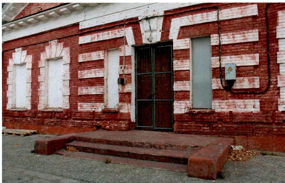
Фото №7. Входная группа парадного (южного) фасада.
