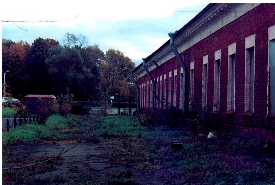
Фото №3. Вид на фрагмент северного фасада и прилегающую территорию.
