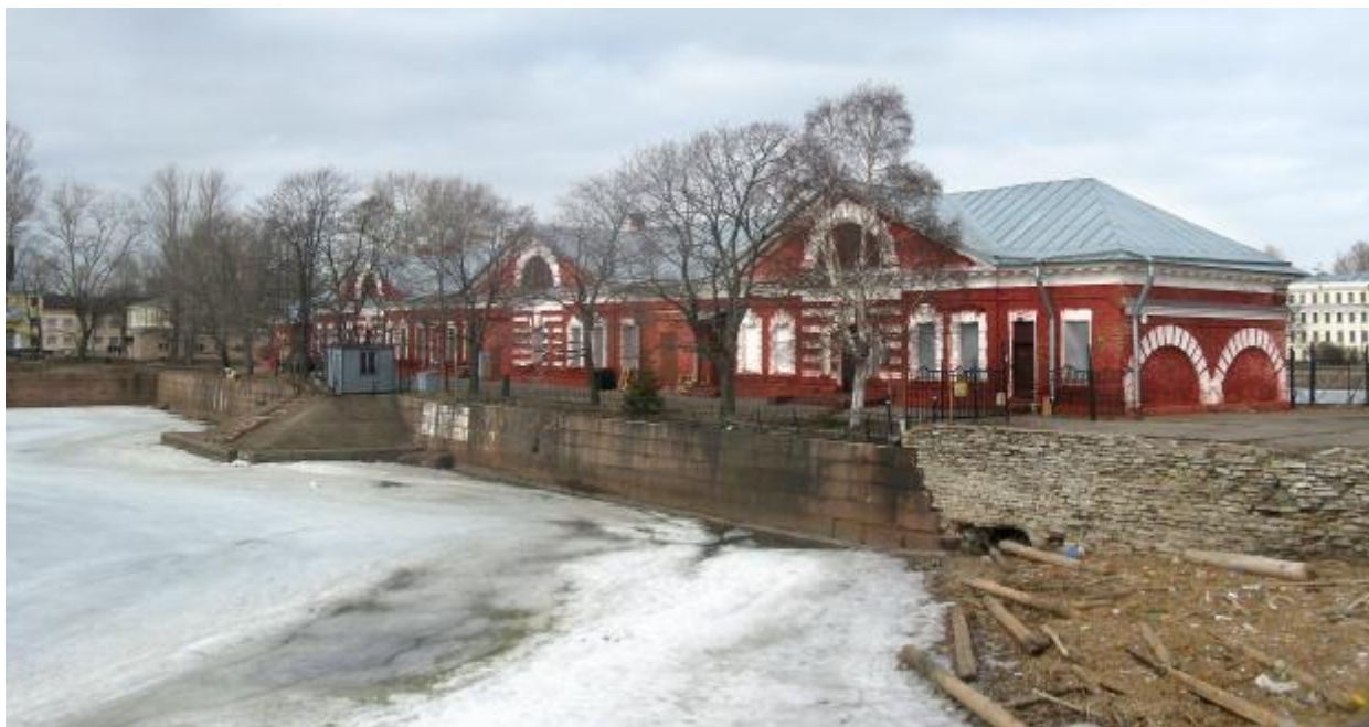
30. Здание «б. Голландской кухни». Г. Кронштадт, Итальянского пруда наб. Вид на главный (южный) фасад. 2000-е гг. Фотография.
