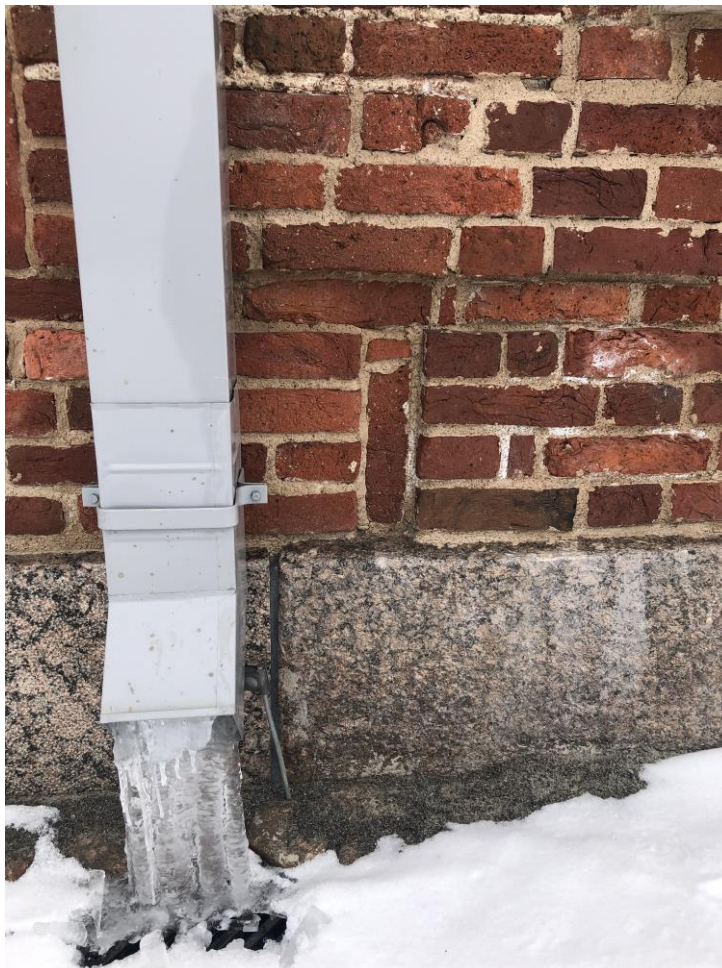
12. Объект культурного наследия регионального значения «б. Голландская кухня», расположенного по адресу: г. Санкт-Петербург, Кронштадтский район, г. Кронштадт, ул. Макаровская, д. 2а, литера А. Южный фасад. Фрагмент. Цоколь.
