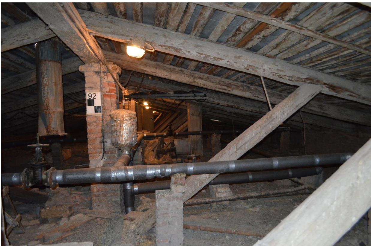
Фото 14. Выявленный ОКН «Здание Государственного Заемного банка (с оградой)». Общий вид чердачного помещения в осях «11-12//И/12-К/12». Съёмка 26.04.2021 г.
