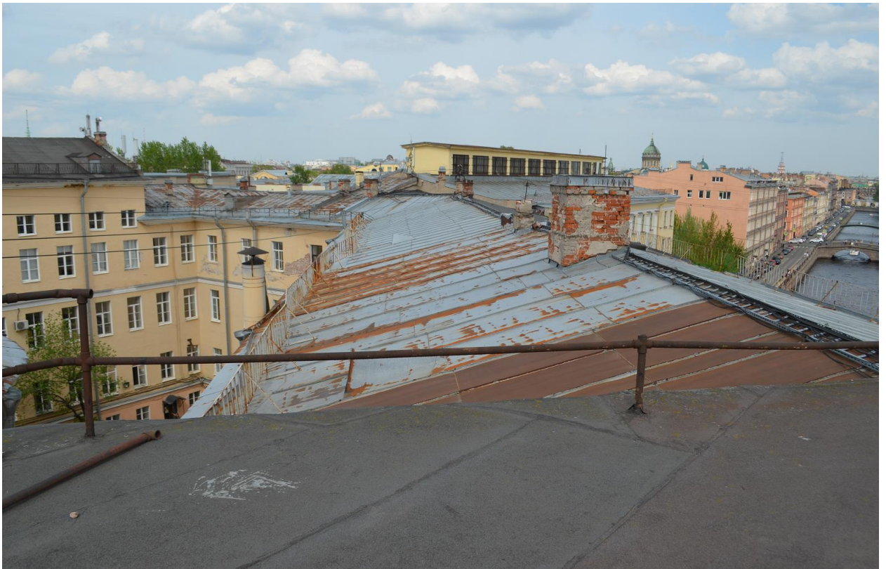
Фото 34. Выявленный ОКН «Здание Государственного Заемного банка (с оградой)». Общий вид крыши. Съёмка 26.04.2021 г.
