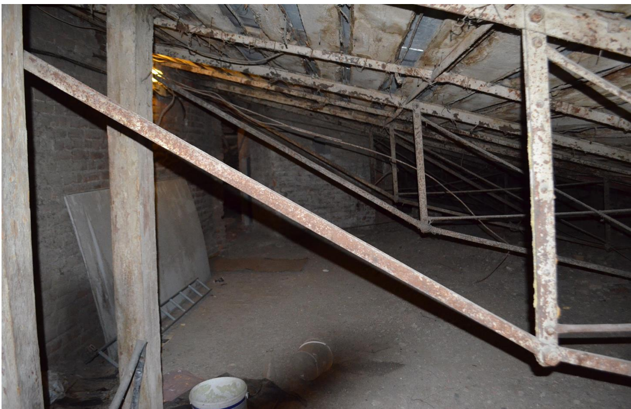
Фото 01. Выявленный ОКН «Здание Государственного Заемного банка (с оградой)». Общий вид стропильных конструкции крыши в осях «10-11//А-Б». Съёмка 26.04.2021 г.
