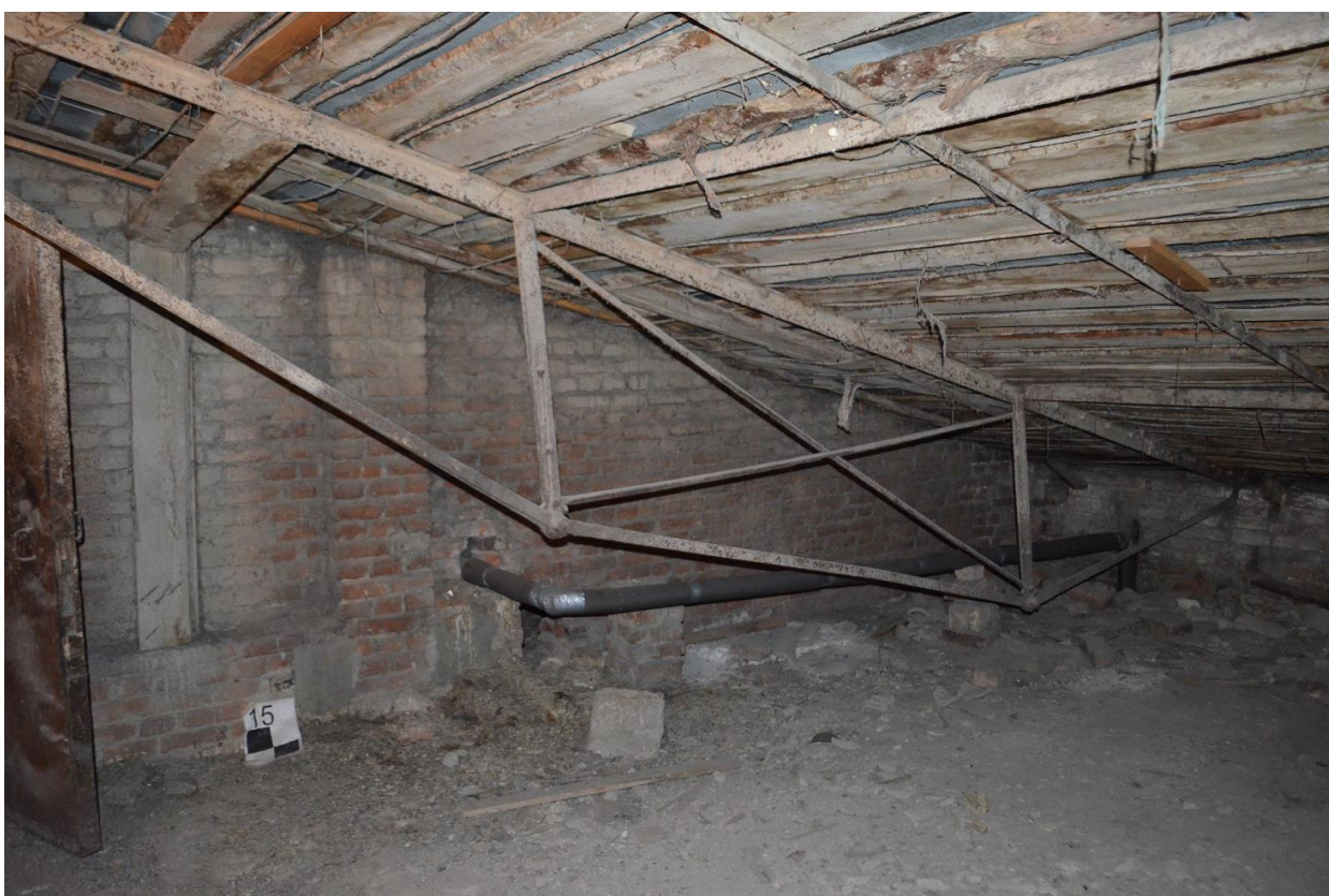
Фото 09. Выявленный ОКН «Здание Государственного Заемного банка (с оградой)». Общий вид стропильных конструкции крыши в осях «11-12//Г/12-Д/12». Съёмка 26.04.2021 г.
