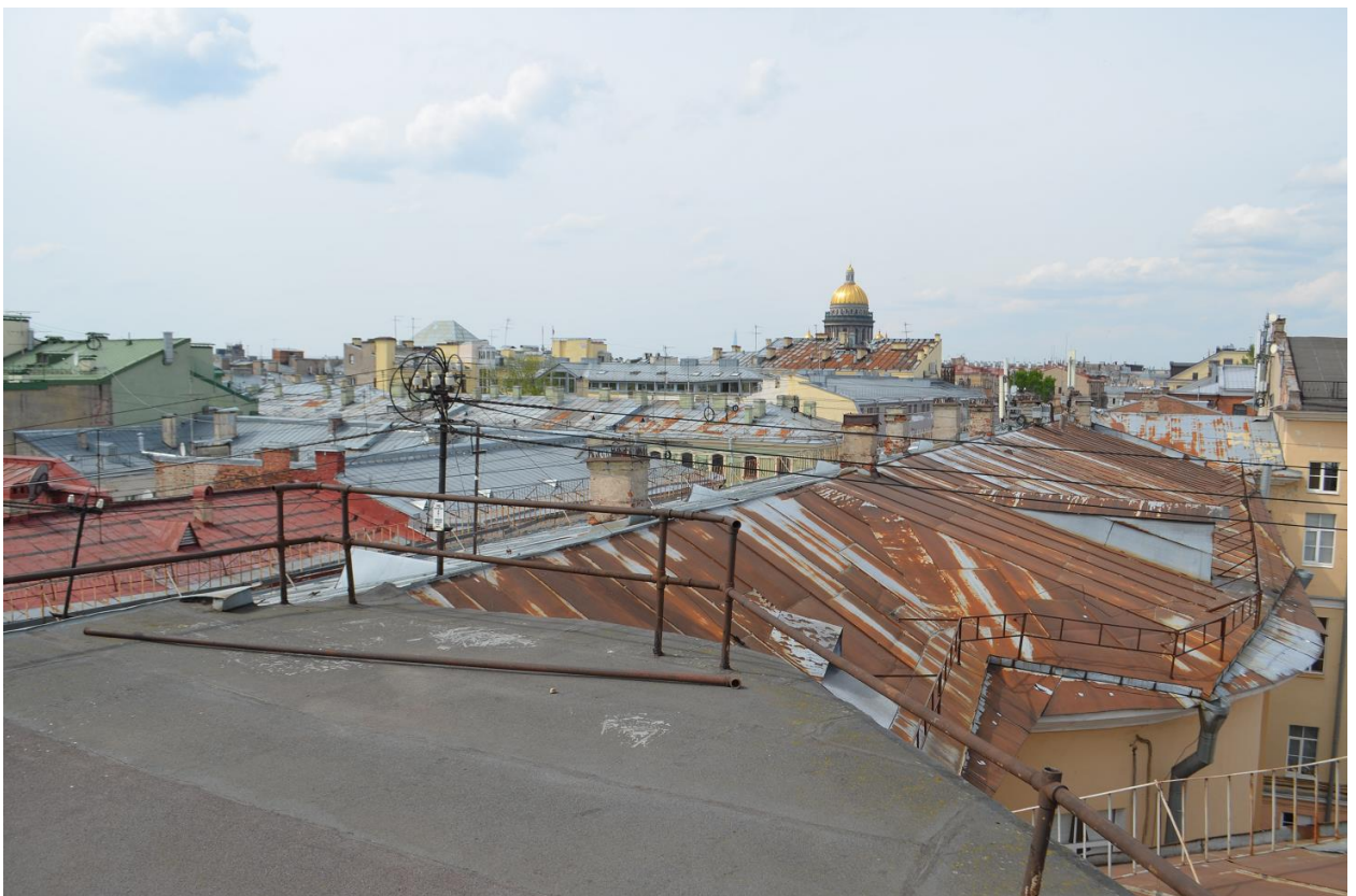
Фото 33. Выявленный ОКН «Здание Государственного Заемного банка (с оградой)». Общий вид крыши. Съёмка 26.04.2021 г.
