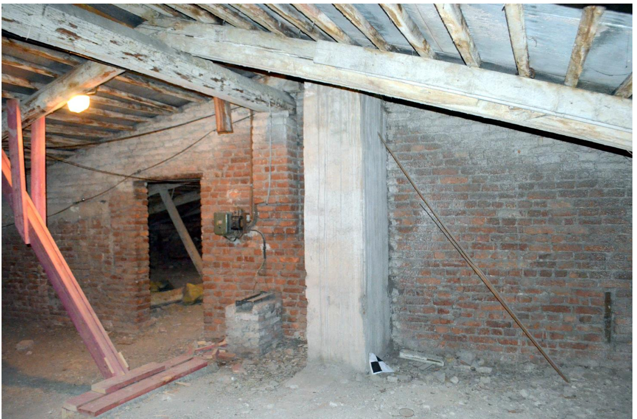
Фото 21. Выявленный ОКН «Здание Государственного Заемного банка (с оградой)». Общий вид стропильной системы крыши в осях «4-5//А-Д». Съёмка 26.04.2021 г.
