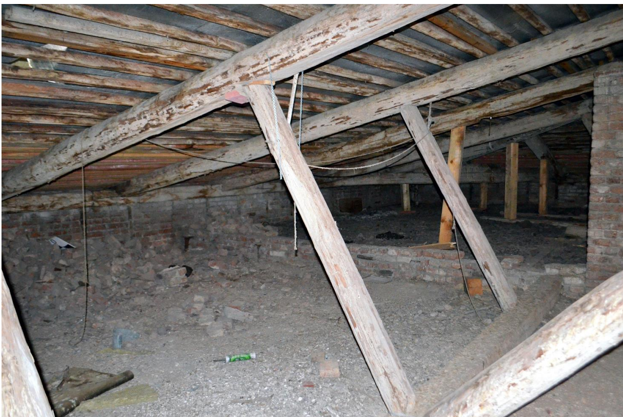
Фото 23. Выявленный ОКН «Здание Государственного Заемного банка (с оградой)». Общий вид стропильной системы крыши в осях «1-4//А-Б». Съёмка 26.04.2021 г.
