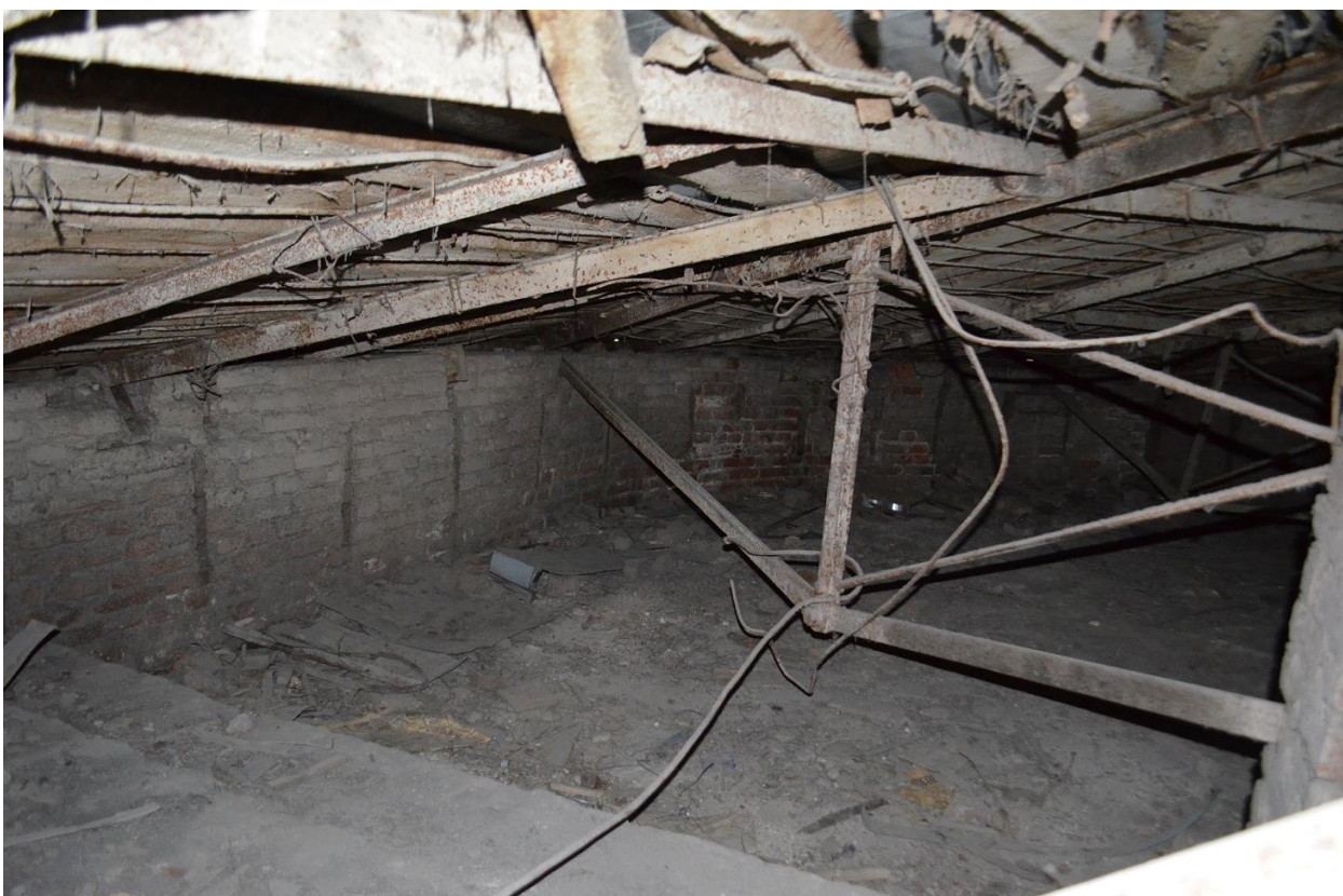
Фото 07. Выявленный ОКН «Здание Государственного Заемного банка (с оградой)». Общий вид стропильных конструкции крыши в осях «11-12//А-Б». Съёмка 26.04.2021 г.
