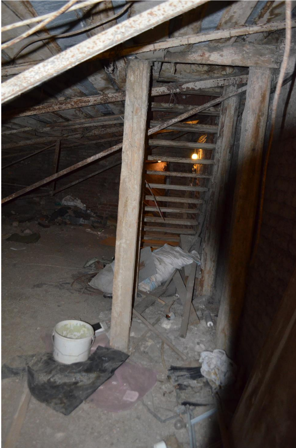
Фото 03. Выявленный ОКН «Здание Государственного Заемного банка (с оградой)». Общий вид стропильных конструкции крыши в осях «10-11//А-Б». Съёмка 26.04.2021 г.
