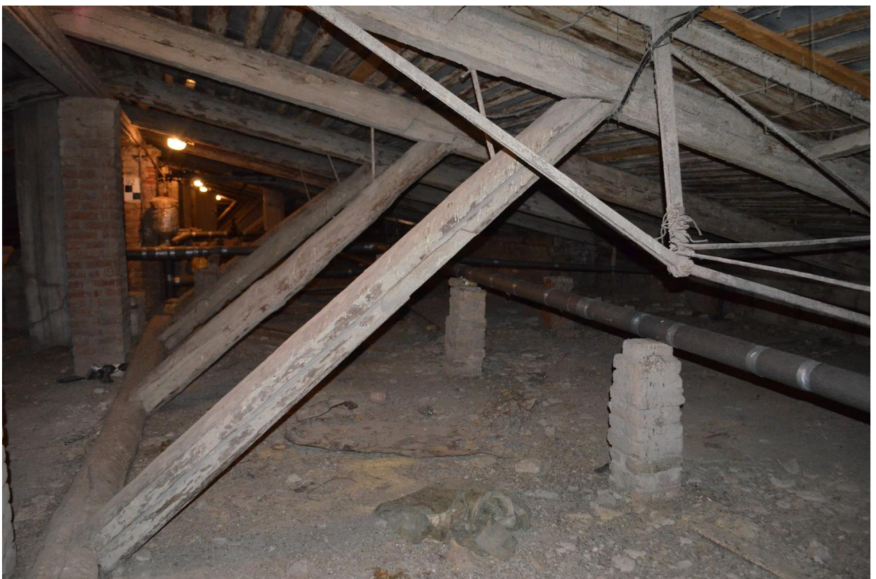
Фото 13. Выявленный ОКН «Здание Государственного Заемного банка (с оградой)». Общий вид чердачного помещения в осях «11-12//И/12-К/12». Съёмка 26.04.2021 г.
