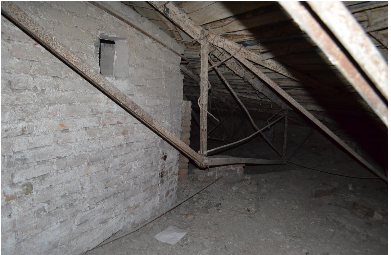
Фото 04. Выявленный ОКН «Здание Государственного Заемного банка (с оградой)». Общий вид стропильных конструкции крыши в осях «10-11//А-Б». Съёмка 26.04.2021 г.
