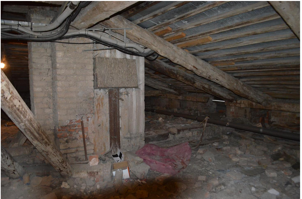
Фото 32. Выявленный ОКН «Здание Государственного Заемного банка (с оградой)». Общий вид стропильной системы крыши в осях «1-4//Ж-Л». Съёмка 26.04.2021 г.
