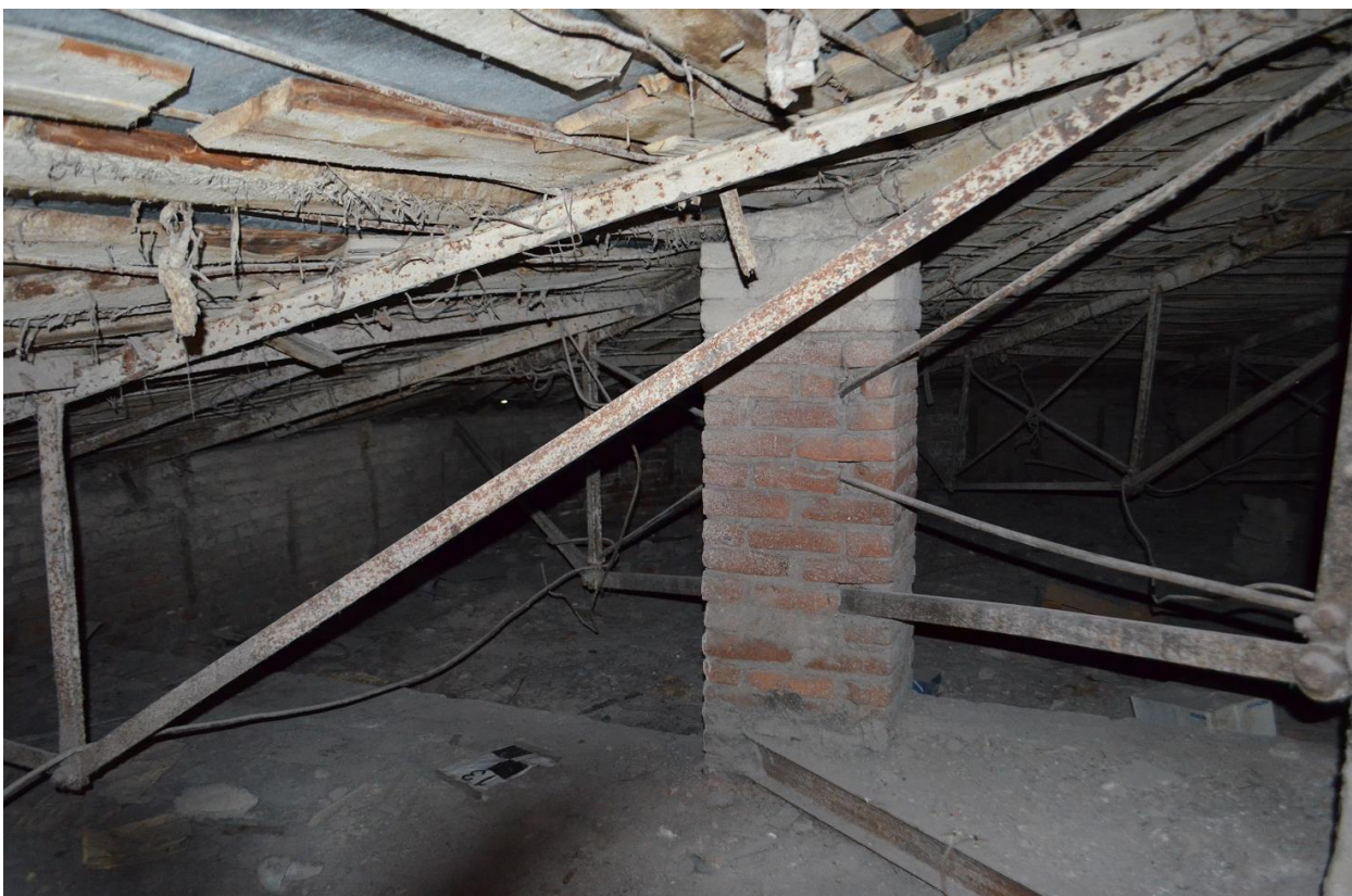
Фото 06. Выявленный ОКН «Здание Государственного Заемного банка (с оградой)». Общий вид стропильных конструкции крыши в осях «11-12//А-Б». Съёмка 26.04.2021 г.
