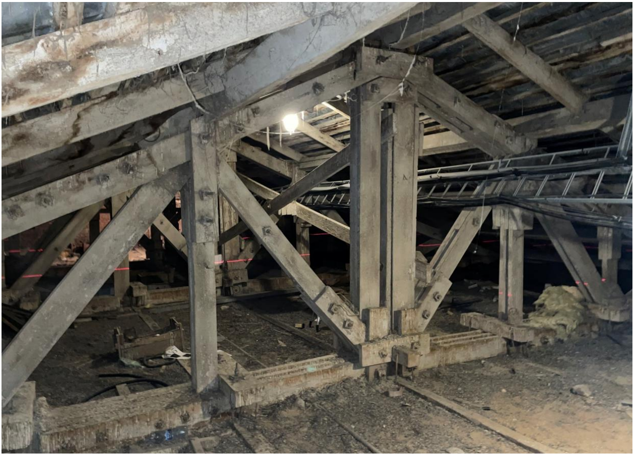
Фото 29. Выявленный ОКН «Здание Государственного Заемного банка (с оградой)». Общий вид стропильной системы крыши в осях «1-3//Е-Ж». Съёмка 26.04.2021 г.
