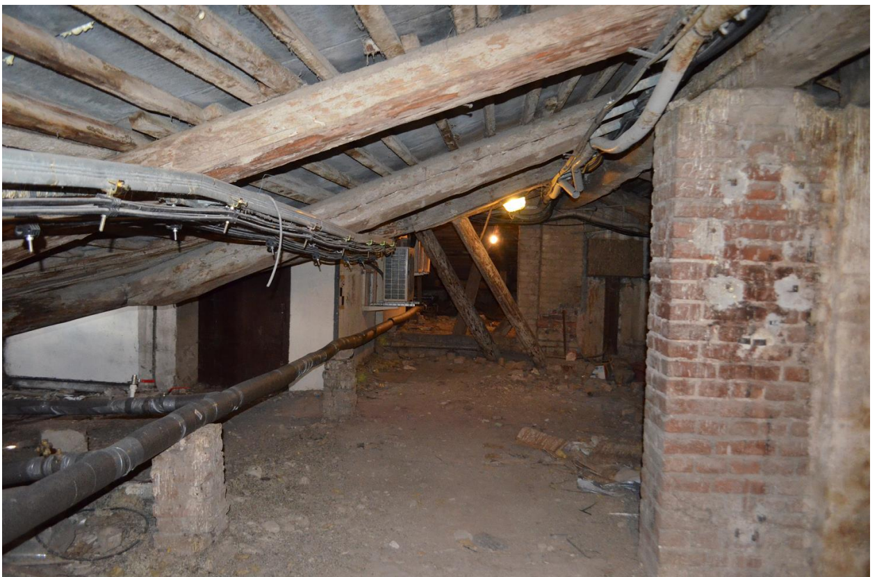
Фото 31. Выявленный ОКН «Здание Государственного Заемного банка (с оградой)». Общий вид стропильной системы крыши в осях «1-4//Ж-Л». Съёмка 26.04.2021 г.
