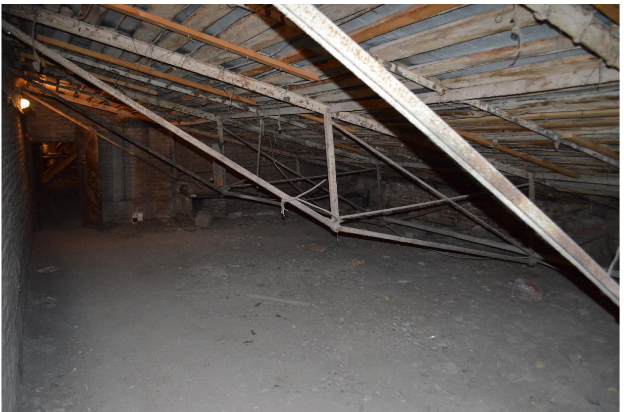
Фото 05. Выявленный ОКН «Здание Государственного Заемного банка (с оградой)». Общий вид стропильных конструкции крыши в осях «11-12//Г/12-Д/12». Съёмка 26.04.2021 г.
