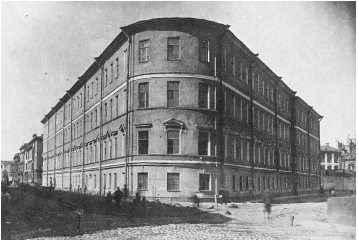
Илл. 17. Здание ЛИТМО на канале Грибоедова. 1932-1934. // ЦГАКФФД СПб. Гр-454714.
