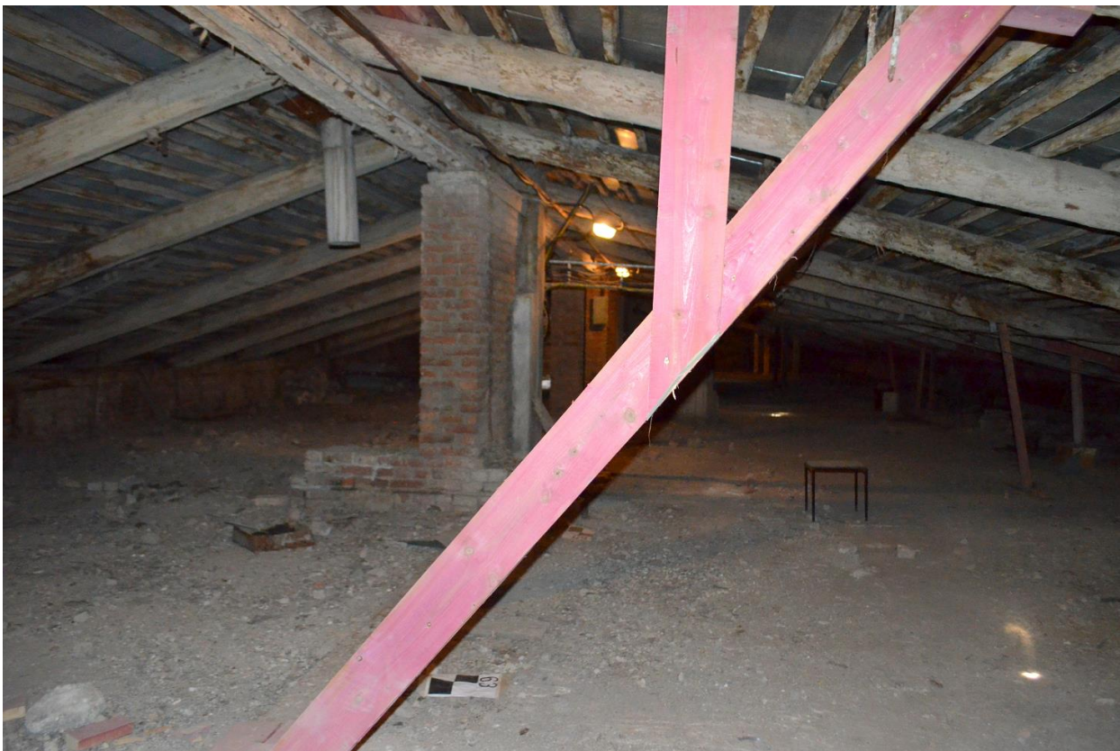
Фото 22. Выявленный ОКН «Здание Государственного Заемного банка (с оградой)». Общий вид стропильной системы крыши в осях «1-3//А-Е». Съёмка 26.04.2021 г.
