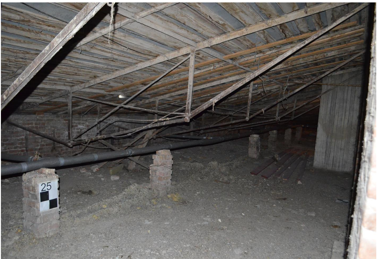
Фото 11. Выявленный ОКН «Здание Государственного Заемного банка (с оградой)». Общий вид чердачного помещения в осях «11-12//Д/12-Е/12». Съёмка 26.04.2021 г.
