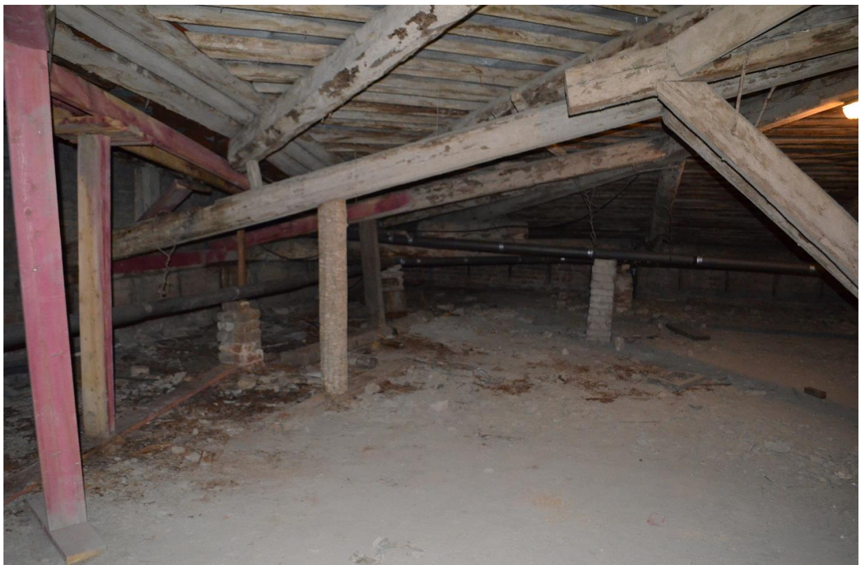
Фото 19. Выявленный ОКН «Здание Государственного Заемного банка (с оградой)». Общий вид чердачного помещения в осях «11-12//К/12-Л/12». Съемка 26.04.2021 г.
