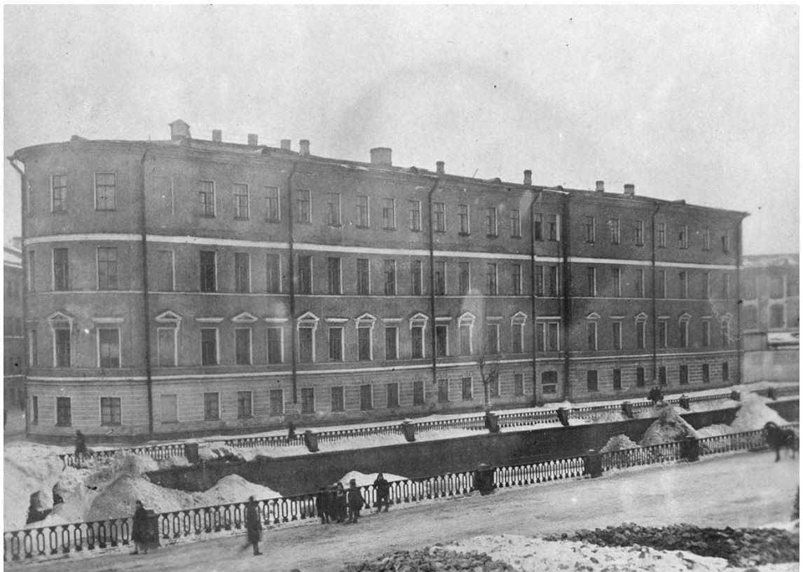
Илл. 18. Здание ЛИТМО на канале Грибоедова. 1932-1934. // ЦГАКФФД СПб. Гр-454745.
