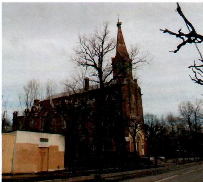
Фото 2. Церковь. Вид с юга.
