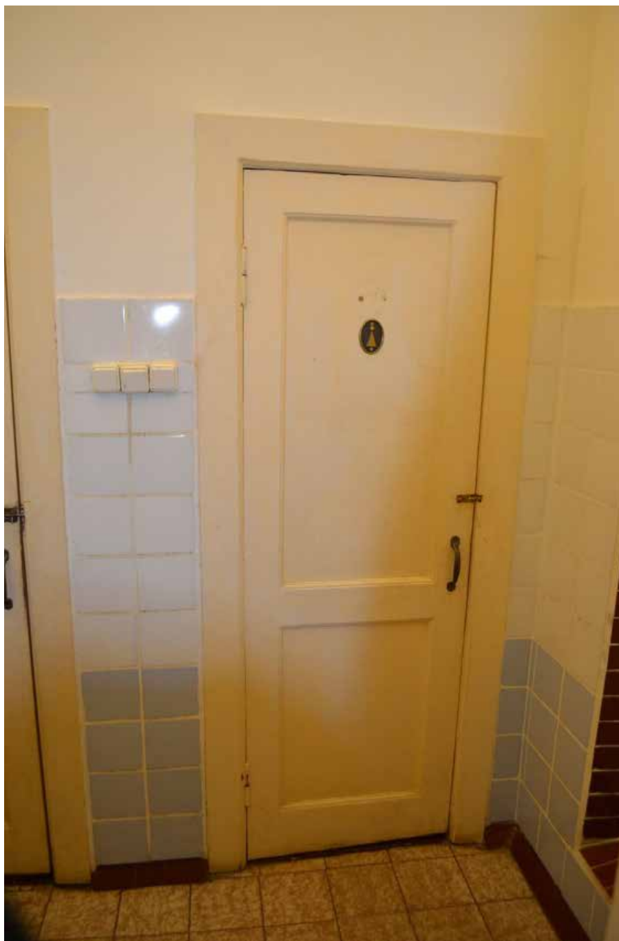
Фото 52. Объект культурного наследия федерального значения «Церковь лютеранская Воскресения Христова». Первый этаж. Помещение 1-Н (10). Фрагмент. Съёмка 31.10.2022
