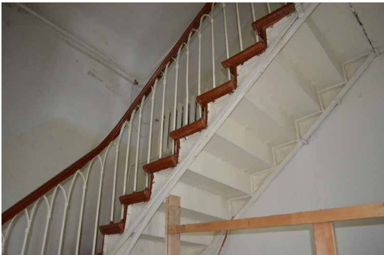
Фото 80. Объект культурного наследия федерального значения «Церковь лютеранская Воскресения Христова». Второй этаж. Помещение 1-Н (15). Лестница, ведущая на хоры. Фрагмент. Съёмка 31.10.2022 г.
