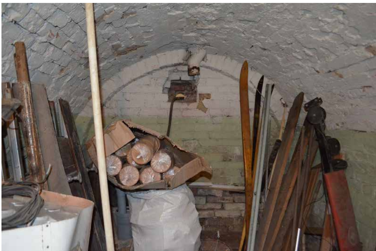
Фото 37. Объект культурного наследия федерального значения «Церковь лютеранская Воскресения Христова». Подвал. Помещение 2-Н (6). Фрагмент. Съёмка 31.10.2022 г.
