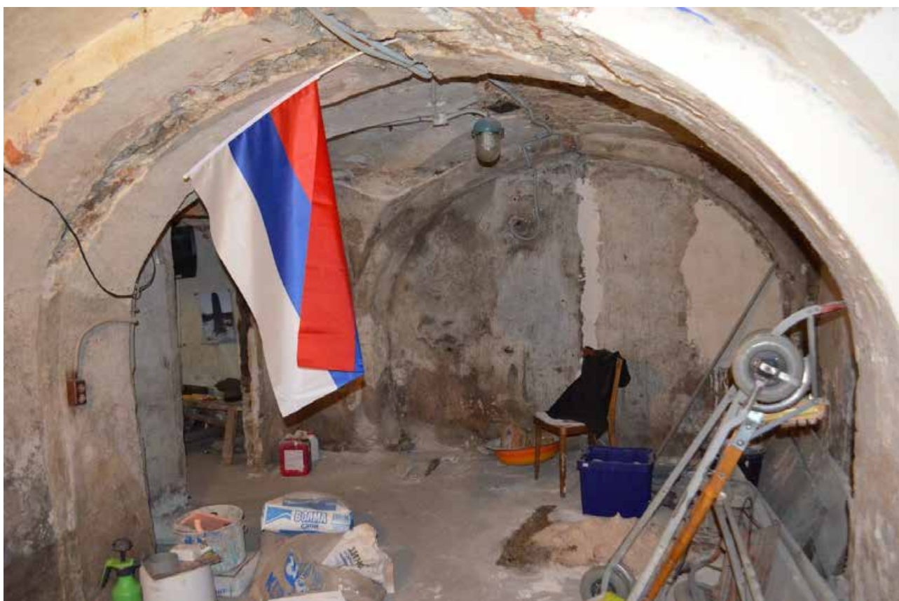
Фото 34. Объект культурного наследия федерального значения «Церковь лютеранская Воскресения Христова». Подвал. Помещение 2-Н (1). Фрагмент. Съёмка 31.10.2022 г.
