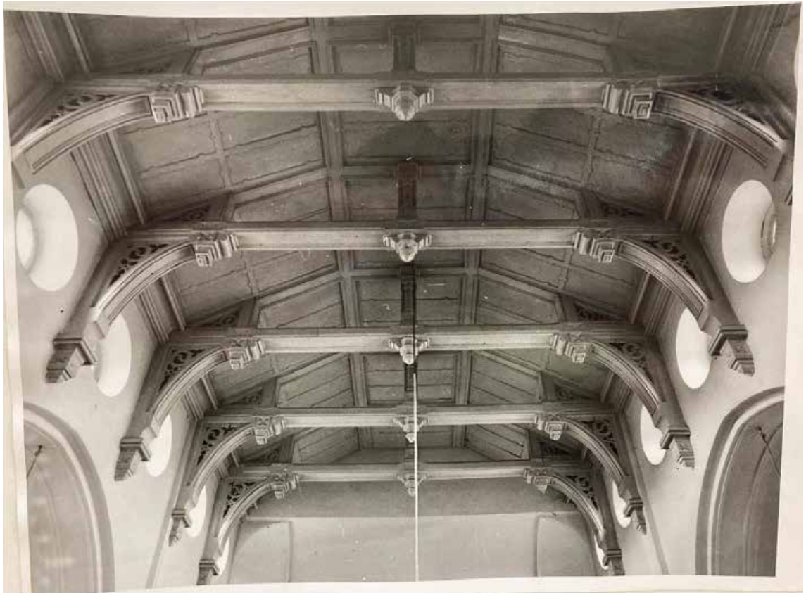
Иллюстрация 85. В. И. Шлакан. Лютеранская церковь 1865 г., арх. А. Ф. Видов. Интерьер. Центральный неф. Фрагмент перекрытия. Фото 1985 г. Архив КГИОП.
