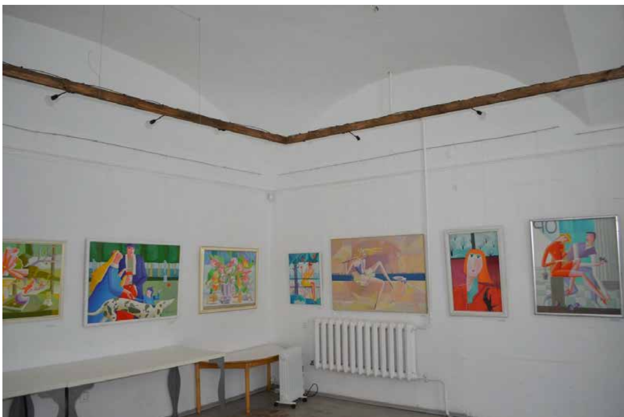
Фото 51. Объект культурного наследия федерального значения «Церковь лютеранская Воскресения Христова». Первый этаж. Помещение 1-Н (9). Фрагмент. Съёмка 31.10.2022 г.
