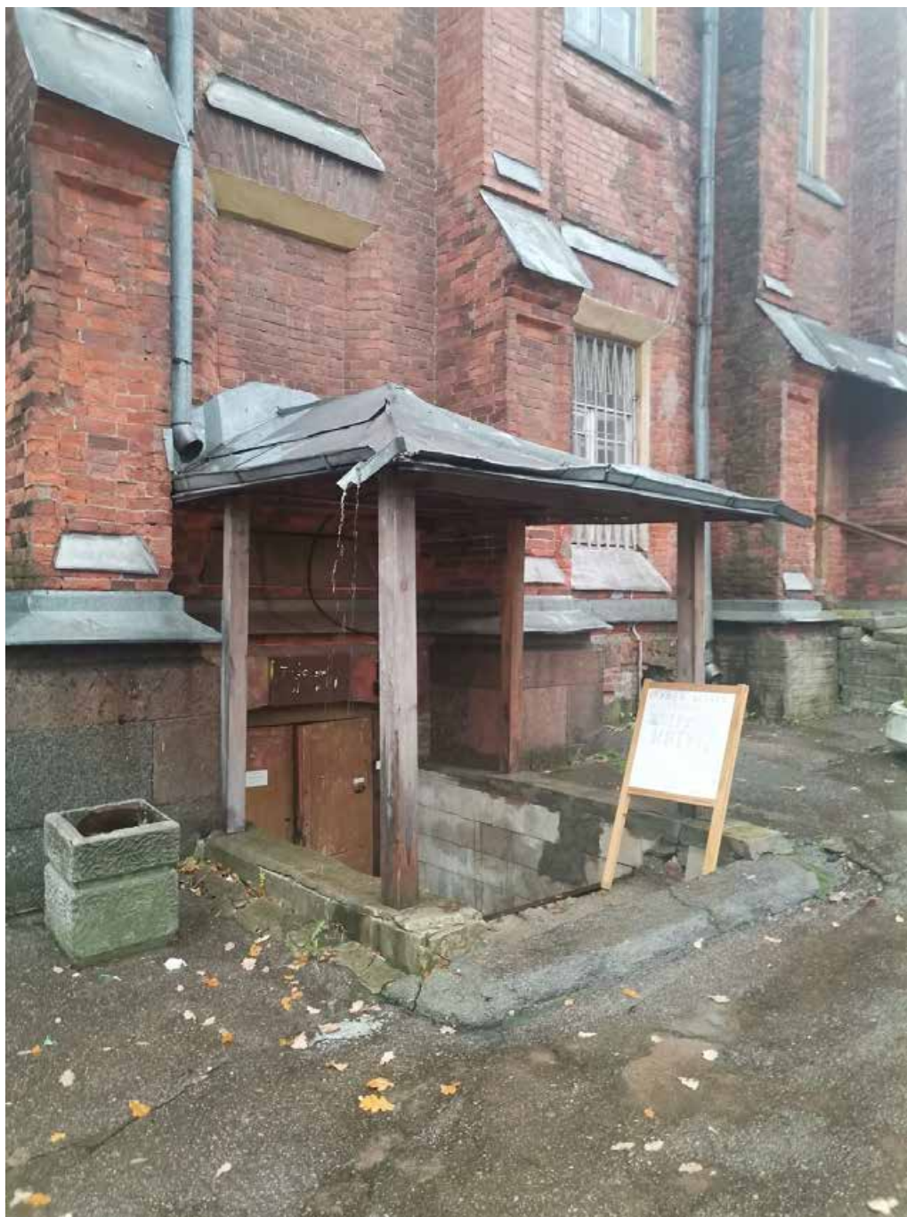
Фото 07. Объект культурного наследия федерального значения «Церковь лютеранская Воскресения Христова». Северо-восточный фасад. Фрагмент. Съёмка 31.10.2022 г.
