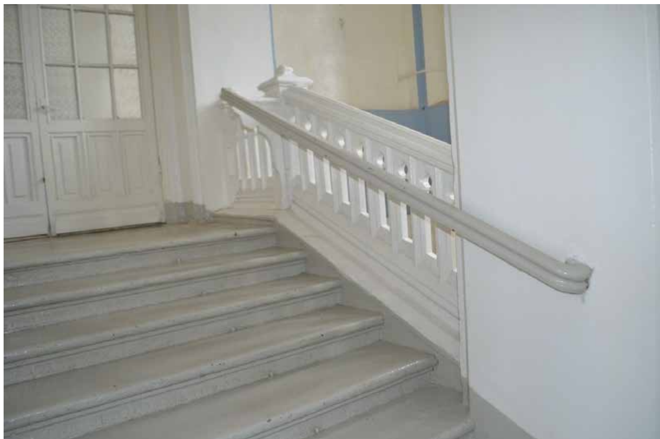
Фото 62. Объект культурного наследия федерального значения «Церковь лютеранская Воскресения Христова». Второй этаж. Помещение 1-Н (18). Лестница. Фрагмент. Съёмка 31.10.2022 г.
