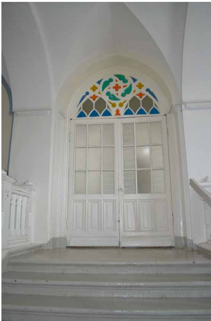
Фото 63. Объект культурного наследия федерального значения «Церковь лютеранская Воскресения Христова». Второй этаж. Помещение 1-Н (18). Лестница. Фрагмент. Съёмка 31.10.2022 г.
