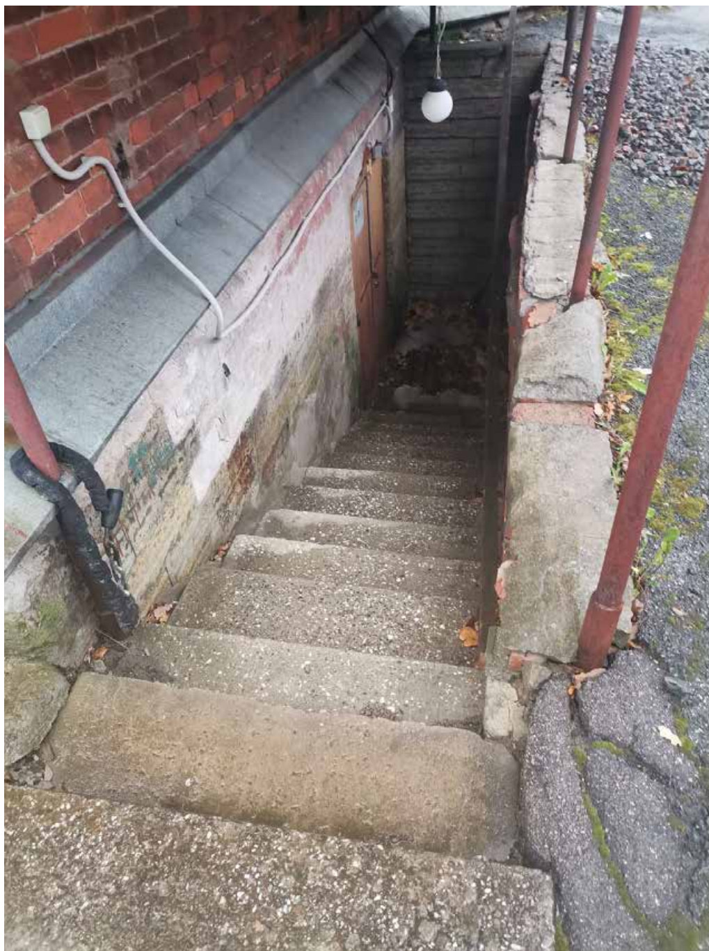
Фото 14. Объект культурного наследия федерального значения «Церковь лютеранская Воскресения Христова». Северо-западный фасад. Прямоок. Фрагмент. Съёмка 31.10.2022 г.
