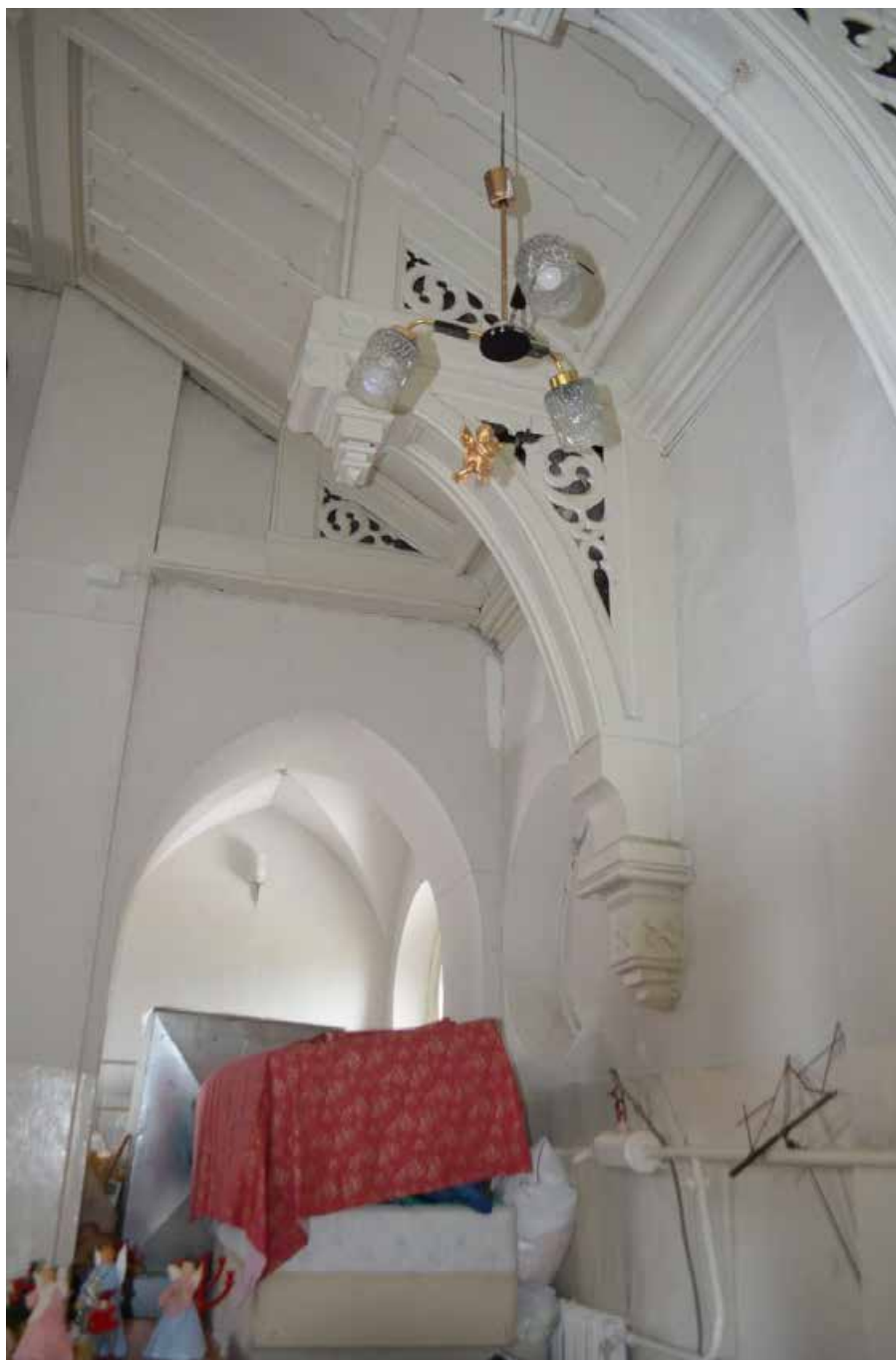
Фото 84. Объект культурного наследия федерального значения «Церковь лютеранская Воскресения Христова». Второй этаж. Помещение 1-Н (15). Хоры. Фрагмент. Съёмка 31.10.2022 г.
