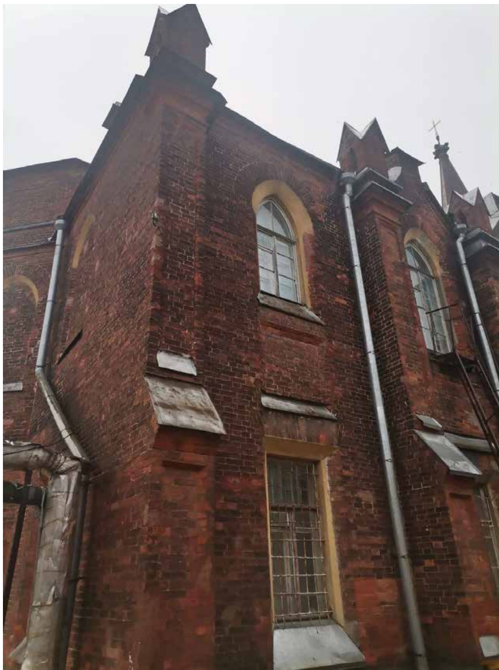
Фото 18. Объект культурного наследия федерального значения «Церковь лютеранская Воскресения Христова». Юго-западный фасад. Фрагмент. Съемка 31.10.2022 г.
