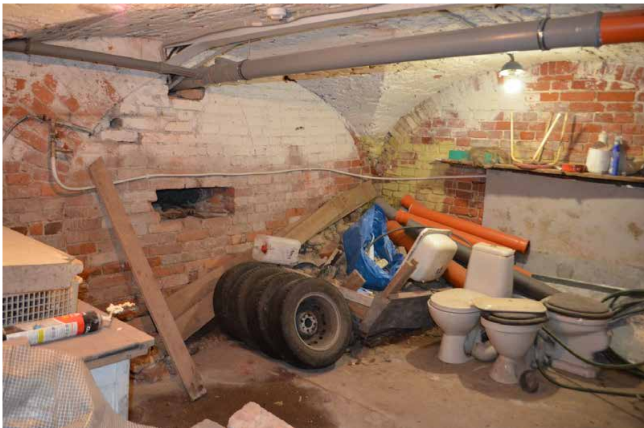
Фото 38. Объект культурного наследия федерального значения «Церковь лютеранская Воскресения Христова». Подвал. Помещение 2-Н (6). Фрагмент. Съёмка 31.10.2022 г.
