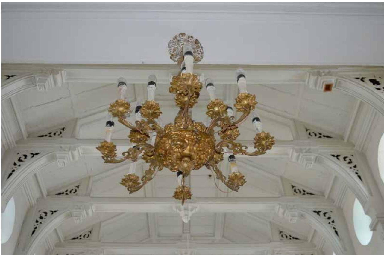
Фото 78. Объект культурного наследия федерального значения «Церковь лютеранская Воскресения Христова». Второй этаж. Помещение 1-Н (15). Церковный зал. Фрагмент. Съёмка 31.10.2022 г.
