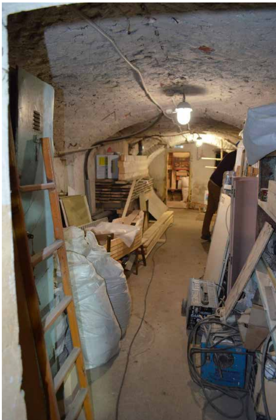
Фото 35. Объект культурного наследия федерального значения «Церковь лютеранская Воскресения Христова». Подвал. Помещение 2-Н (5). Фрагмент. Съёмка 31.10.2022 г.
