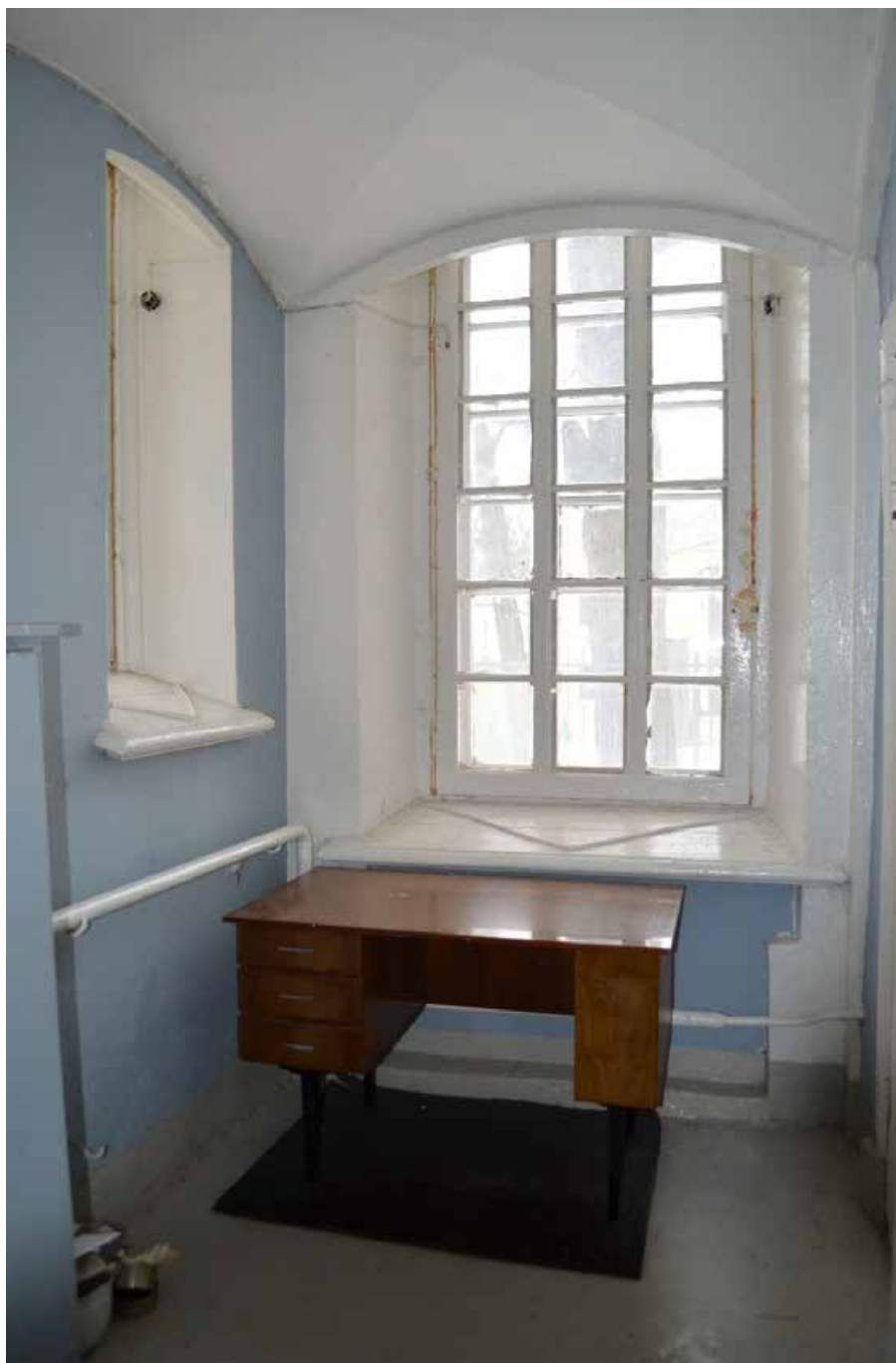
Фото 55. Объект культурного наследия федерального значения «Церковь лютеранская Воскресения Христова». Первый этаж. Помещение 1-Н (2). Фрагмент. Съёмка 31.10.2022 г.
