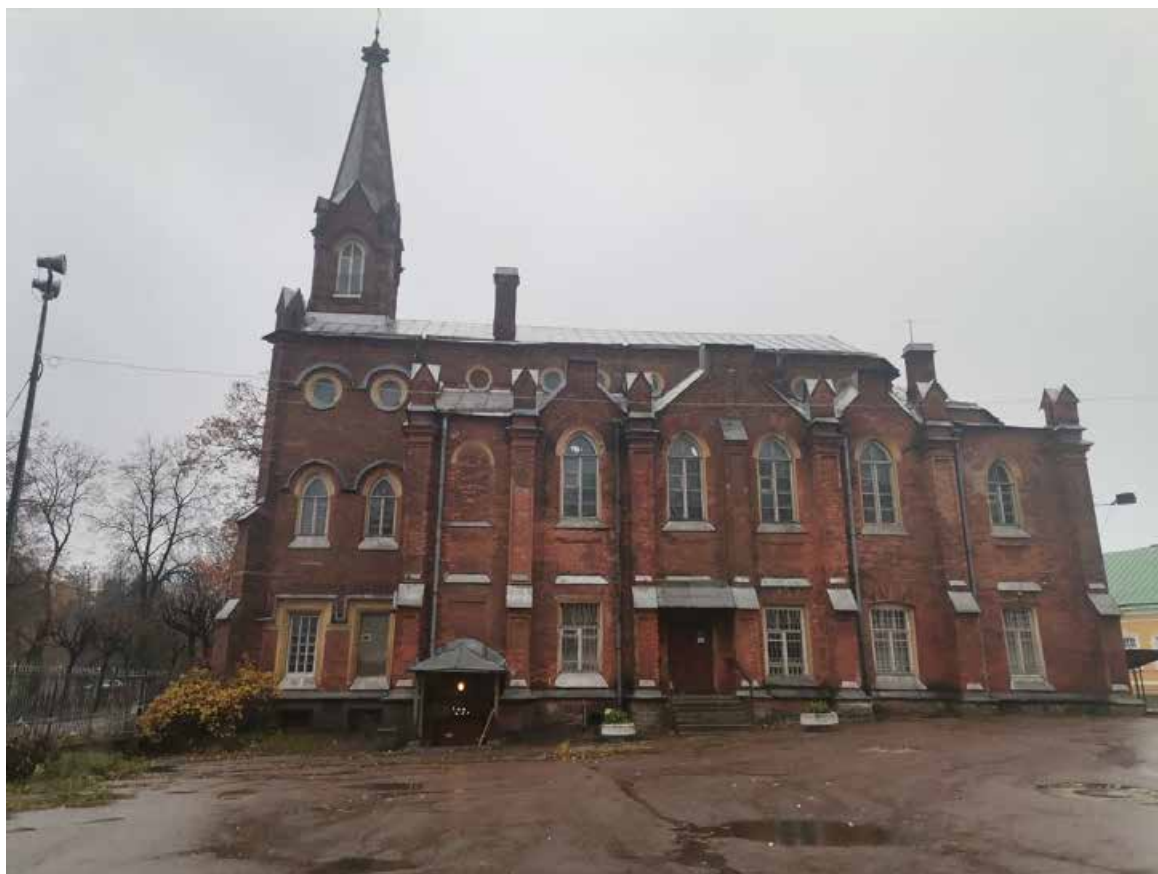
Фото 01. Объект культурного наследия федерального значения «Церковь лютеранская Воскресения Христова». Северо-восточный фасад. Общий вид. Съёмка 31.10.2022 г.
