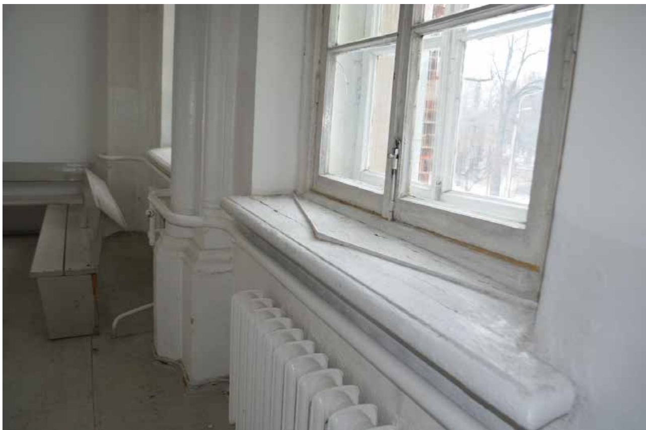
Фото 74. Объект культурного наследия федерального значения «Церковь лютеранская Воскресения Христова». Второй этаж. Помещение 1-Н (15). Церковный зал. Фрагмент. Съёмка 31.10.2022 г.
