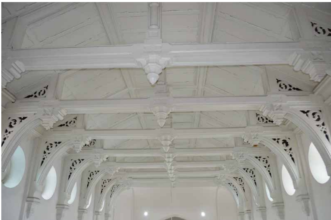
Фото 83. Объект культурного наследия федерального значения «Церковь лютеранская Воскресения Христова». Второй этаж. Помещение 1-Н (15). Церковный зал, потолок: фермы, кессоны и кронштейны. Съёмка 31.10.2022 г.
