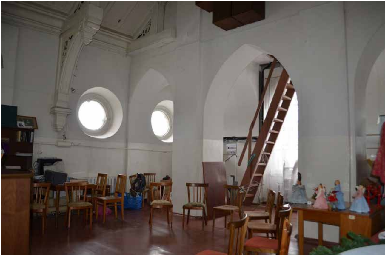
Фото 86. Объект культурного наследия федерального значения «Церковь лютеранская Воскресения Христова». Второй этаж. Помещение 1-Н (15). Хоры. Фрагмент. Съёмка 31.10.2022 г.
