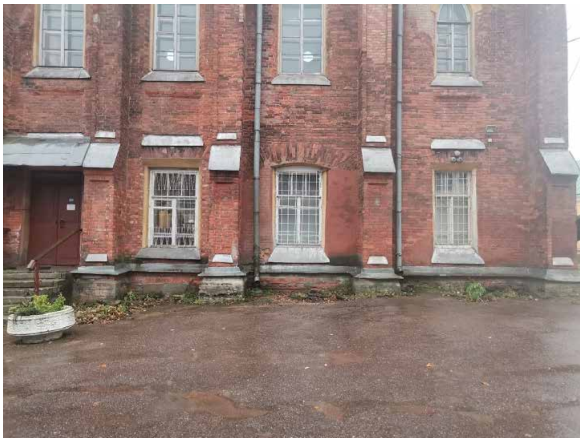
Фото 11. Объект культурного наследия федерального значения «Церковь лютеранская Воскресения Христова». Северо-восточный фасад. Фрагмент. Съёмка 31.10.2022 г.
