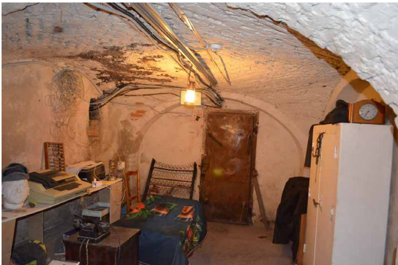
Фото 31. Объект культурного наследия федерального значения «Церковь лютеранская Воскресения Христова». Подвал. Помещение 2-Н (1). Фрагмент. Съёмка 31.10.2022 г.
