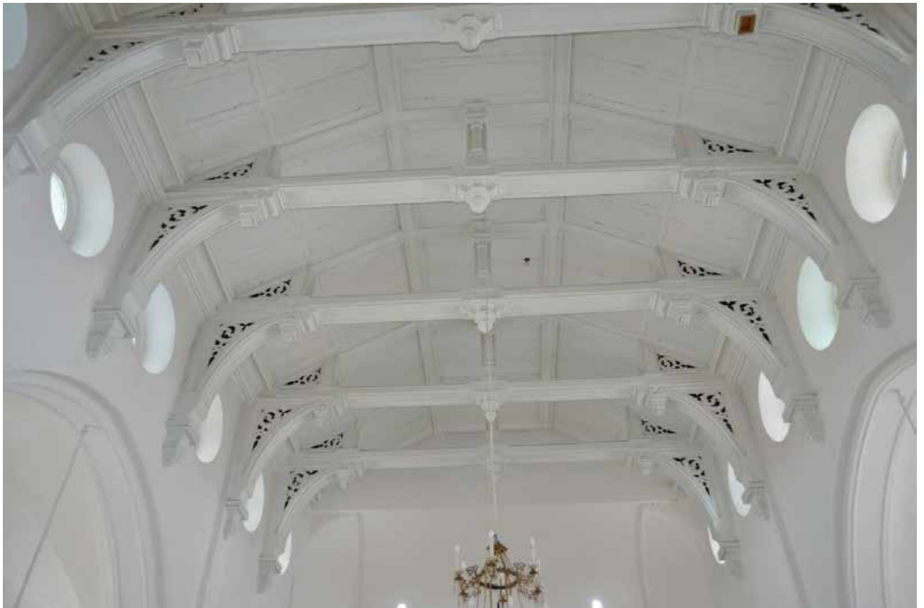
Фото 66. Объект культурного наследия федерального значения «Церковь лютеранская Воскресения Христова». Второй этаж. Помещение 1-Н (15). Церковный зал. Фрагмент. Съёмка 31.10.2022 г.
