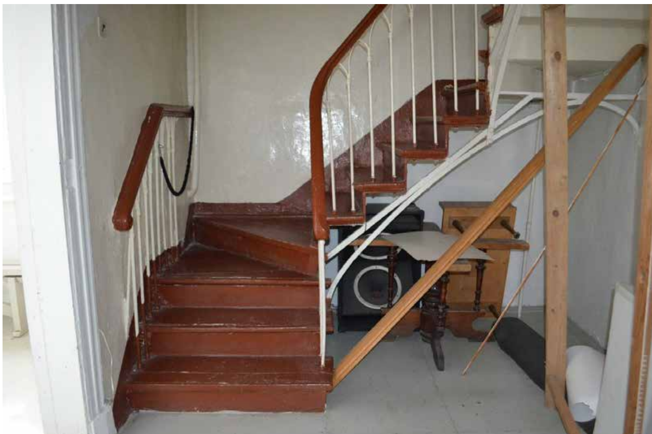
Фото 79. Объект культурного наследия федерального значения «Церковь лютеранская Воскресения Христова». Второй этаж. Помещение 1-Н (15). Лестница, ведущая на хоры. Фрагмент. Съёмка 31.10.2022 г.
