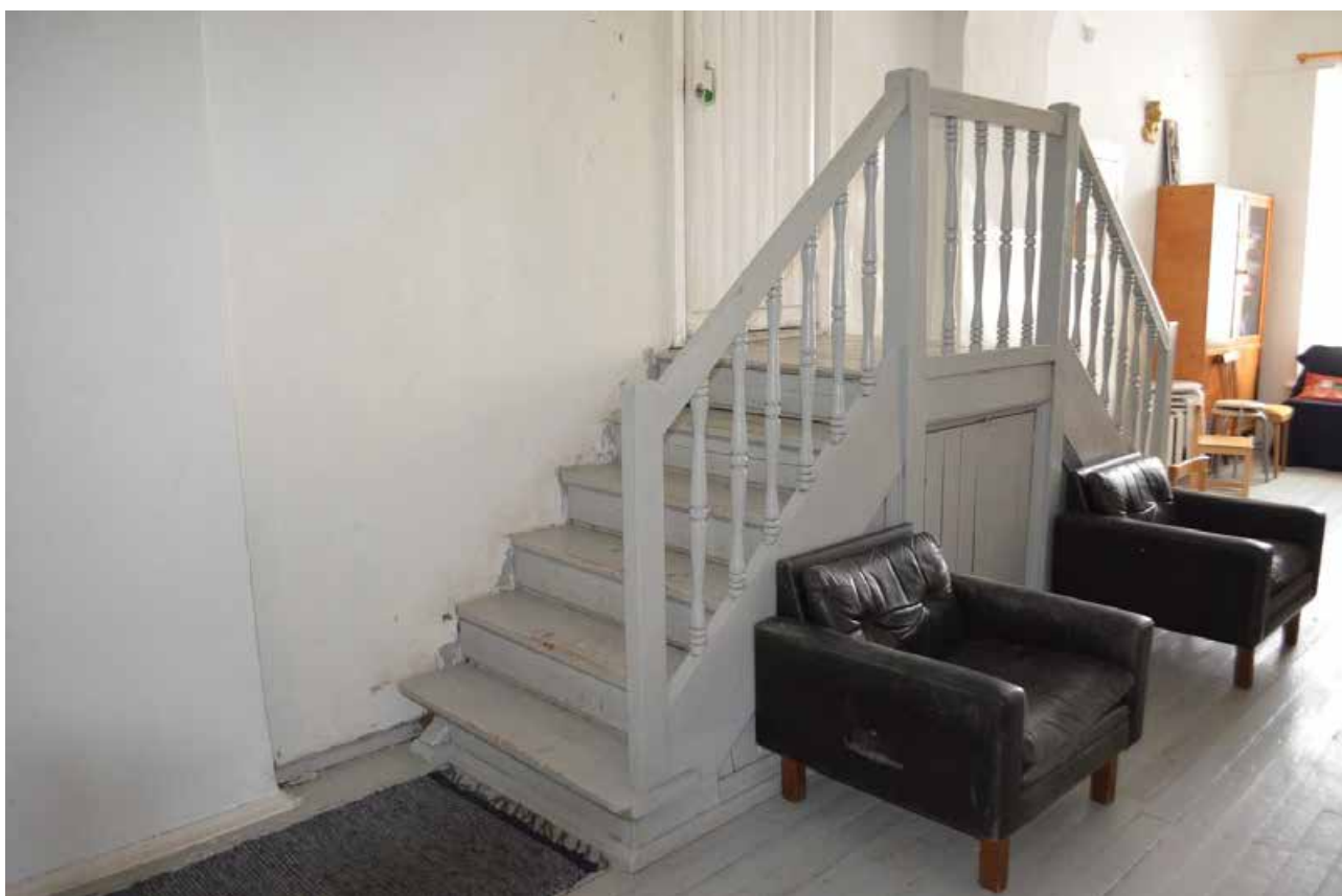
Фото 45. Объект культурного наследия федерального значения «Церковь лютеранская Воскресения Христова». Первый этаж. Помещение 1-Н (5). Фрагмент. Съёмка 31.10.2022 г.
