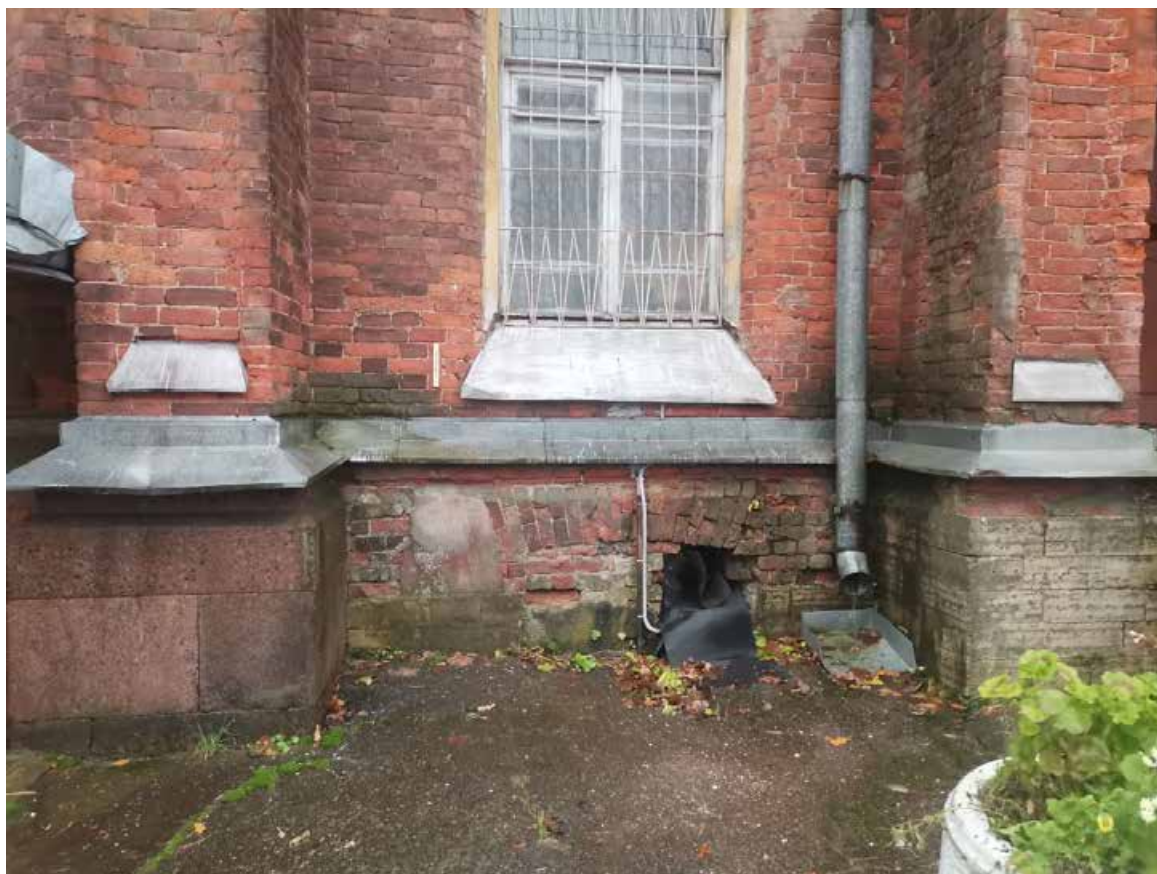
Фото 08. Объект культурного наследия федерального значения «Церковь лютеранская Воскресения Христова». Северо-восточный фасад. Фрагмент. Съёмка 31.10.2022 г.
