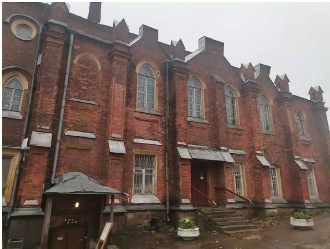
Фото 05. Объект культурного наследия федерального значения «Церковь лютеранская Воскресения Христова». Северо-восточный фасад. Фрагмент. Съёмка 31.10.2022 г.
