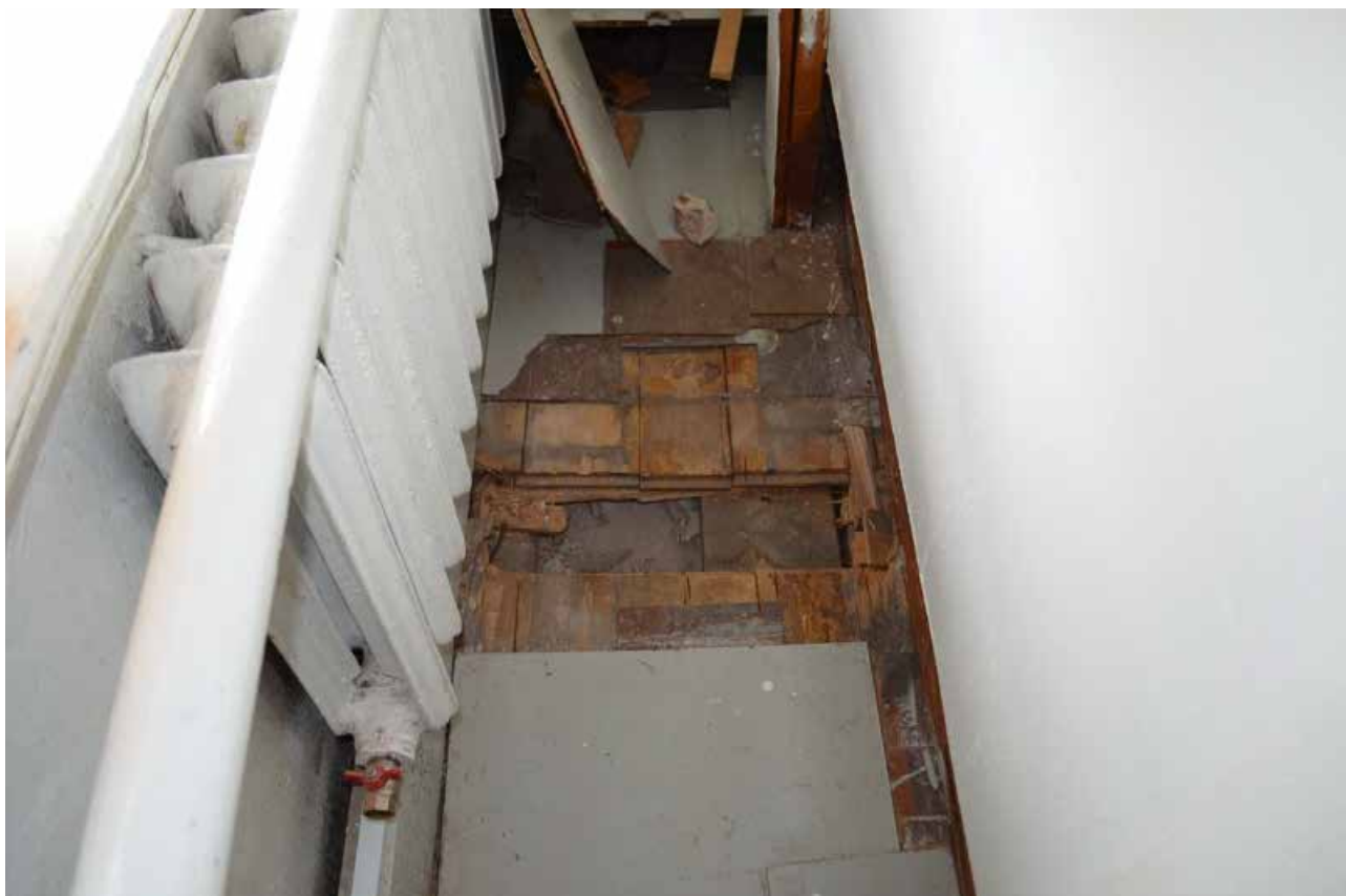
Фото 85. Объект культурного наследия федерального значения «Церковь лютеранская Воскресения Христова». Второй этаж. Помещение 1-Н (15). Хоры. Фрагмент. Съёмка 31.10.2022 г.
