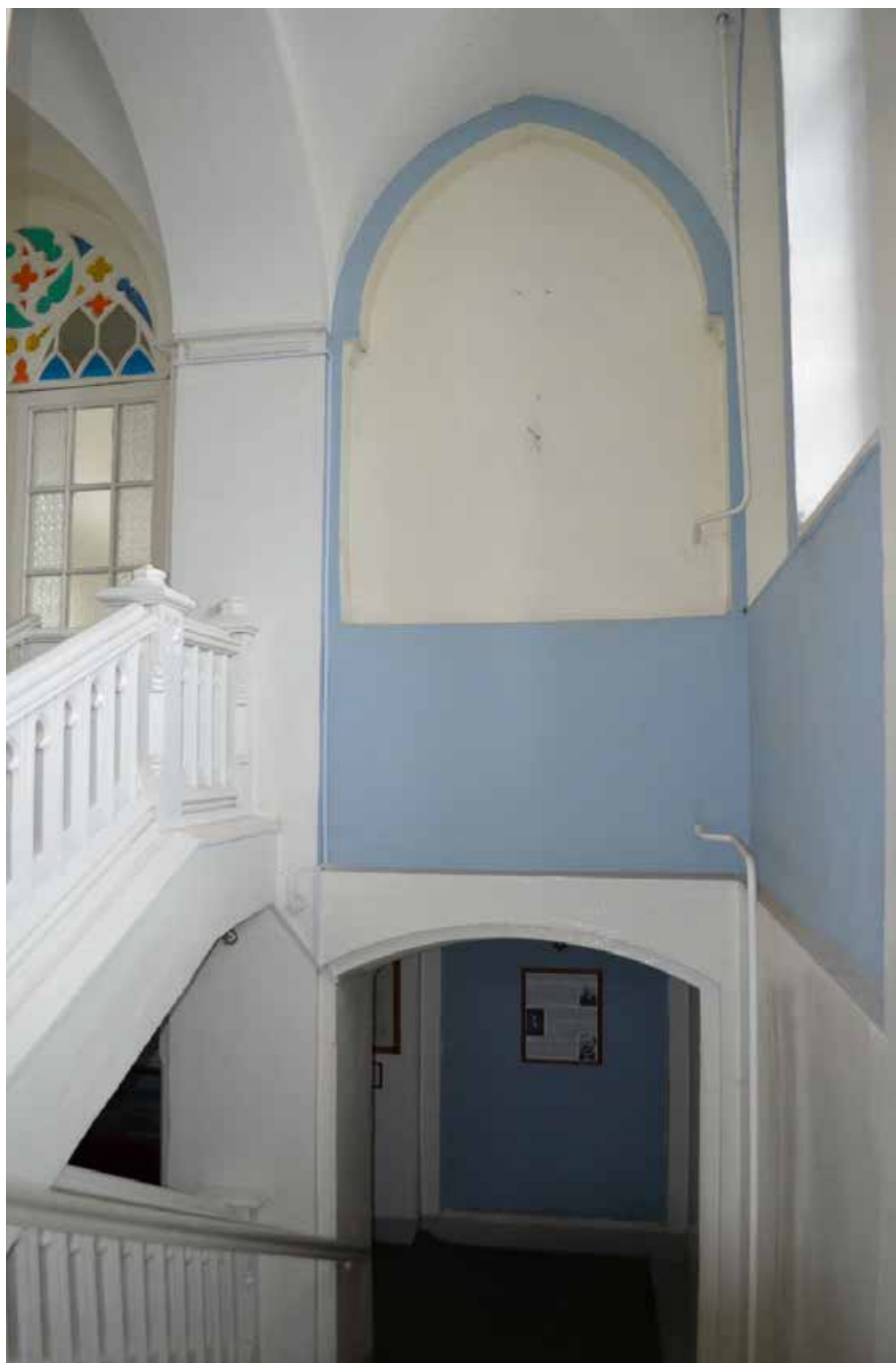
Фото 64. Объект культурного наследия федерального значения «Церковь лютеранская Воскресения Христова». Второй этаж. Помещение 1-Н (18). Лестница. Фрагмент. Съёмка 31.10.2022 г.
