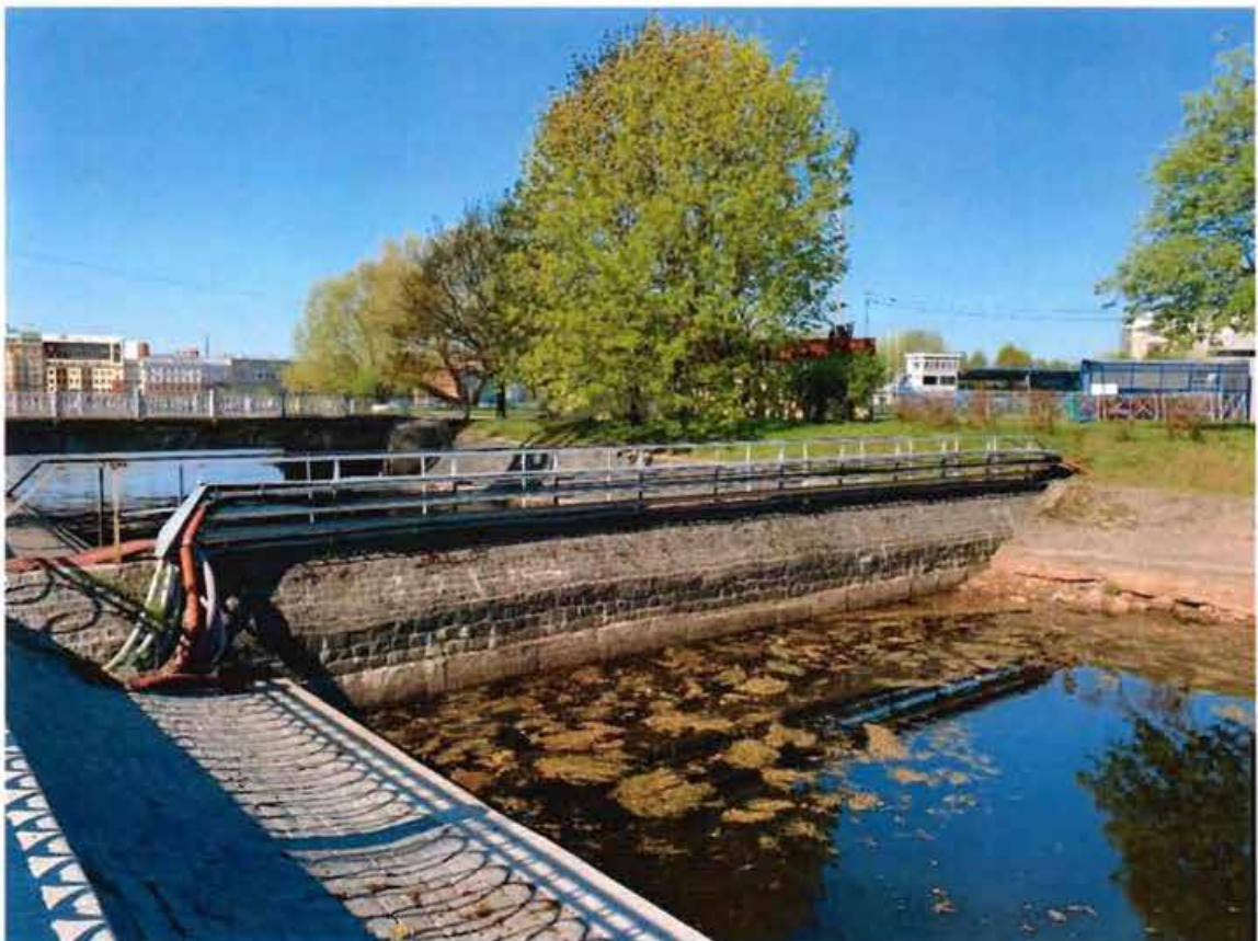
13. Вид на плотину (у стадиона «Петровский»). Восточная часть объекта культурного наследия.
