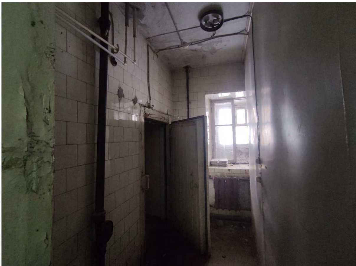
15. Фрагмент пом. 1-Н (16) в уровне цокольного этажа.
