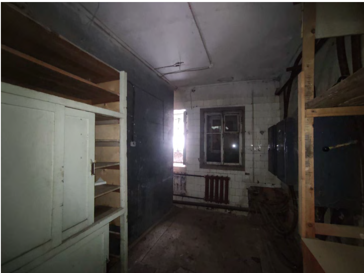
14. Фрагмент пом. 1-Н (16) в уровне цокольного этажа.
