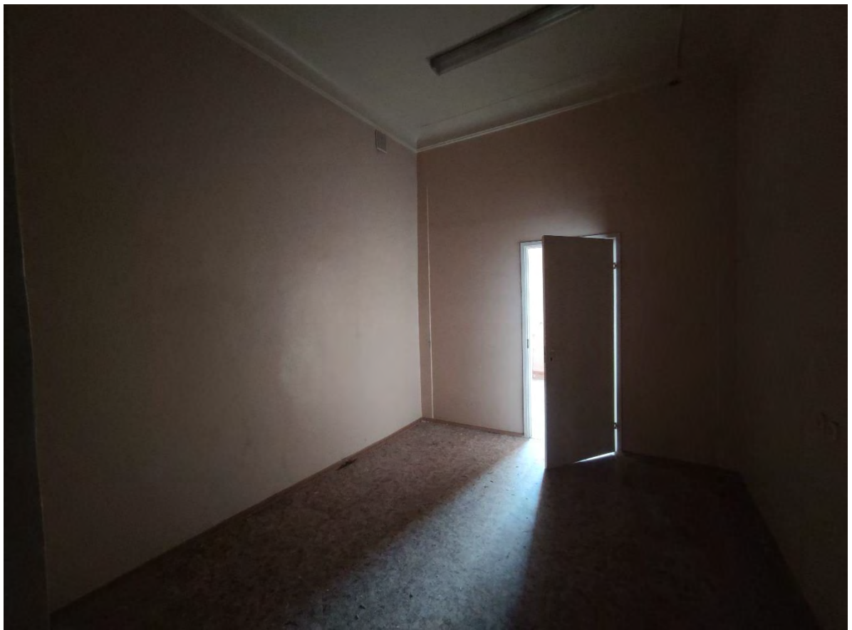
84. Общий вид пом. 4-Н (8) в уровне 3-го этажа.
