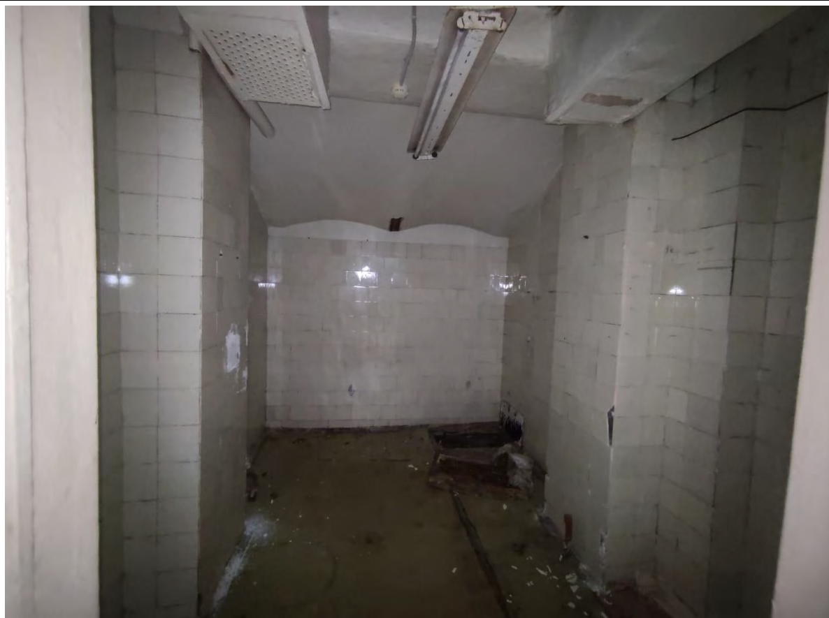
20. Общий вид пом. 1-Н (23, 24) в уровне цокольного этажа.
