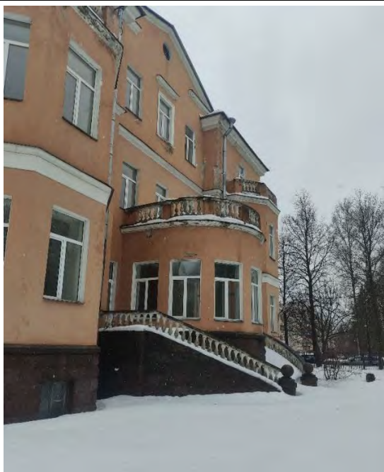
9. Фрагмент северо-западного фасада выявленного объекта культурного наследия значения «Дом Л.В. Калина (с садом)». Вид на полуциркульный одноэтажный ризалит.
