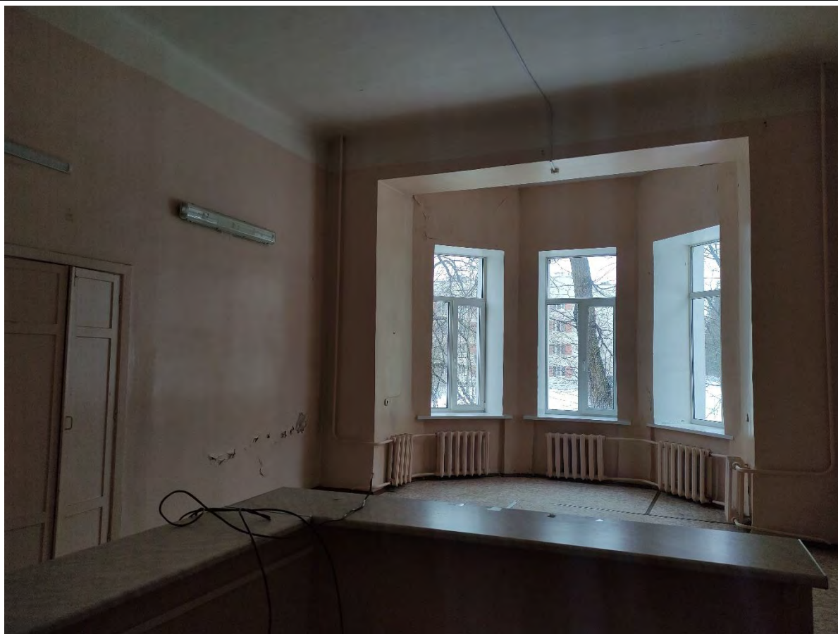
38. Общий вид пом. 2-Н (22) в уровне 1-го этажа.
