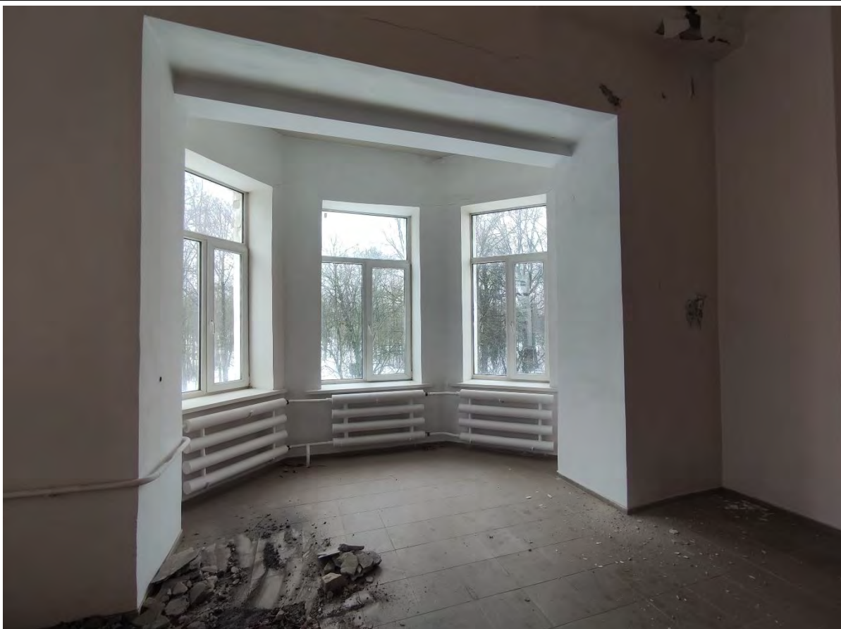
62. Фрагмент пом. 3-Н (2) в уровне 2-го этажа.
