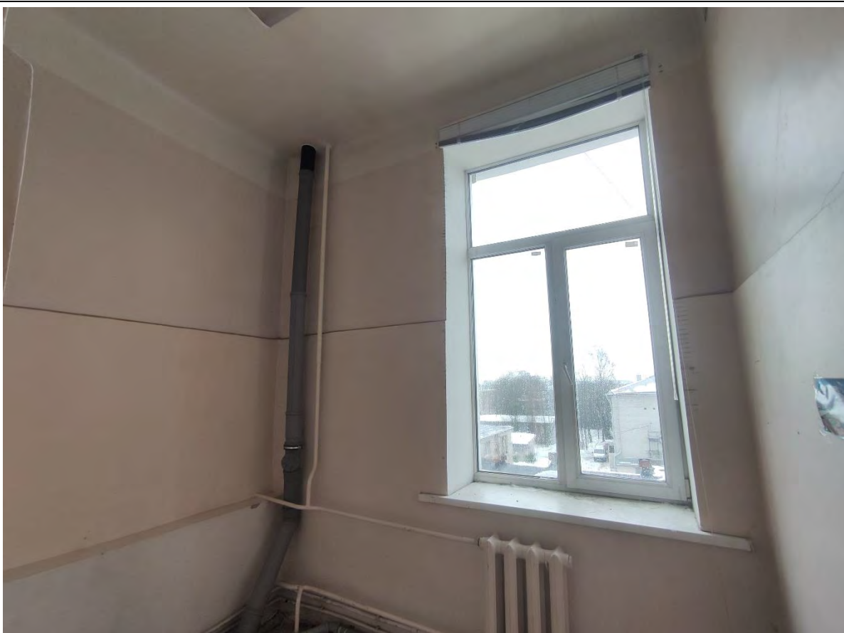
71. Общий вид пом. 4-Н (12) в уровне 3-го этажа.
