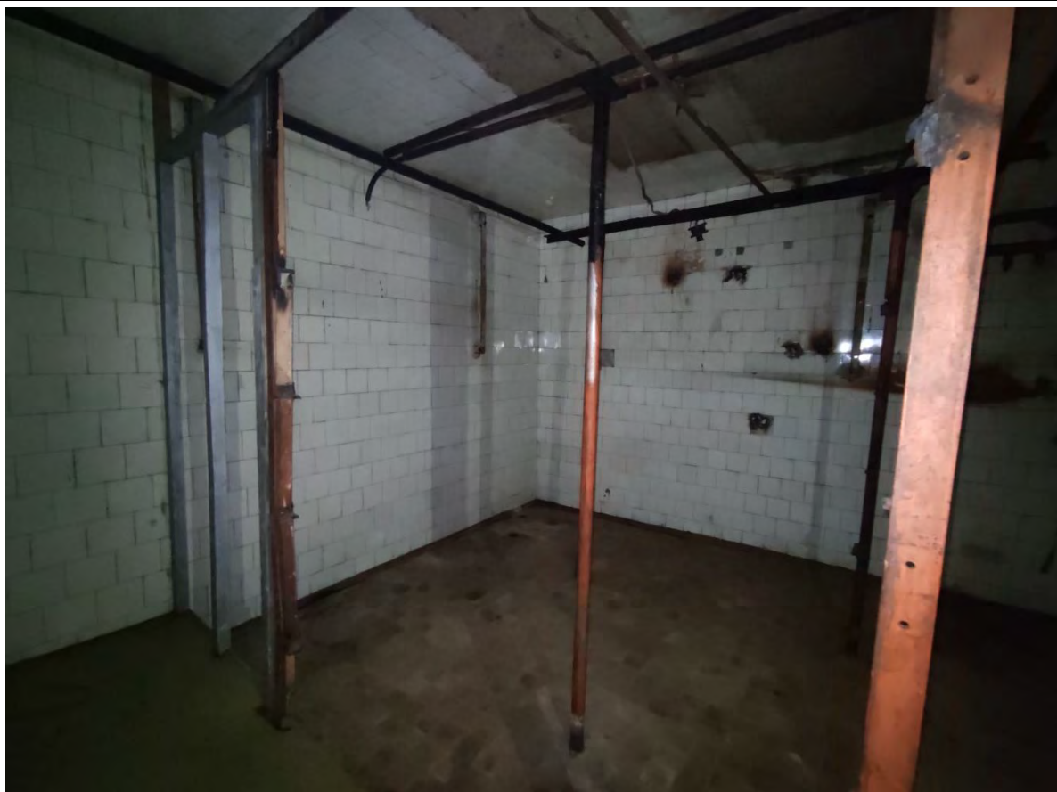
30. Общий вид пом. 1-Н (5) в уровне цокольного этажа.
