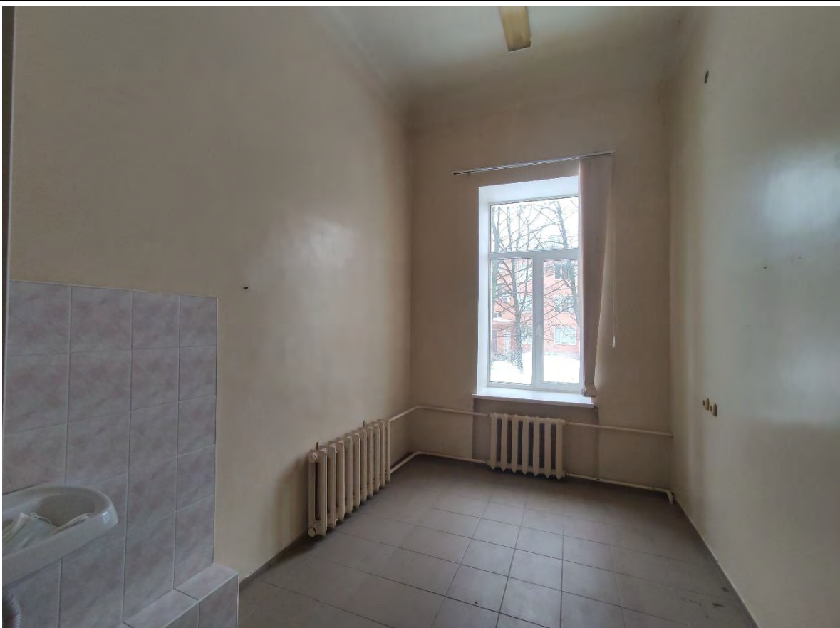
48. Фрагмент пом. 2-Н (6) в уровне 1-го этажа.
