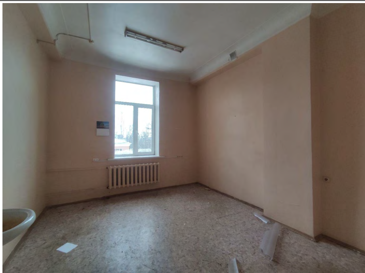
70. Общий вид пом. 4-Н (9) в уровне 3-го этажа.
