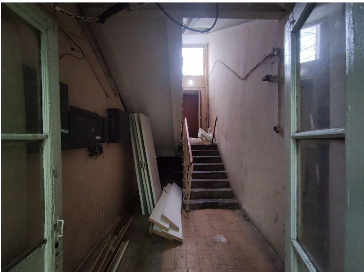
25. Общий вид объема двухмаршевой лестницы (пом. 1-Н (31)) в уровне цокольного этажа.
