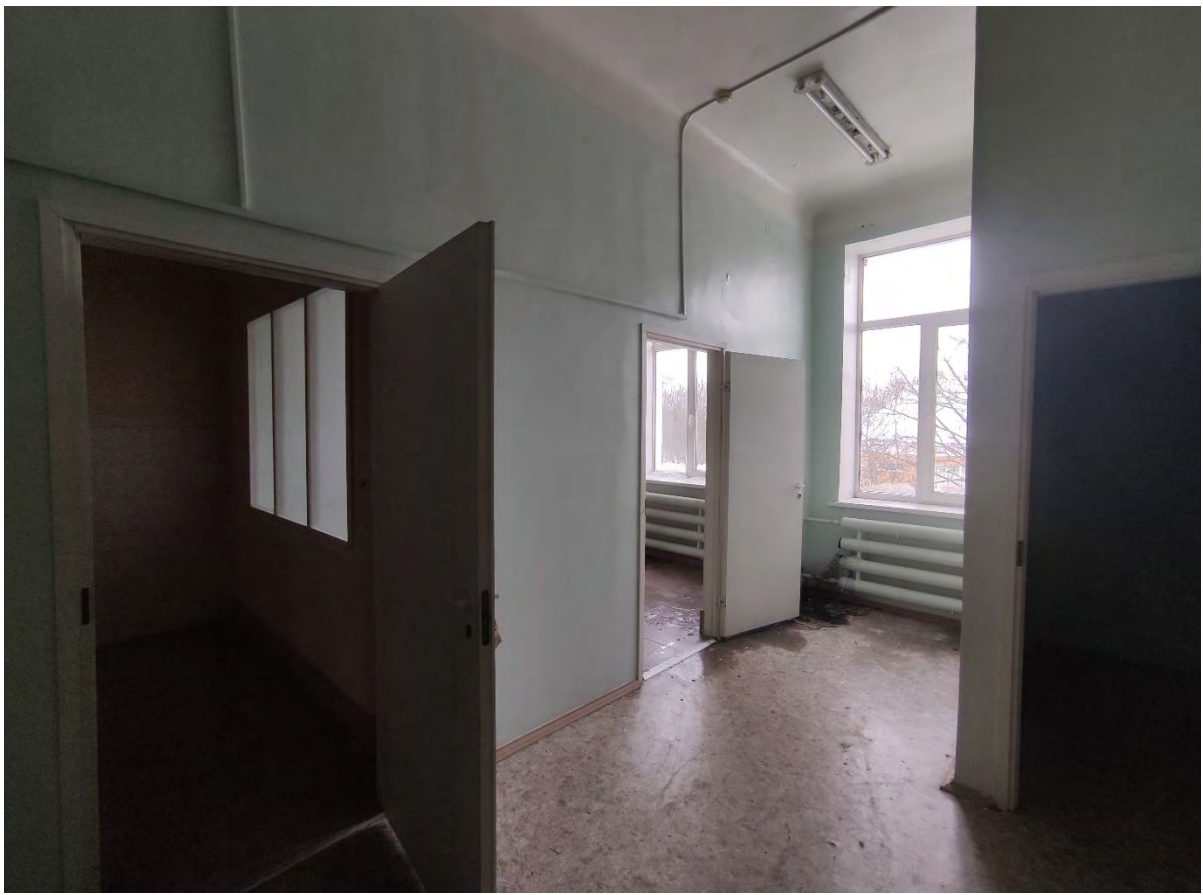
81. Общий вид пом. 4-Н (26) в уровне 3-го этажа.
