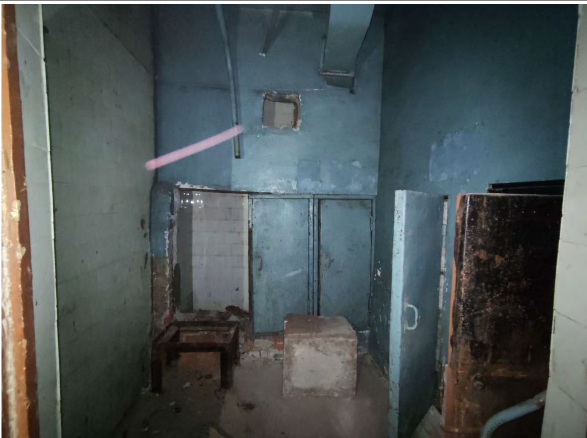
31. Общий вид пом. 1-Н (8) в уровне цокольного этажа.
