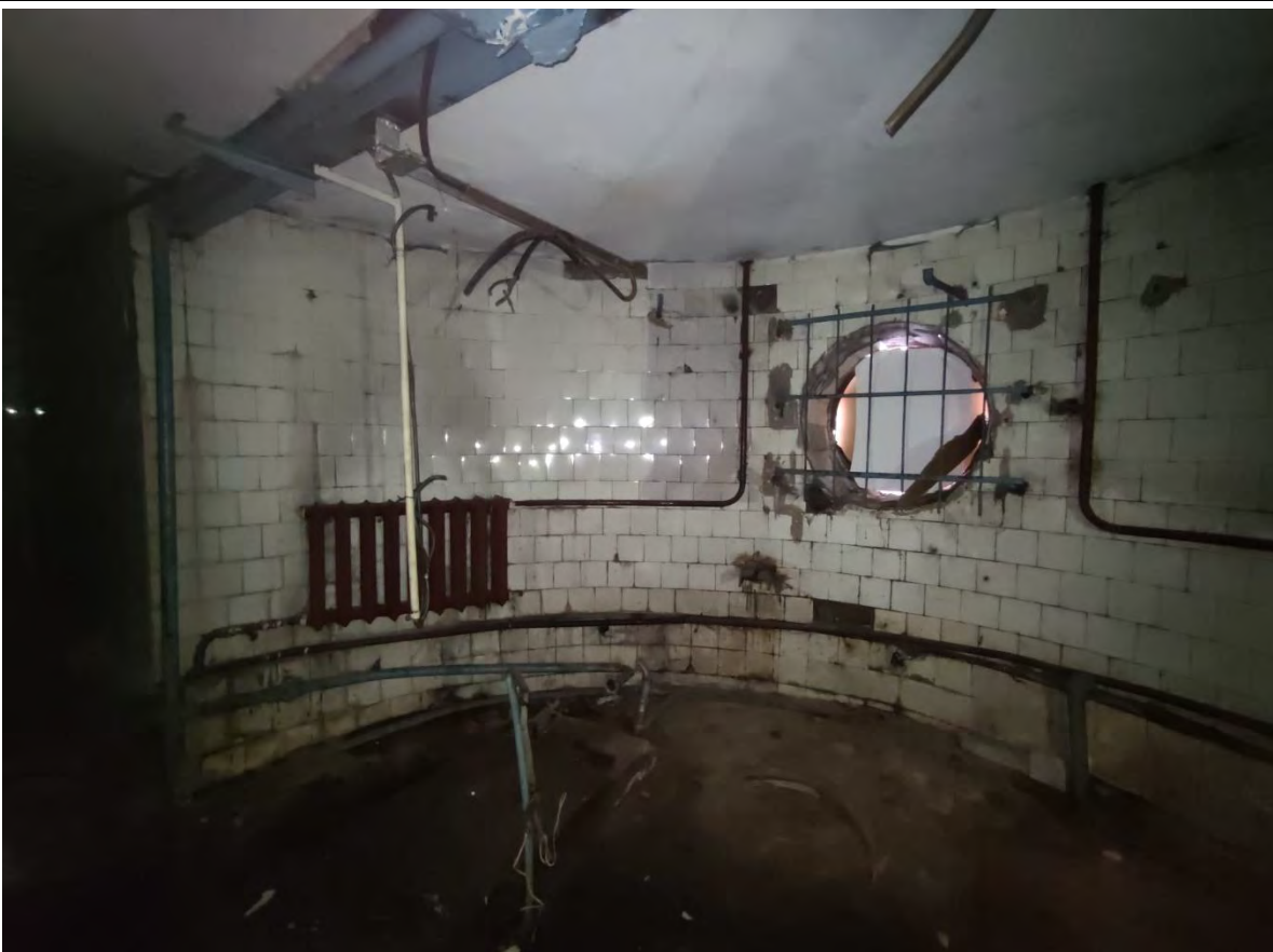
32. Общий вид пом. 1-Н (6) в уровне цокольного этажа.
