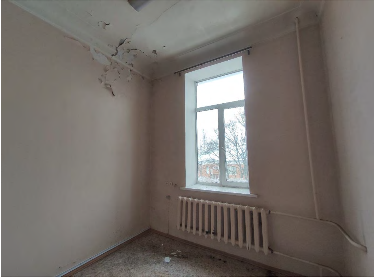
85. Общий вид пом. 4-Н (7) в уровне 3-го этажа.
