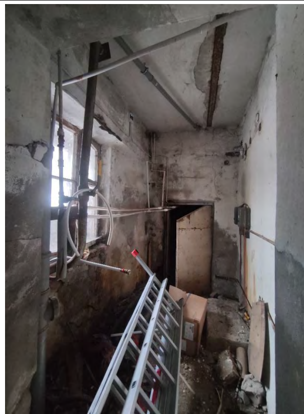
13. Общий вид пом. 1-Н (22) в уровне цокольного этажа.
