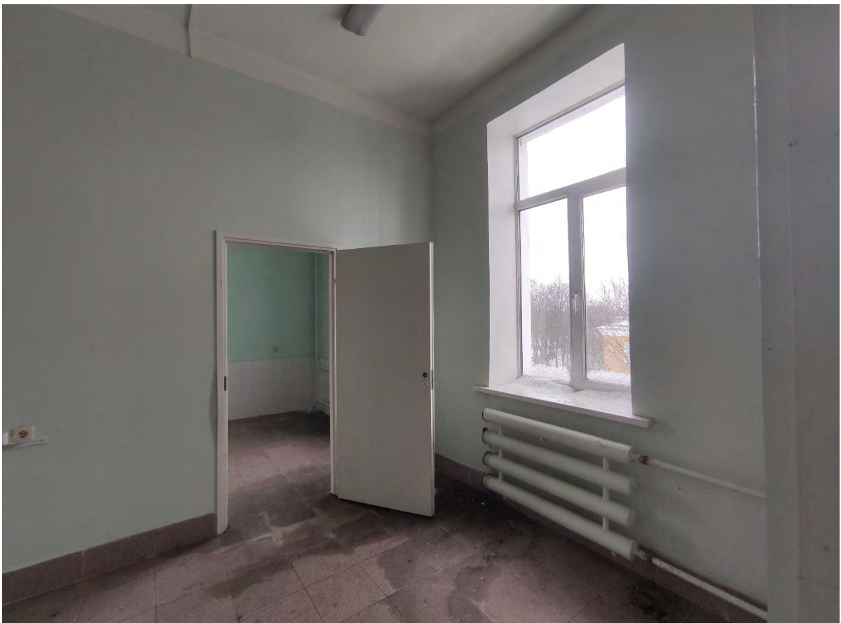
82. Фрагмент пом. 4-Н (24) в уровне 3-го этажа.
