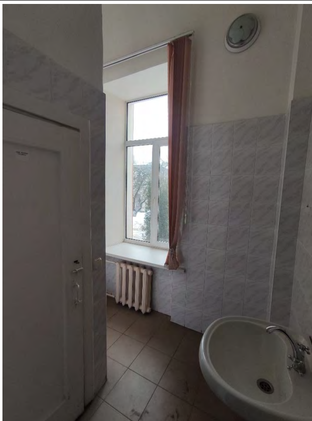
42. Фрагмент пом. 2-Н (18) в уровне 1-го этажа.
