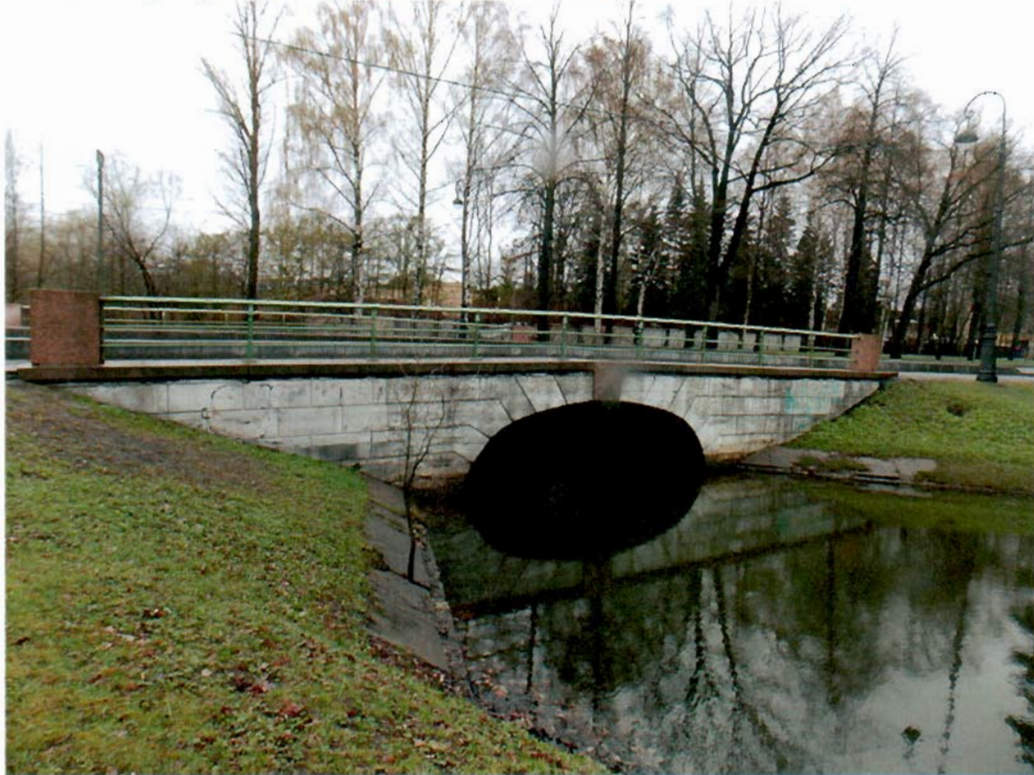
15. мост через р. Чухонку (на Южной дороге).
