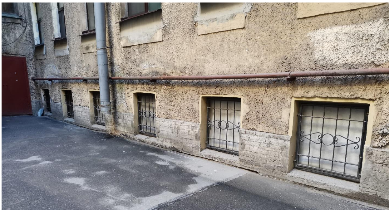
Фото 3, 4 Оконные заполнения помещения 4-Н.
