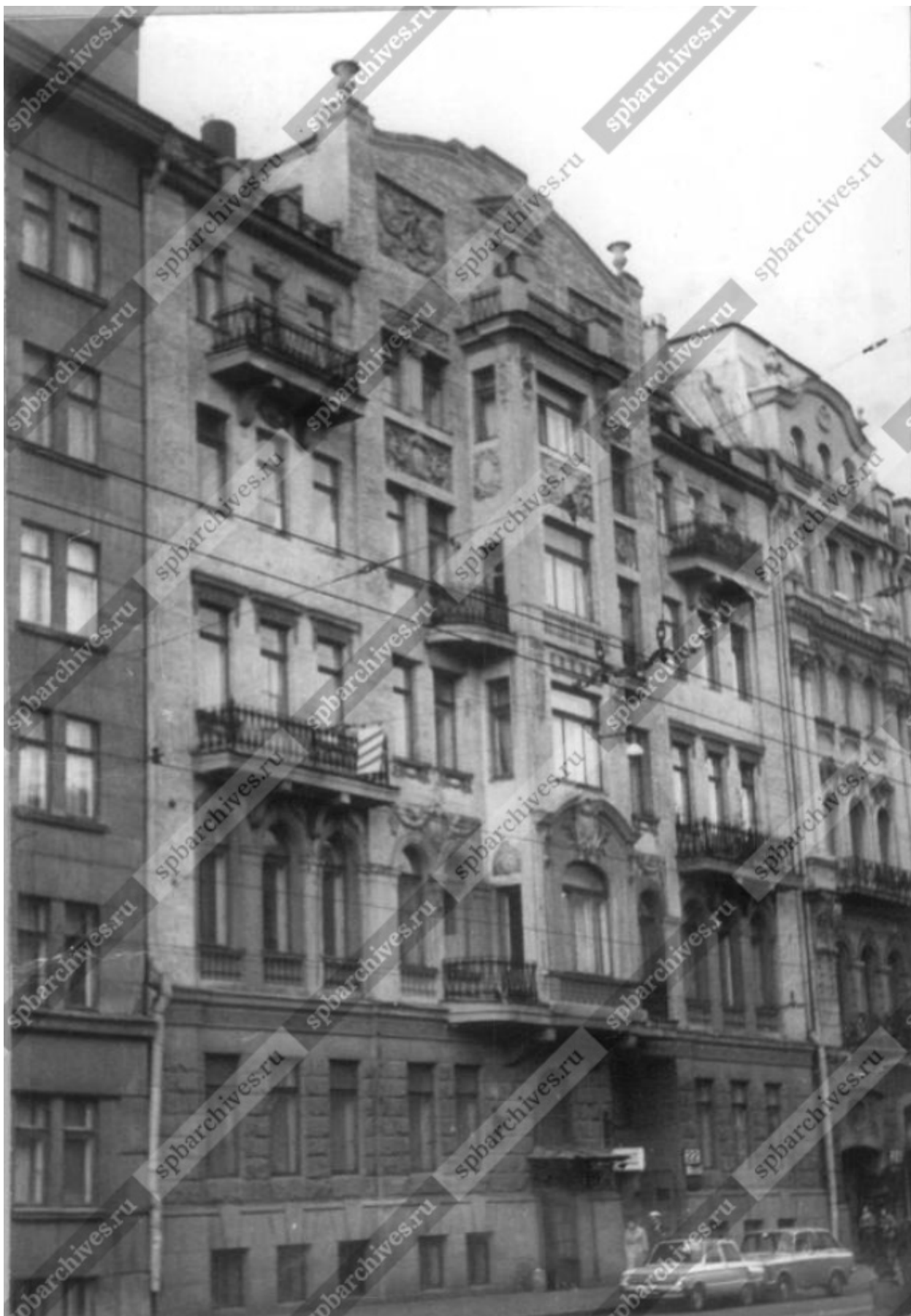
44. Фасад дома №22 на улице Салтыкова-Щедрина. Арх. В.В. Шауб, 1911 г. Дата съёмки: 1982 г. // ЦГАКФФД СПб. Архивный шифр: Ар 122233.
