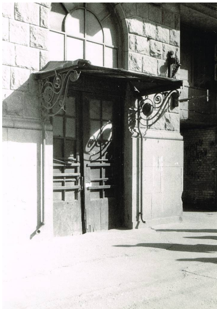
38. Кирочная ул., д. 22. Лицевой фасад. Фрагмент. Фото 1998 г. URL: https://pastvu.com/p/1161341
