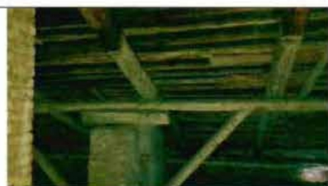
Фото 38. Конструкции крыши. Фрагмент.
