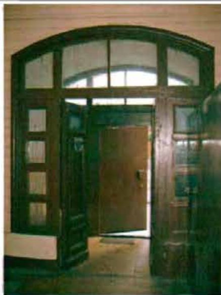
Фото 107. Дверной проем тамбура. Общий вид.
