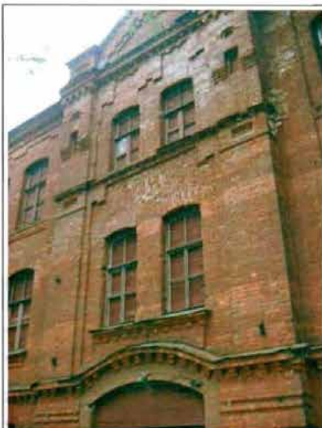
Фото 3. Западный фасад. Фрагмент центральной части фасада.
