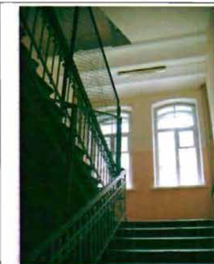
Фото 56. Лестница в центральной части здания. Фрагмент.
