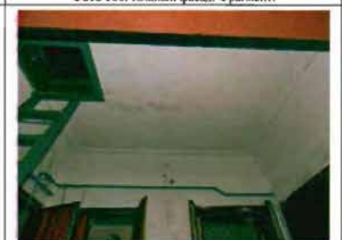
Фото 102. Отделка потолка тамбура. Общий вид.
