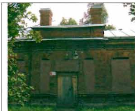
Фото 99. Западный фасад. Центральная часть. Общий вид.
