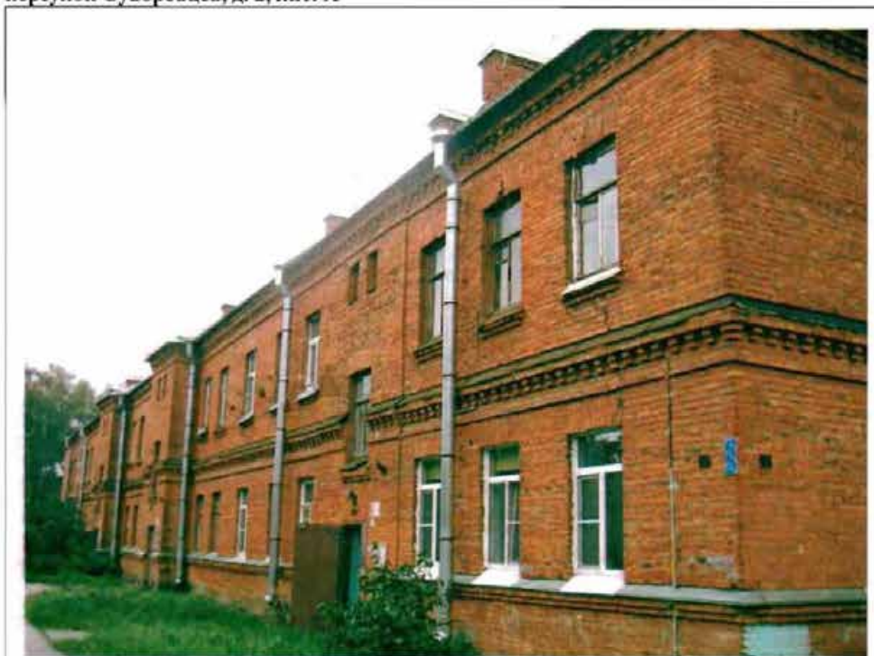
Фото 83. Северный фасад. Общий вид.
