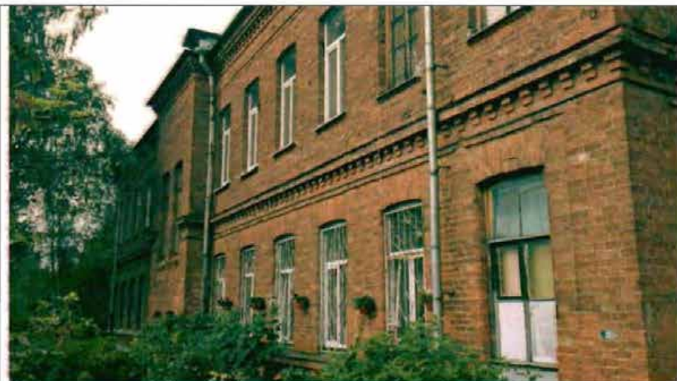
Фото 171. Восточный фасад. Общий вид.
