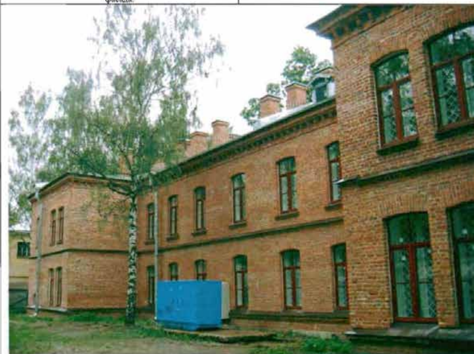
Фото 42. Западный фасад. Общий вид.
