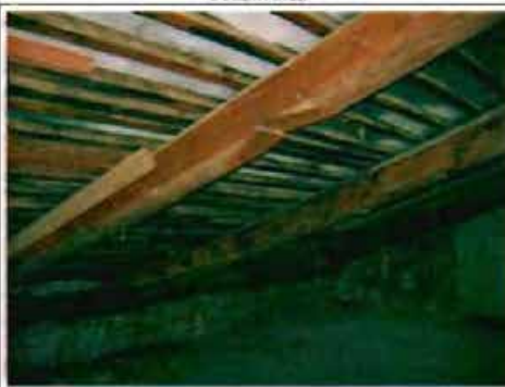
Фото 151. Конструкции крыши. Фрагмент.
