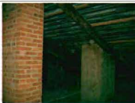
Фото 152. Конструкции крыши. Фрагмент.
