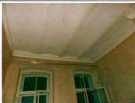
Фото 120. Помещение 1-го этажа. Общий вид.
