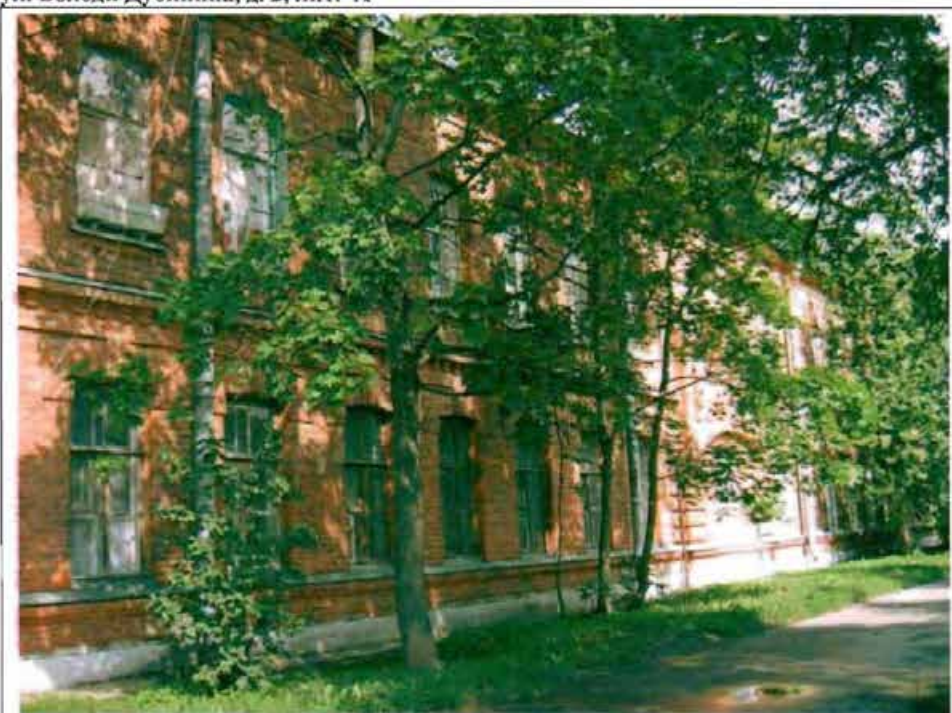
Фото 136. Восточный фасад. Общий вид.
