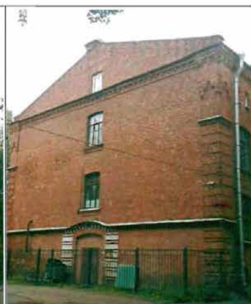
Фото 50. Южный фасад. Общий вид.
