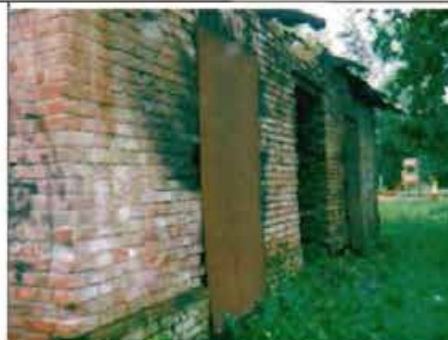
Фото 95. Северный фасад. Общий вид.
