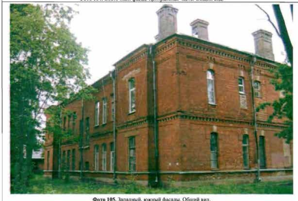
Фото 105. Западный, южный фасады. Общий вид.
