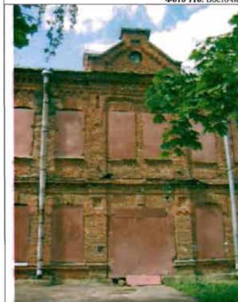
Фото 117. Восточный фасад. Фрагмент центральной части фасада.
