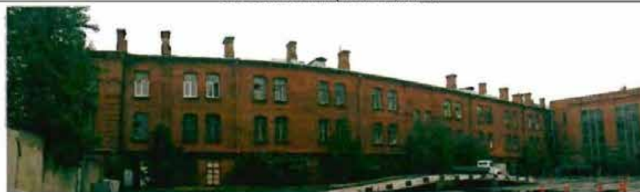
Фото 29. Западный фасад. Общий вид.
