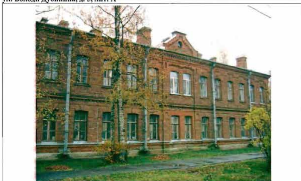
Фото 157. Западный фасад. Общий вид.
