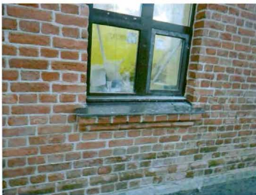
Ступенчатые подоконные доски. Съемка 20.11.2012, Воронина Н.В.
