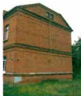
Фото 86. Западный фасад. Общий вид.
