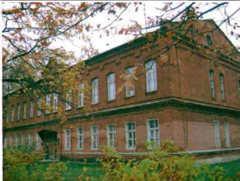
Фото 89. Западный, южный фасады. Общий вид.
