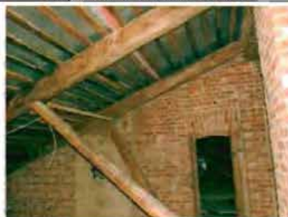
Фото 127. Конструкции крыши. Общий вид.
