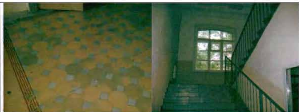
Фото 58. Интерьер. Покрытие межэтажной площадки лестницы в центральной части здания. Фрагмент.
