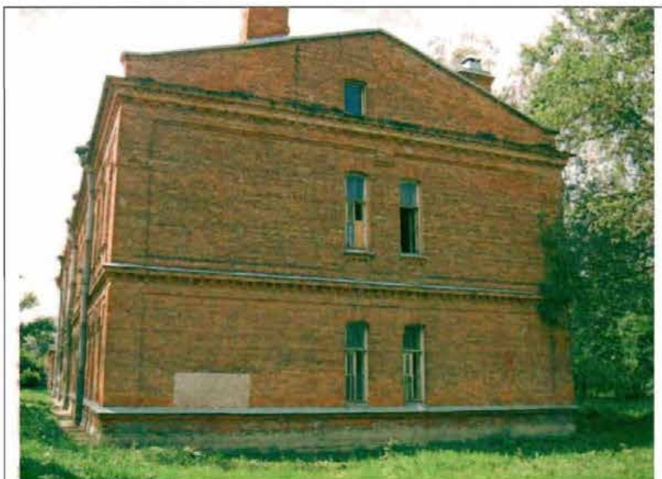
Фото 180. Северный фасад. Общий вид.
