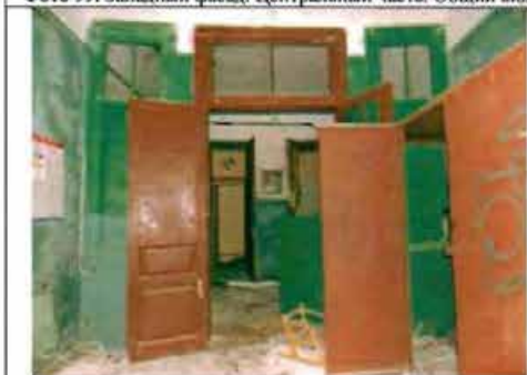
Фото 101. Дверной проем тамбура. Общий вид.
