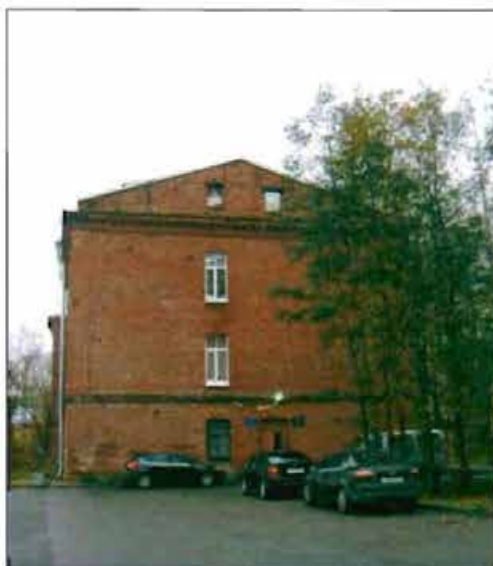
Фото 15. Северный фасад. Общий вид.
