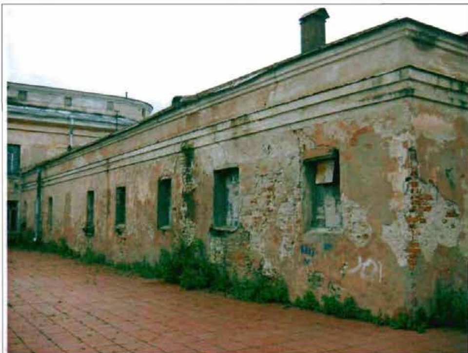
Фото 25. Восточный фасад. Общий вид.
