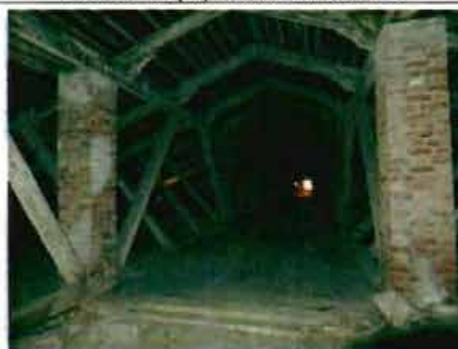
Фото 12. Конструкции крыши. Общий вид. 29.12.2015.
