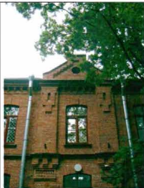
Фото 40. Восточный фасад. Фрагмент центральной части фасада.
