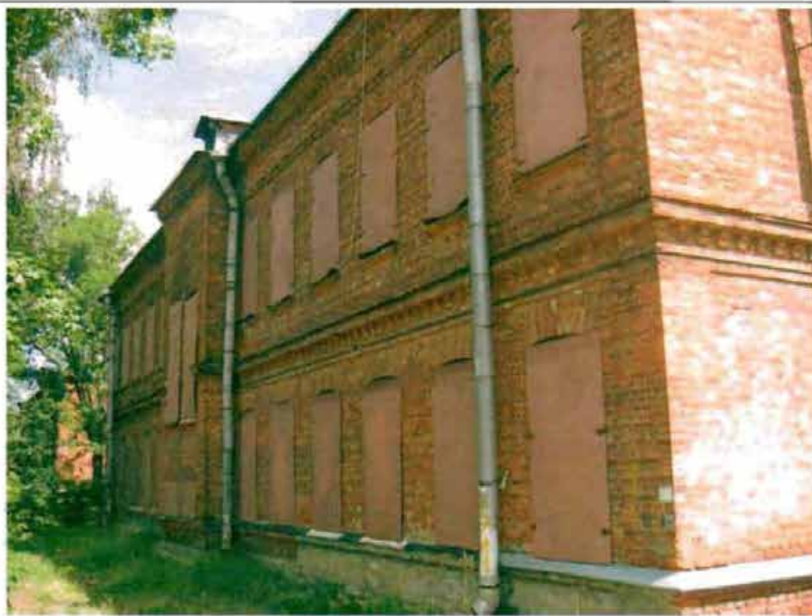
Фото 119. Западный фасад. Общий вид.
