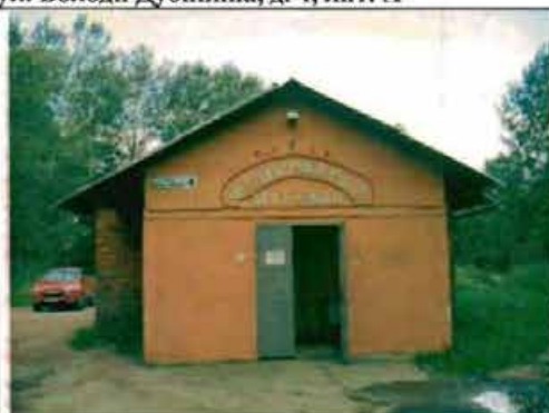
Фото 153. Восточный фасад. Общий вид.
