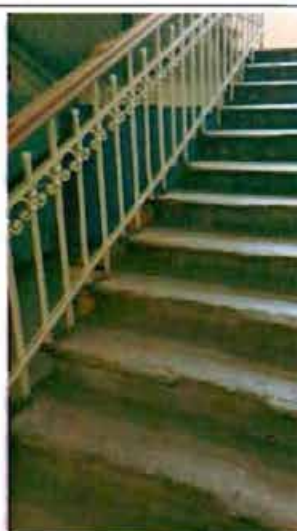
Фото 57. Лестница в центральной части здания. Фрагмент.
