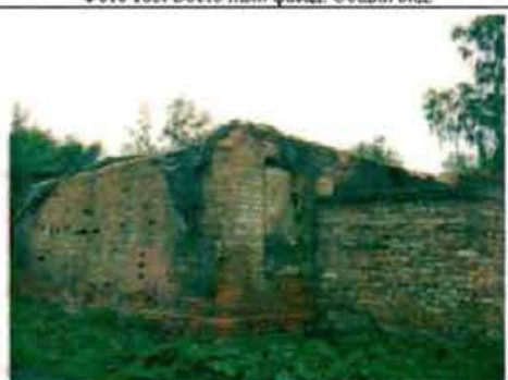
Фото 187. Северный фасад. Общий вид.
