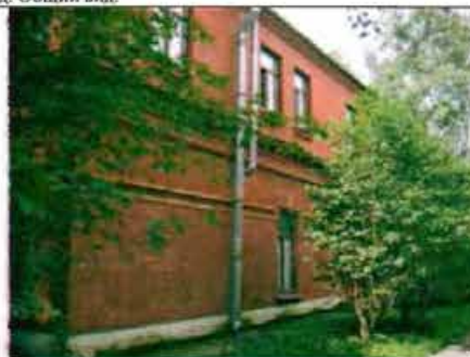
Фото 80. Северный фасад. Фрагмент.
