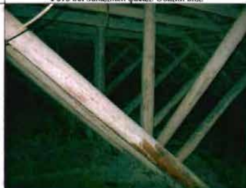
Фото 88. Конструкции крыши. Общий вид.
