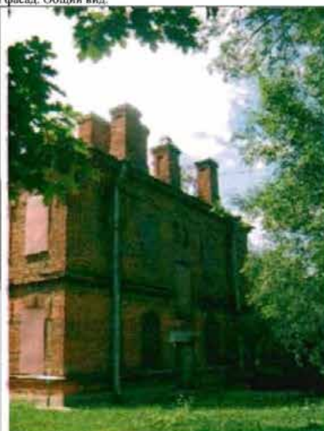
Фото 118. Северный фасад. Общий вид.
