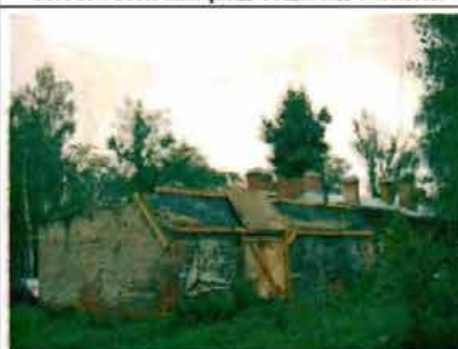
Фото 186. Западный, северный фасады. Общий вид.
