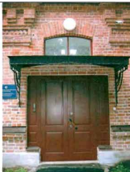
Фото 41. Дверной проем восточного фасада. Общий вид.
