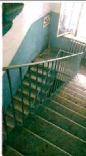
Фото 144. Лестница № 2 в южной части здания. Общий вид.
