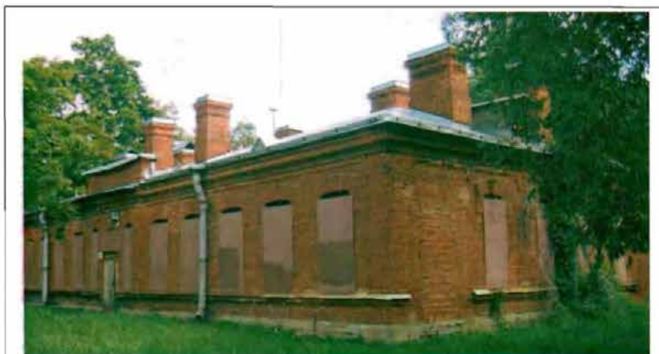
Фото 98. Западный фасад. Общий вид.
