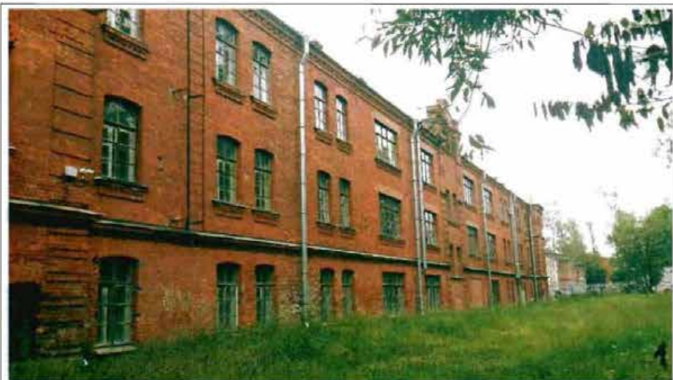
Фото 48. Западный фасад. Общий вид.
