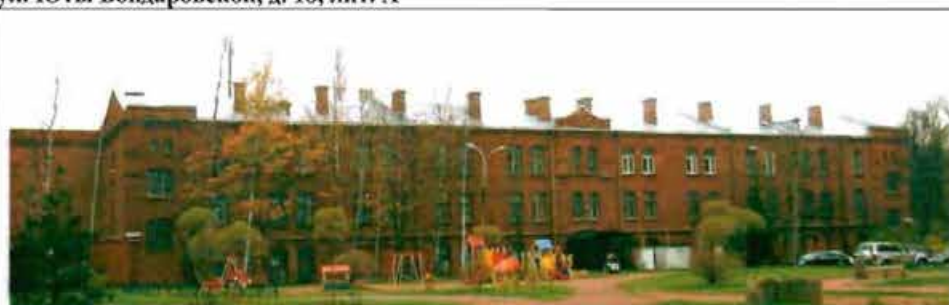
Фото 28. Восточный фасад. Общий вид.
