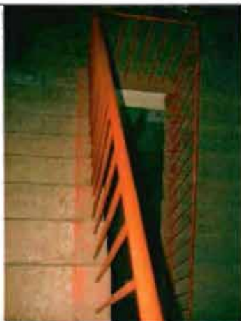
Фото149. Лестница № 1 в северной части здания. Общий вид.
