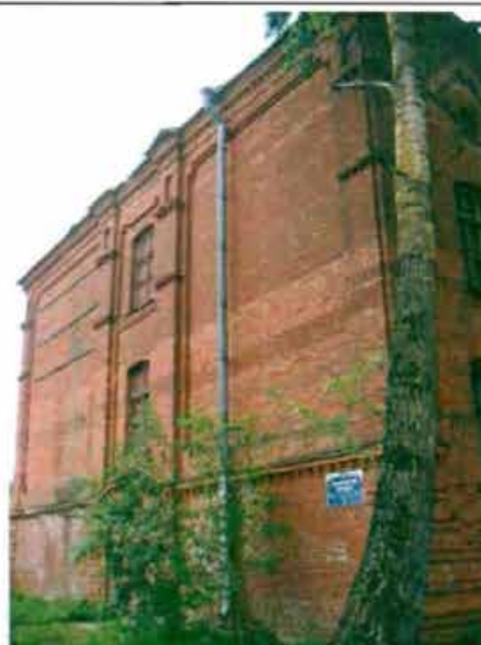
Фото 6. Северный фасад. Общий вид.
