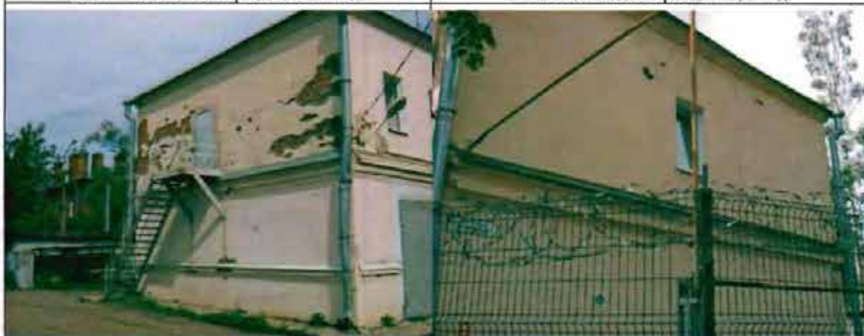
Фото 112. Южный фасад. Общий вид.
