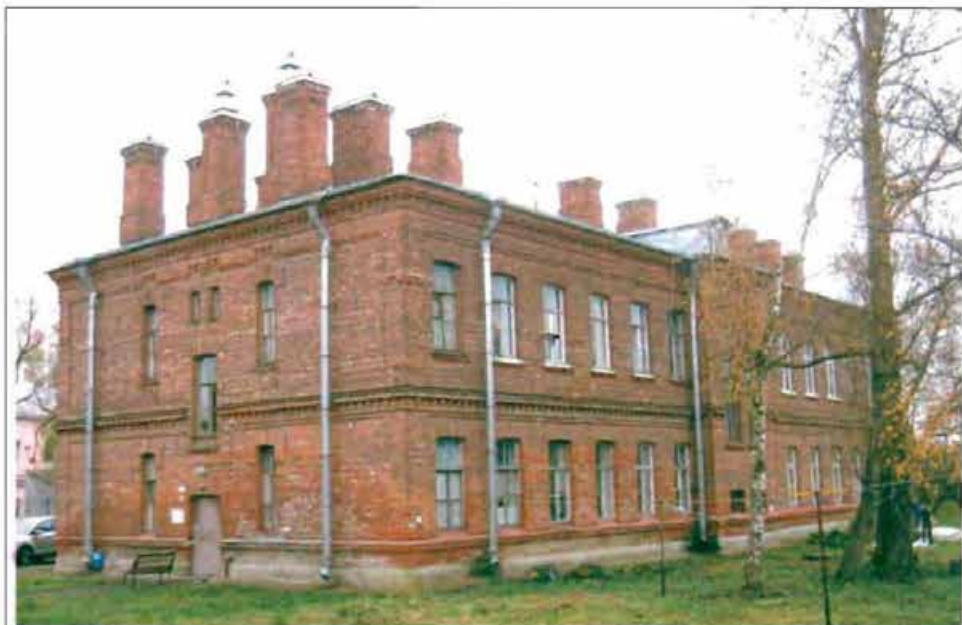
Фото 129. Западный, северный фасады. Общий вид.
