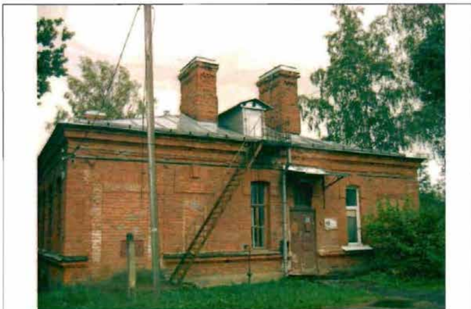
Фото189. Северный фасад. Общий вид.
