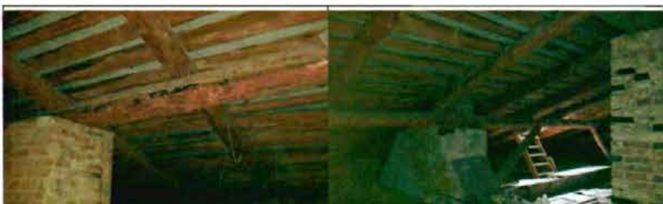
Фото 62. Конструкции крыши. Общий вид.
