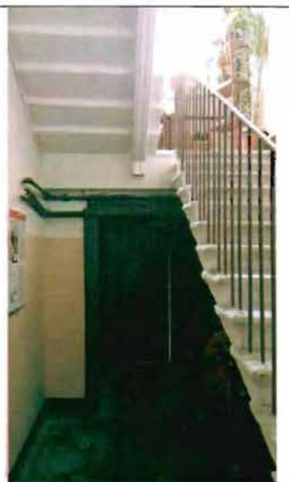
Фото 131. Лестница № 2 в северной части здания. Общий вид.
