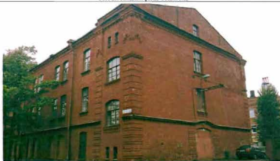
Фото 30. Северный фасад. Общий вид.
