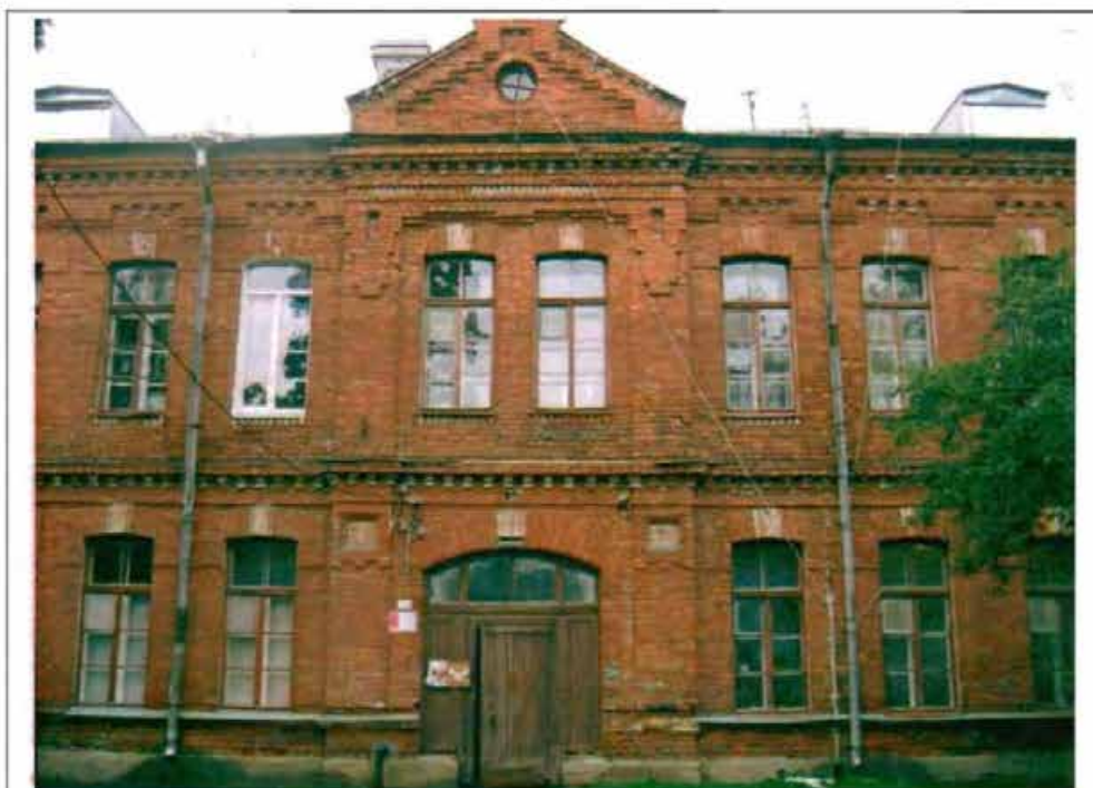
Фото 104. Восточный фасад. Центральная часть. Общий вид.
