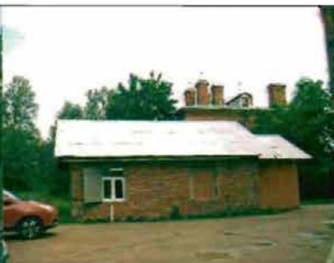
Фото 154. Южный фасад. Общий вид.
