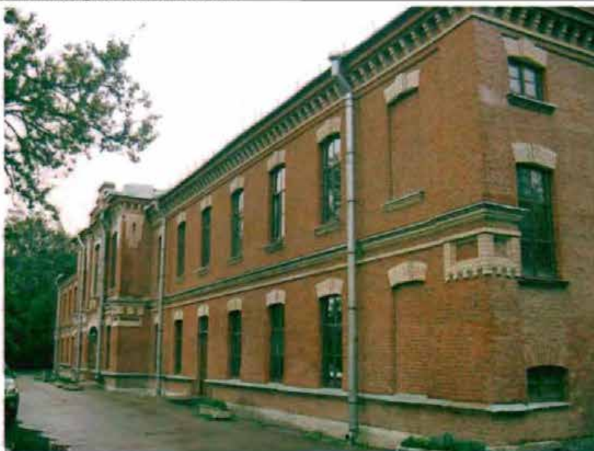
Фото 64. Северный фасад. Общий вид.
