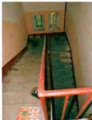
Фото 124. Лестница в южной части здания. Общий вид.
