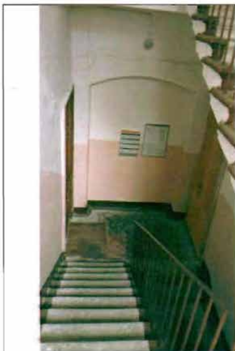
Фото 130. Лестница № 1 в южной части здания. Общий вид.
