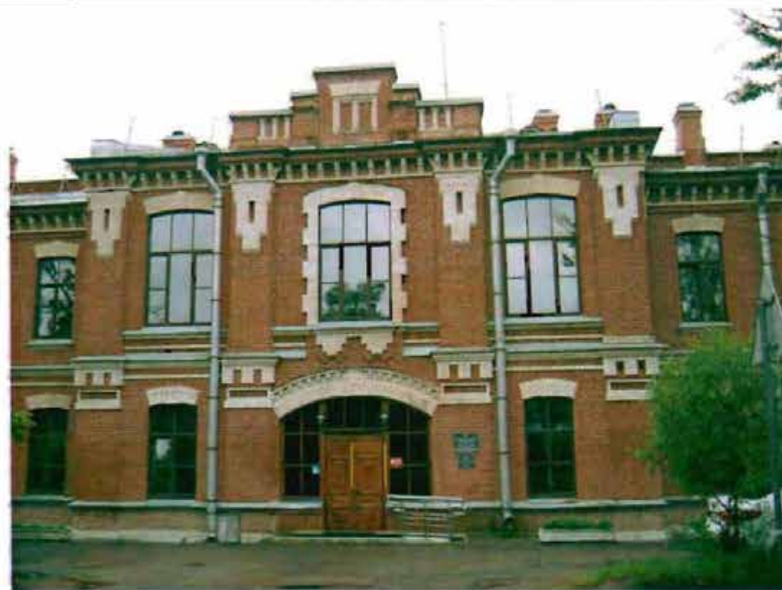
Фото 65. Северный фасад. Фрагмент центральной части фасада.
