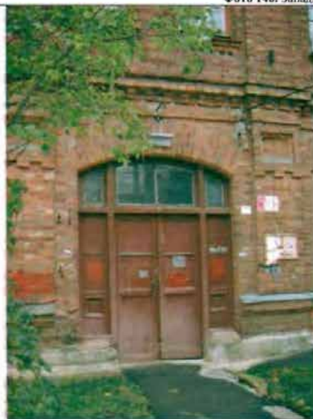
Фото 147. Дверной проем западного фасада. Общий вид.
