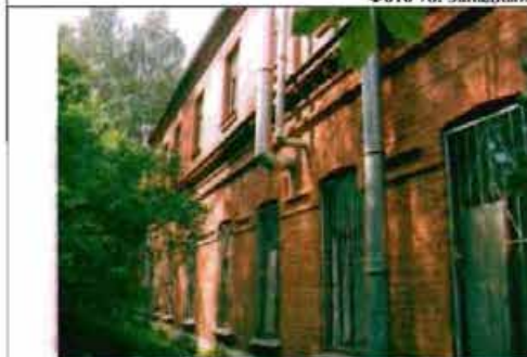
Фото 79. Восточный фасад. Общий вид.
