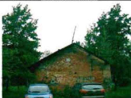
Фото 94. Восточный фасад. Общий вид.
