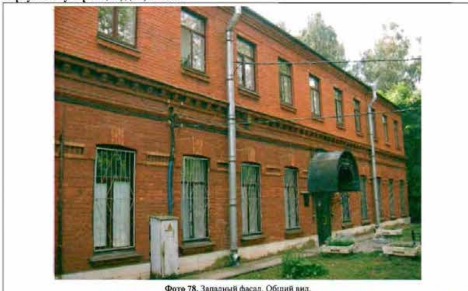
Фото 78. Западный фасад. Общий вид.
