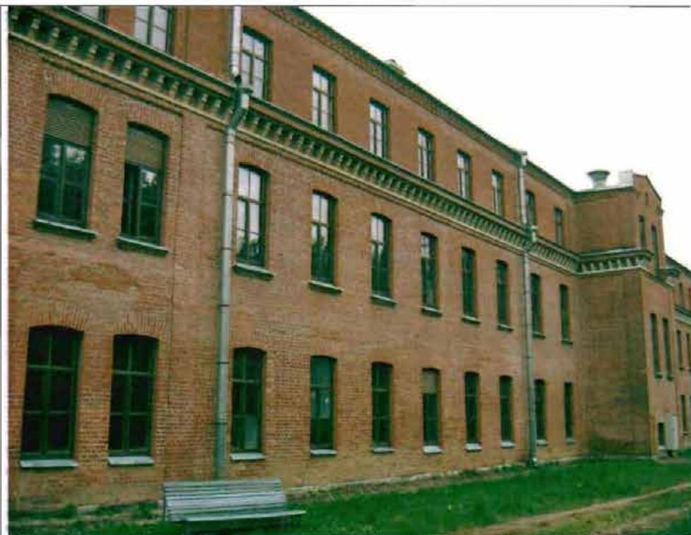
Фото 66. Южный фасад. Общий вид. 05.07.2016.
