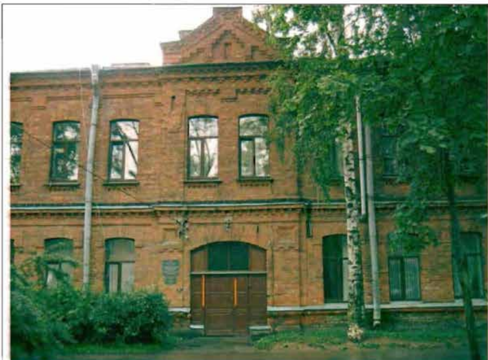
Фото 164. Восточный фасад. Фрагмент центральной части фасада.
