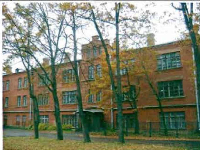
Фото 47. Восточный фасад. Общий вид.
