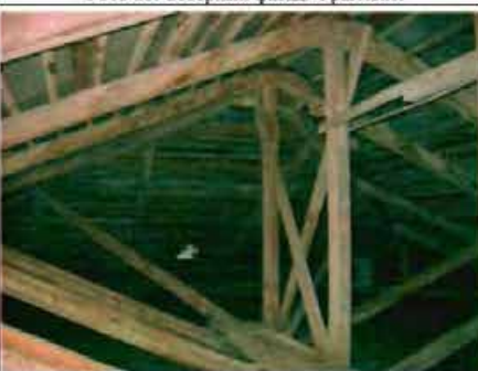
Фото 82. Конструкции крыши. Общий вид.
