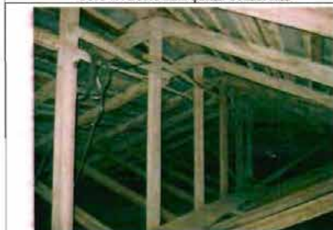
Фото 81. Конструкции крыши. Общий вид.
