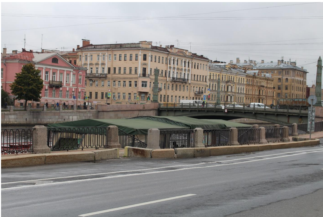
Фото 11. Вид на спуск № 9 объекта культурного наследия федерального значения «Набережные со спусками» с юго-запада.
