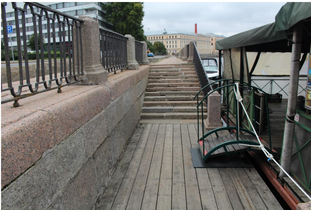
Фото 7. Вид на нижнюю площадку и юго-западный лестничный марш спуска № 9 объекта культурного наследия федерального значения «Набережные со спусками».
