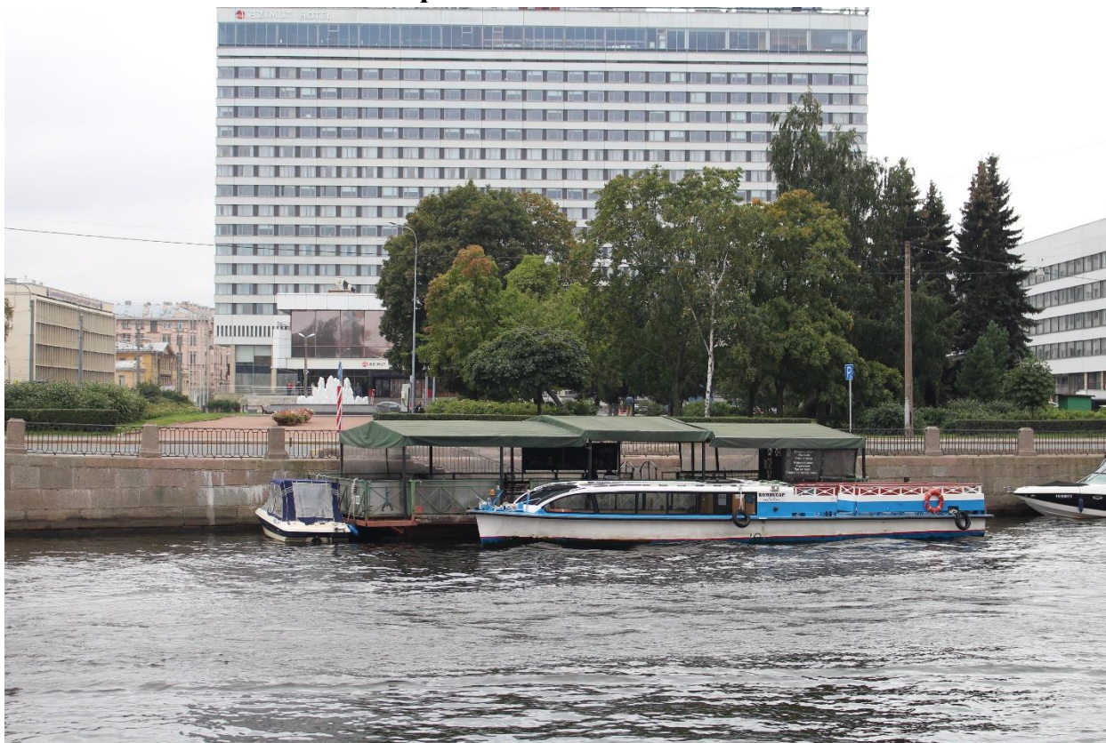
Фото 1. Вид на спуск № 9 объекта культурного наследия федерального значения «Набережные со спусками» на участке набережной реки Фонтанки «Египетский мост – Английский мост» с левого берега реки Фонтанки.
