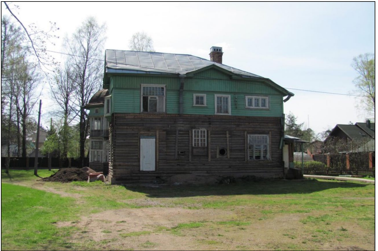
29. Вид со стороны ул. Граничной на северный фасад 2-х этажного деревянного здания, входящего в состав выявленного объекта культурного наследия «Комплекс построек усадьбы Польша. Дом (деревянный 2-этажный). Флигель (каменный 2-этажный). Флигель с водонапорной башней (каменный). Парк с прудом и деревьями ценных пород». Санкт-Петербург, пос. Ольгино, ул. Коммунаров, д. 7, литеры А, Б. Фотография 2017 г. ООО «Студия архитектуры и дизайна профессора Горюнова «Арт Деко».
