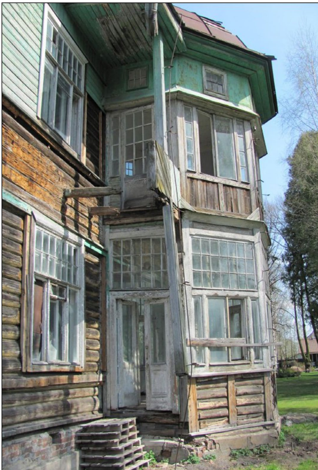
35. Шестигранная веранда. Южный фасад 2-х этажного деревянного здания. Фотография 2017 г. ООО «Студия архитектуры и дизайна профессора Горюнова «Арт Деко».
