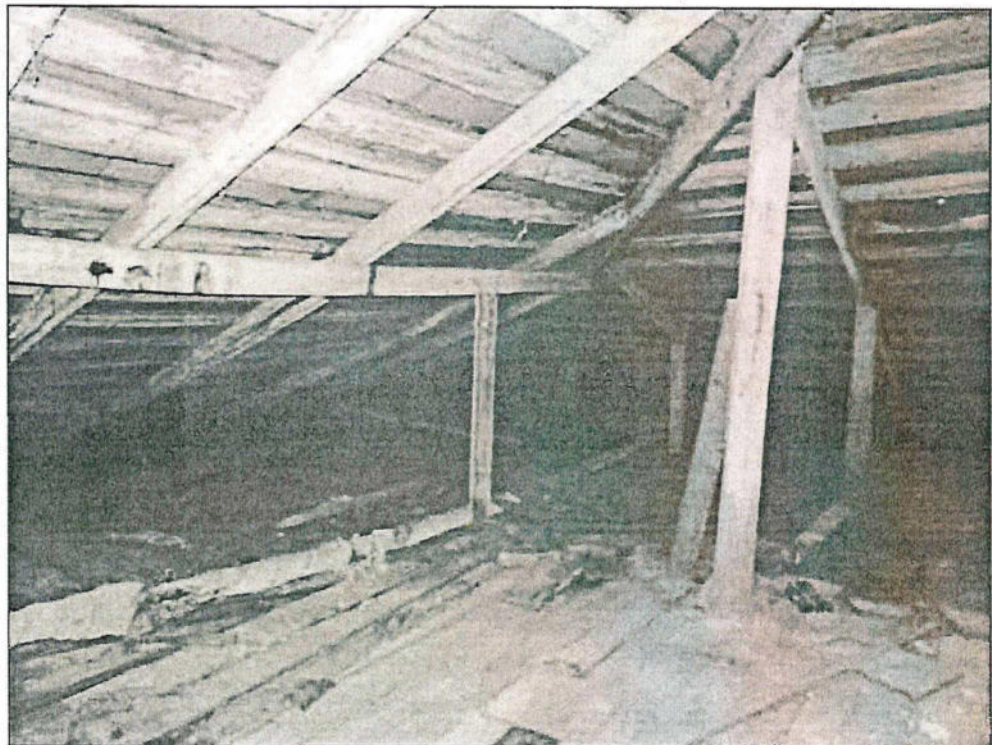
5. Стропильная система. Фрагмент.
