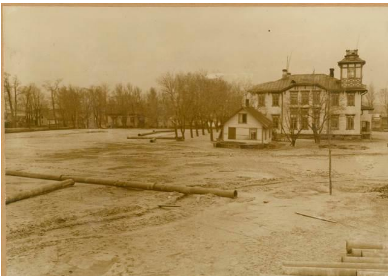
Дом Ропса и окружающий его участок в 1934 г. в момент передачи яхт-клубу. Территория яхт-клуба ещё не благоустроена.
