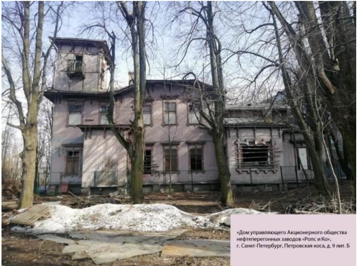
Западный фасад. Съёмка Старцевой Т.С., 22 апреля 2022 года
