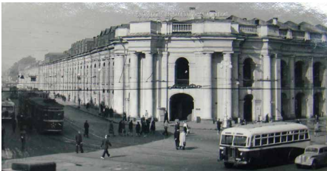
Илл. 22. Гостиный двор со стороны Невского пр. и Садовой ул. после реконструкции. 1953 г. Архив КГИОП.
