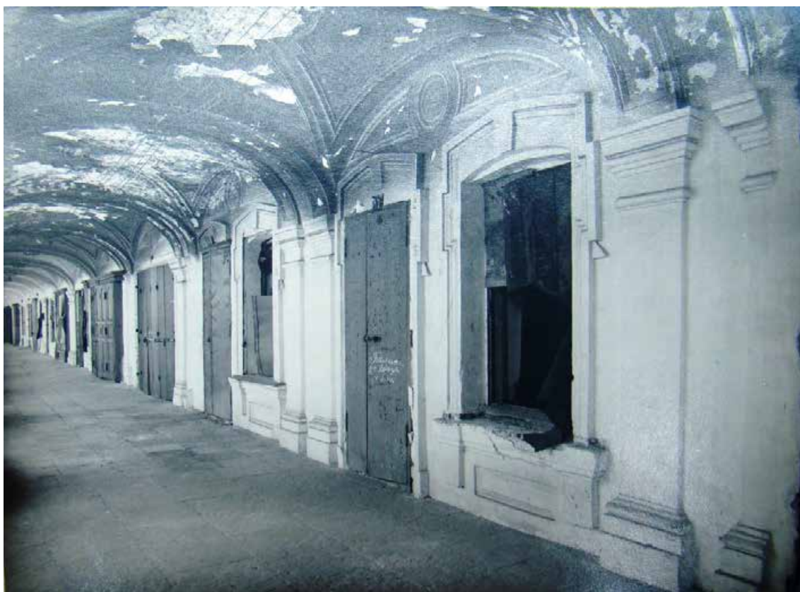
Илл. 21. Фрагмент галереи по Перинной линии. 1941 - 1943 г. Архив КГИОП.
