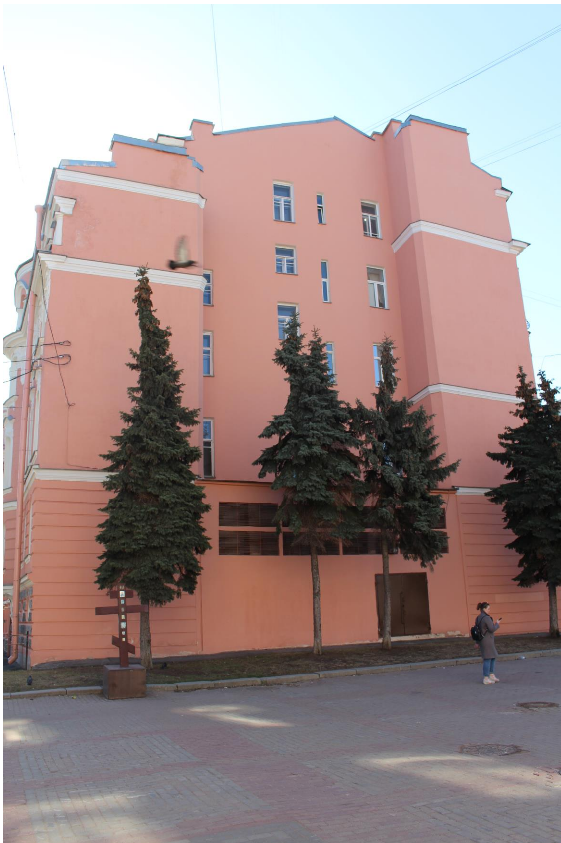
Фото 3. Вид на западный фасад.
