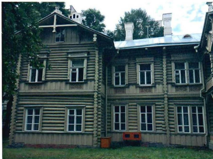
4. Фрагмент северо-восточного фасада.
