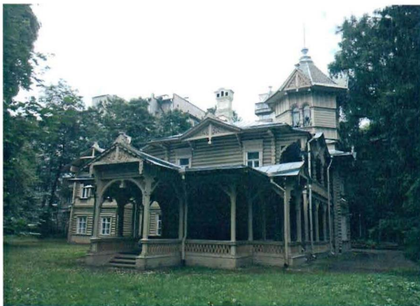
3. Общий вид северо-восточного фасада.
