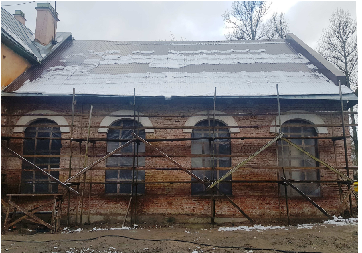
5. Главное здание (Подгорная ул.д.16, лит.А). Одноэтажная часть здания. Вид с востока.
