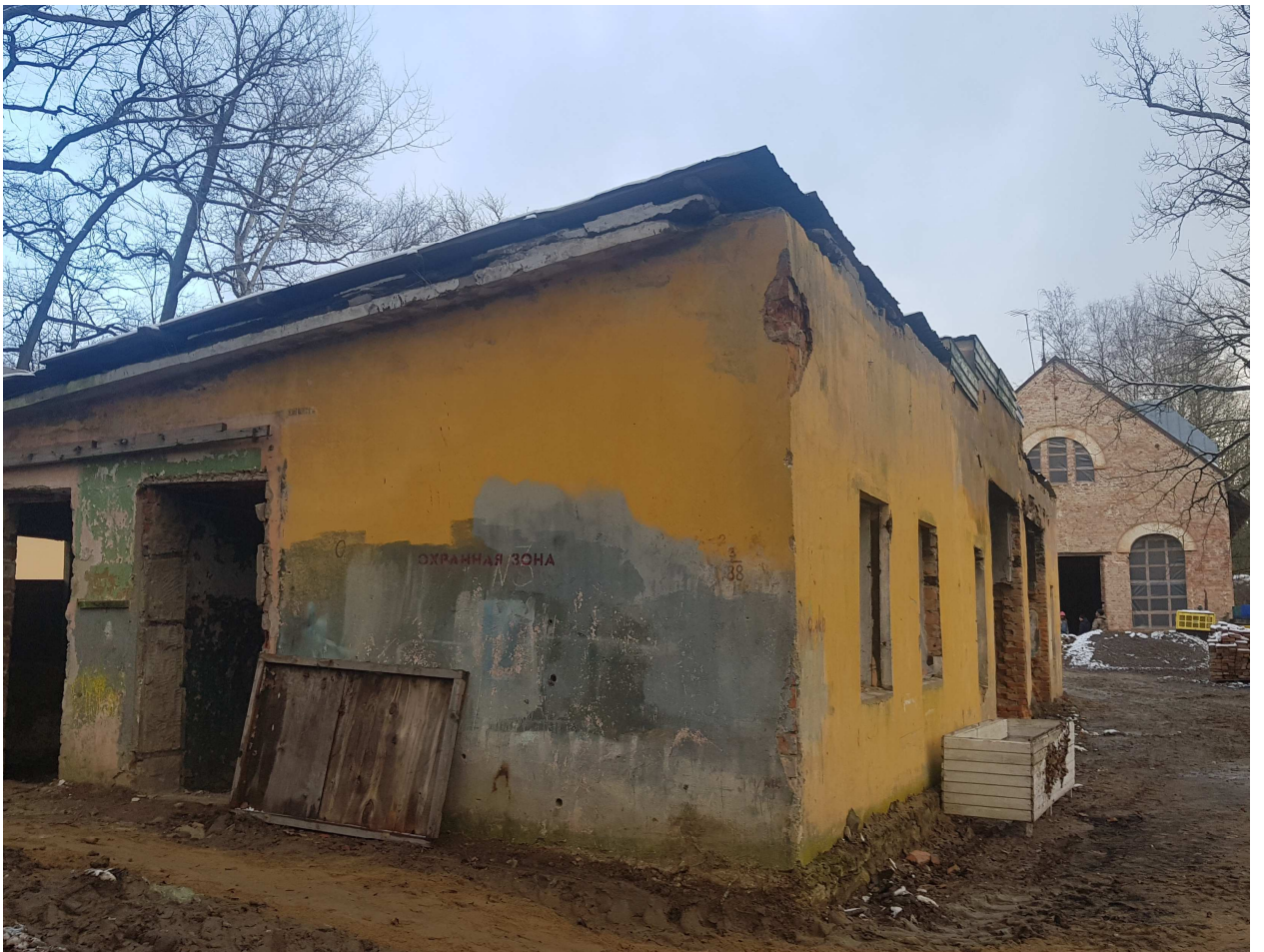
9. Службы. Здание 2 (Подгорная ул.д.16, лит.Б). Вид северного и западного фасадов.
