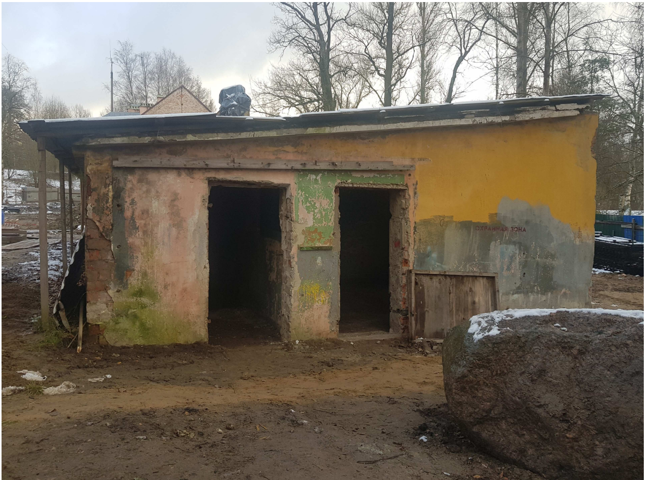
13. Службы. Здание 2 (Подгорная ул.д.16, лит.Б). Северный торцевой фасад.
