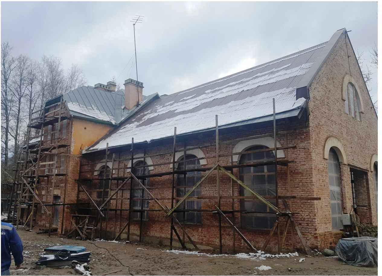
2. Главное здание (Подгорная ул.д.16, лит.А). Вид продольного восточного фасада.
