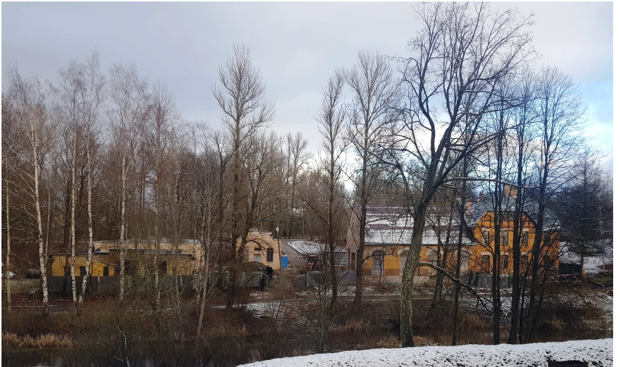
8. Вид на выявленный объект культурного наследия «Павловская электрическая станция (с 2 службами и оградой)» с запада (с левого берега р. Славянки).
