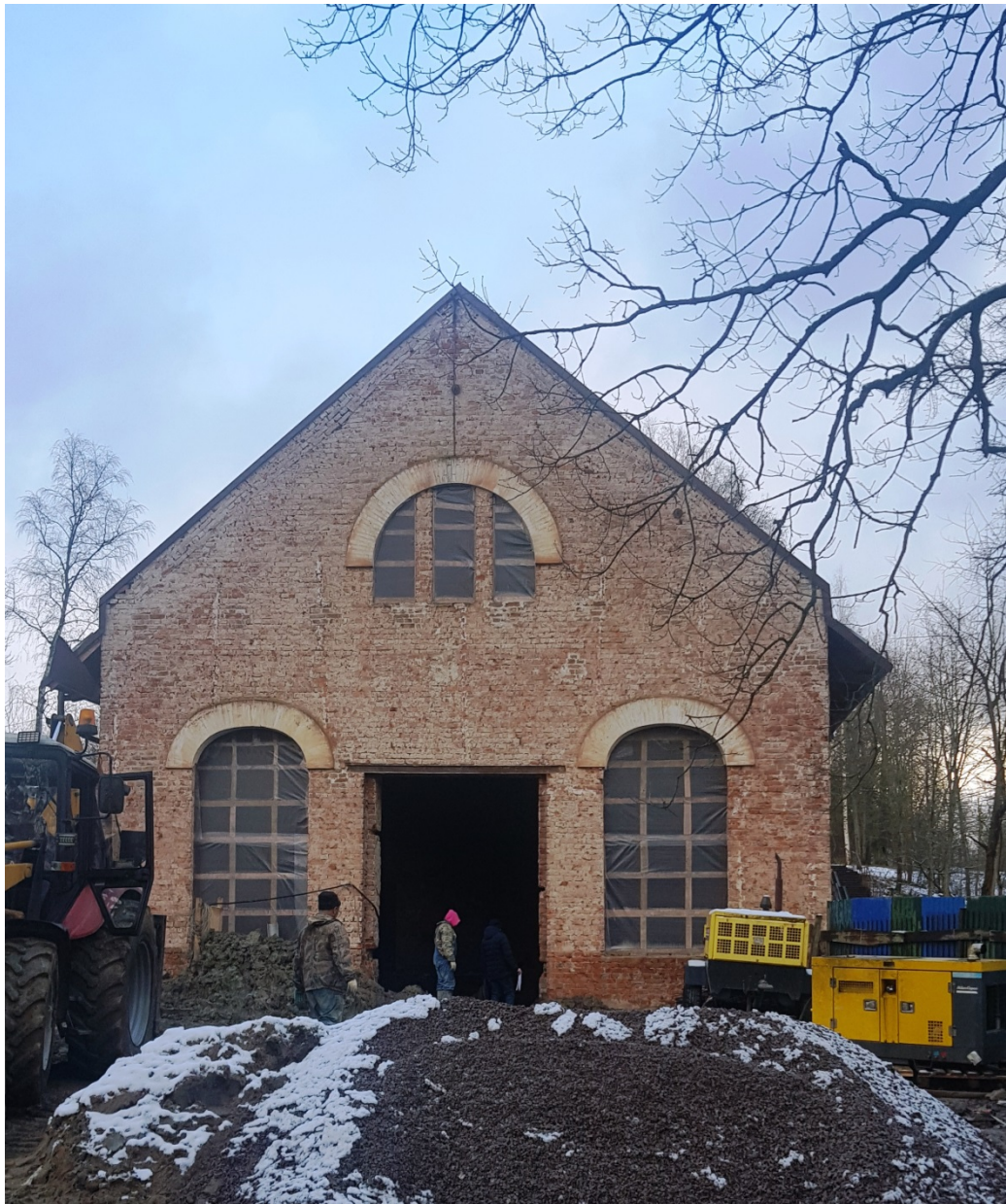
3. Главное здание (Подгорная ул.д.16, лит.А). Общий вид с севера. Торцевой фасад.
