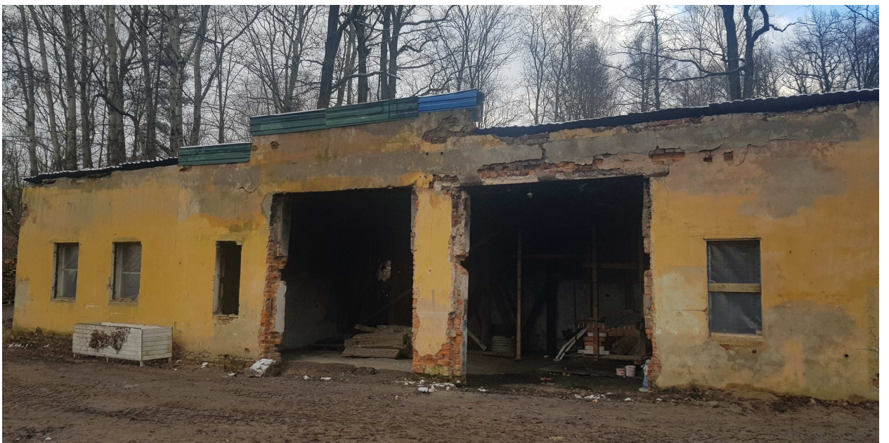
11. Службы. Здание 2 (Подгорная ул.д.16, лит.Б). Западнй продольный фасад.
