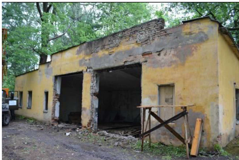
19. Службы. Здание 2 (Надгорная ул., 16, лит. Б). Западный фасад. Фото сентябрь 2018 г.
