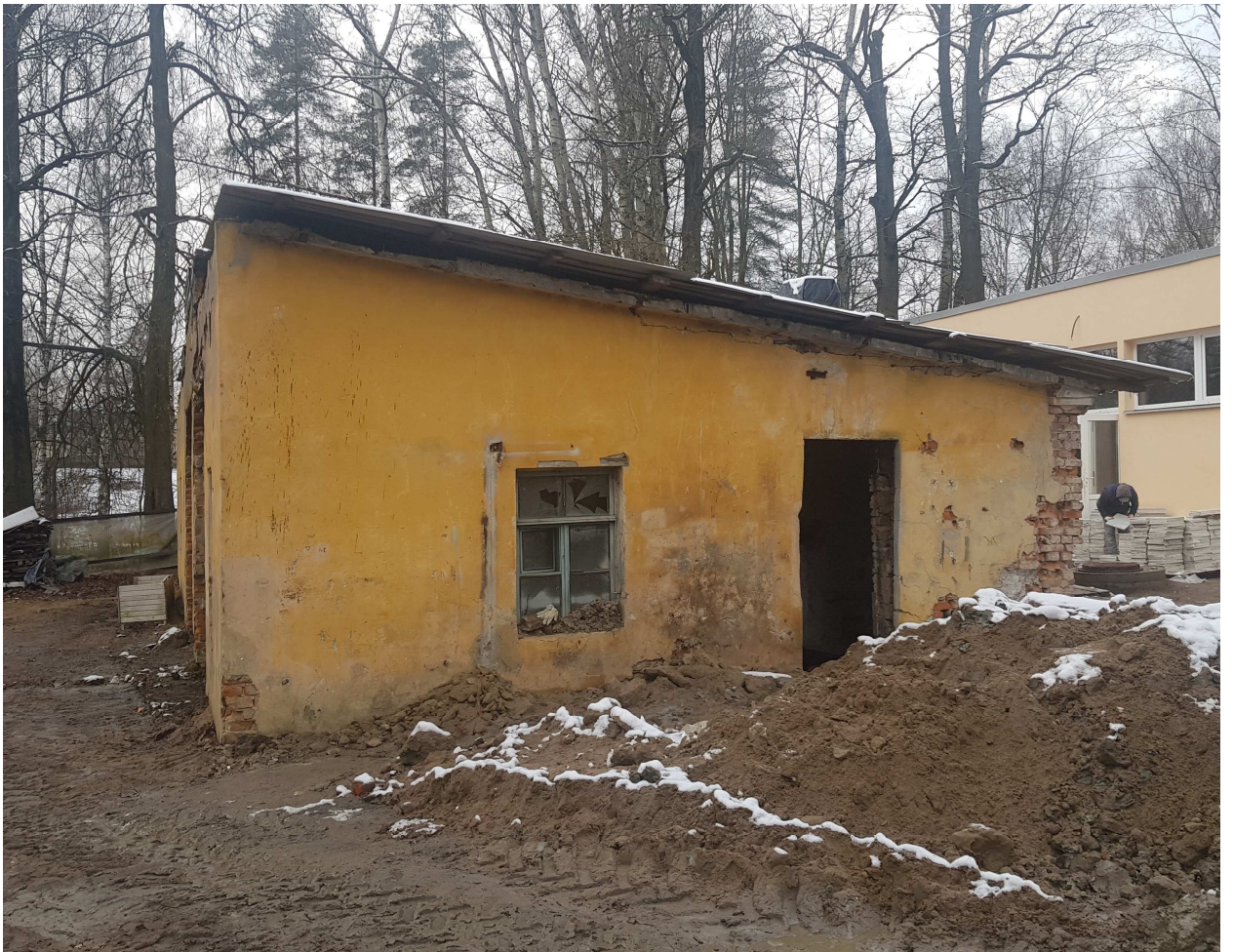
10. Службы. Здание 2 (Подгорная ул.д.16, лит.Б). Южный торцевой фасад.
