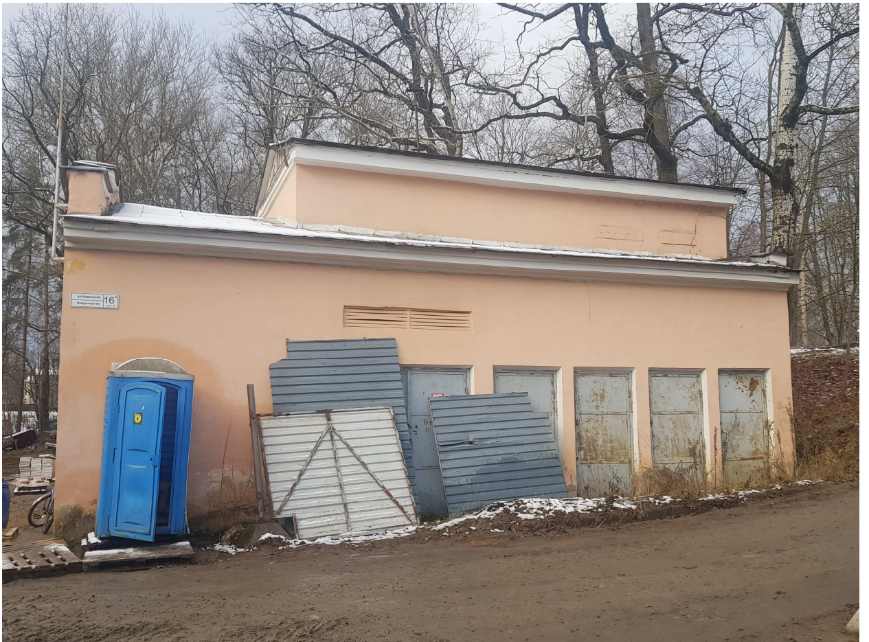
15. Службы. Здание 1 (Подгорная ул.д.16а, лит.А). Боковой фасад.
