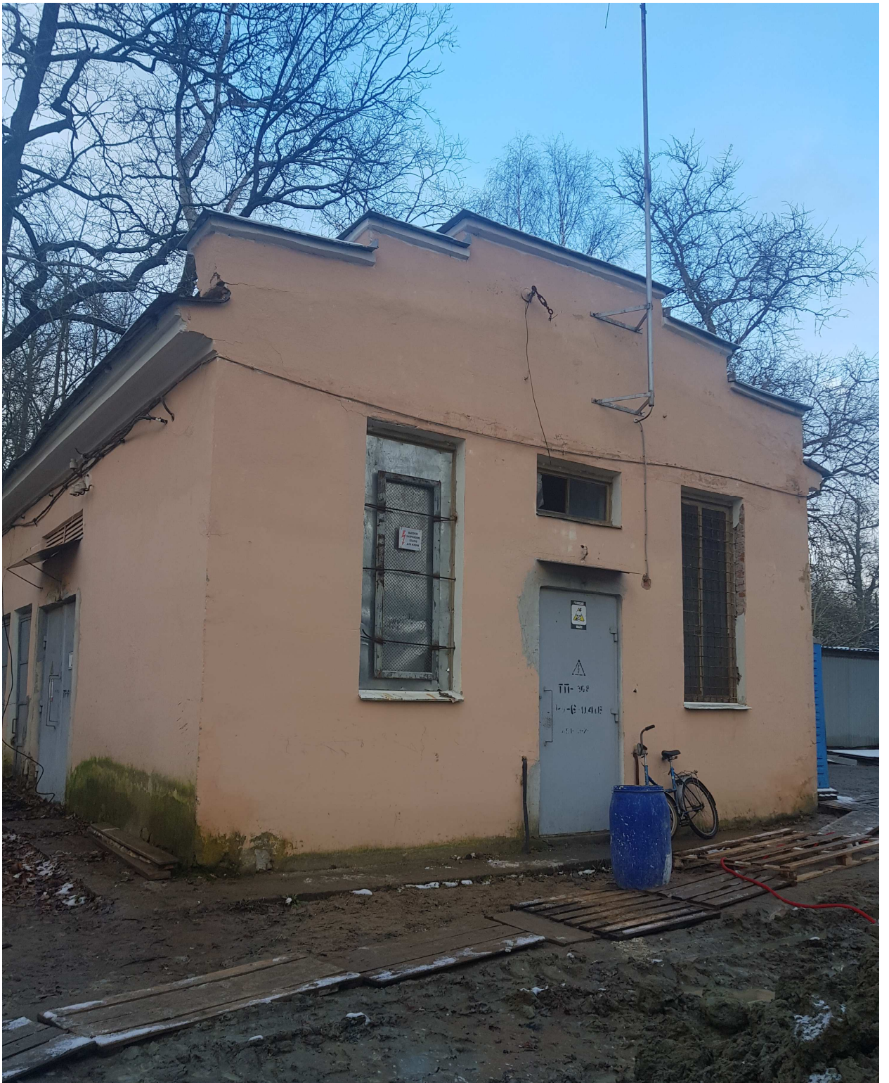
14. Службы. Здание 1 (Подгорная ул.д.16а, лит.А). Общий вид здания с востока.
