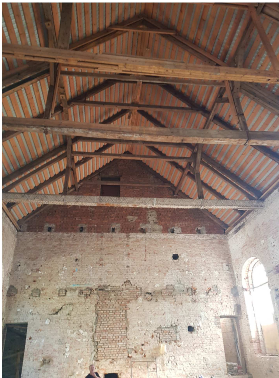
6. Главное здание (Подгорная ул.д.16, лит.А). Современное состояние помещений.
