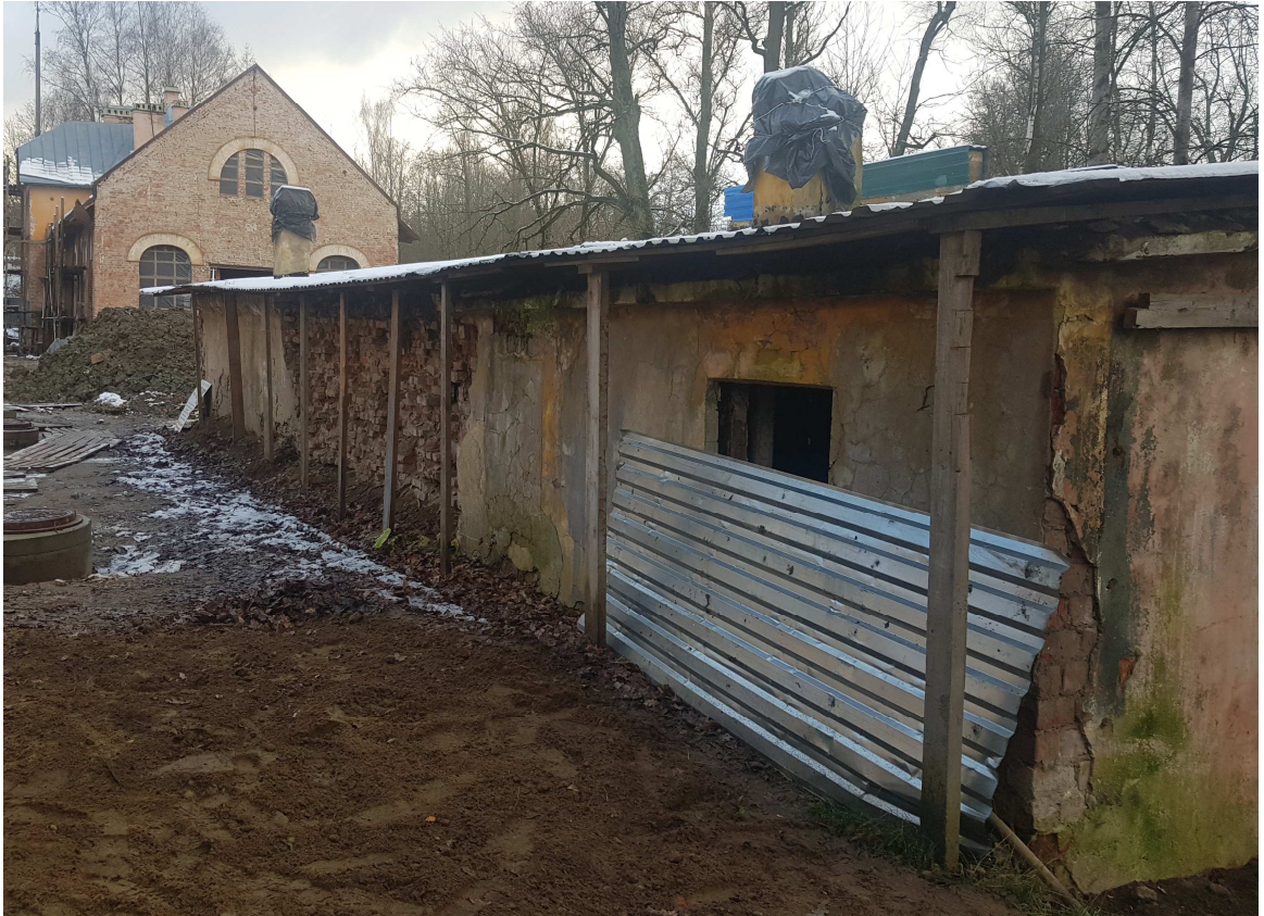
12. Службы. Здание 2 (Подгорная ул.д.16, лит.Б). Восточный продольный фасад.
