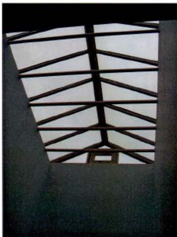
22. Зенитный фонарь над пространством лестницы в южной части главного здания.
