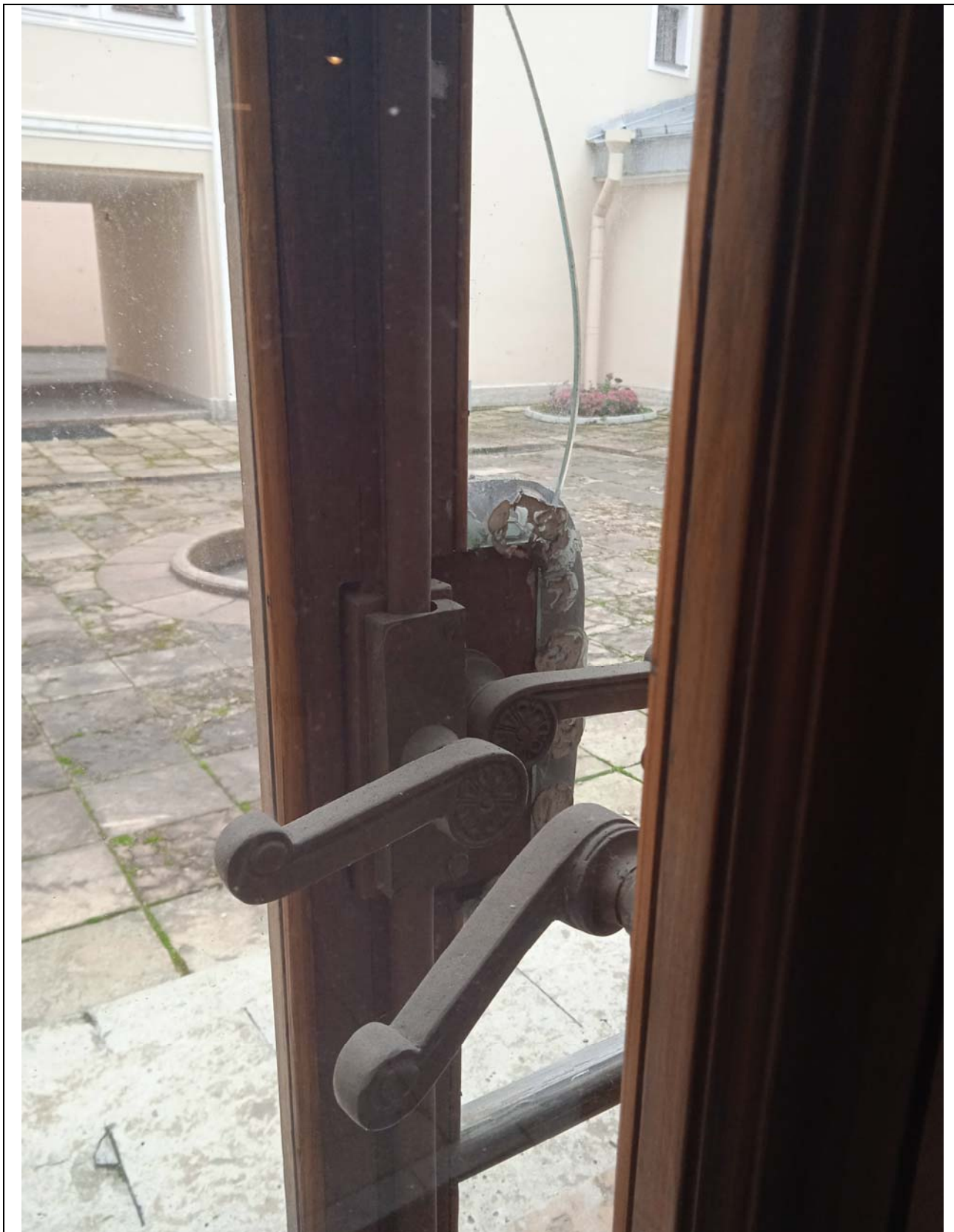
9. Посольство Германии. Вестибюль. Историческая фурнитура дверного заполнения.
