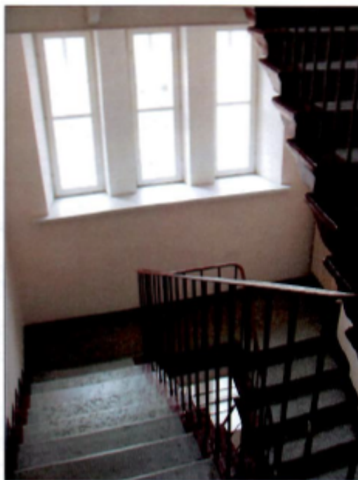
23. Лестница в северной части главного здания. Второй этаж.
