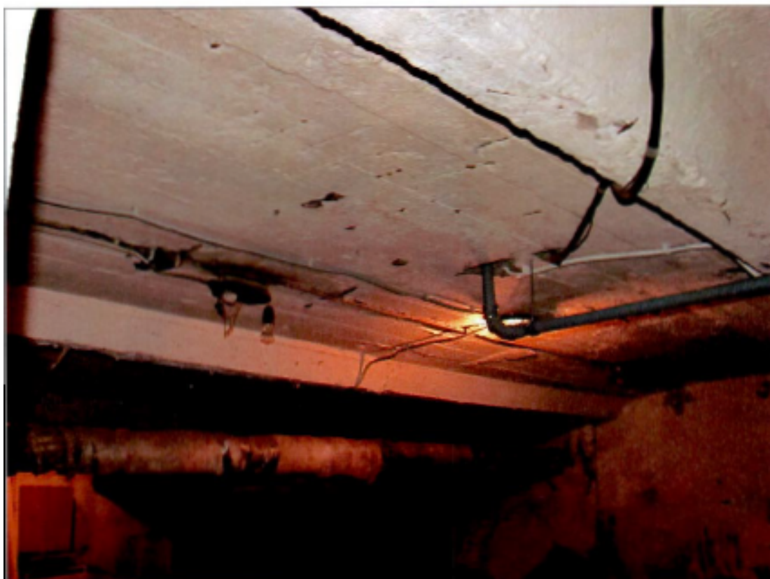
15. «Посольство Германии». Подвал. Перекрытие.
