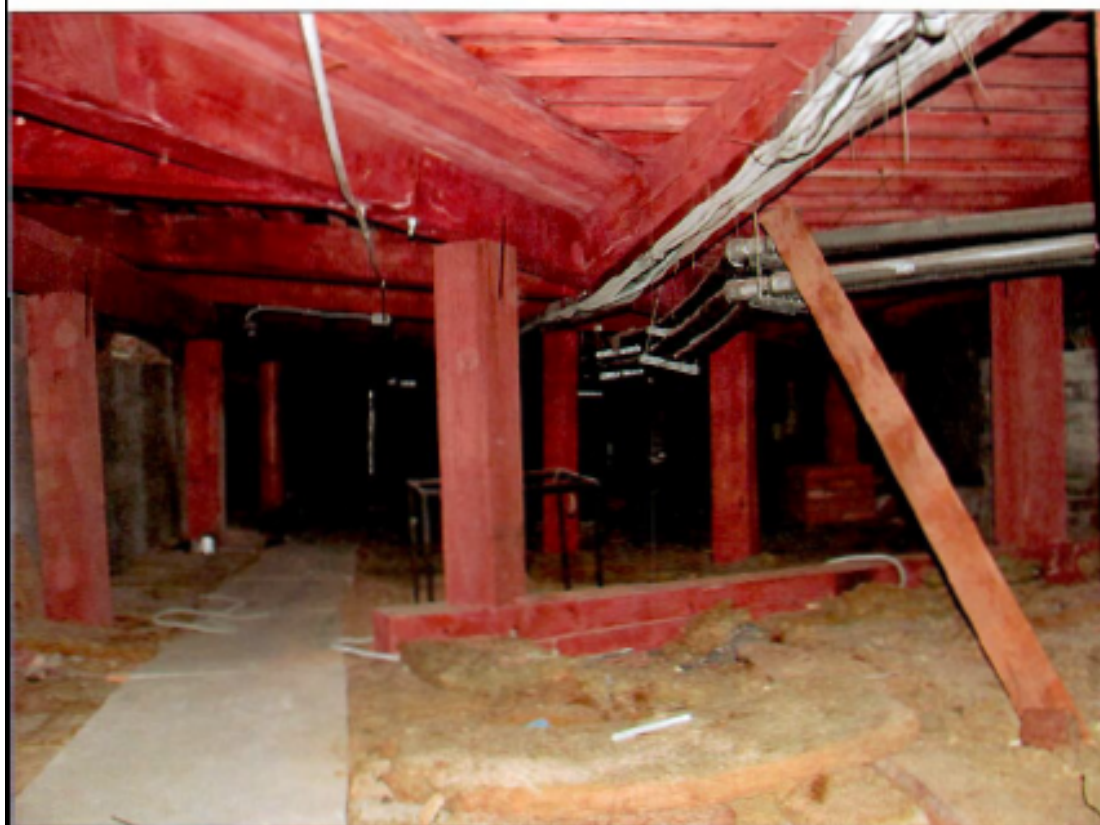
16. «Посольство Германии». Чердак. Стропильная система.
