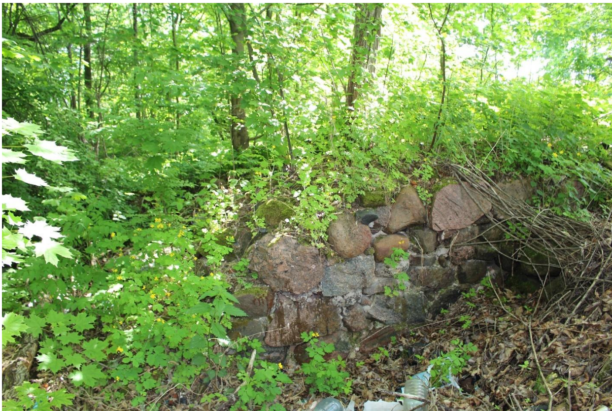
Фото 23. Вид на руины здания и локально сохранившиеся фрагменты бутового фундамента.
