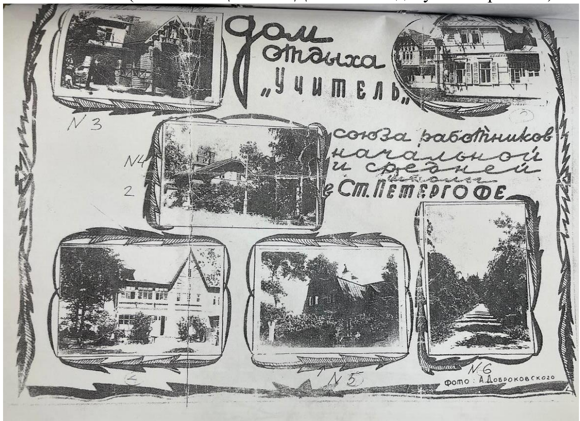
Илл. 12. Дом отдыха «Учитель» союза работников начальной и средней школы в Ст. Петергофе. 1940-е – 1950-е гг. (источник: архив КГИОП 203Г-25).
