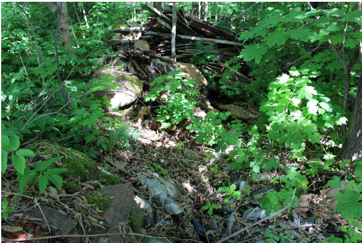
Фото 25. Вид на руины здания и локально сохранившиеся фрагменты бутового фундамента.
