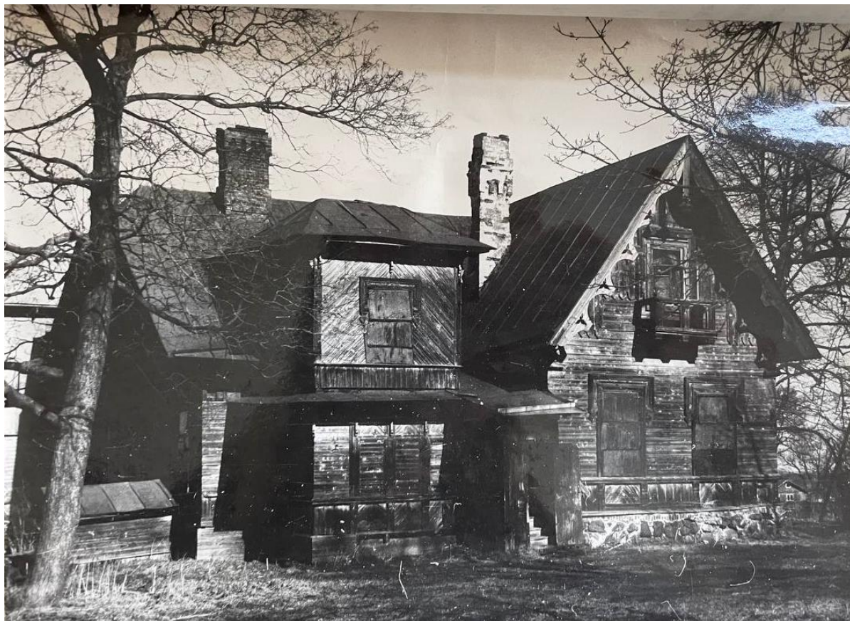
Илл. 19. Корпус 5 («коричневая» дача). Вид с юго-запада. 1990 г. (источник: архив КГИОП п. 219-4).
