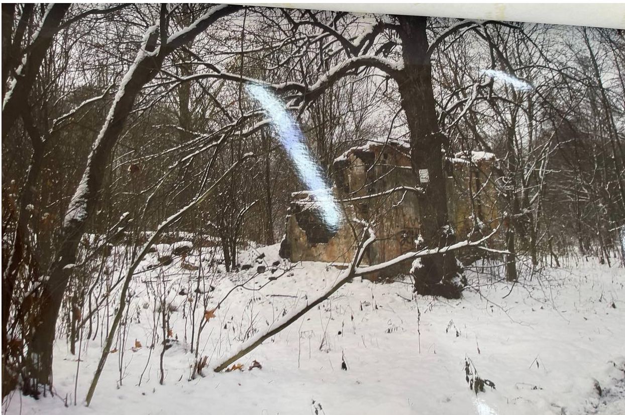
Илл. 25. Руины восточной части северной пристройки к зданию (источник: архив КГИОП 203Г-25).
