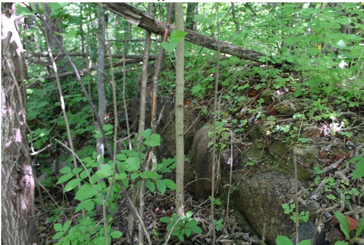
Фото 24. Вид на руины здания и локально сохранившиеся фрагменты бутового фундамента.
