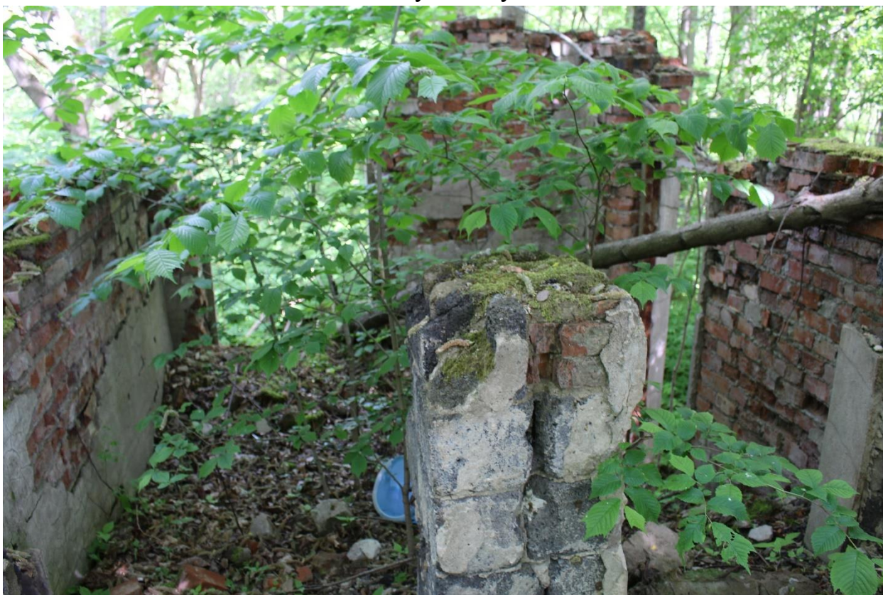
Фото 12. Вид на руины восточной части поздней (1964 г.) северной пристройки к основному объему здания.
