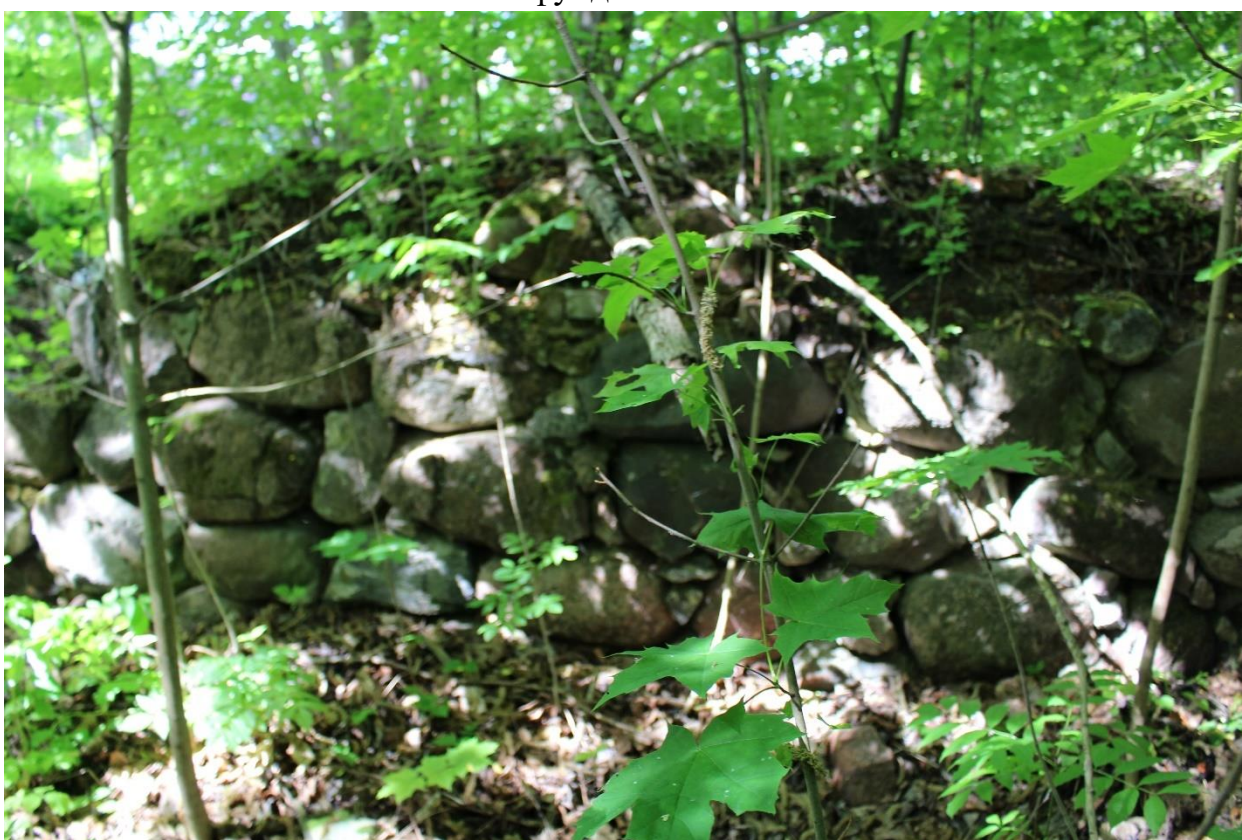
Фото 22. Вид на руины здания и локально сохранившиеся фрагменты бутового фундамента.
