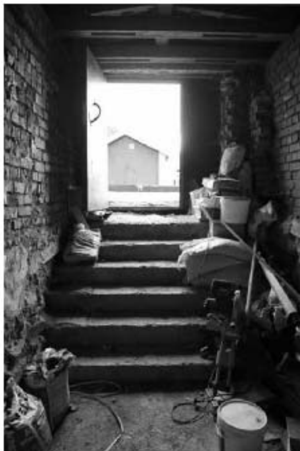
Фото п.26. Подвал, лестница, помещение 2Н (8)
