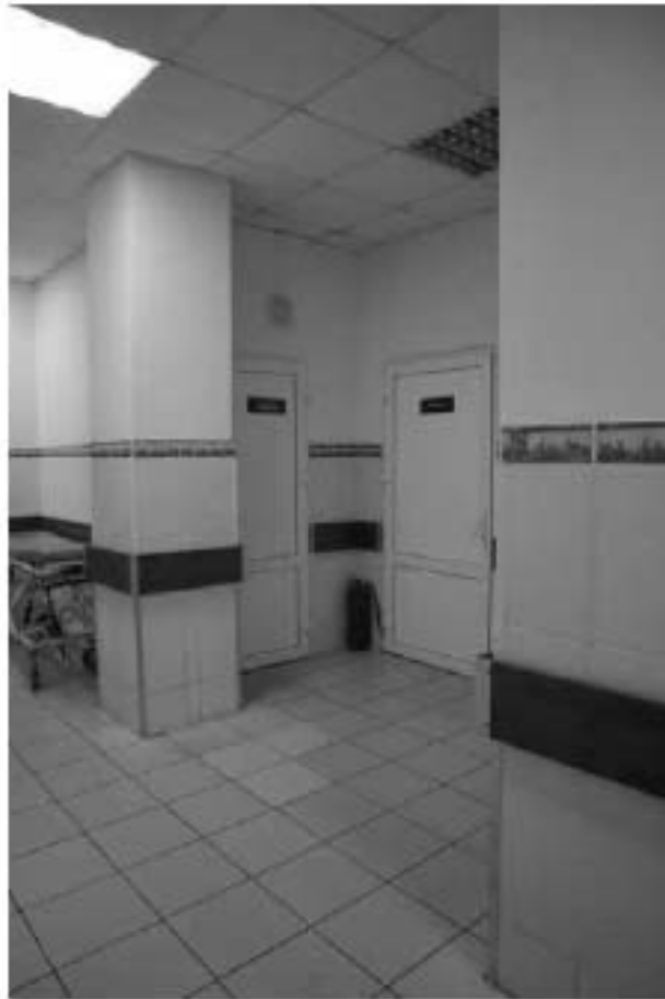
Фото 1.69. 1 этаж, коридор, помещение 4Н (4).
