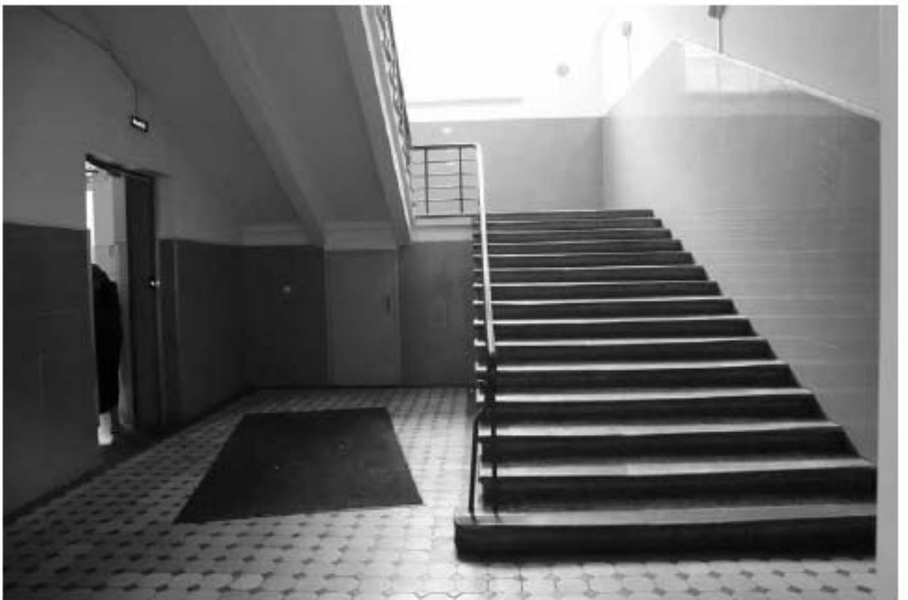
Фото 1.58. 1 этаж, лестница, помещение 2 ЛК (3).
