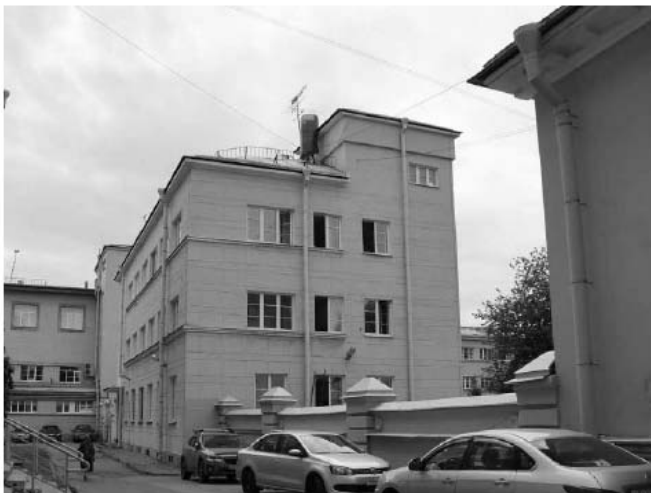
Фото 4. Боковой фасад, вид с севера.
