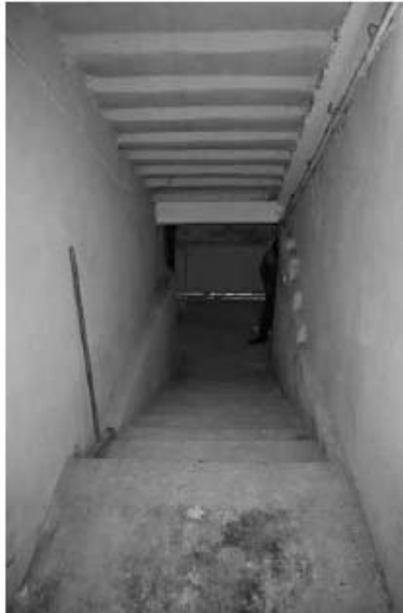
Фото п.1. Подвал, лестница, помещение 5ЛК (1).
