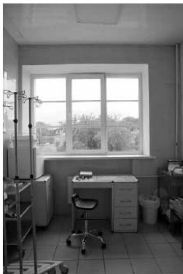
Фото 2.18. 2 этаж, помещение 11Н (137).
