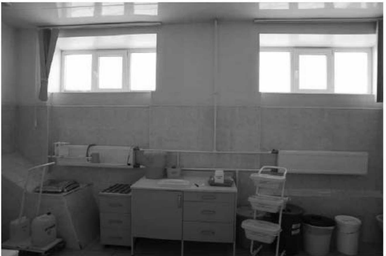
Фото 3.6. 3 этаж, помещение 12Н (93).
