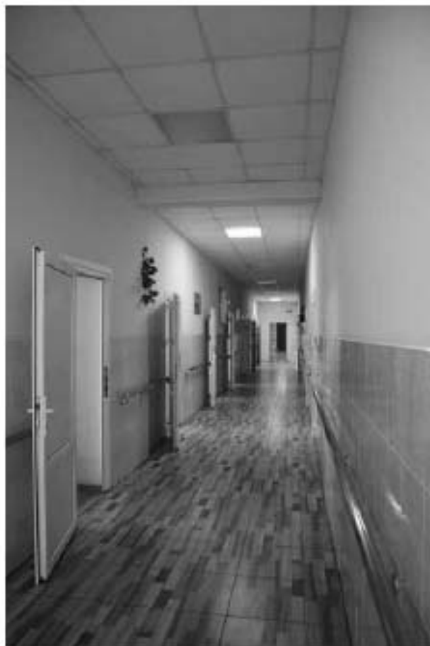
Фото 3.84. 3 этаж, коридор, помещение 12Н (42).
