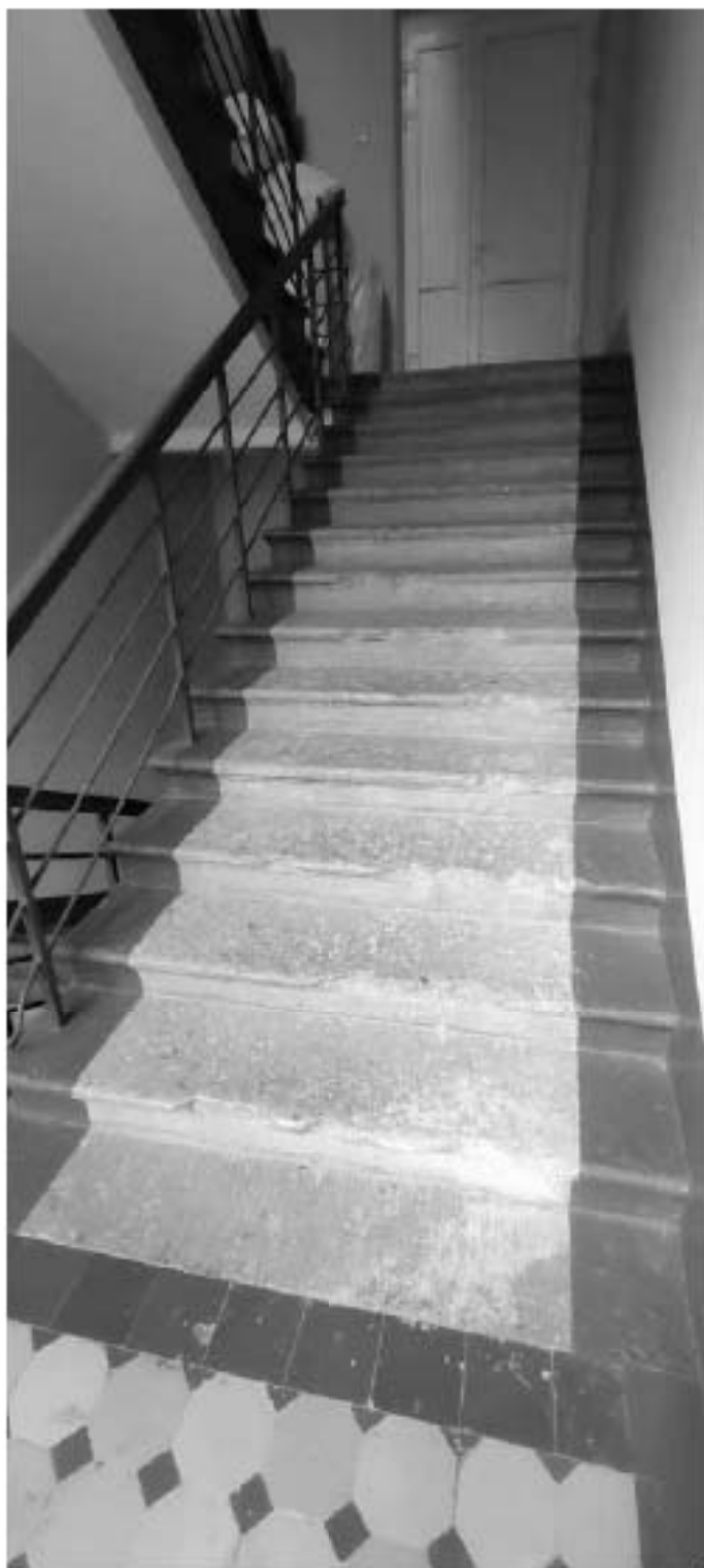
Фото 2.106. 2 этаж, лестница, помещение 4ЛК (6).
