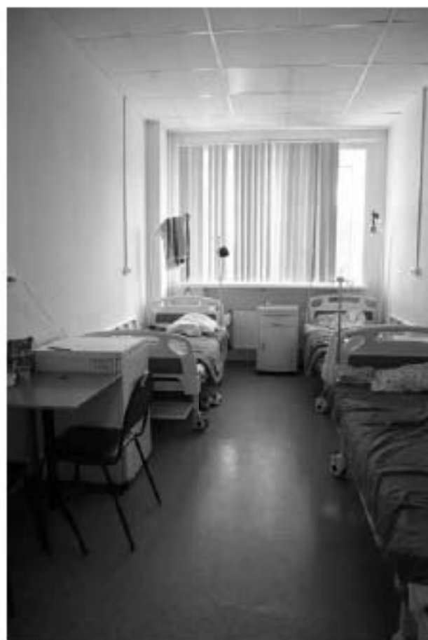
Фото 3.43. 3 этаж, помещение 12Н (62).
