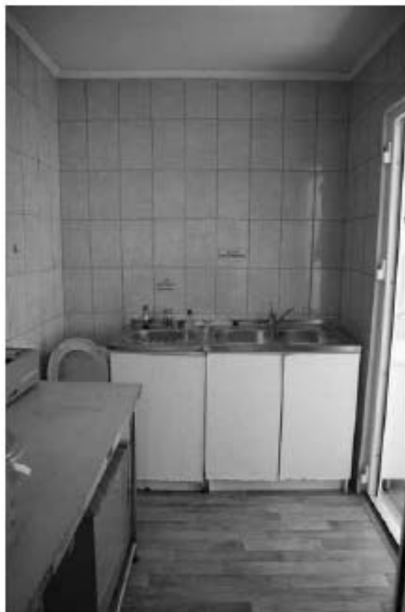
Фото 4.4. 4 этаж, помещение 14Н (2).
