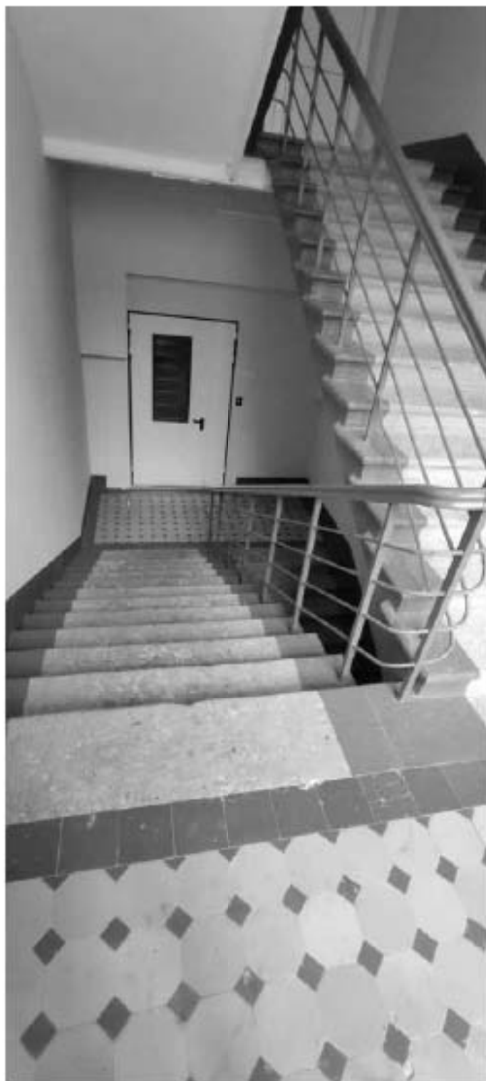
Фото 2.107. 2 этаж, лестница, помещение 4ЛК (6).
