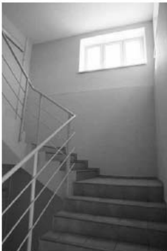
Фото 3.11. 3 этаж, лестница, помещение 1Н (82).
