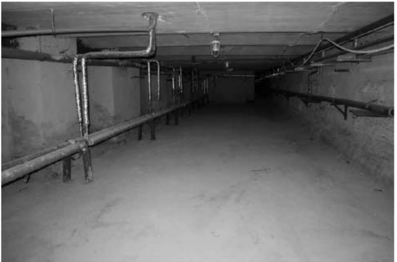
Фото п.2. Подвал, помещение 1Н (1).
