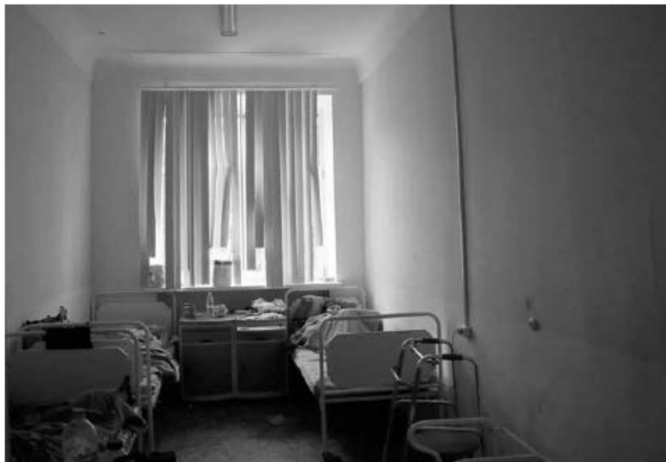
Фото 1.9. 1 этаж, помещение 4Н (73).
