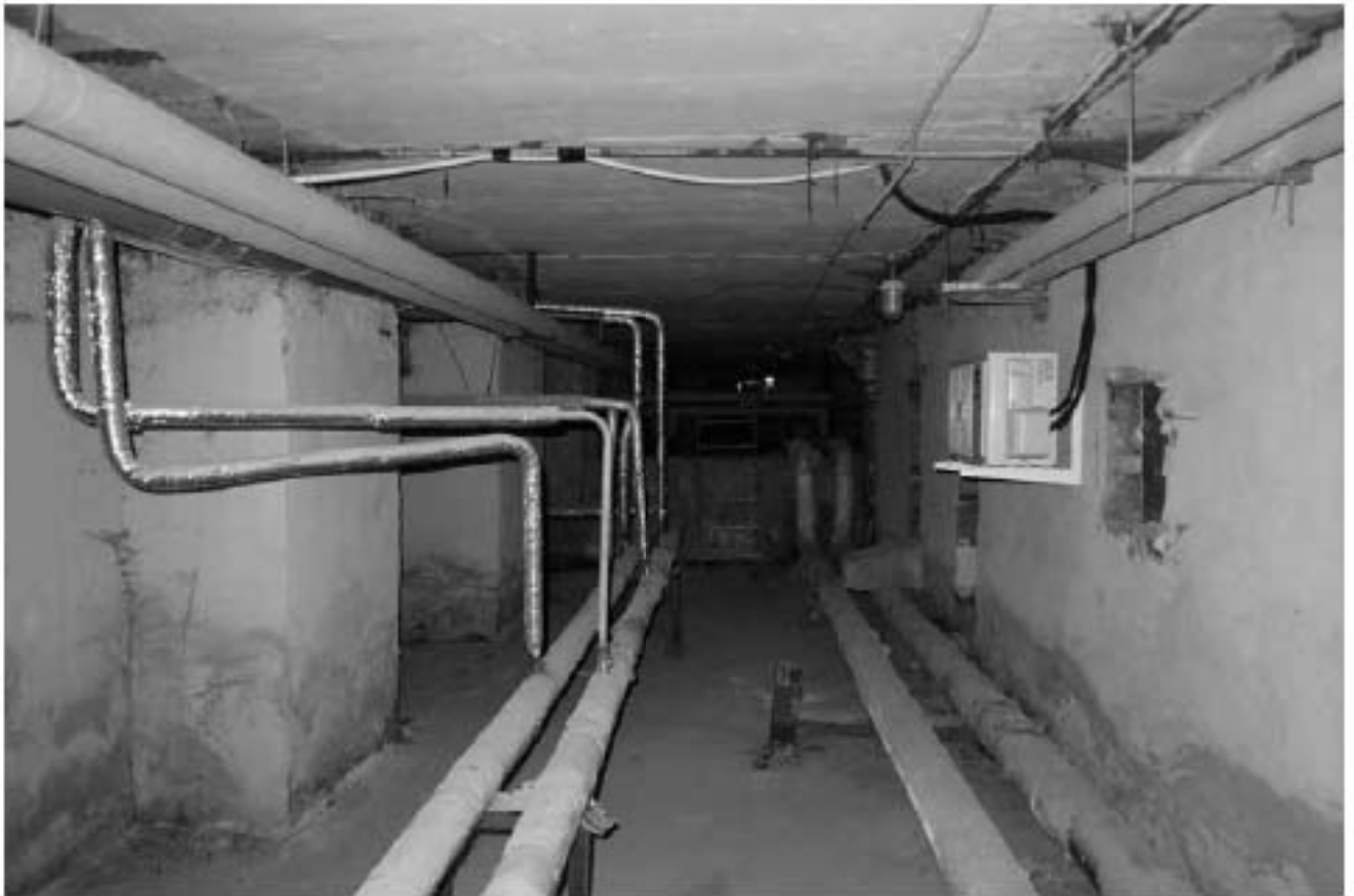
Фото п.31. Подвал, помещение 2Н (1).
