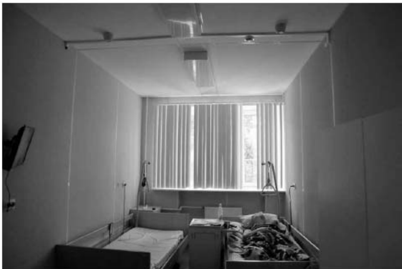
Фото 2.28. 2 этаж, помещение 11Н (85).
