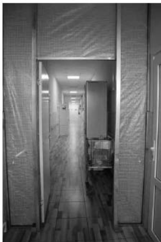
Фото 3.76. 3 этаж, коридор, помещение 12Н (1).
