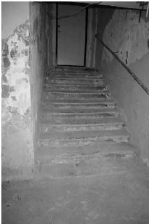
Фото п.15. Подвал, лестница, помещение 4ЛК (1).
