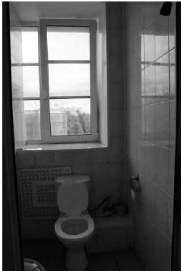
Фото 3.52. 3 этаж, помещение 12Н (31).
