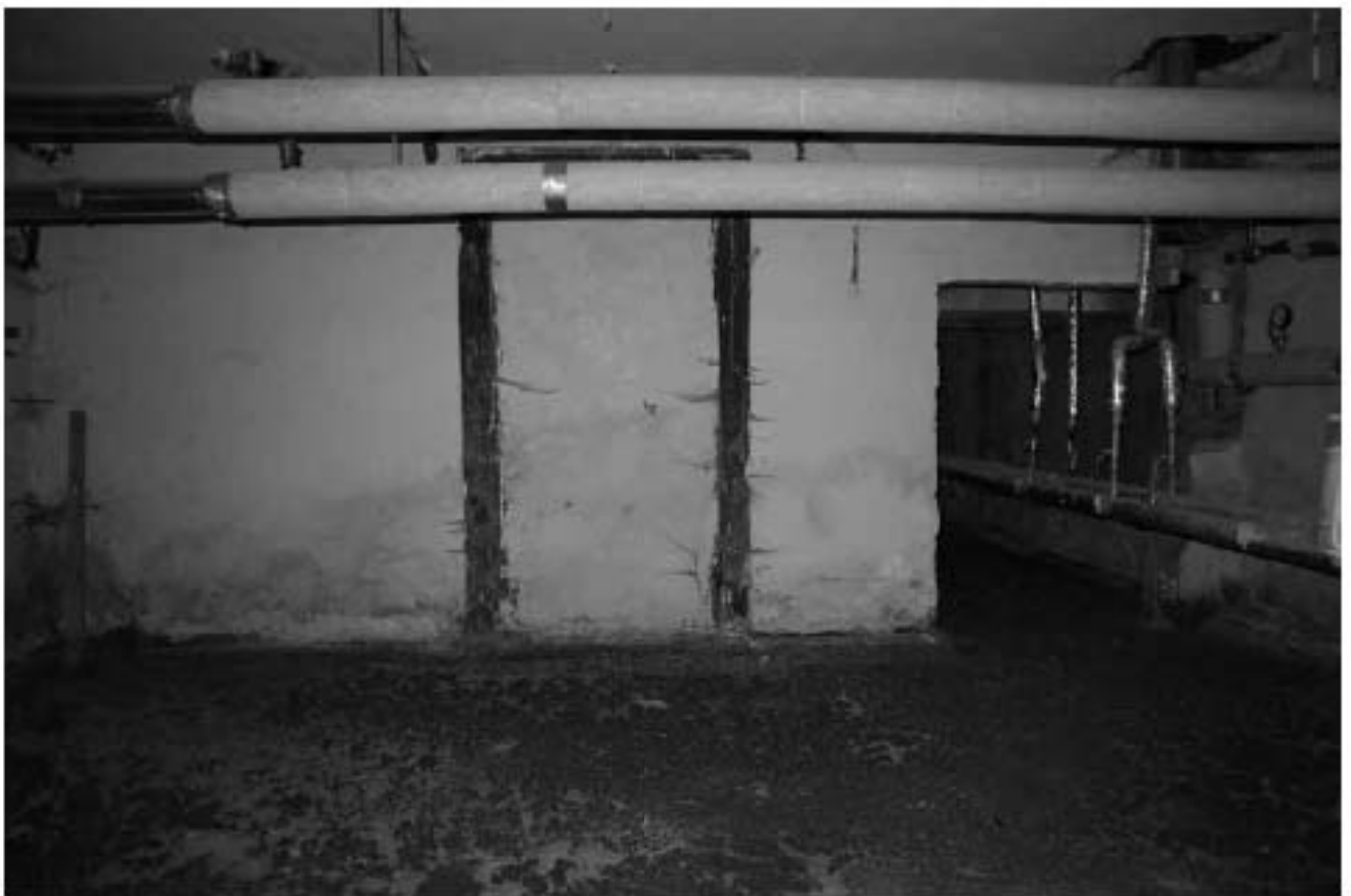
Фото п.18. Подвал, помещение 1Н (30).
