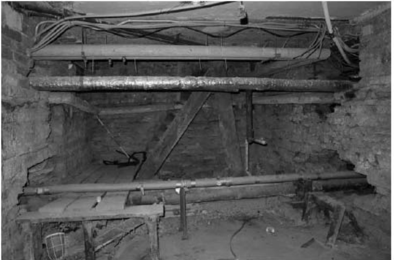
Фото п.33. Подвал, помещение 2Н (1).
