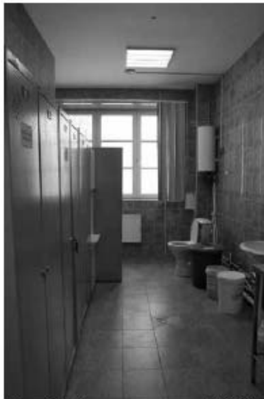
Фото 3.9. 3 этаж, помещение 1Н (84).
