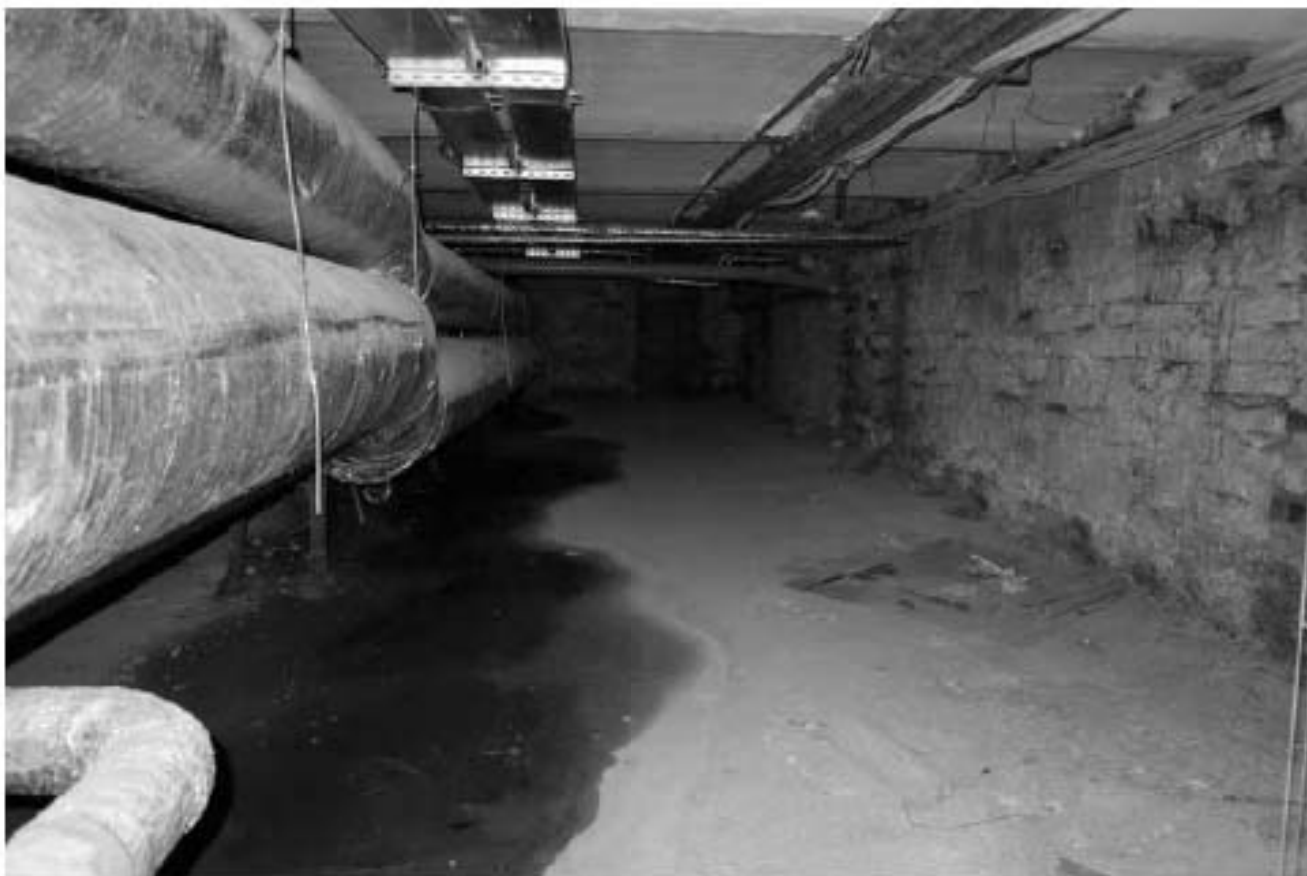
Фото п.41. Подвал, помещение 1Н (43).
