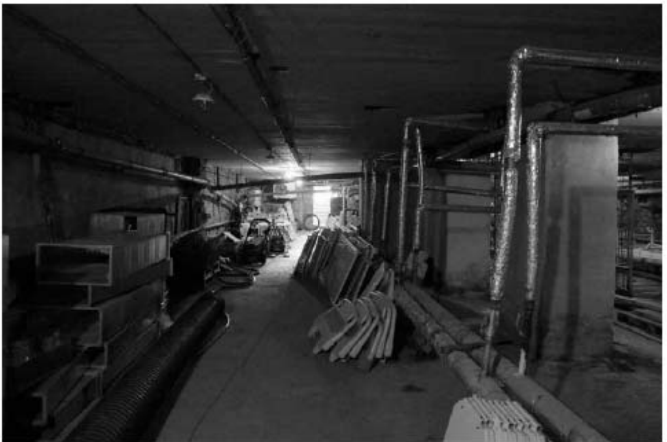
Фото п.30. Подвал, помещение 2Н (1).
