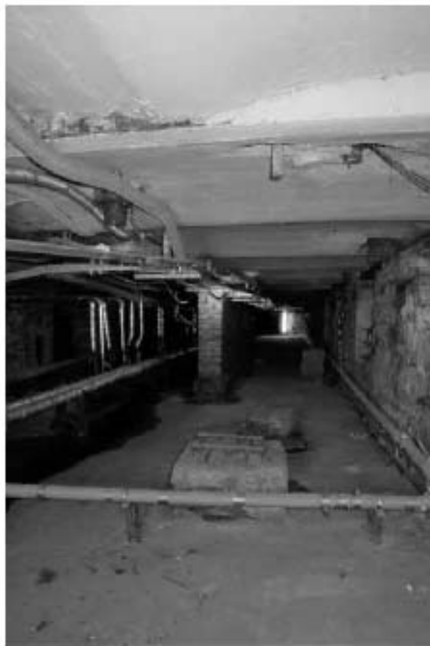
Фото п.36. Подвал, помещение 2Н (53).
