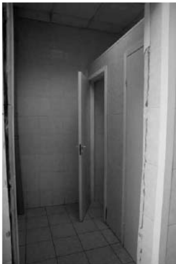
Фото 1.13. 1 этаж, помещение 4Н (97).
