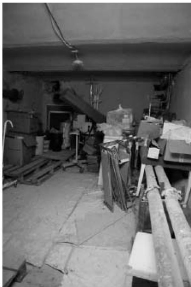
Фото п.3. Подвал, помещение 1Н (7).
