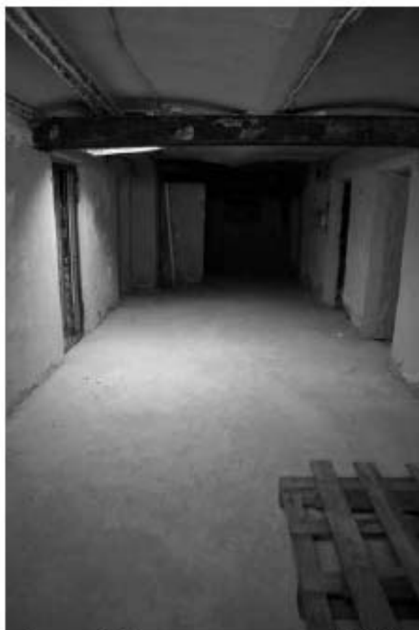
Фото п.4. Подвал, помещение 1Н (14).
