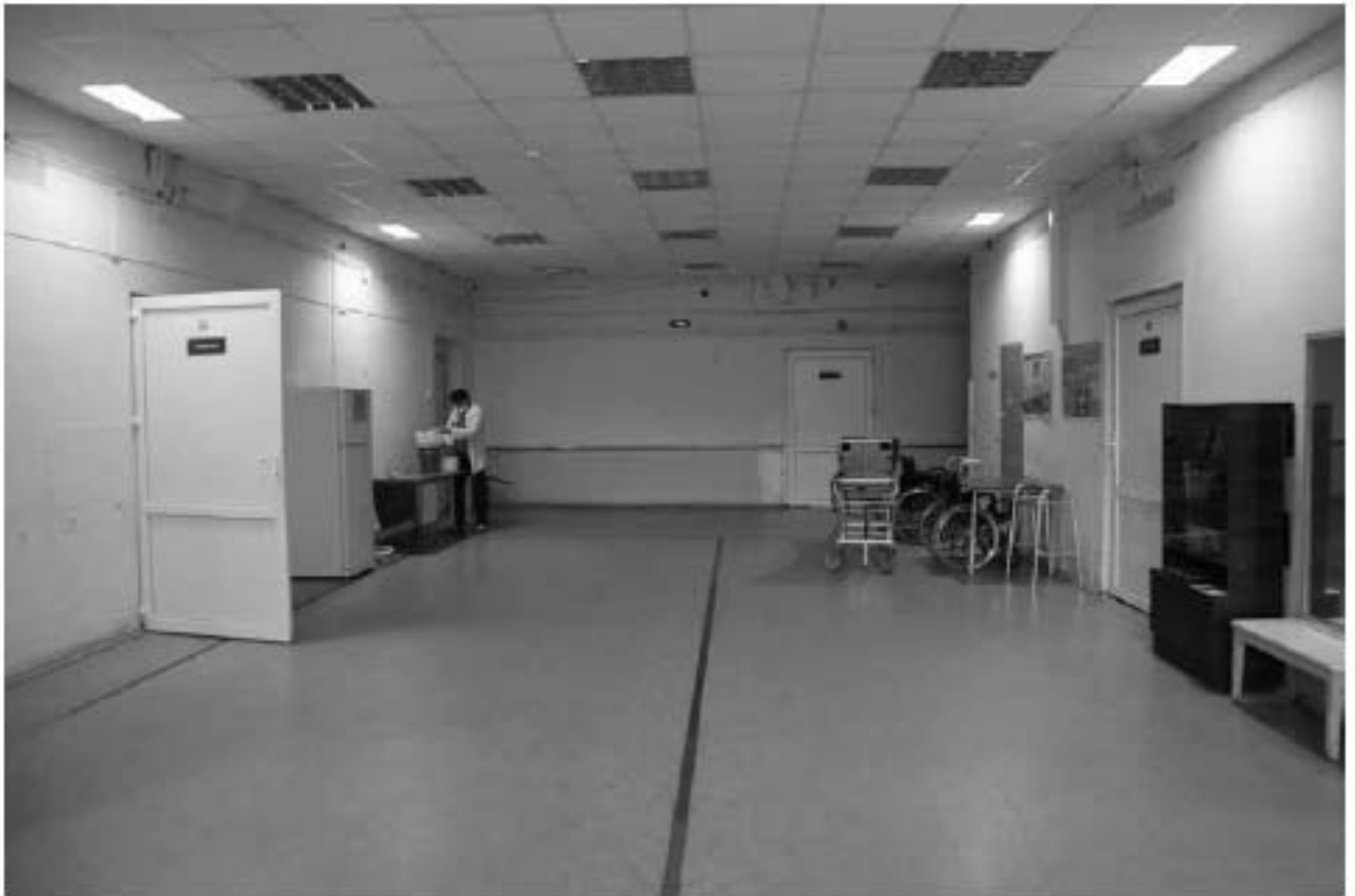
Фото 1.15. 1 этаж, помещение 4Н (66).
