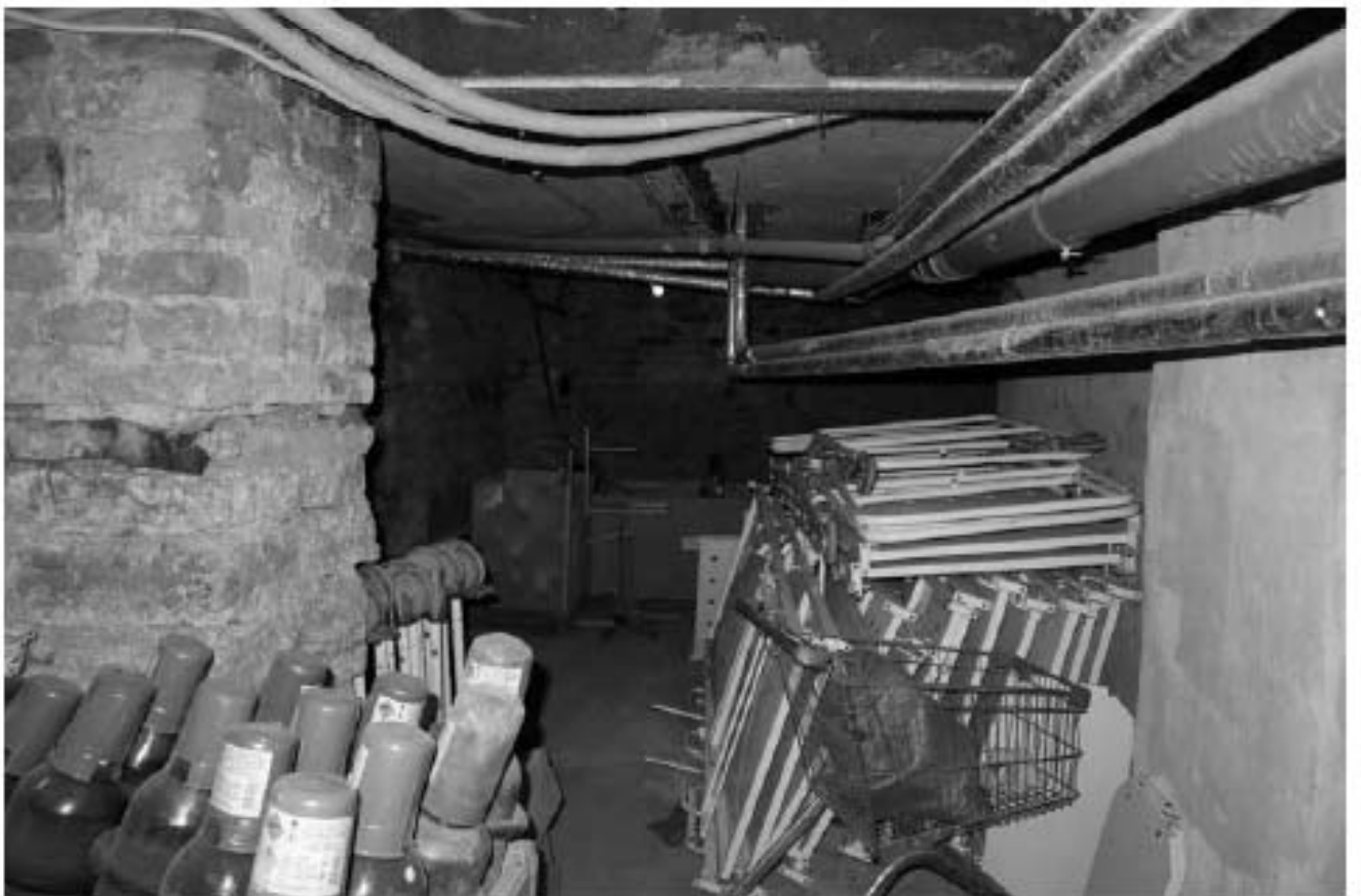
Фото п.28. Подвал, помещение 2Н (1)
