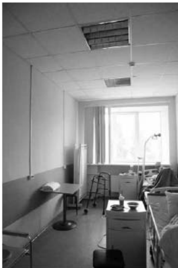
Фото 3.35. 3 этаж, помещение 12Н (69).
