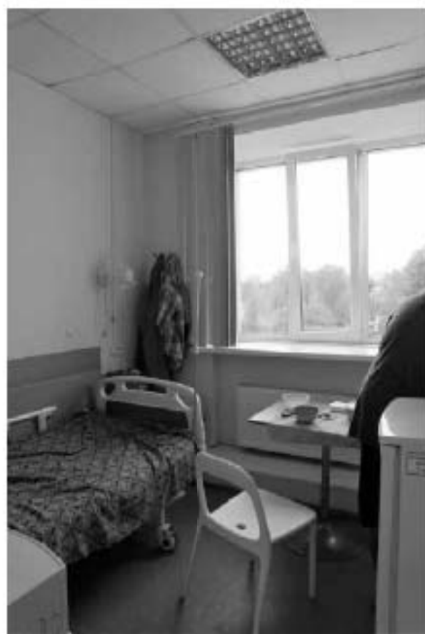
Фото 3.34. 3 этаж, помещение 12Н (107).
