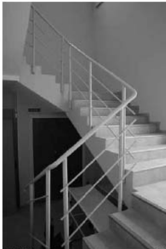
Фото 1.16. 1 этаж, лестница, помещение 1Н (36).
