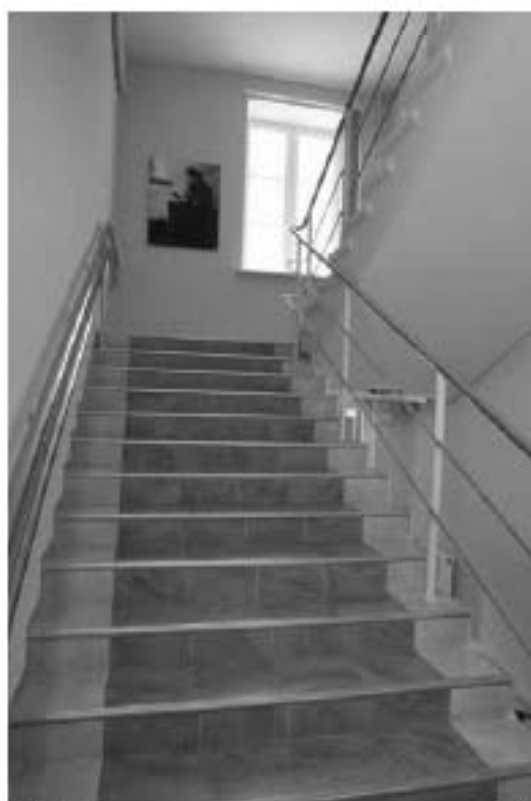
Фото 1.2. 1 этаж, лестница, помещение 1Н (26).
