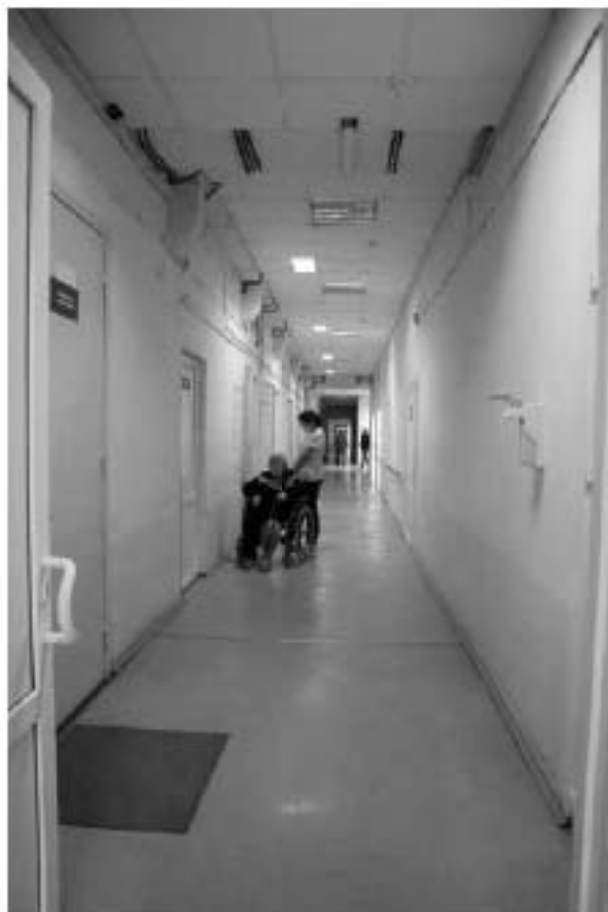
Фото 1.39. 1 этаж, коридор, помещение 4Н (44).
