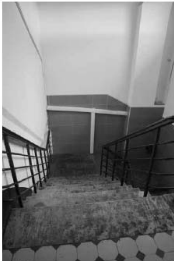
Фото 5.8. 5 этаж, лестница, помещение 2ЛК (8).
