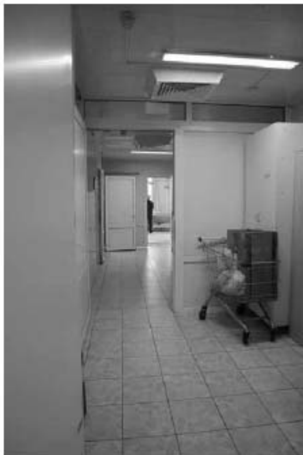
Фото 2.59. 2 этаж, коридор, помещение 11Н (61-62).
