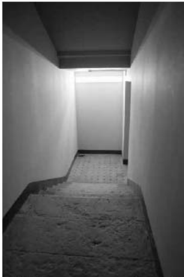
Фото 1.92. 1 этаж, лестница, помещение 4ЛК (4).
