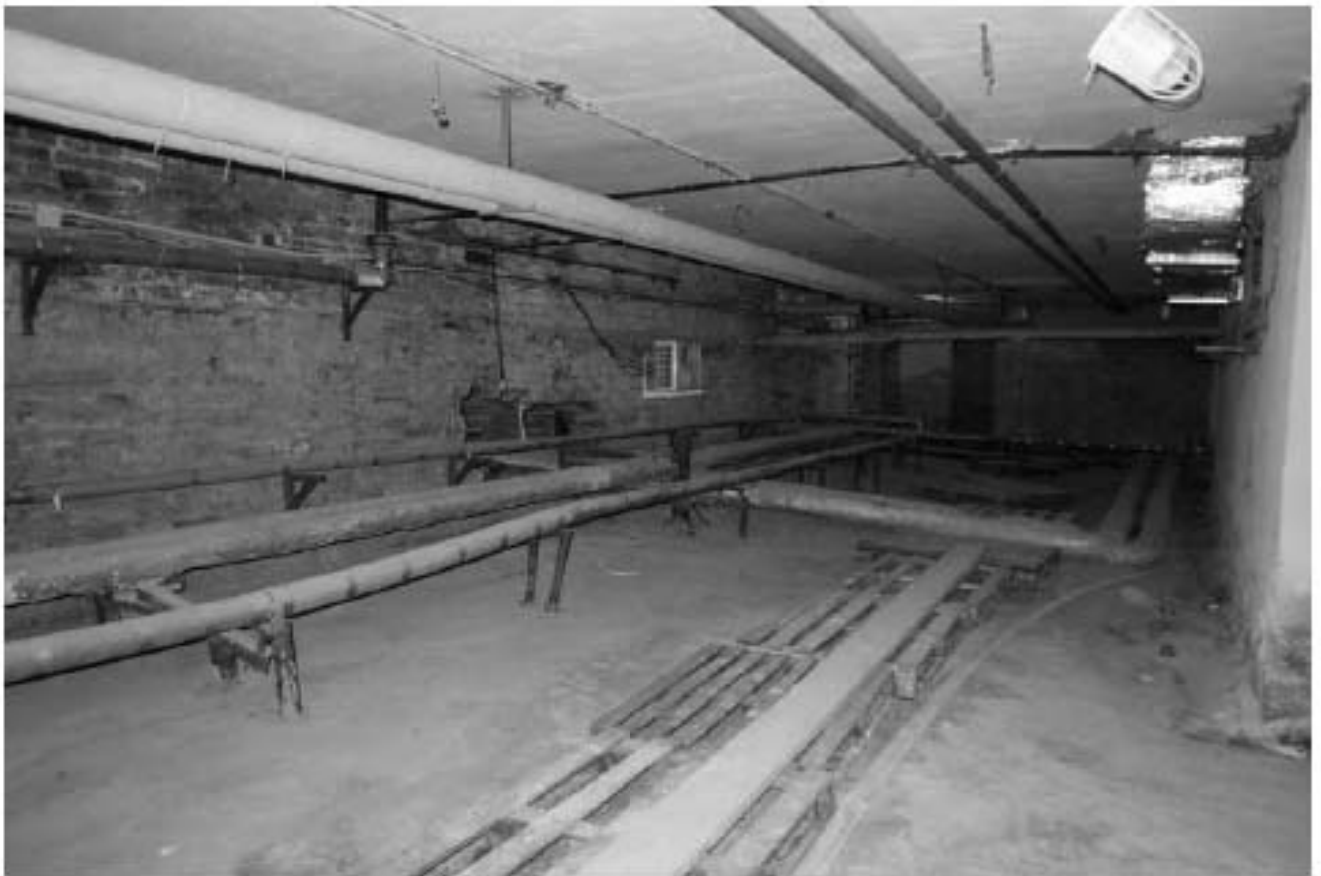
Фото п.29. Подвал, помещение 2Н (1).
