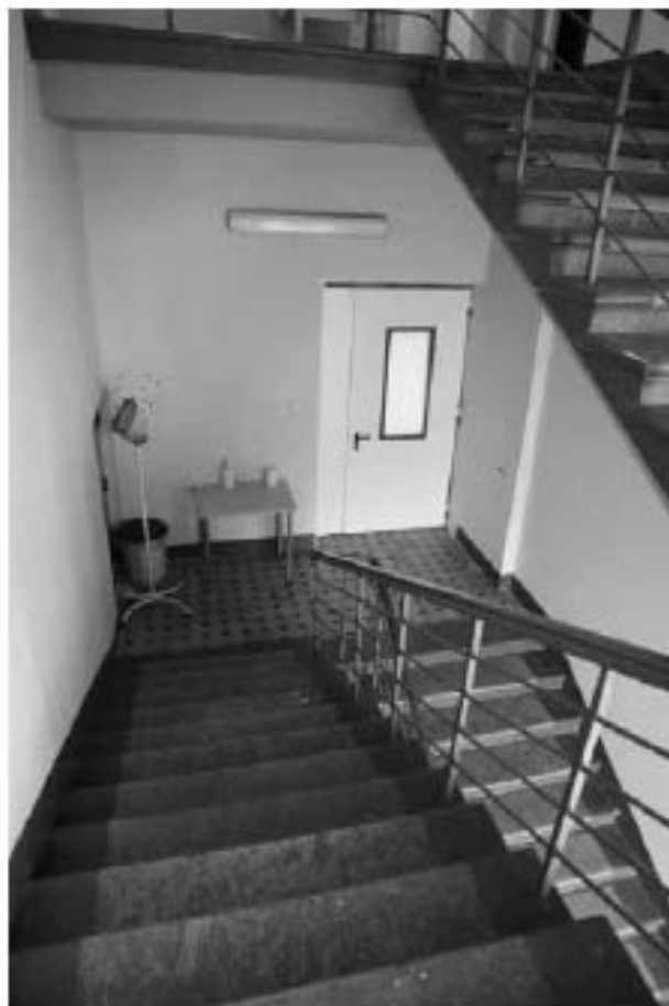
Фото 3.15. 3 этаж, лестница, помещение 4ЛК (7).
