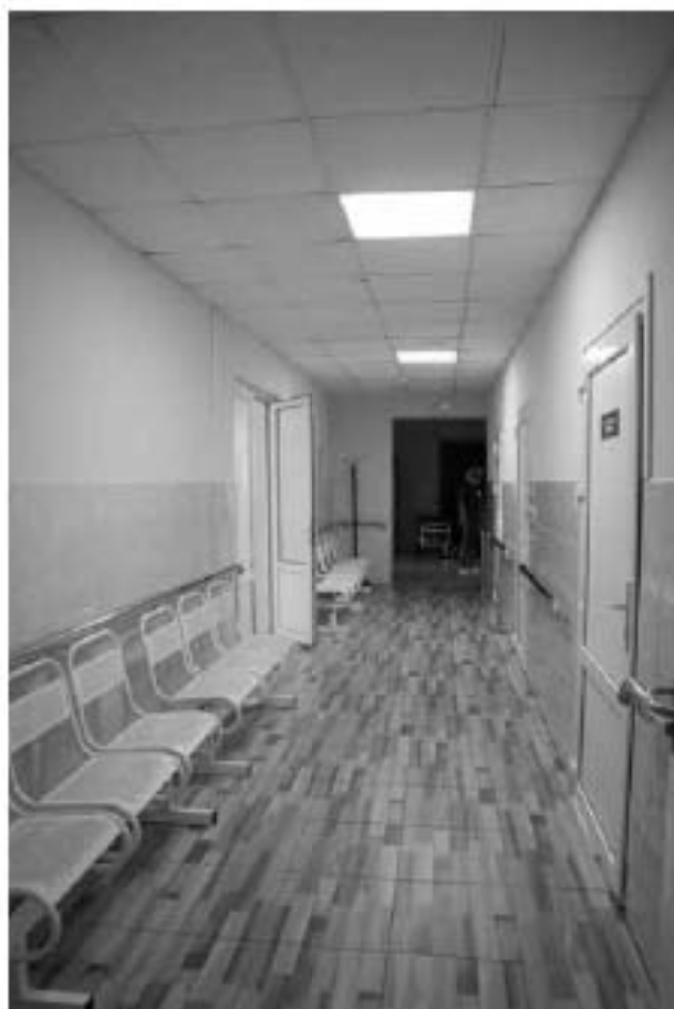
Фото 3.86. 3 этаж, коридор, помещение 12Н (55).
