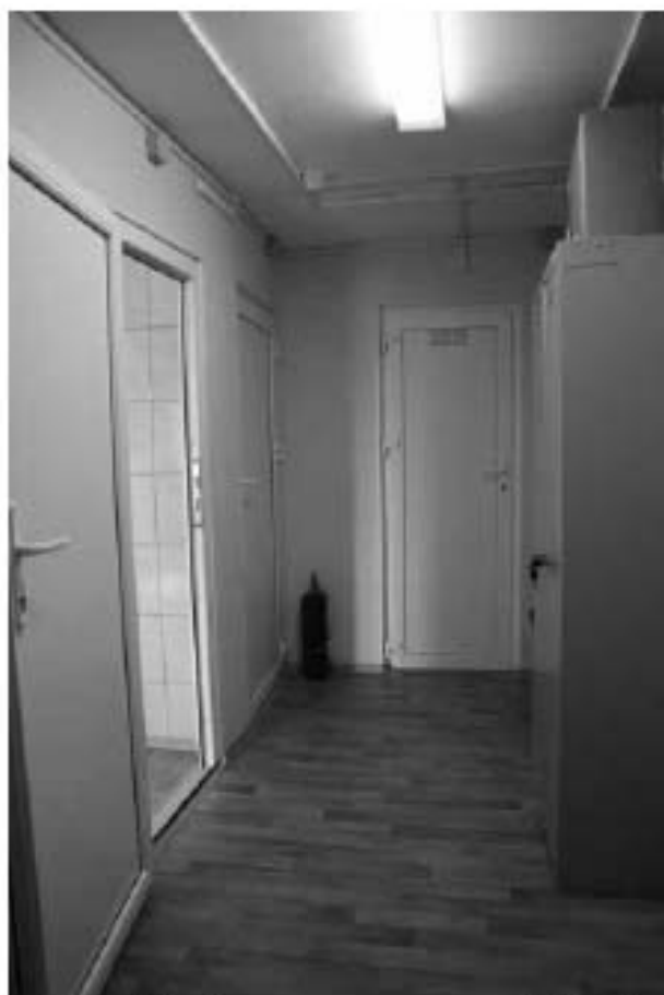
Фото 4.5. 4 этаж, помещение 14Н (1).
