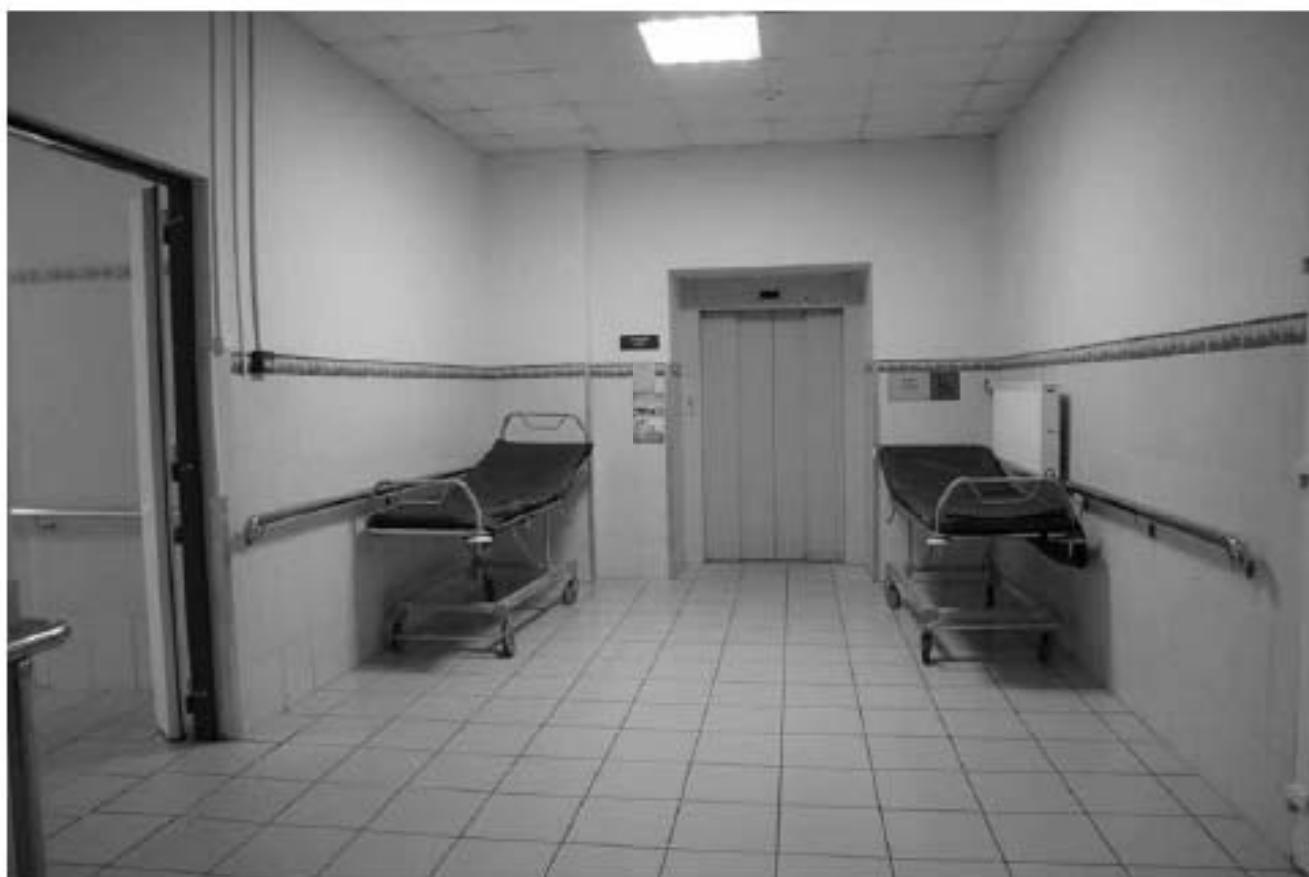
Фото 1.63. 1 этаж, помещение 4Н (15).
