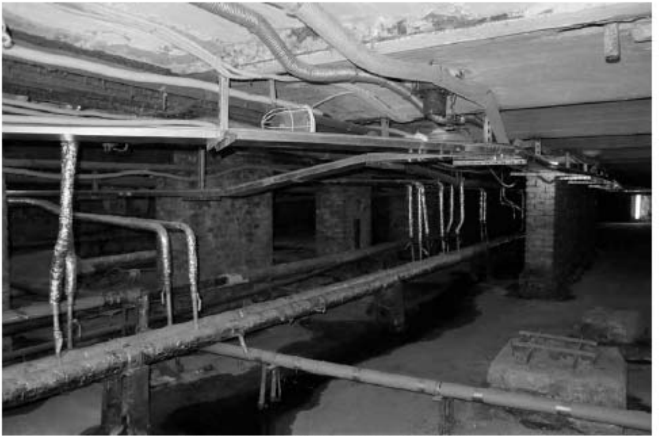
Фото п.35. Подвал, помещение 1Н (53).
