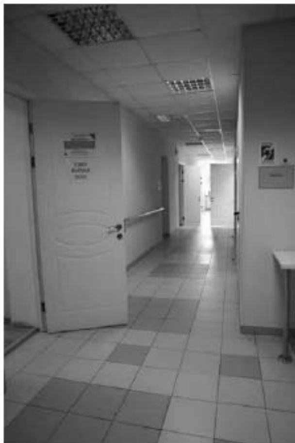
Фото 1.83. 1 этаж, коридор, помещение 9Н (1).
