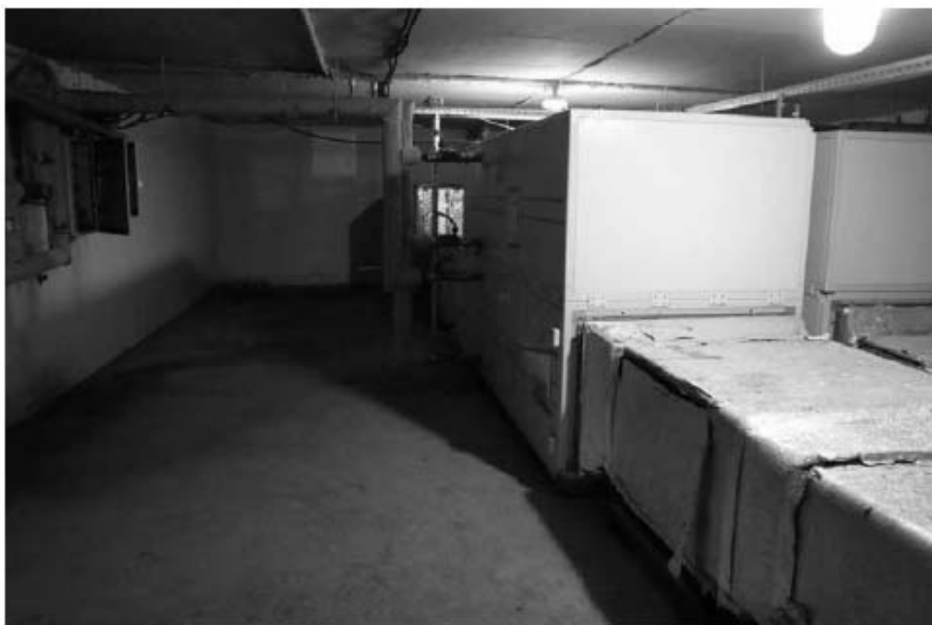
Фото п.22. Подвал, помещение 1Н (38).
