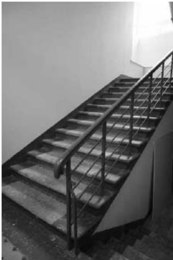
Фото 1.95. 1 этаж, лестница, помещение ЗЛК (2).
