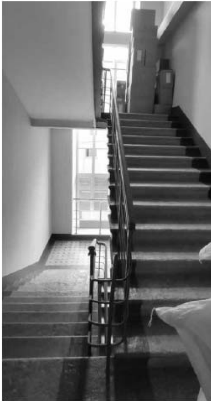
Фото 2.105. 2 этаж, лестница, помещение 4ЛК (6).
