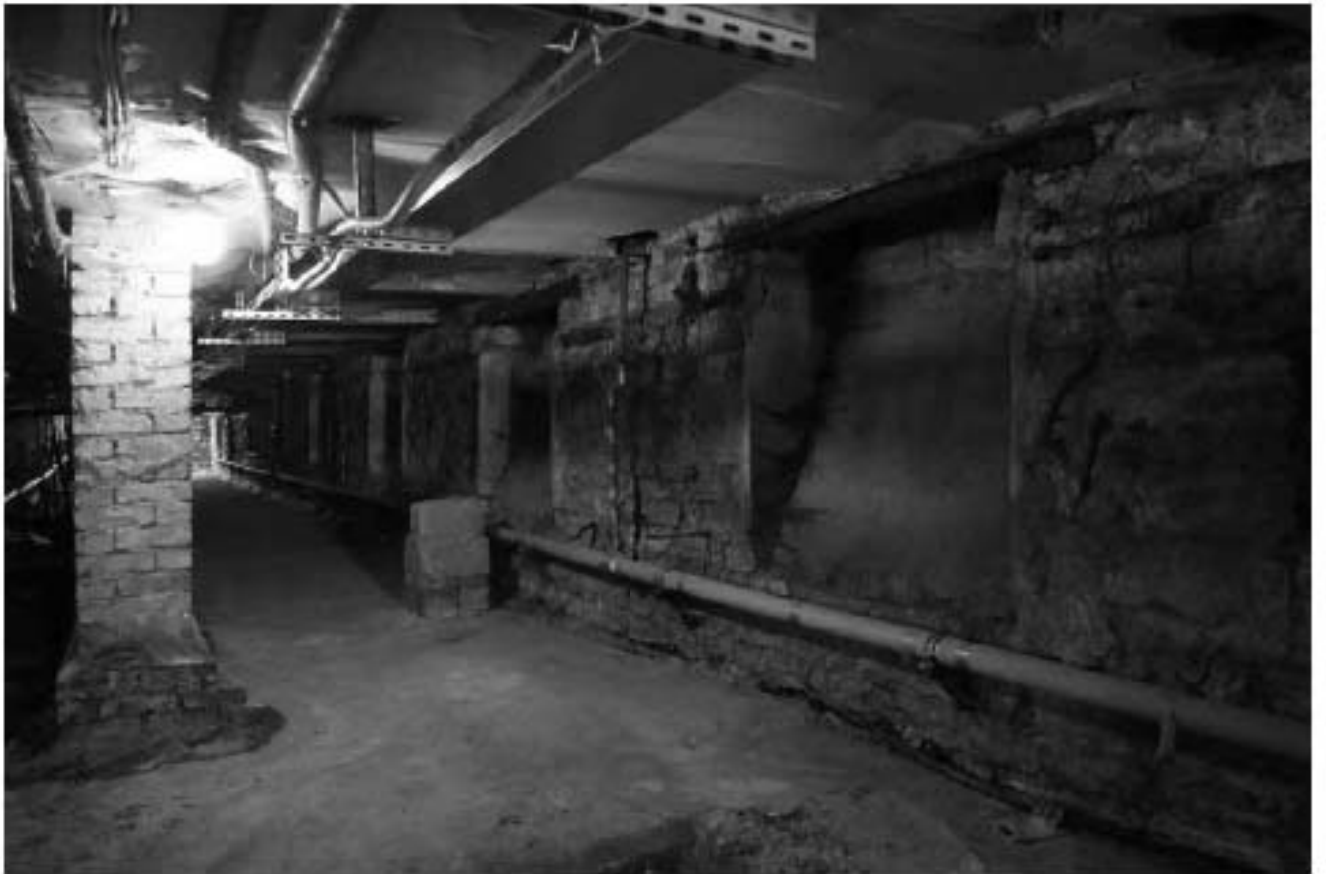
Фото п.37. Подвал, помещение 2Н (53).
