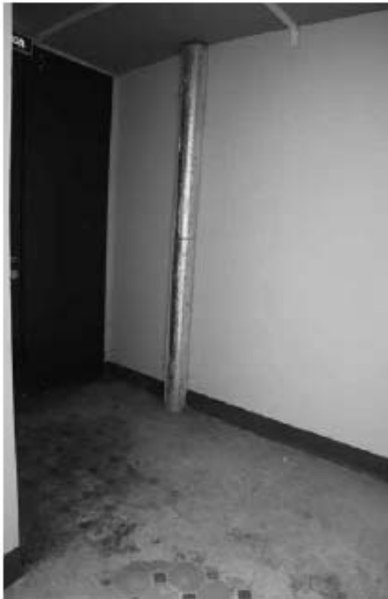
Фото 1.93. 1 этаж, помещение 4ЛК (3).
