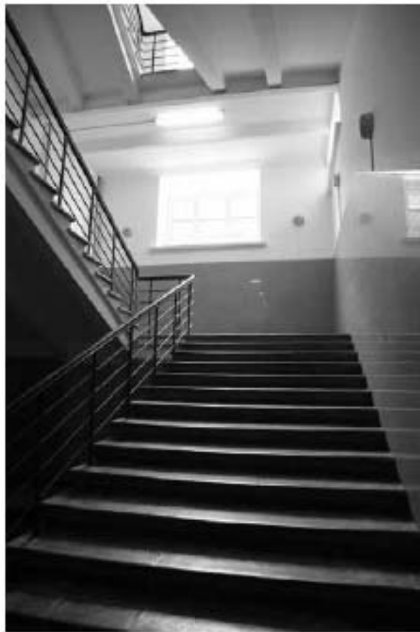
Фото 1.59. 1 этаж, лестница, помещение 2 ЛК (3).
