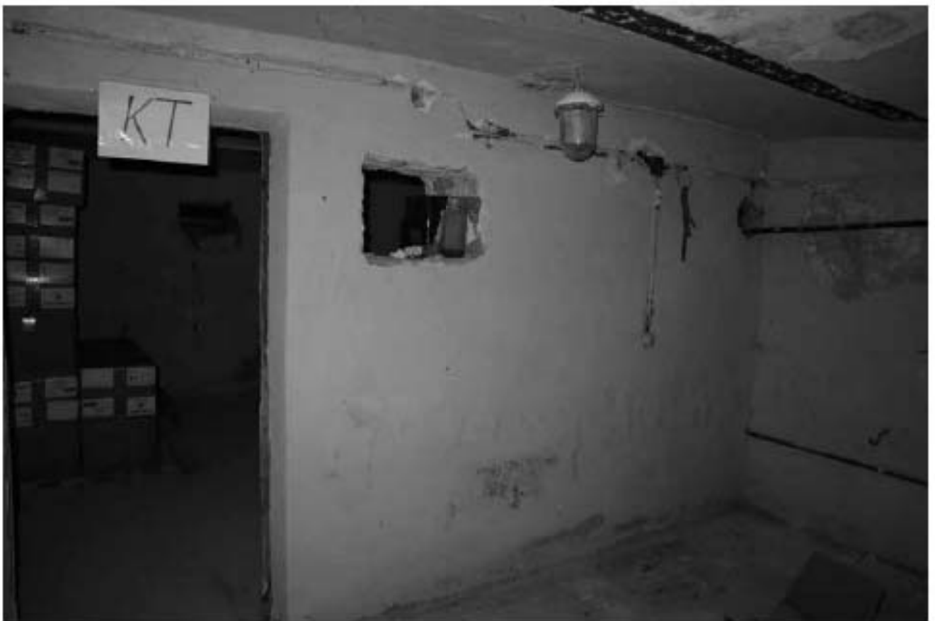
Фото п.6. Подвал, помещение 1Н (12).
