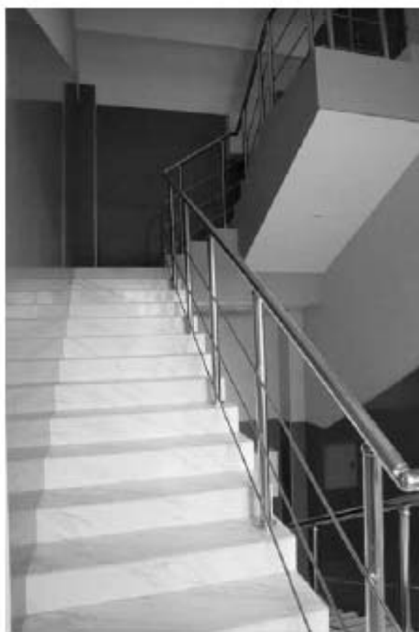
Фото 3.80. 3 этаж, лестница, помещение 1ЛК (7).
