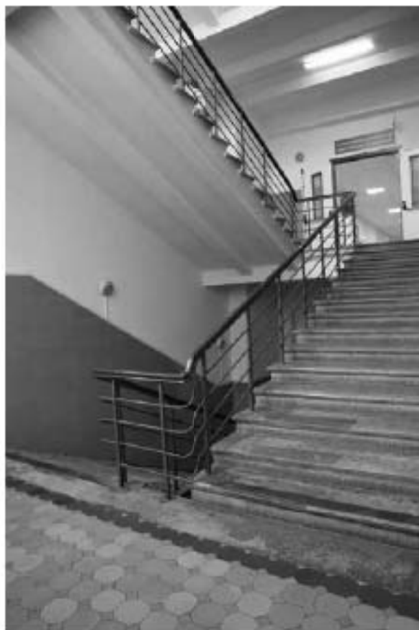
Фото 2.91. 2 этаж, лестница, помещение 2ЛК (5).
