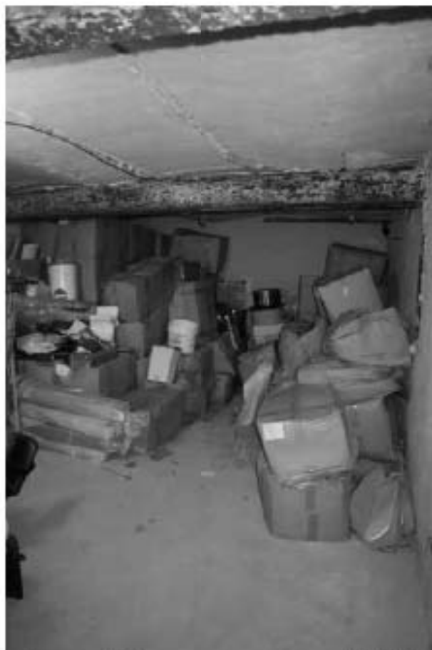
Фото п.8. Подвал, помещение 1Н (16).
