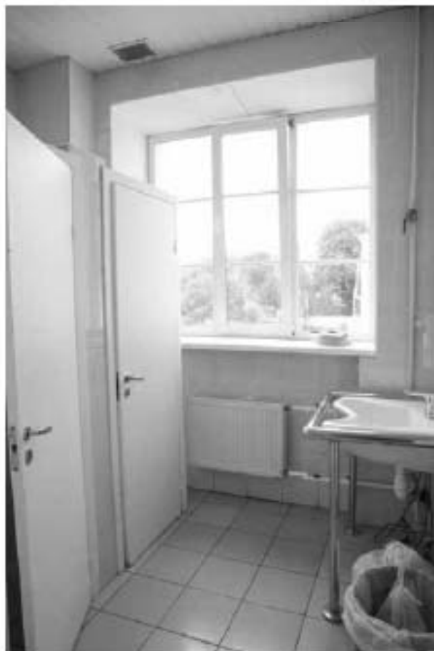
Фото 2.42. 2 этаж, помещение 11Н (159).
