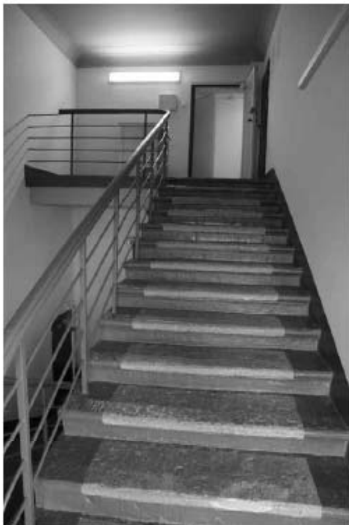
Фото 4.1. 4 этаж, лестница, помещение 4ЛК (8).
