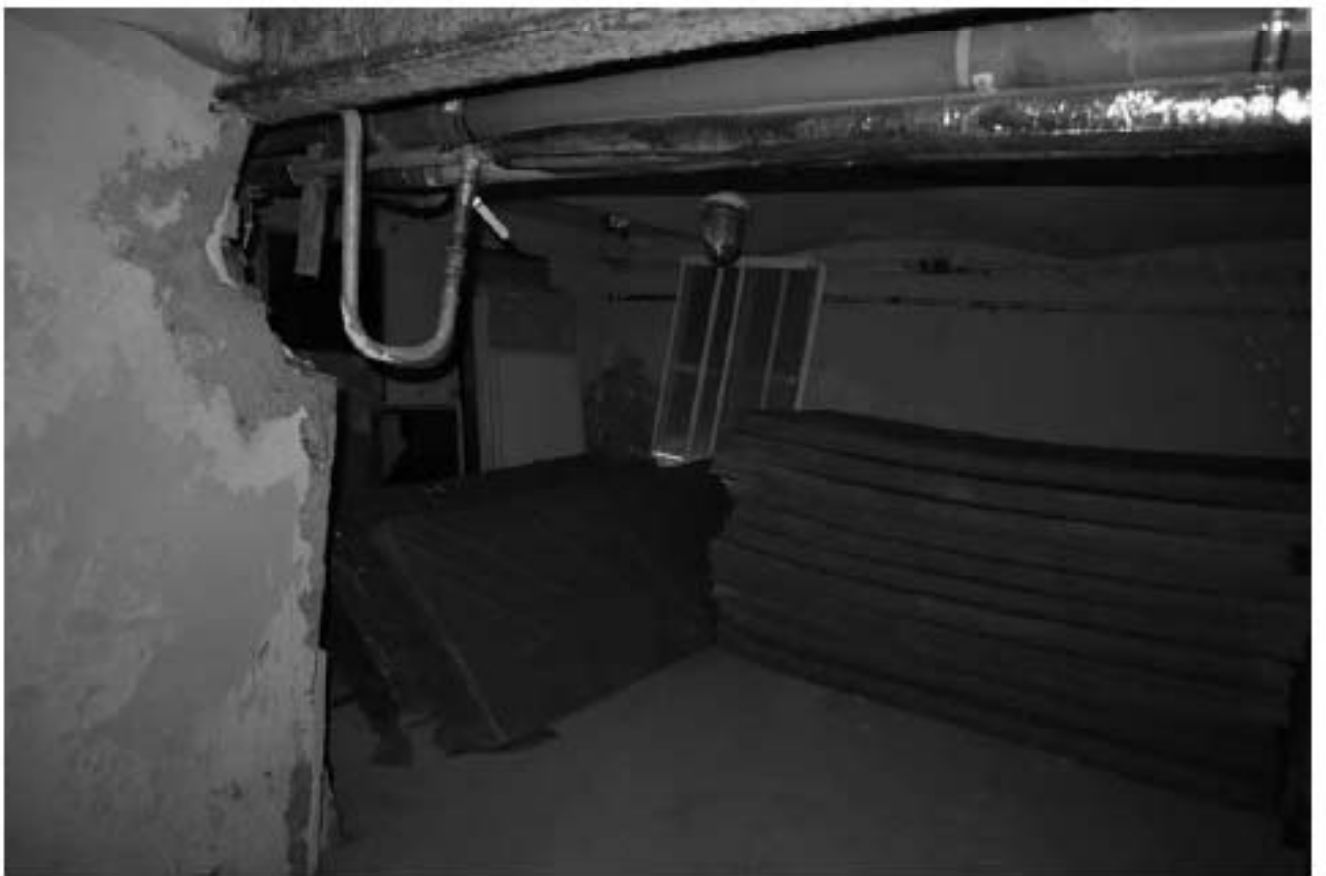
Фото п.12. Подвал, помещение 1Н (24).
