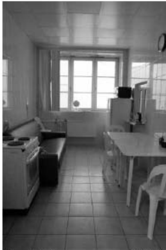
Фото 3.5. 3 этаж, помещение 1Н (80).
