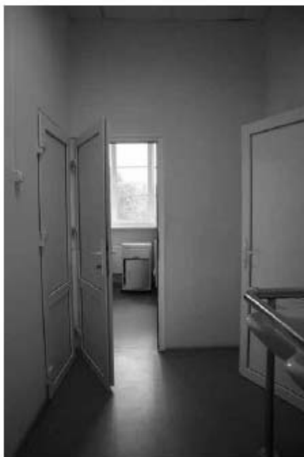
Фото 2.85. 2 этаж, помещение 11Н (22).
