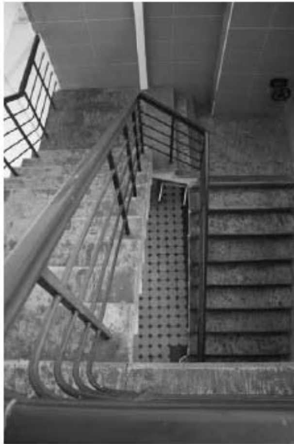
Фото 5.9. 5 этаж, лестница, помещение 2ЛК (8).
