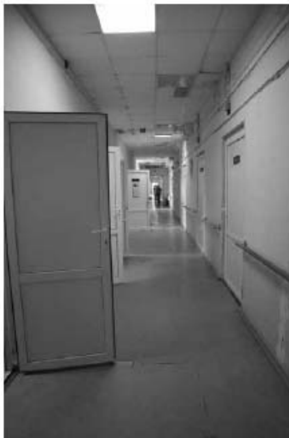
Фото 1.20. 1 этаж, коридор, помещение 4Н (55).
