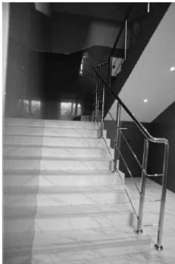
Фото 1.75. 1 этаж, лестница, помещение 1JK (5).
