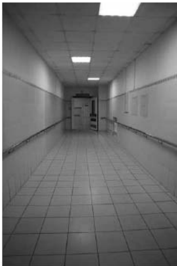
Фото 1.55. 1 этаж, коридор, помещение 4Н (24).
