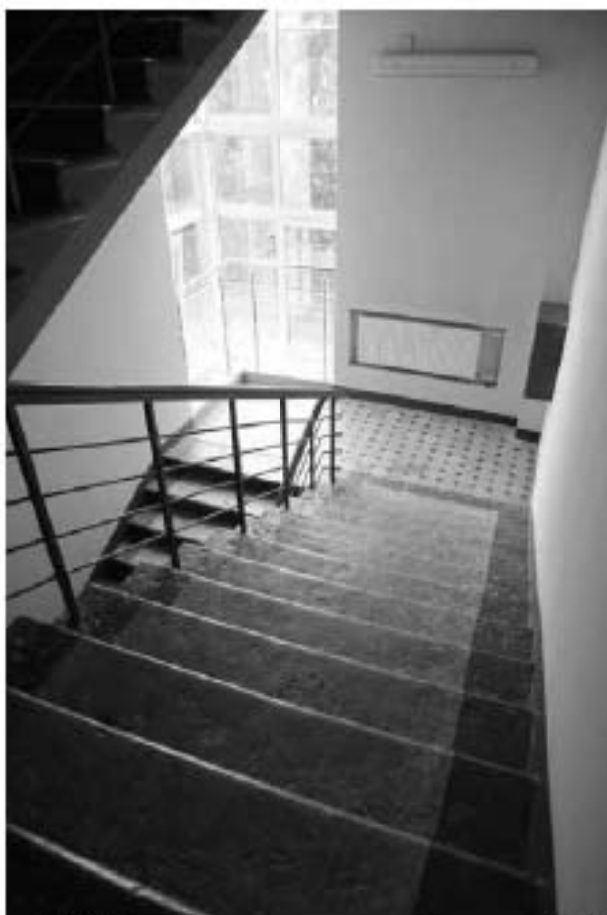
Фото 3.90. 3 этаж, лестница, помещение 3ЛК (5).
