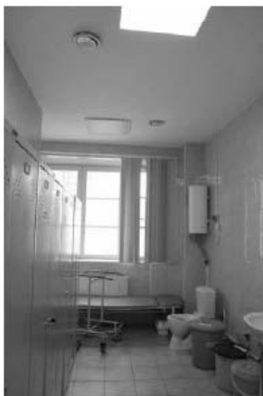
Фото 2.2. 2 этаж, помещение 1Н (62).
