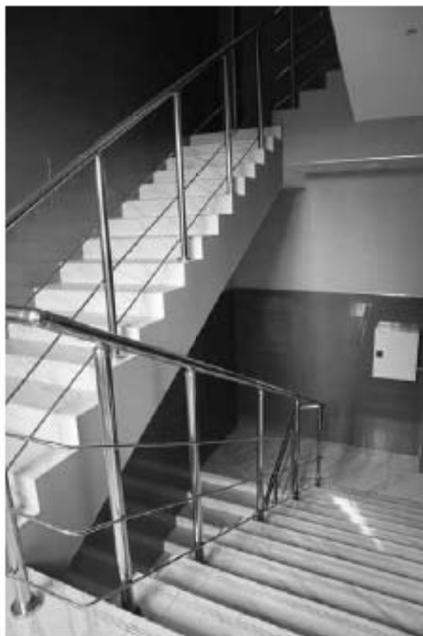
Фото 3.81. 3 этаж, лестница, помещение 1ЛК (7).
