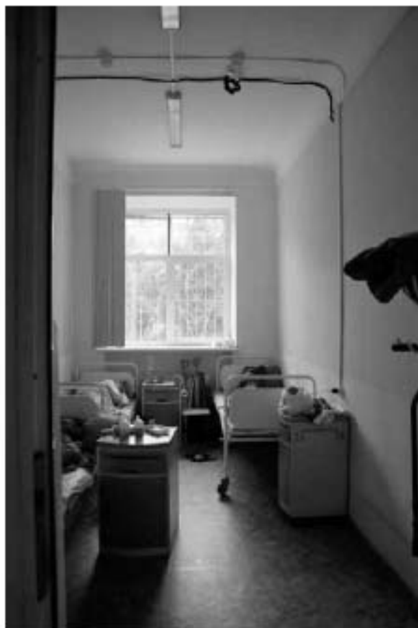
Фото 1.23. 1 этаж, помещение 4Н (63).
