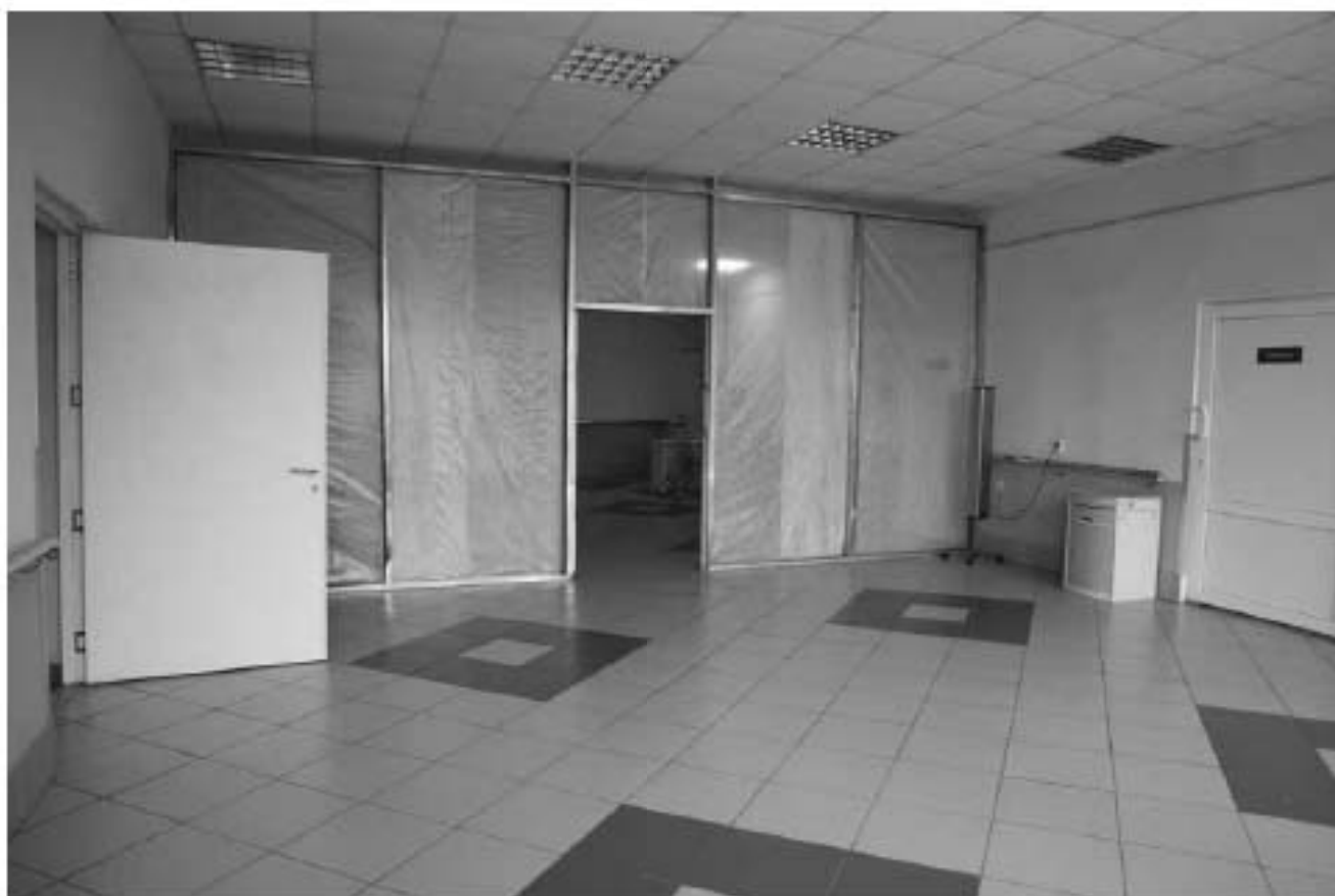
Фото 2.33. 2 этаж, помещение 11Н (80).
