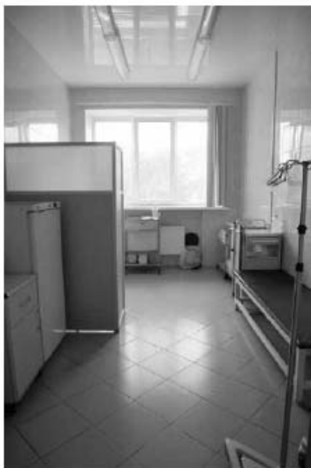
Фото 3.41. 3 этаж, помещение 12Н (64).
