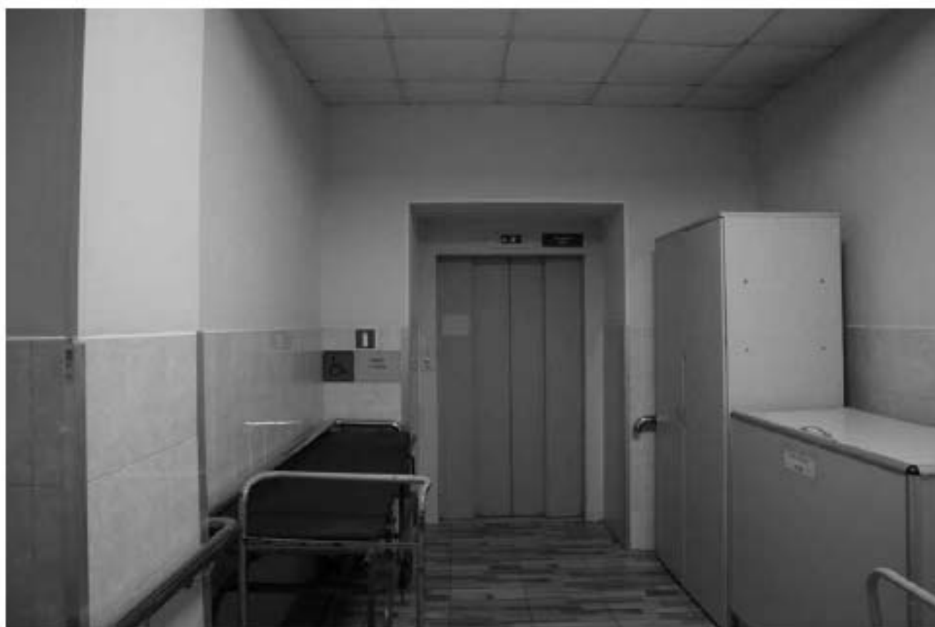
Фото 3.50. 3 этаж, помещение 12Н (53).
