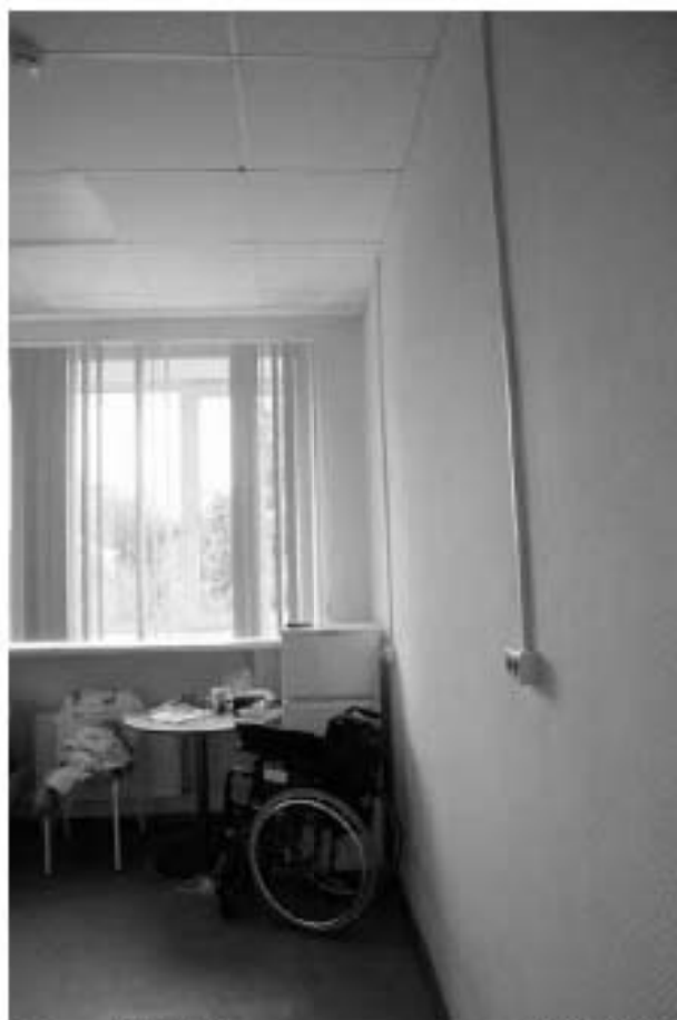
Фото 3.58. 3 этаж, помещение 12Н (21).
