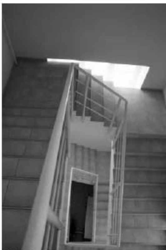
Фото 3.12. 3 этаж, лестница, помещение 1Н (82).
