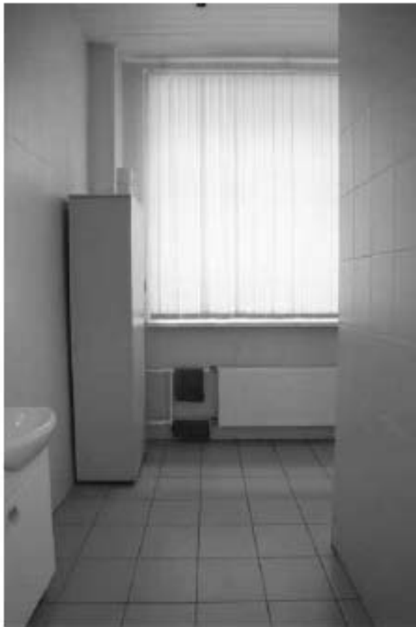
Фото 1.89. 1 этаж, помещение 9Н (10).
