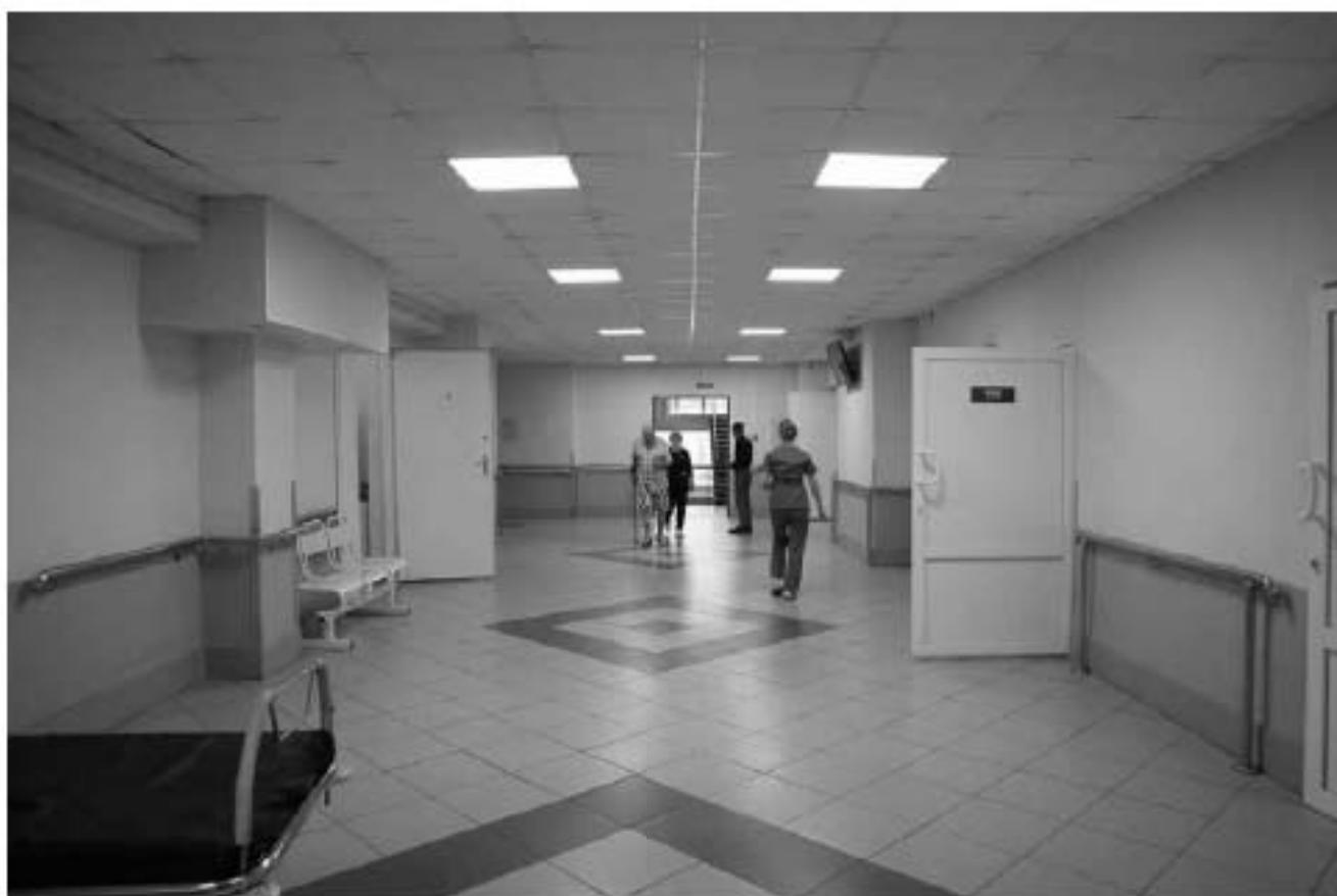
Фото 2.50. 2 этаж, помещение 11Н (53).
