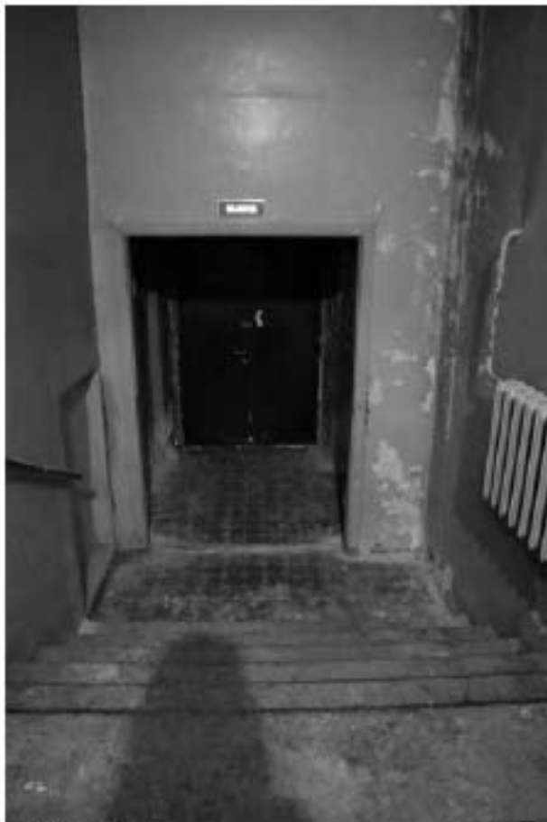
Фото 1.98. 1 этаж, лестница, помещение 4Н (70).
