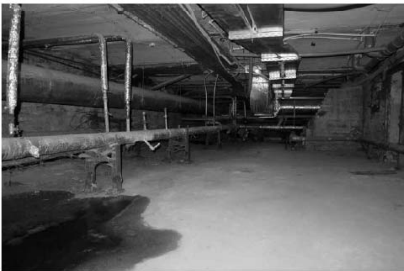
Фото п.40. Подвал, помещение 1Н (45).
