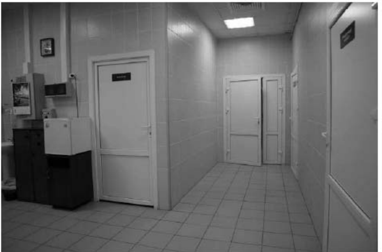
Фото 1.44. 1 этаж, помещение 4Н (134).
