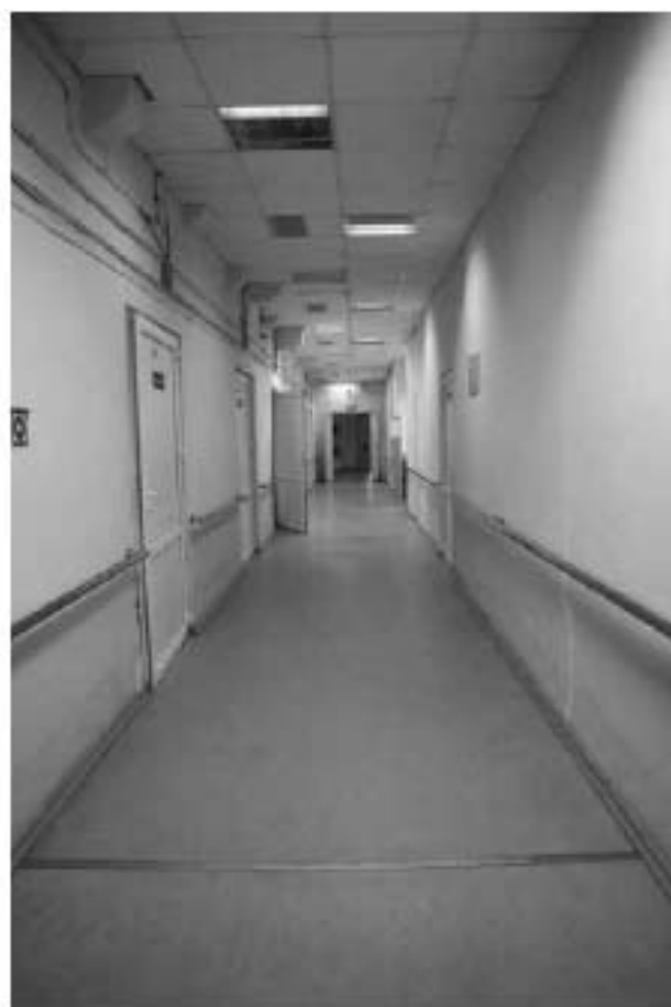
Фото 1.10. 1 этаж, коридор, помещение 4Н (69).
