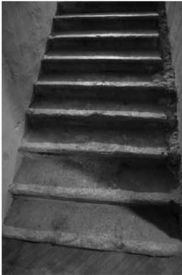
Фото 1.97. 1 этаж, лестница, помещение 3ЛК (3).
