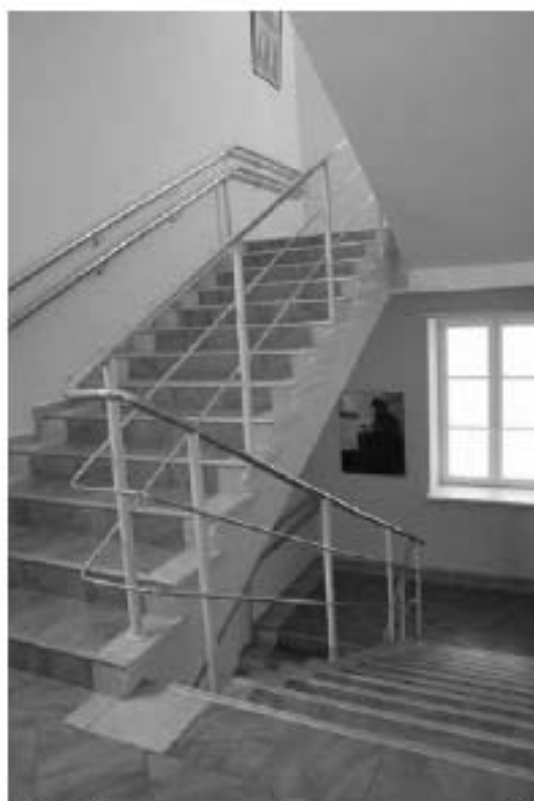
Фото 2.13. 2 этаж, лестница, помещение 1Н (51).
