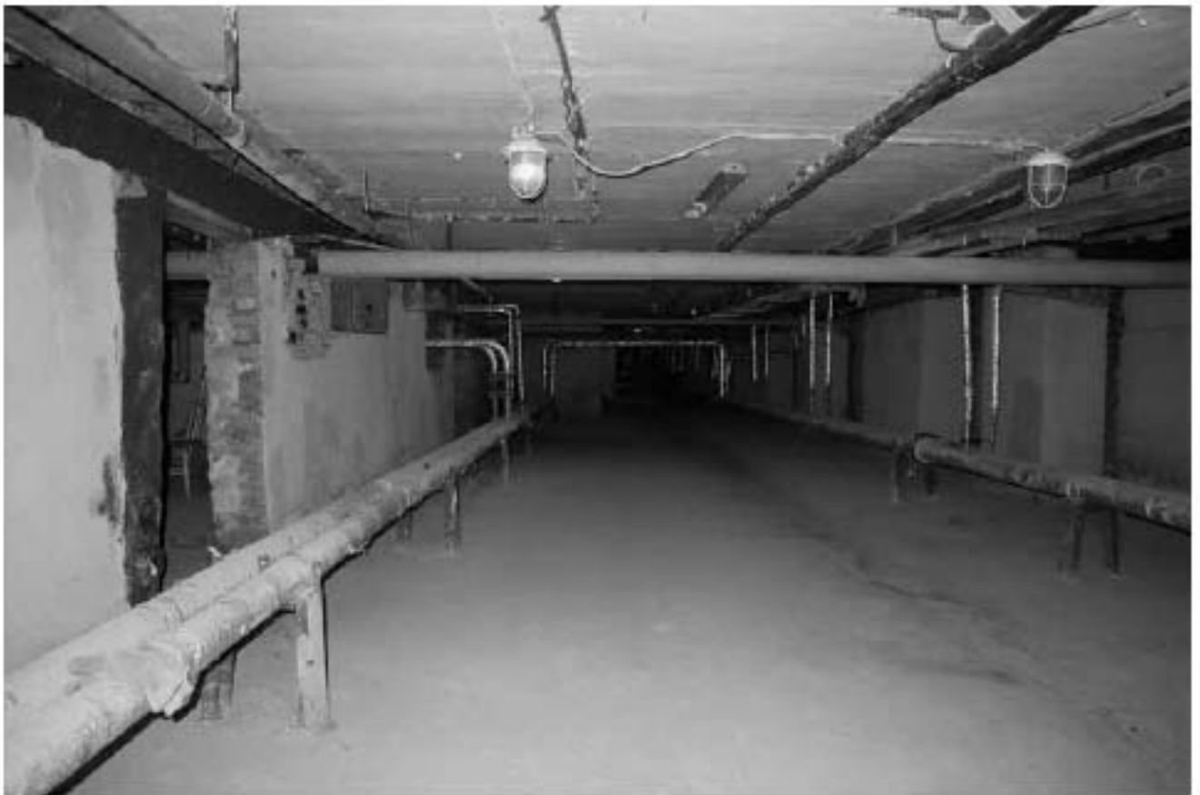
Фото п.19. Подвал, помещение 1Н (32).
