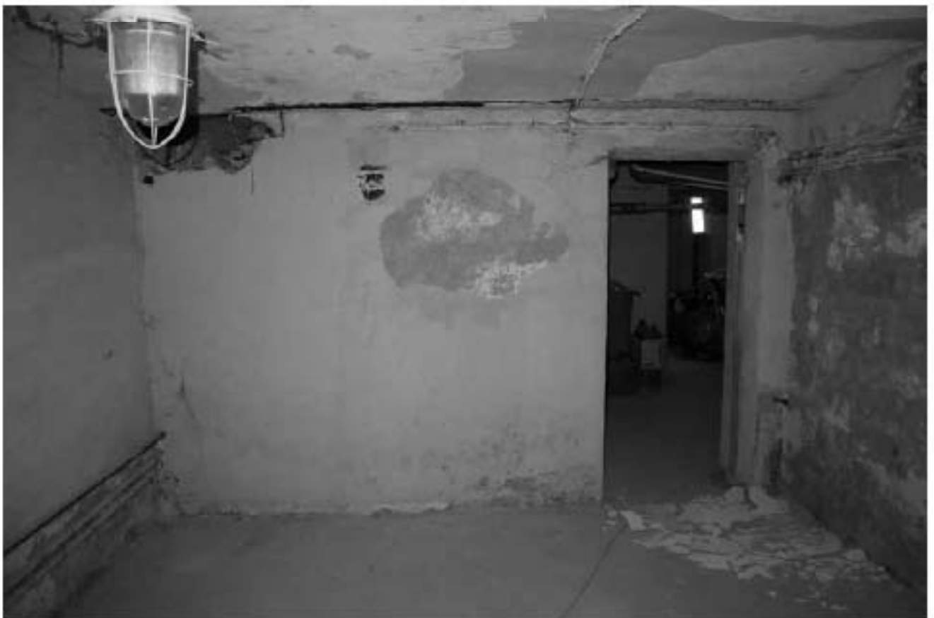
Фото п.10. Подвал, помещение 1Н (19).
