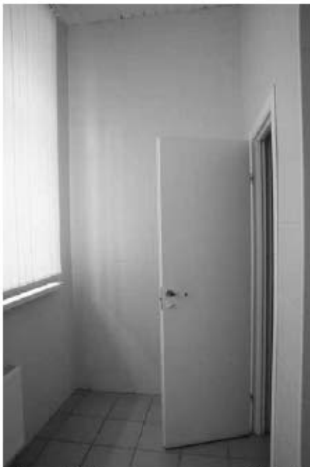
Фото 1.90. 1 этаж, помещение 9Н (10).
