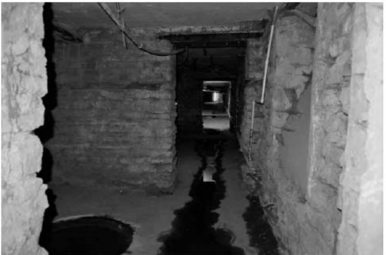
Фото п.32. Подвал, помещение 2Н (1).
