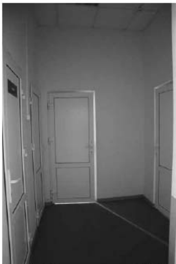
Фото 2.76. 2 этаж, помещение 11Н (13).
