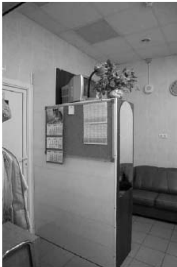
Фото 1.41. 1 этаж, помещение 4Н (132).
