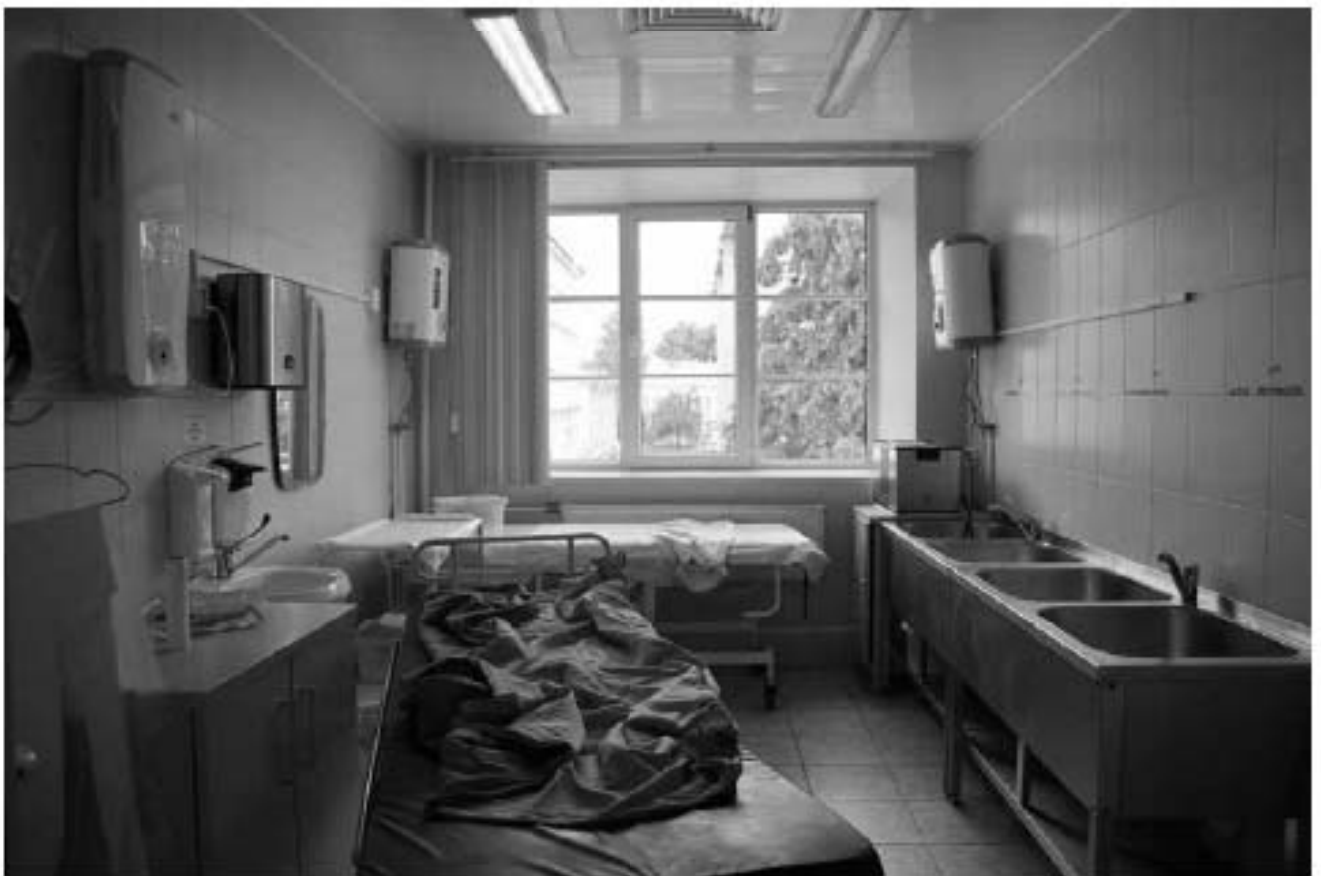
Фото 2.56. 2 этаж, помещение 11Н (63).
