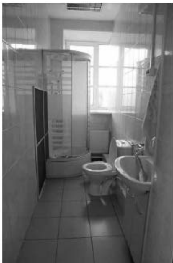
Фото 3.74. 3 этаж, помещение 12Н (32).
