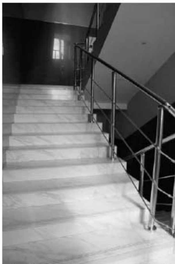
Фото 2.70. 2 этаж, лестница, помещение 1ЛК (6).
