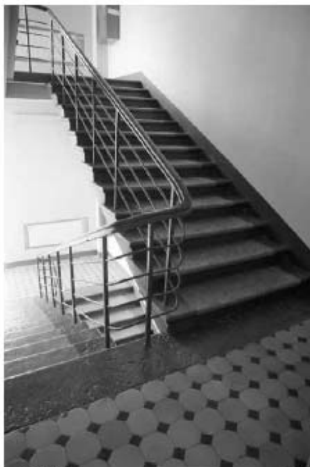
Фото 3.14. 3 этаж, лестница, помещение 4ЛК (7).
