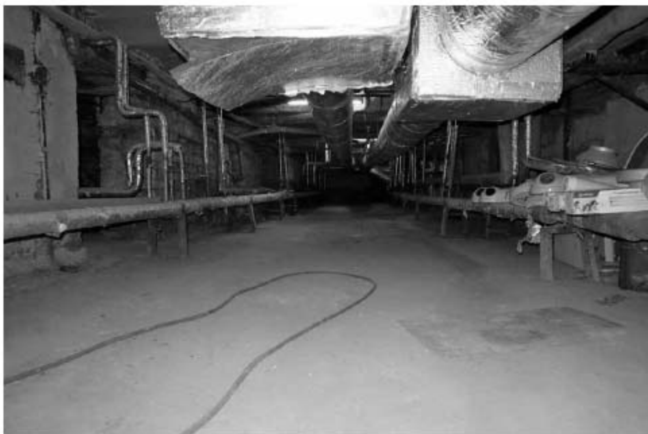
Фото п.21. Подвал, помещение 1Н (37).
