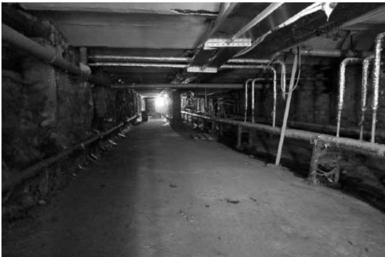
Фото п.39. Подвал, помещение 1Н (53).
