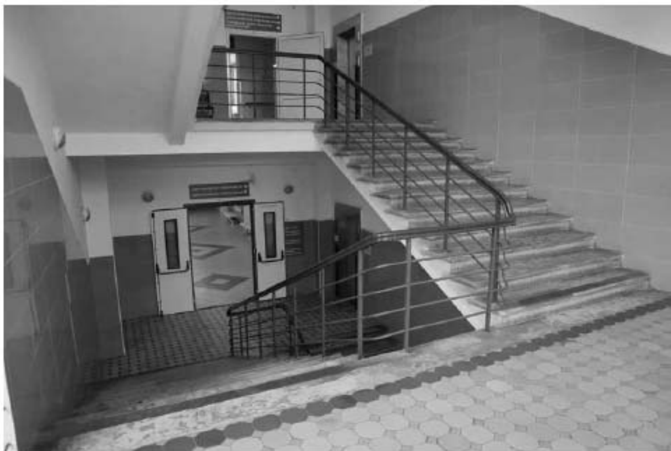
Фото 2.92. 2 этаж, лестница, помещение 2ЛК (5).
