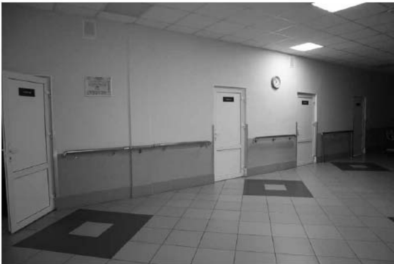
Фото 2.71. 2 этаж, помещение 11Н (1).
