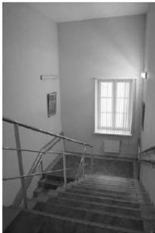
Фото 3.1. 3 этаж, лестница, помещение 1Н (73).
