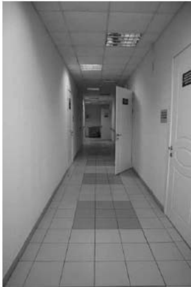
Фото 1.91. 1 этаж, коридор, помещение 9Н (1).
