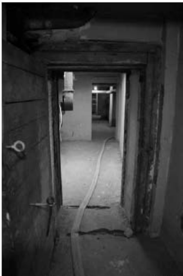
Фото п.16. Подвал, помещение 3Н (1).
