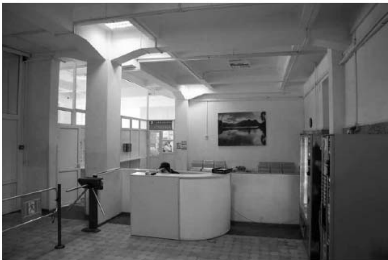
Фото 1.56. 1 этаж, помещение 4Н (25).
