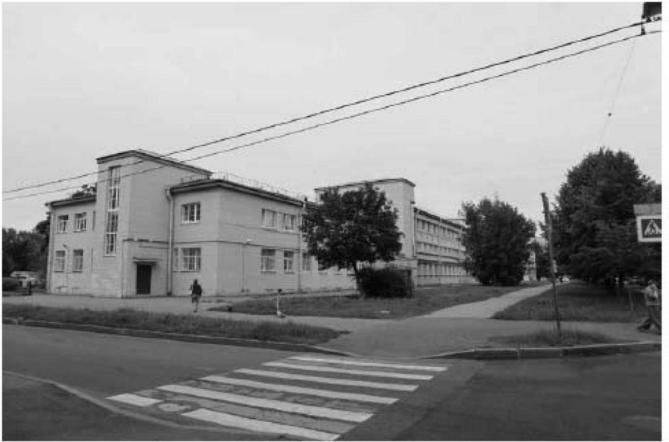
Фото 7. Лицевой фасад, вид с Оборонной ул.
