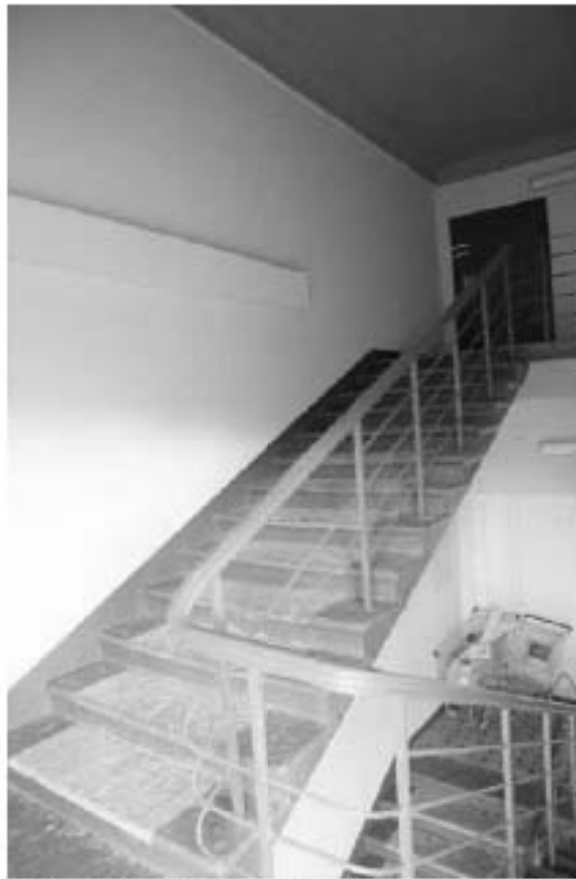
Фото 3.91. 3 этаж, лестница, помещение 3ЛК (5).
