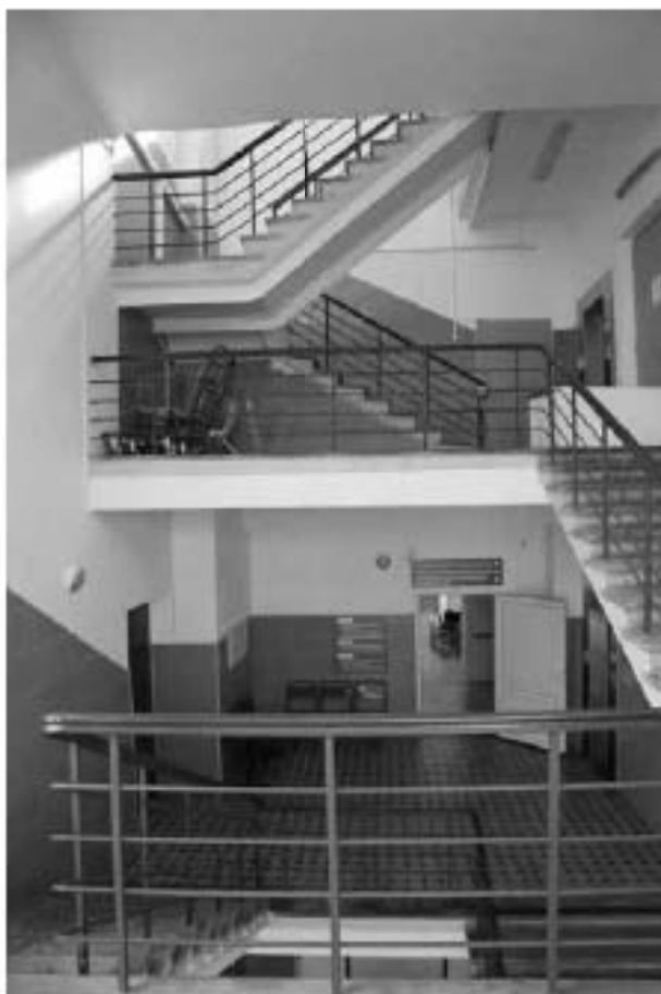
Фото 3.89. 3 этаж, лестница, помещение 2ЛК (6).
