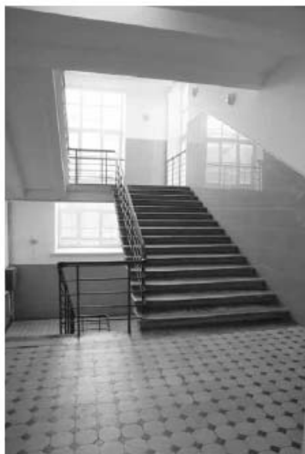
Фото 2.90. 2 этаж, лестница, помещение 2ЛК (5).
