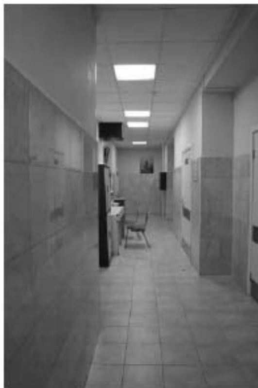
Фото 2.1. 2 этаж, коридор, помещение 1Н (53).
