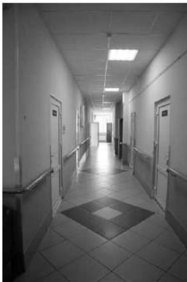
Фото 2.72. 2 этаж, коридор, помещение 11Н (1).
