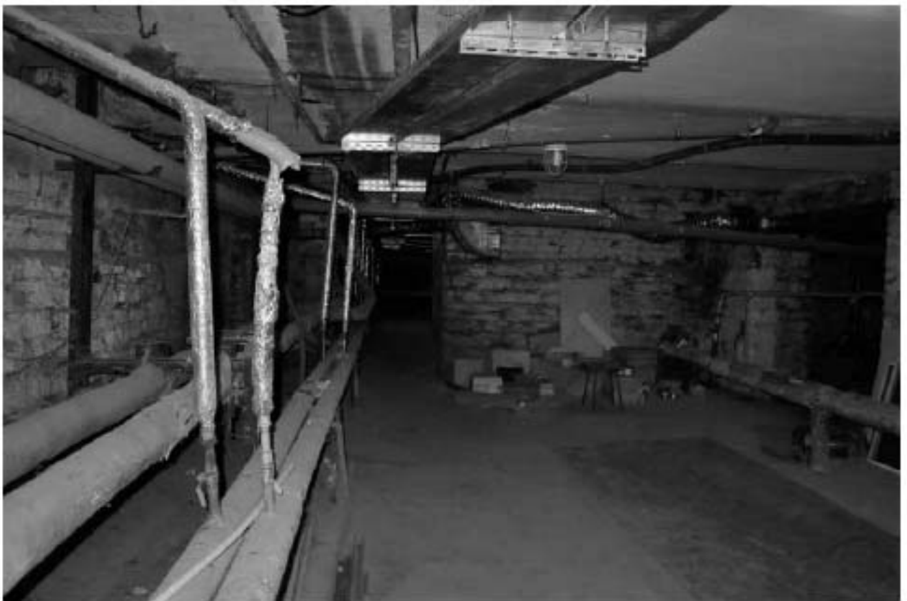
Фото п.20. Подвал, помещение 1Н (32).
