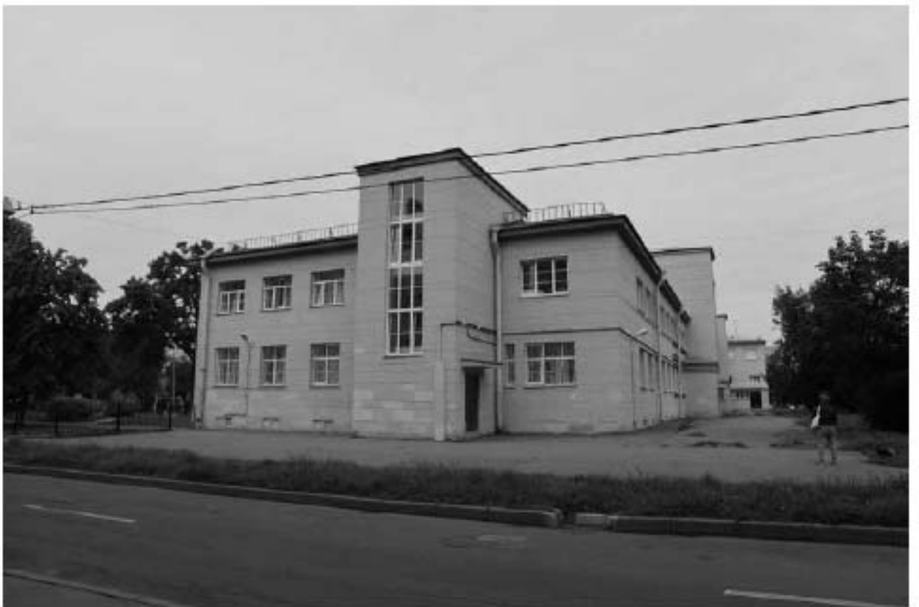
Фото 8. Лицевой фасад, вид с Оборонной ул.
