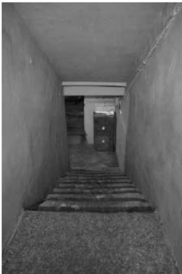
Фото 1.96. 1 этаж, лестница, помещение ЗЛК (3).
