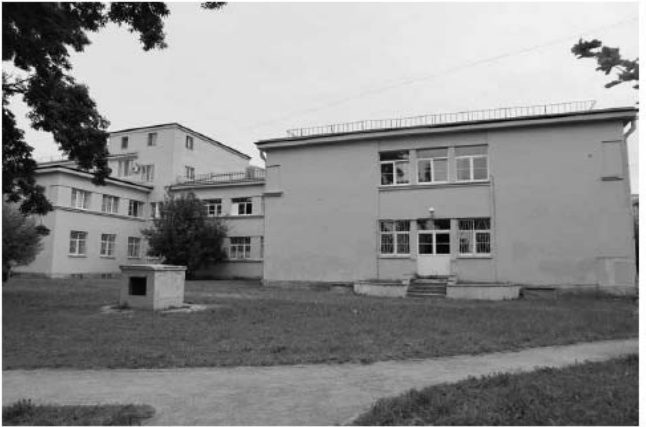
Фото 9. Лицевой фасад, вид с Оборонной ул.
