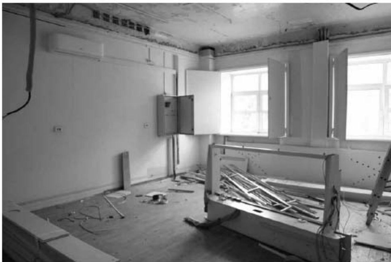
Фото 2.54. 2 этаж, помещение 11Н (57).
