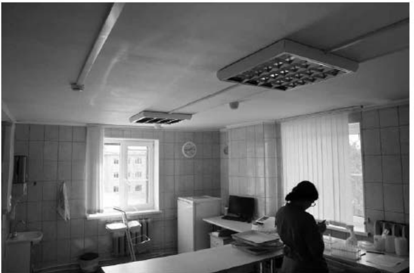
Фото 4.3. 4 этаж, помещение 14Н (2).
