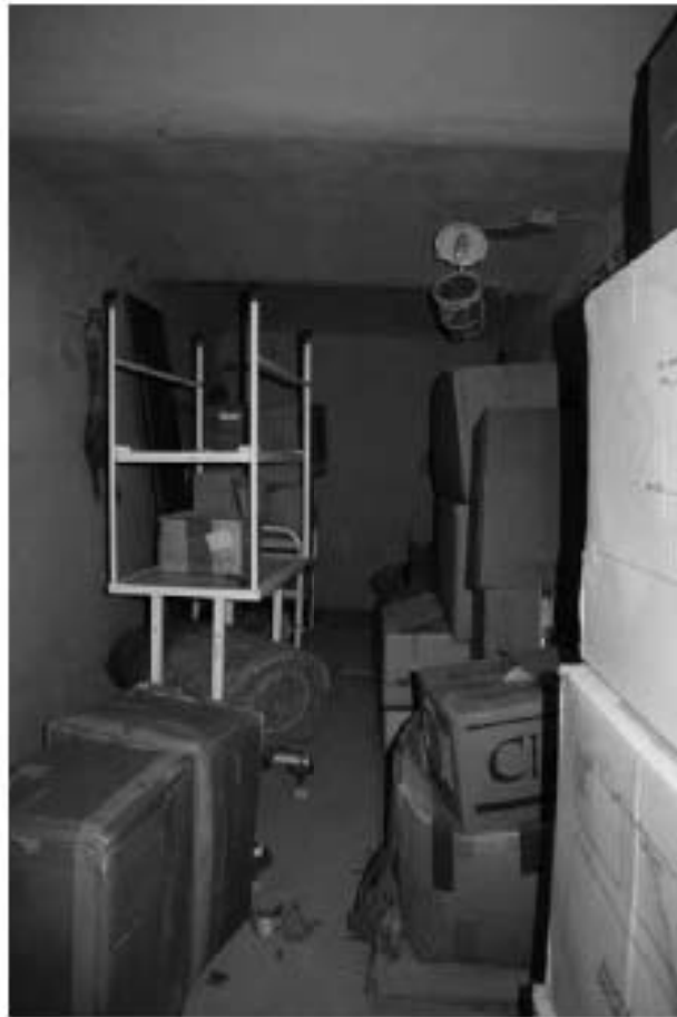
Фото п.5. Подвал, помещение 1Н (8).
