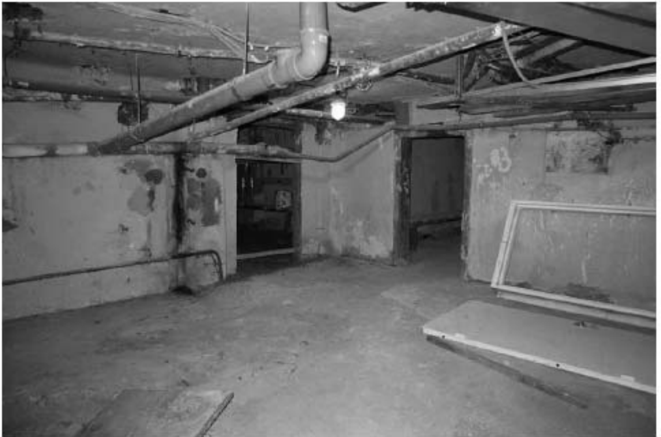
Фото п.17. Подвал, помещение 1Н (29).
