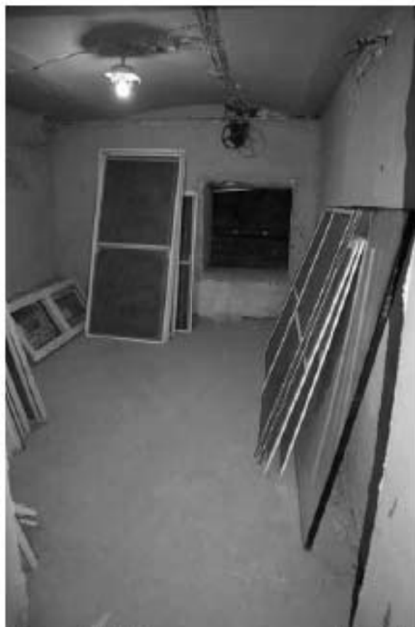
Фото п.13. Подвал, помещение 1Н (26).
