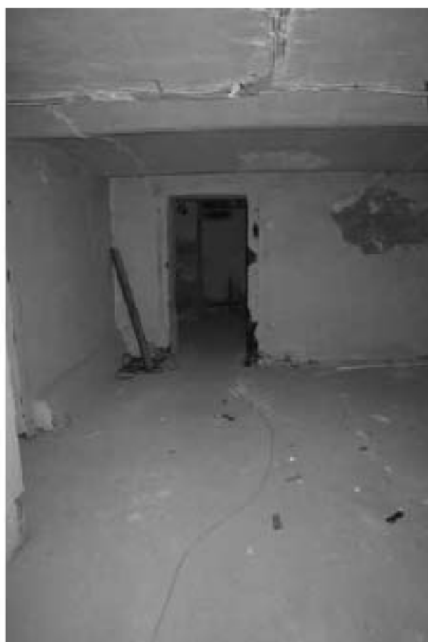
Фото п.14. Подвал, помещение 1Н (28).
