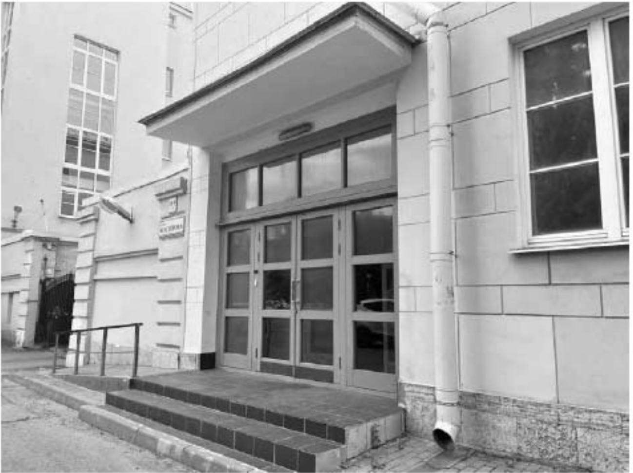
Фото 2. Фрагмент лицевого фасада, входная группа.
