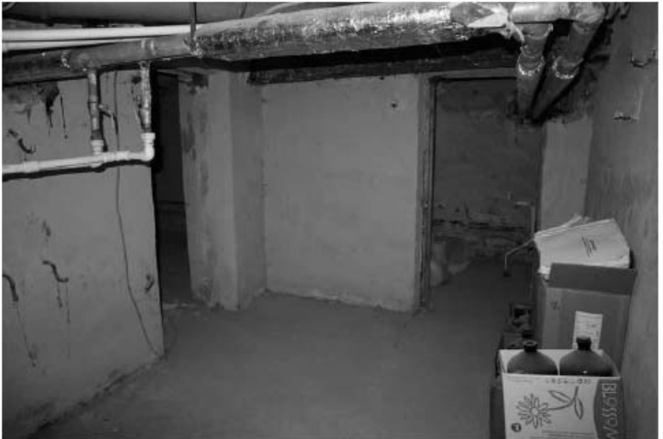
Фото п.9. Подвал, помещение 1Н (17).
