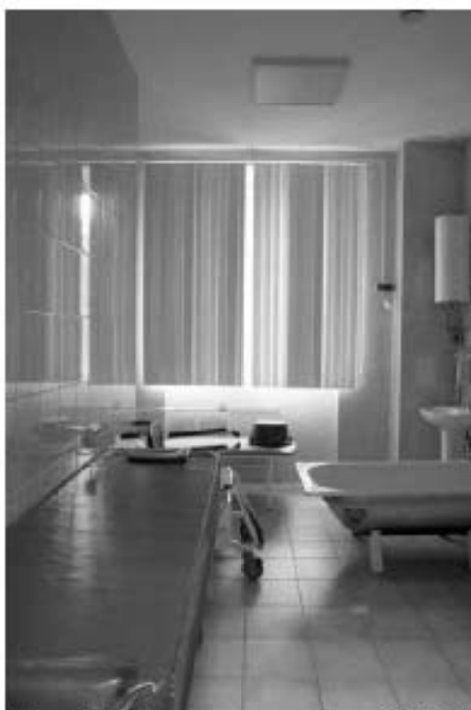
Фото 1.12. 1 этаж, помещение 1Н (39).
