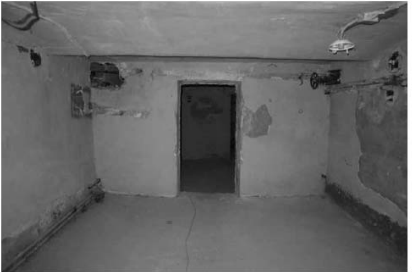
Фото п.11. Подвал, помещение 1Н (21).
