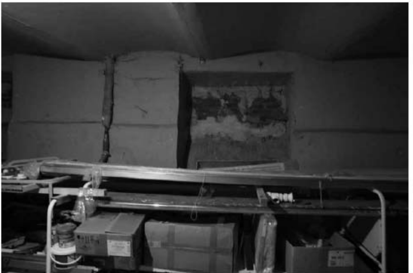
Фото п.24. Подвал, помещение 1Н (64).
