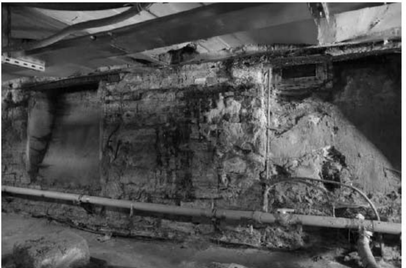
Фото п.38. Подвал, помещение 1Н (53).
