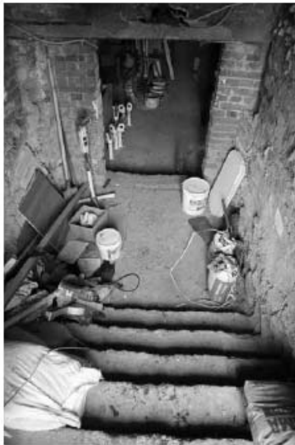
Фото п.25. Подвал, лестница, помещение 2Н (8)
