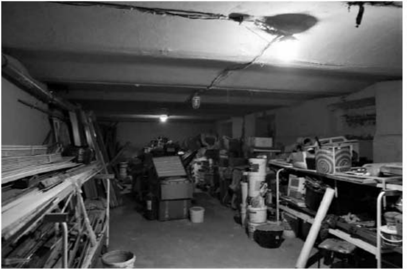
Фото п.23. Подвал, помещение 1Н (64).
