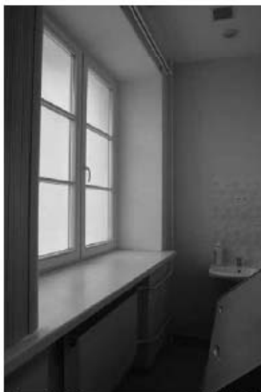
Фото 2.4. 2 этаж, помещение 1Н (61).
