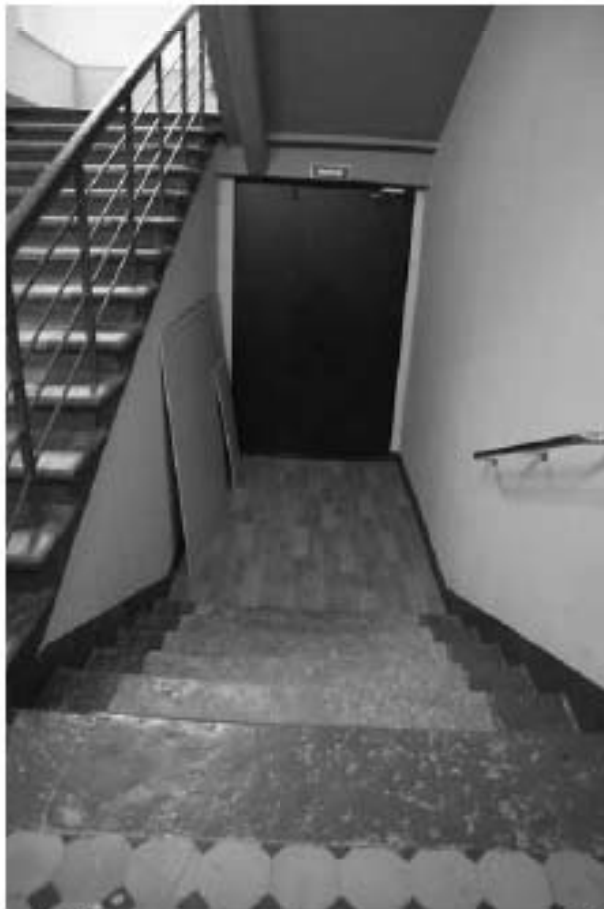
Фото 1.94. 1 этаж, лестница, помещение 3ЛК (2).
