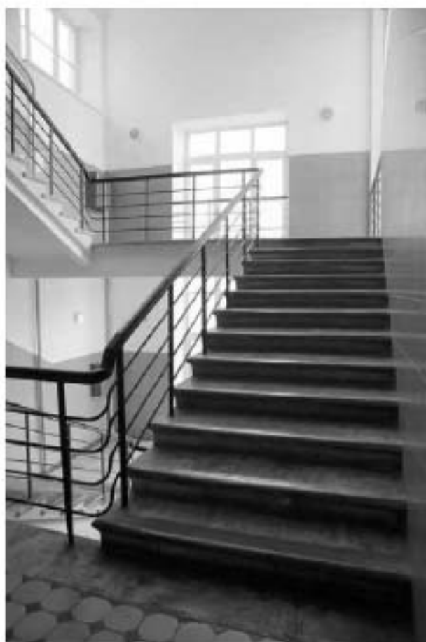
Фото 3.88. 3 этаж, лестница, помещение 2ЛК (6).
