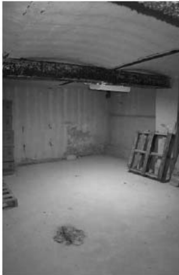
Фото п.7. Подвал, помещение 1Н (15).
