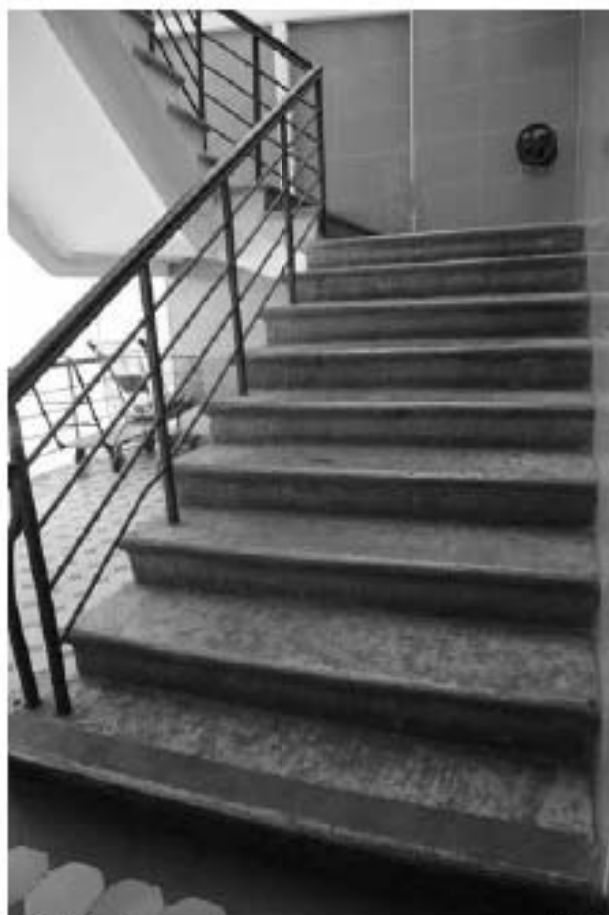
Фото 4.13. 4 этаж, лестница, помещение 2ЛК (7).
