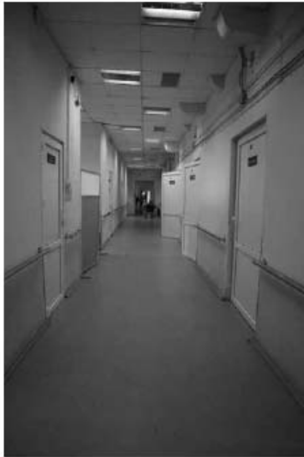
Фото 1.7. 1 этаж, коридор, помещение 4Н (69).
